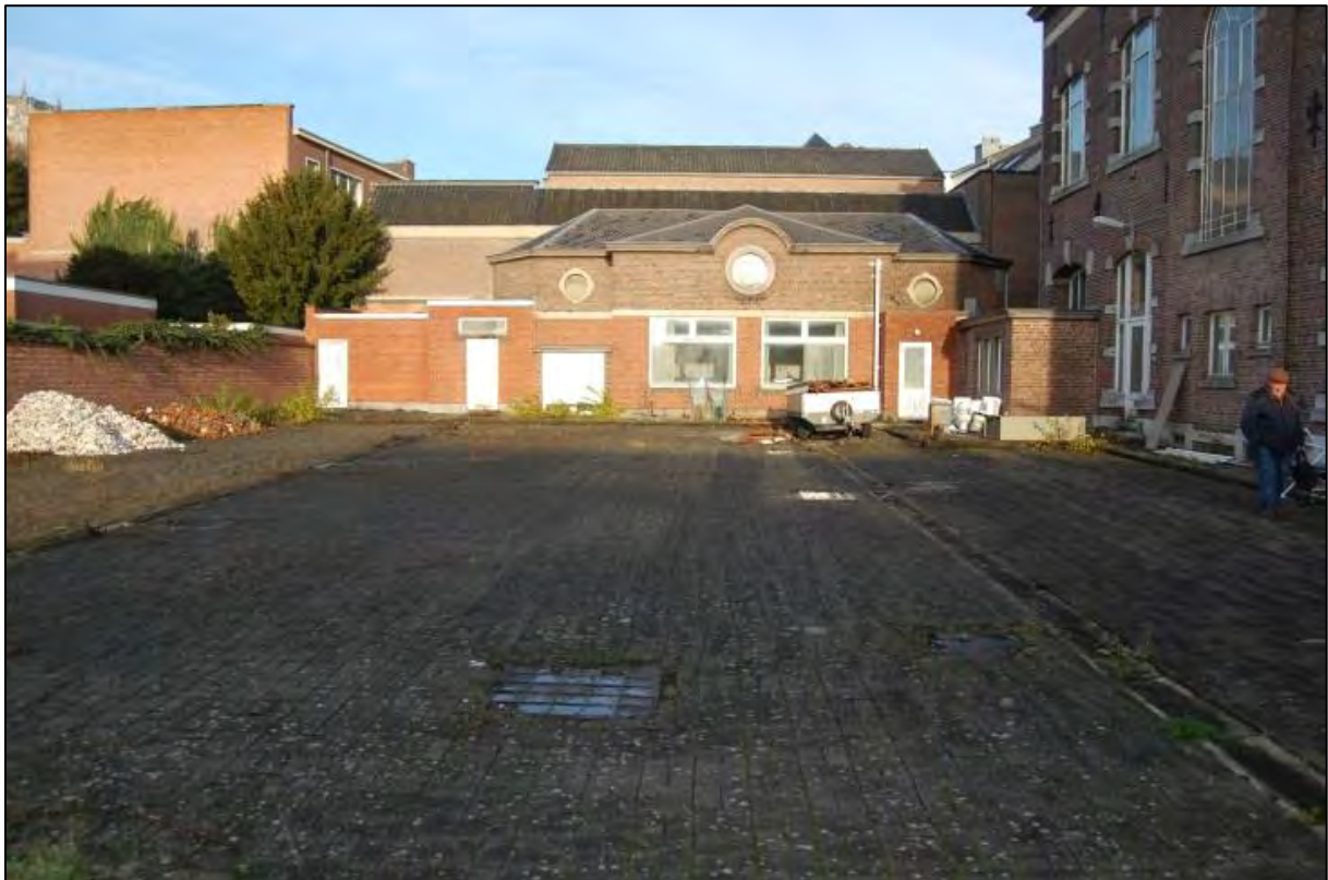
Afb. 43: Putdeksels van collectoren/afvoeren verspreid onder de verharding achter het hoofdgebouw (foto: stad Tongeren).
