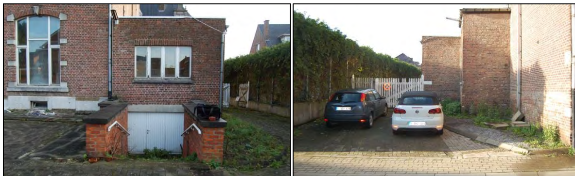
Afb. 4: Zicht op de bijbouw met kelder tegen de zuidgevel van het hoofgebouw: links in noordoostelijke richting (Repenstraat), rechts in zuidwestelijke richting vanaf de Repenstraat (foto: stad Tongeren).
