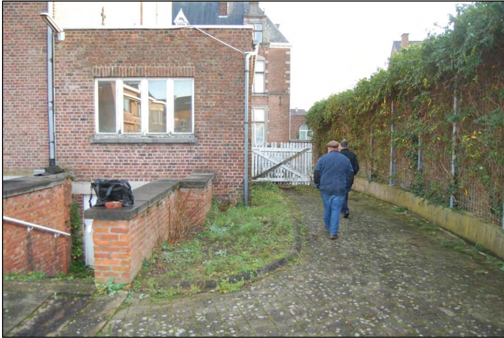
Afb. 6: Opname in noordoostelijk richting (Repenstraat) vanaf de zuidrand van het projectgebied: zicht op het hellend vlak naar de kelderruimte onder de bijbouw tegen de zuidgevel van het hoofdgebouw (Stad Tongeren).
