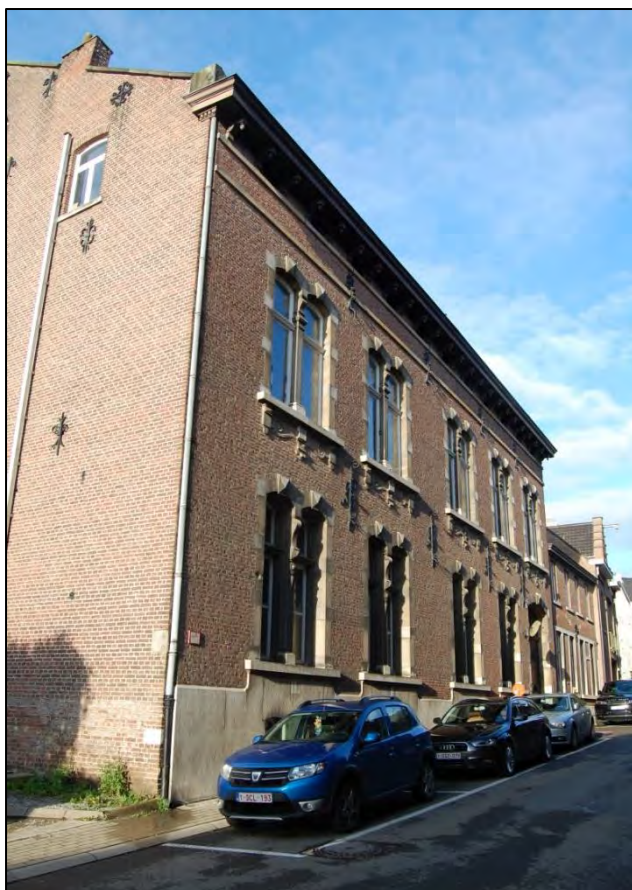
Afb. 32: Opname van de voorgevel van het pand Repenstraat 11 (Foto: stad Tongeren).
