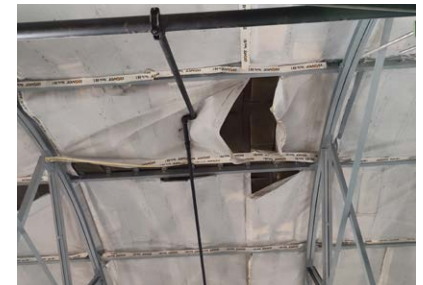
los dampscherm toneeltoren (dak 1)
