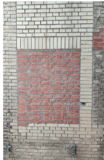
noordkoer +4, dichtgemetselde opening richting Schermenmagazijn
