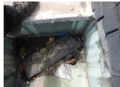
afval in dakgoot toneeltoren (MoWa, 2022)
