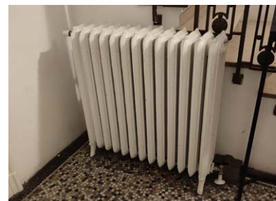
gietijzeren radiator, trap zuid +0
