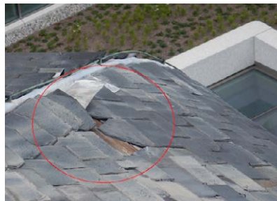
ontbrekende leien in koepel toneeltoren (MoWa, 2022)
