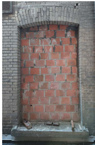
noordkoer +1, dichtgemetselde opening richting Schermenmagazijn
