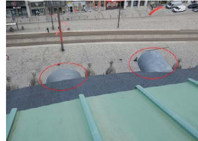
zink onder koperen dak (dak 3B) (MoWa, 2022)
