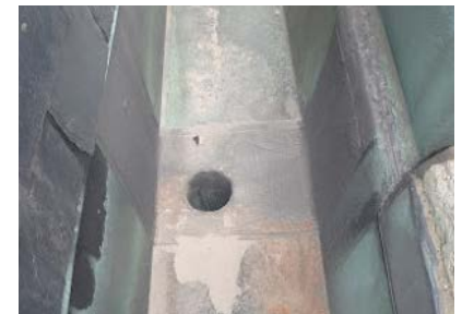
herstelling met coating (MoWa, 2022)
