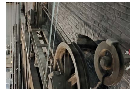
stalen brandscherm met origineel ophaalsysteem
