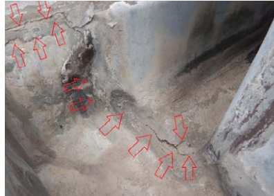
gescheurd lood boven voorste trapplaten (MoWa, 2022)
