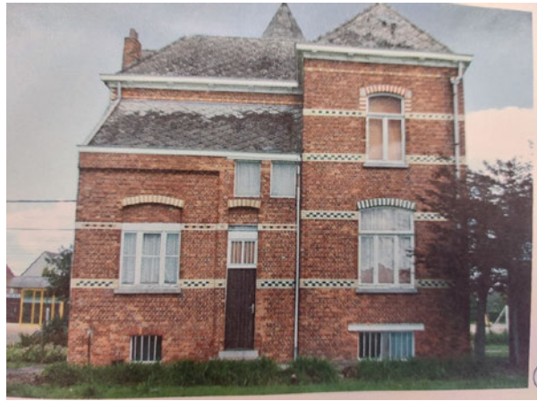
Afb. 17 foto achtergevel zuid 5
