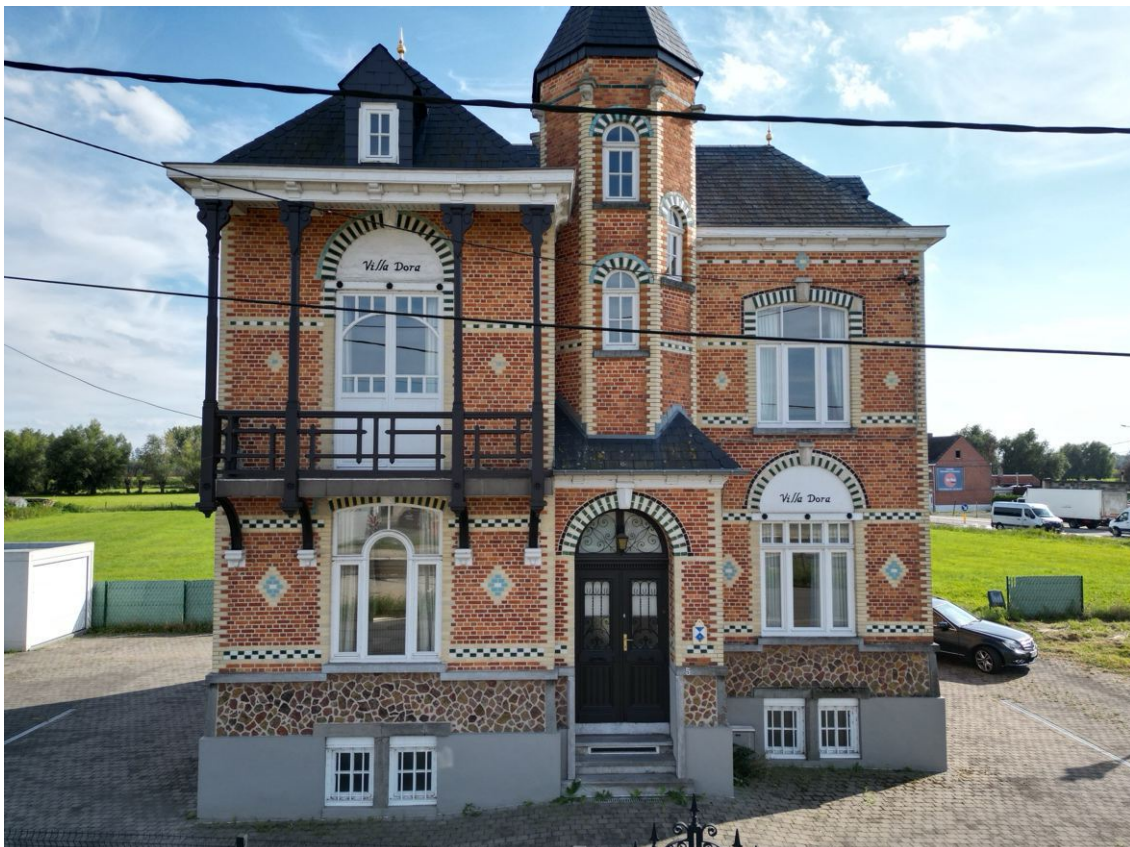
Afb. 25 foto voorgevel richting de rijbaan
