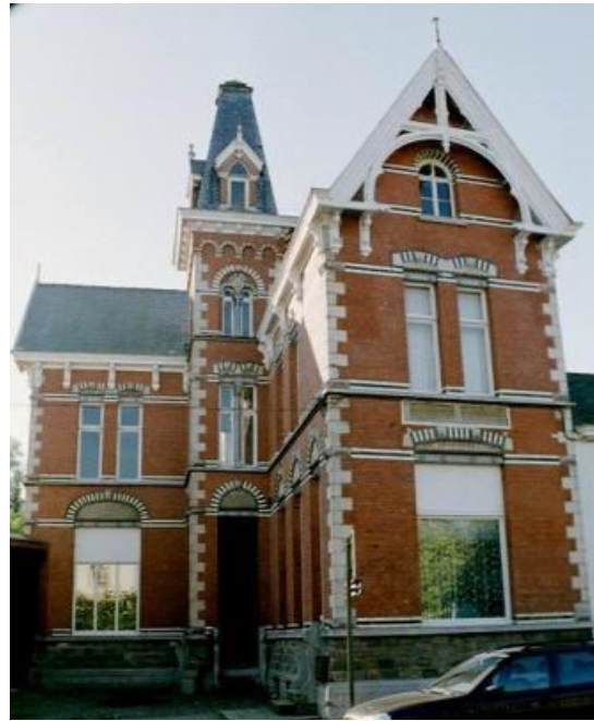
Afb. 4 voormalig postgebouw - Burg. de Lausnaystraat 55 te Berlare
