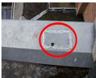
lek zinken plaatje op gootrand dak [5]
