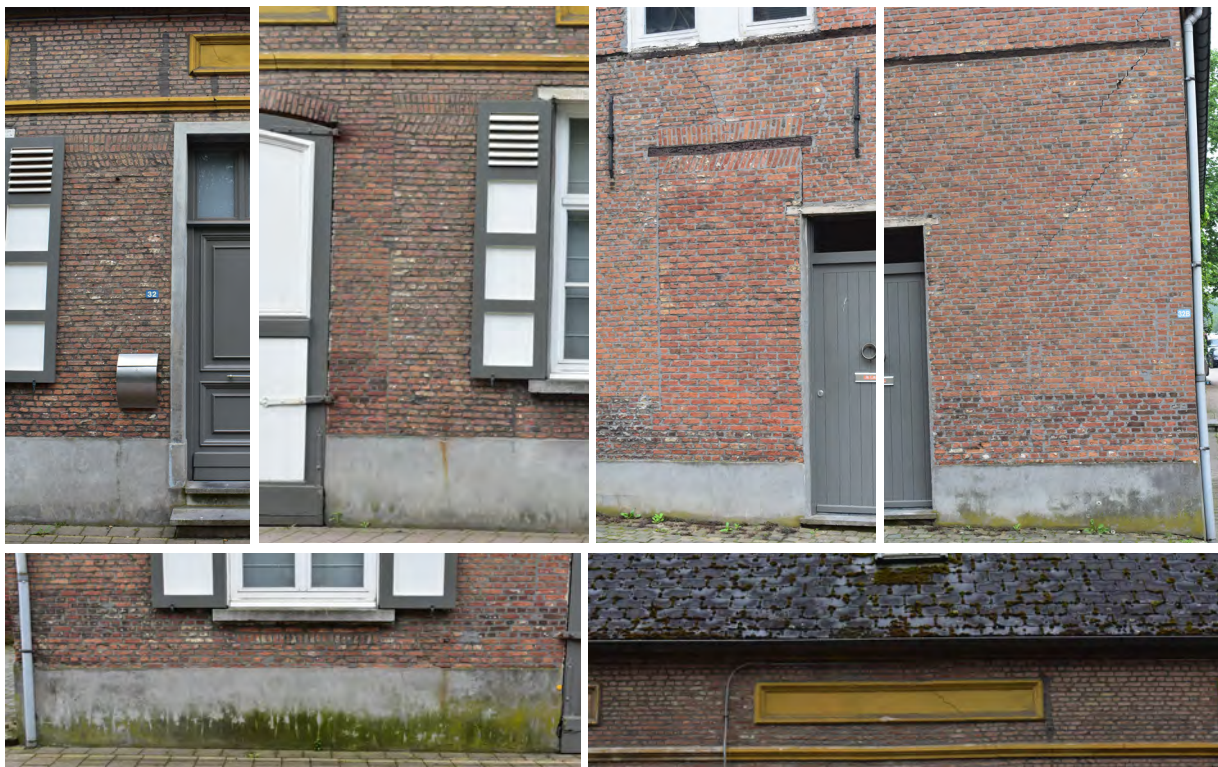
Figuur 94: stroomlaag voorgevel tussen travee drie en vier
