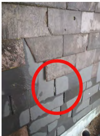
dak [3]-noordoost: verlijmde leien
