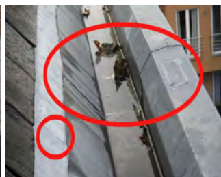
dak [5]-west: gescheurde soldeernaad + gescheurd voetlood
