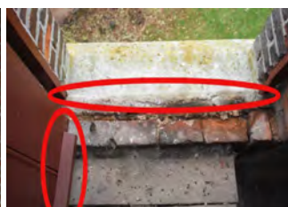
zolder [6]-west: kleien waterlijst en lage onderdorpel
