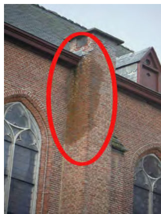
dak [5]-oost: gevolg van de gescheurde soldeernaad
