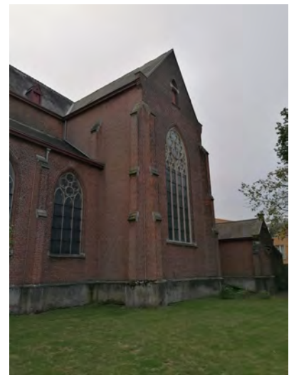
Figuur 40: westgevel eerste vier traveeën
