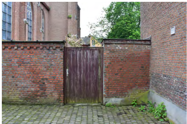
Figuur 63: zicht op de tuinmuur ten westen van de dorpswoning Figuur 64: detail van het metselwerk van de tuinmuur ter hoogte van de poort Figuur 65: zicht op de tuindeur in risaliet Figuur 66: detail metselwerk van de tuinmuur, kalkmortel Figuur 67: overzicht op de tuinmuur Figuur 68: de tuinmuur aan de kerktoren Figuur 69: de tuinmuur met poort tussen kerktoren en dorpswoning
