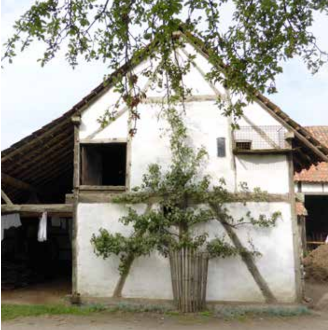
Figuur 25. Leifruit dat tegen de gevel geplaatst is. Bij de werken aan deze wand dienen beschermingsmaatregelen voorzien te worden ter bescherming van deze beplanting.
