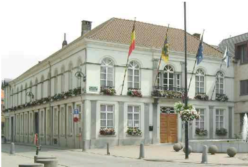
Foto huidige toestand Gemeentehuis De oorspronkelijke schouwen werden verwijderd, het marktplein heraangelegd.
