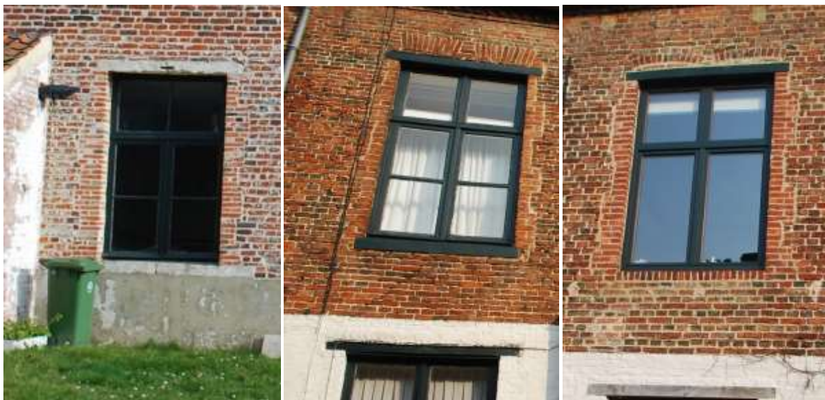
Foto 73 Natuurstenen omlijstingen werden vervangen door baksteenmetselwerk.
