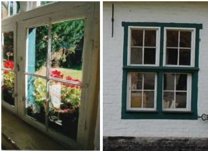
Diest, Engelen Conventstraat 5, eenvoudige houten wervels en knieren, eind zeventiende eeuw of achttiende eeuw. (© Vlaams Overheid, Onroerend Erfgoed; © ARAT Architecten )
