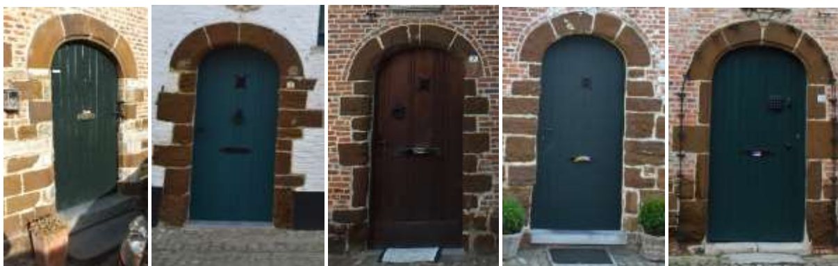
Foto 130 Voorbeelden van korfboogvormige deuromlijstingen in ijzerzandsteen.
