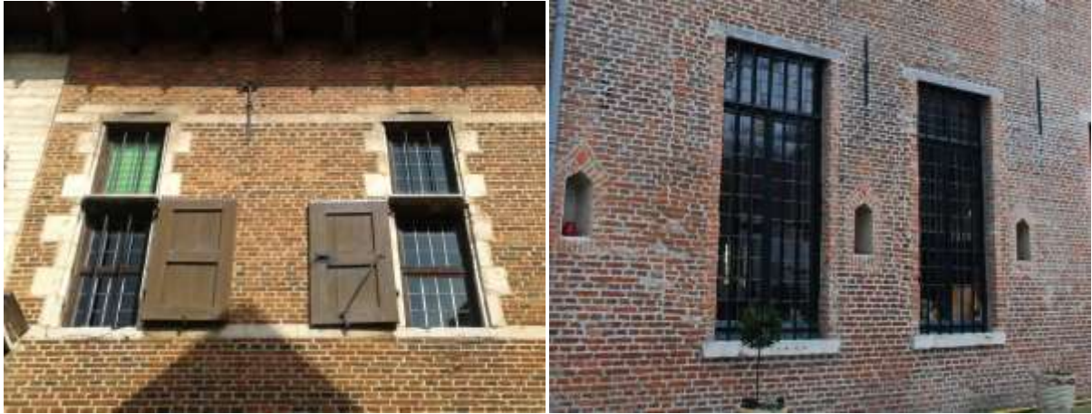
Foto 119 De oorspronkelijke beglazing was waarschijnlijk in glas-in-lood uitgevoerd.
