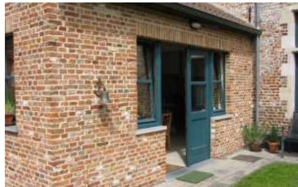
Foto 65 Tuinberging en aanbouw die mits aanpassingen voldoen aan de criteria
