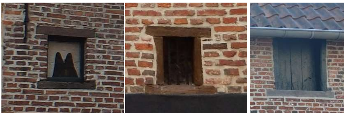
Foto 114 Voorbeelden van raamopeningen met dorpel en latei in hout.
