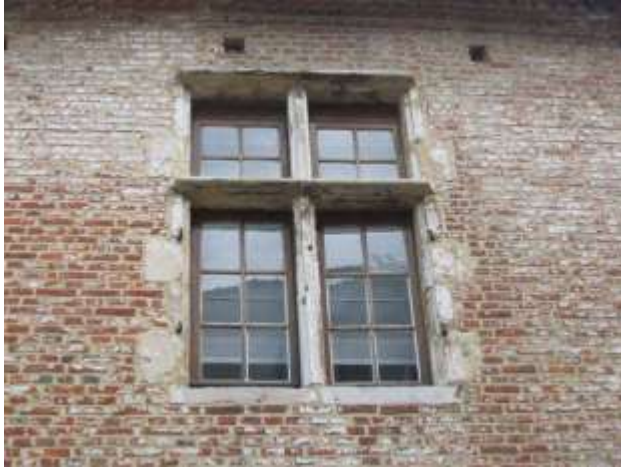
Diest, Engelen Conventstraat 26, kruisvenster tweede helft zeventiende eeuw. (© Vlaams Overheid, Onroerend Erfgoed)
