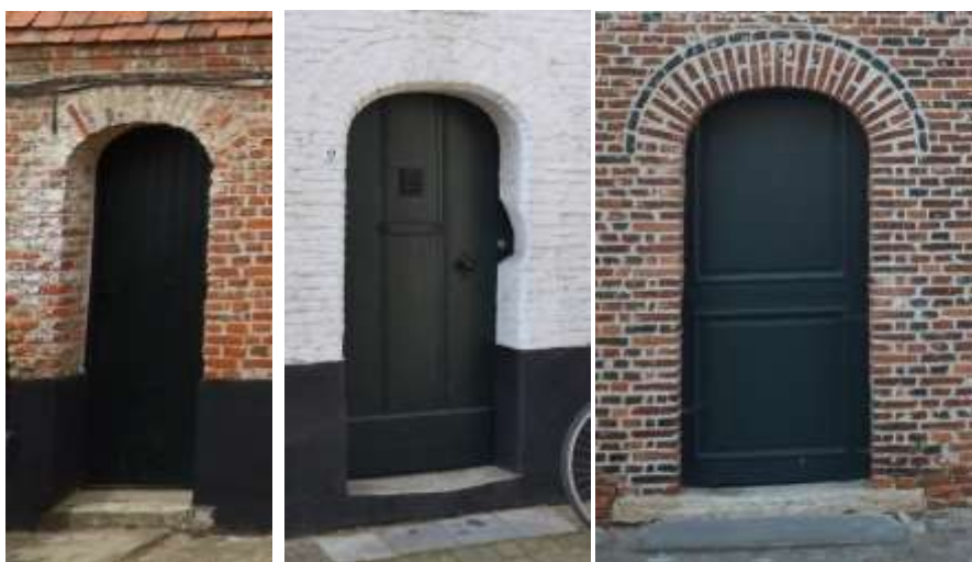
Foto 134 Voorbeelden van korfboogvormige bakstenen deuromlijstingen.
