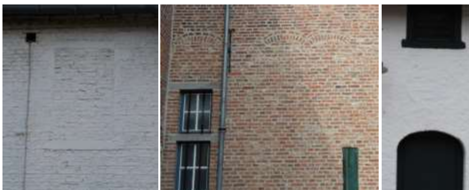
Foto 76 Heilige Geeststraat 24, Kerkstraat 6-8, Kerkstraat 11: dichtgemetste openingen.
