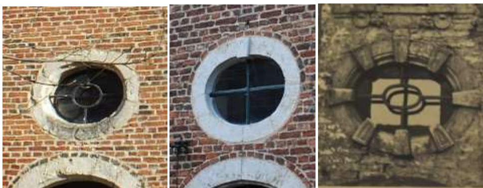
Foto 105 Voorbeelden van Oeils-de-boeuf in witte steen.
