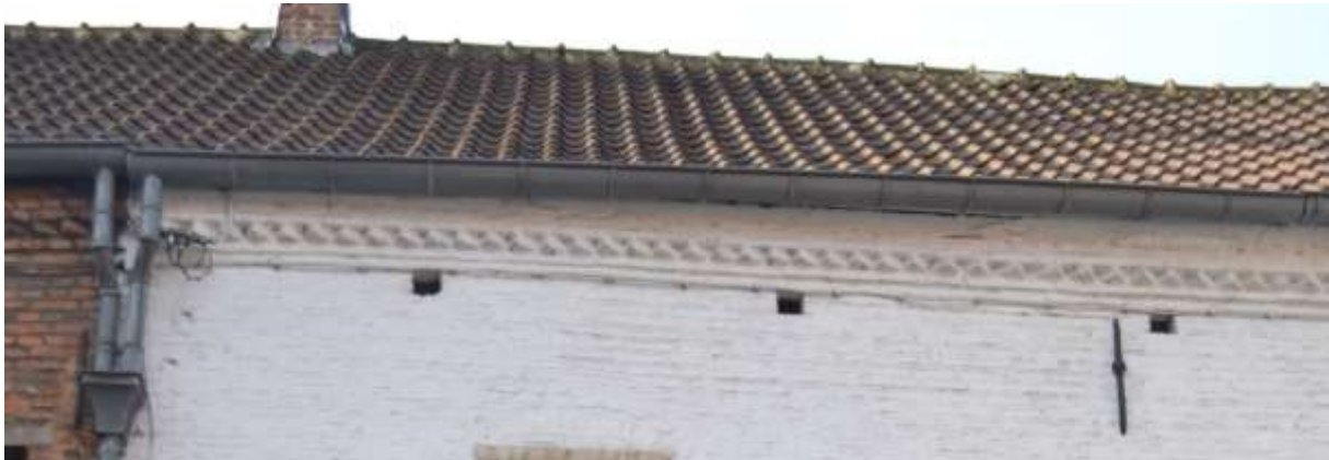
Foto 81 Doorlopende muizentandmotief aan de voorgevels
