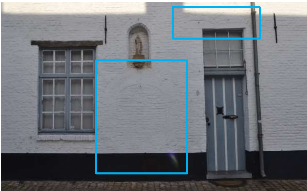
Foto 58 Heilige Geeststraat 9: bouwspoor weggewerkt d.m.v. een kaleilaag.
