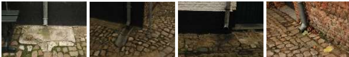
Foto 162 Watervangstenen V.l.n.r. witte en blauwe hardsteen; cementering, ontbreken van watervang
