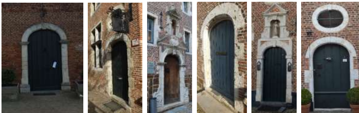
Foto 127 Voorbeelden van deuromlijstingen met korbboogvorm uitgevoerd in witte natuursteen.
