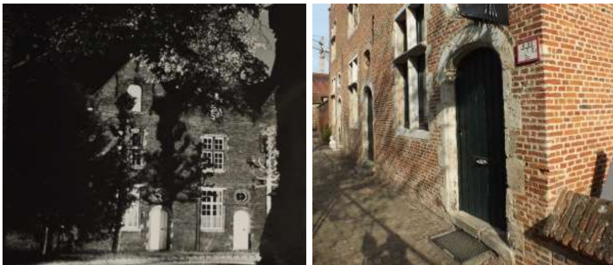
Foto 140 Het schrijnwerk van Infirmeriestraat 5-6-7 was vroeger wit geschilderd.
