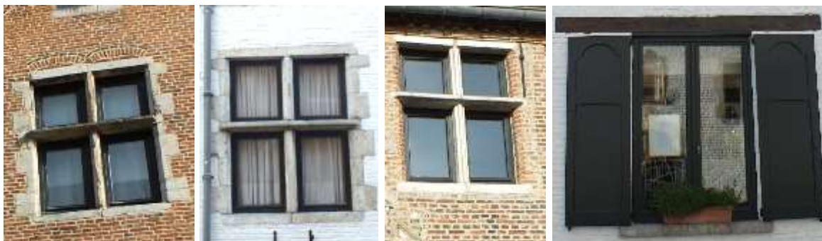
21e -eeuwse vensters in historische kruisvensters geplaatst.
