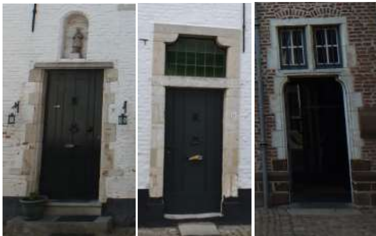
Foto 128 Voorbeelden van deuromlijstingen met bovenlicht uitgevoerd in witte natuursteen.
