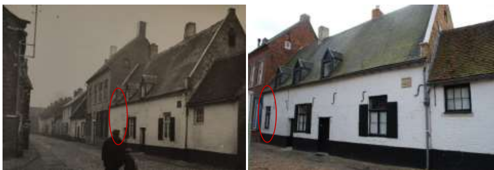
Vensteropening toegevoegd in 20 e eeuw met dorpel in blauwe hardsteen en profilering eigen aan de tijd vormt een mooi voorbeeld van de illustratie die schrijnwerk kan vormen binnen de aanpassingswerken van een woning en dient zeker behouden te blijven.
