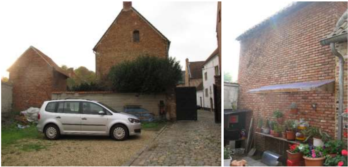
Foto 24 Scheidingsmuur (snelbouwsteen) niet op perceelgrens
