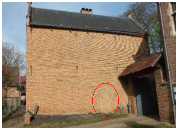
Foto 48 V.l.n.r. poort tegen godshuizen; huidige situatie, met bouwspoor van voormalige opening.
