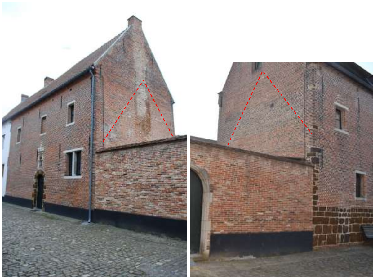
Foto 25 V.l.n.r. bouwspoor zijgevel nr.10; bouwspoor zijgevel nr. 16
