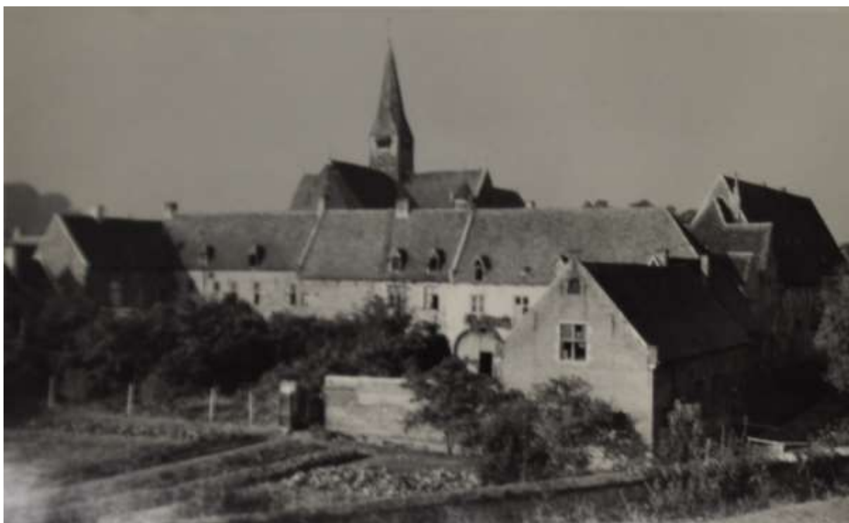
Foto 45 Oude foto van achtergevel boerderij
