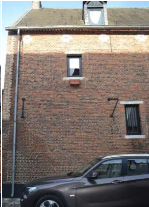
Foto 13 V.l.n.r. bouwsporen voorgevel nr. 15; bouwsporen nr. 11
