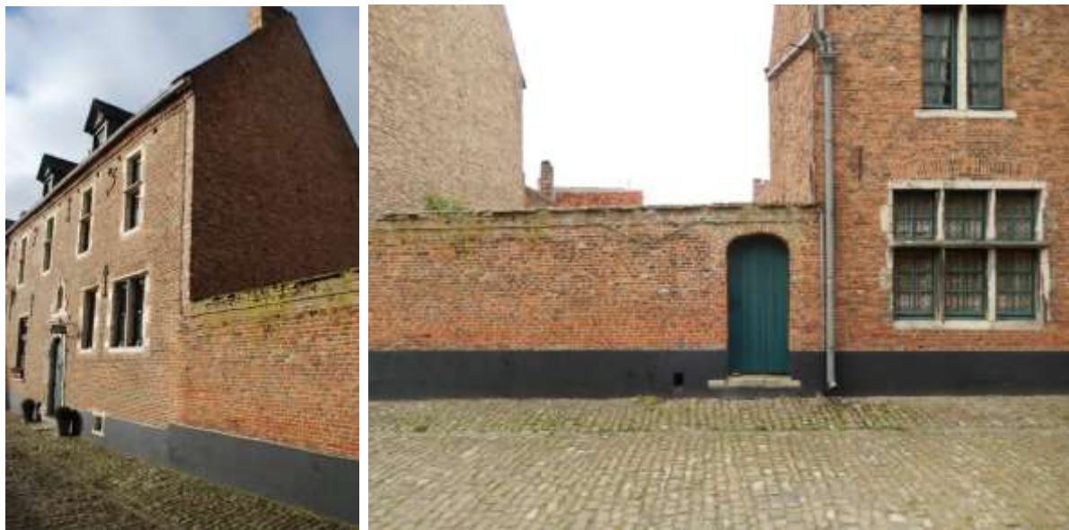
Foto 9 V.l.n.r. voorgevel Heilige Geeststraat 3; voorgevel Heilige Geeststraat 1
