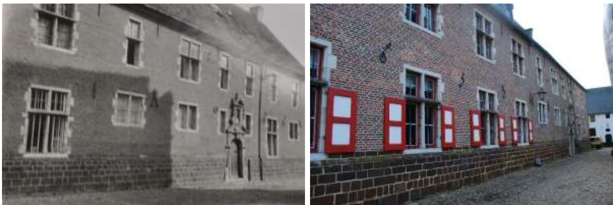
Foto 120 Bij de infirmerie werd het onderste deel van de kruisvensters van luiken voorzien.
