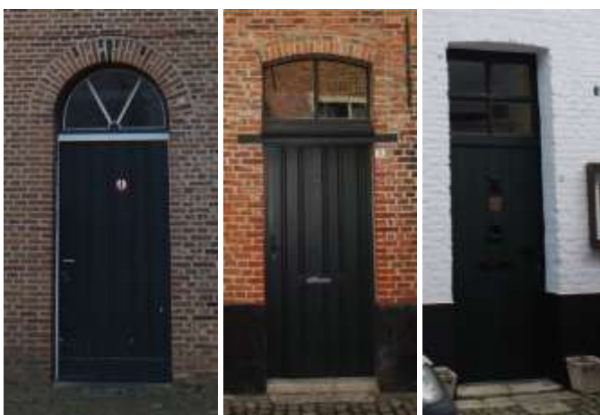
Foto 136 Voorbeelden van deuropeningen met rondboog- en segmentboogvorm in baksteen.
