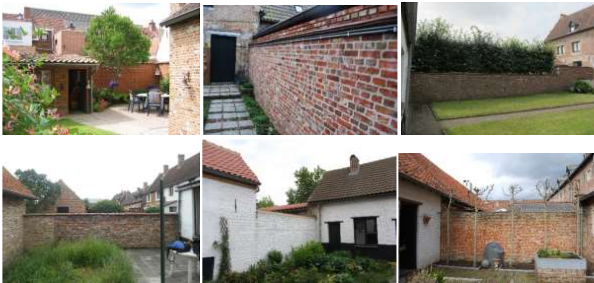
Foto 182 Recente bakstenen tuilmuren.
