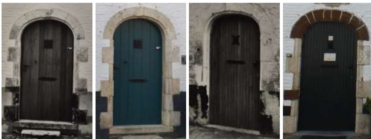
Foto 141 Het schrijnwerk was bij de vervanging nog niet beschilderd.
