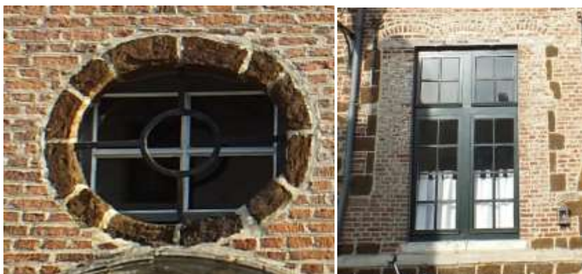
Foto 110 Oeil-de-boeuf en drielicht in ijzerzandsteen te Engelen Conventstraat 3.
