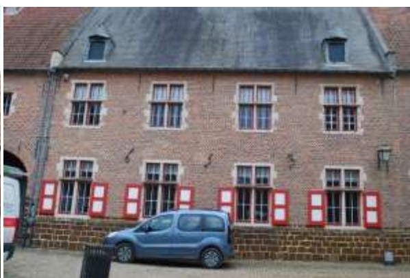
Foto 44 V.l.n.r. achtergevel boerderij; voorgevel bakhuis
