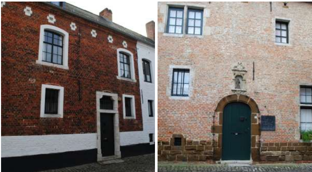
Foto 55 (restanten van) witgeschilderde kaleilagen die een natuurstenen omlijsting imiteren.
