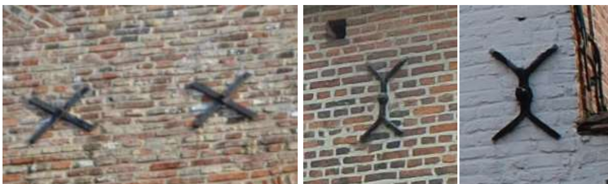
Foto 94 Voorbeelden van X-vormige ankers.
