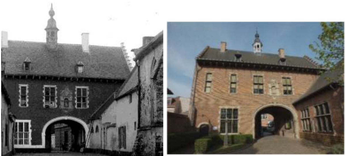
Foto 57 (19 de eeuw) Kaleilaag op de natuurstenen raam- en poortomlijsting.
