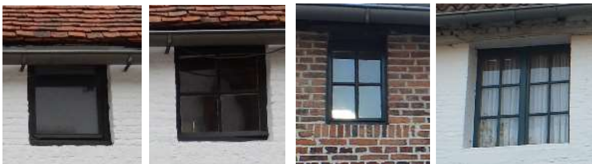
Foto 115 Voorbeelden van raamopeningen met enkel latei in hout.
