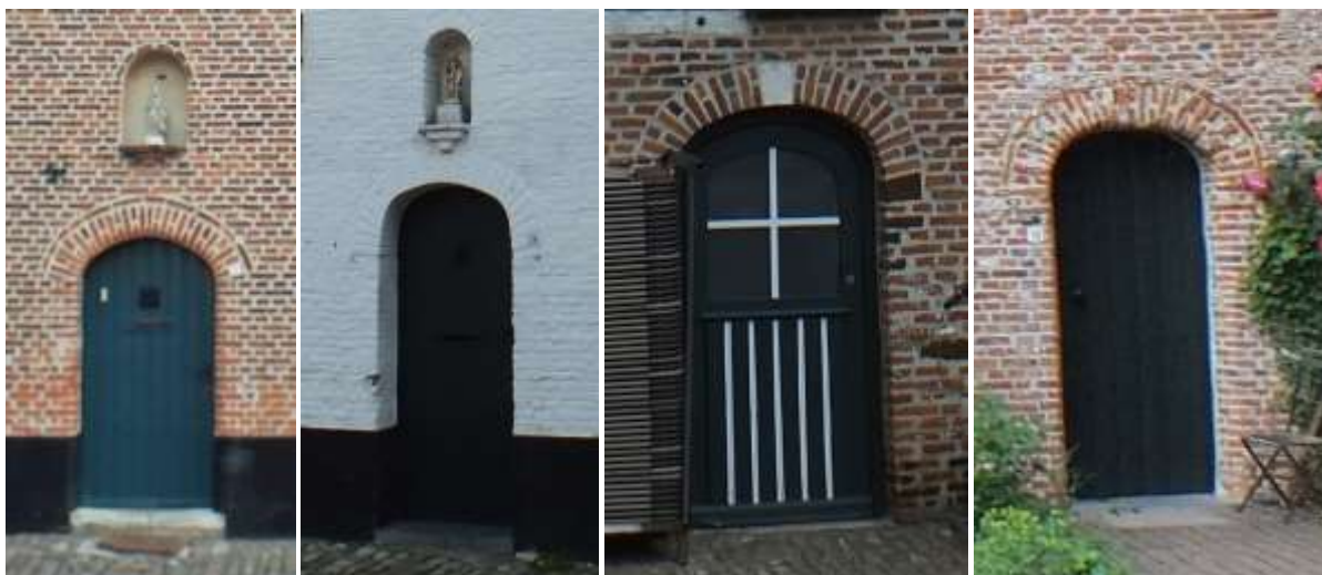
Foto 133 Voorbeelden van korfboogvormige bakstenen deuromlijstingen.
