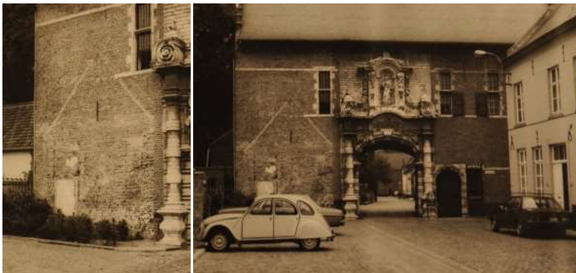
Foto 33 1977 waarop nog bouwsporen te zien zijn
