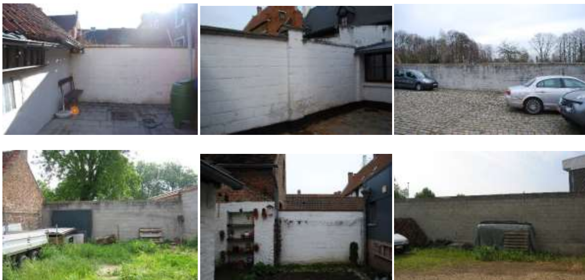
Foto 184 Tuilmuren in snelbouwsteen.
