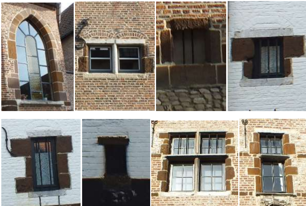
Foto 109 Voorbeelden van ramen in ijzerzandsteen.
