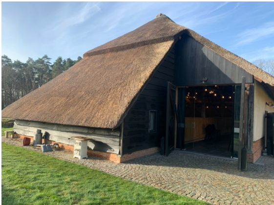
De oostelijke poortopening en het wagenhuis.
