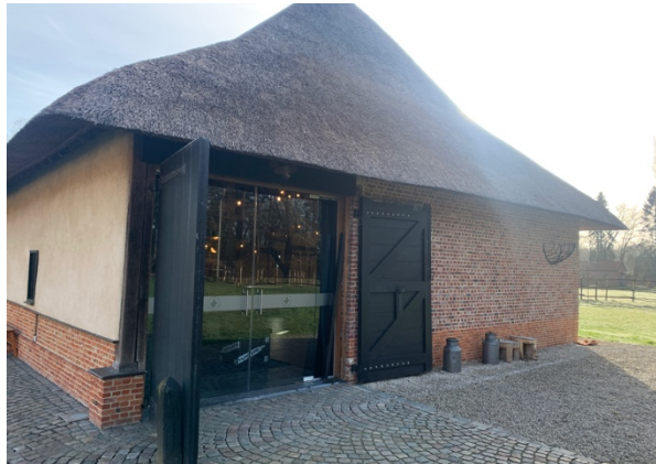
De westelijke gevel van de schuur.
