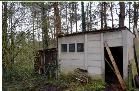
Foto 2: Koterij (H4) in bos B1 bestaande uit betonplaten en asbest dak.
