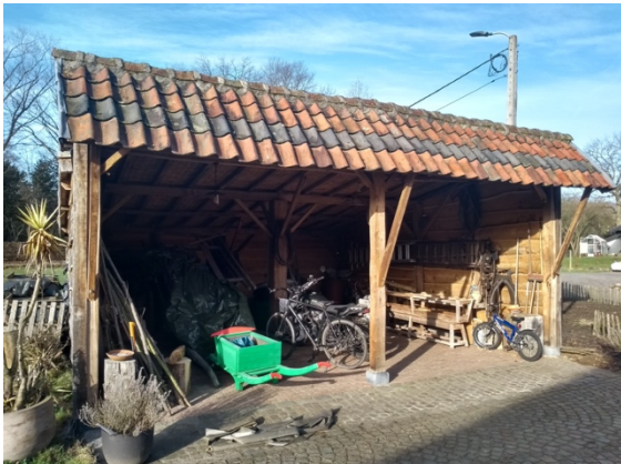
Het karrenschob, gezien vanuit het oosten.
