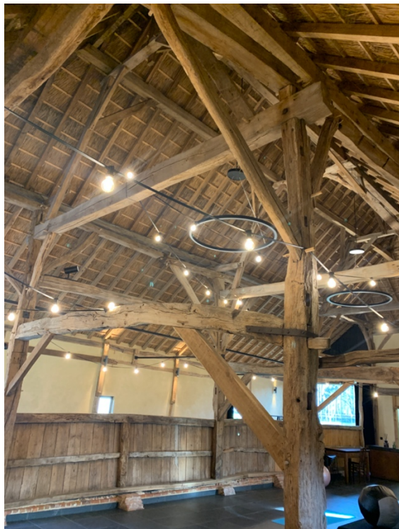
Zicht op de monumentale spantstructuren en de weegt.
