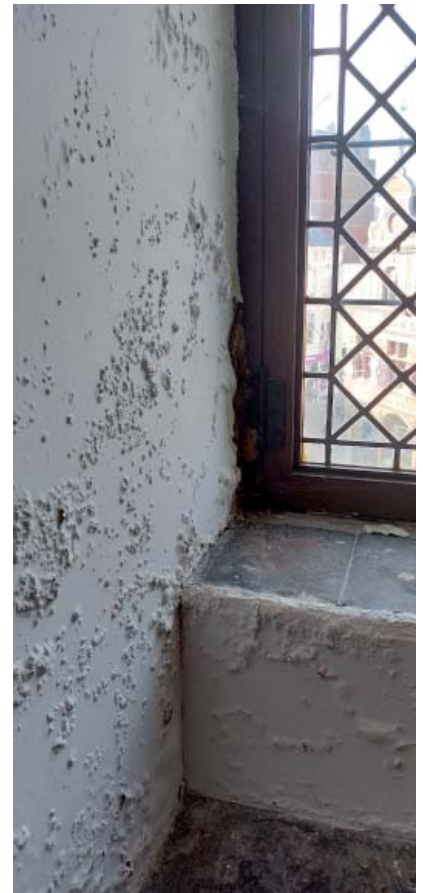
Fig. 29. Zout- en vochtproblematiek 2 de verdieping, 2022 © ARTER
