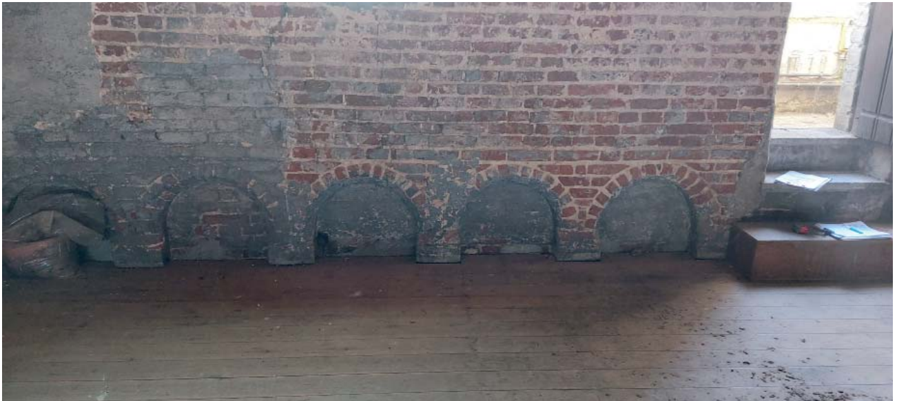
Fig. 31. Restanten voormalige gevelbouw zuidgevel vanop de zolderverdieping, 2022 © ARTER
