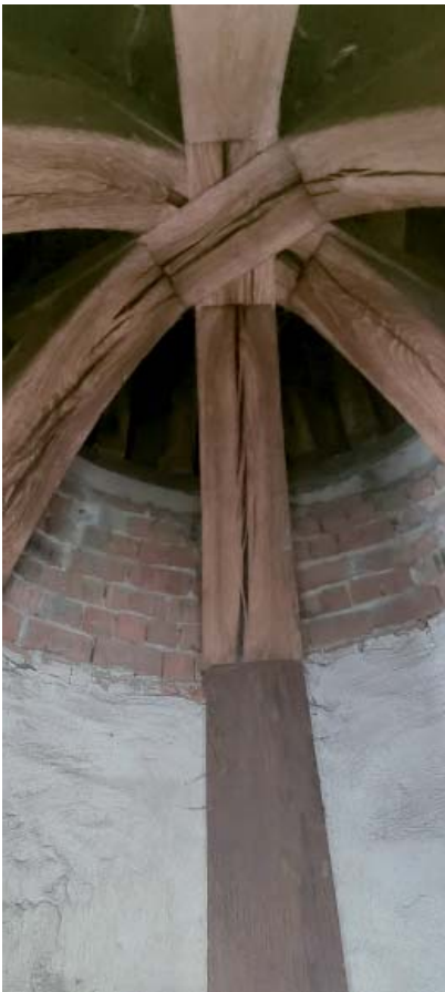
Fig. 37. Constructie toren arkeltoren oost, 2022 © ARTER
