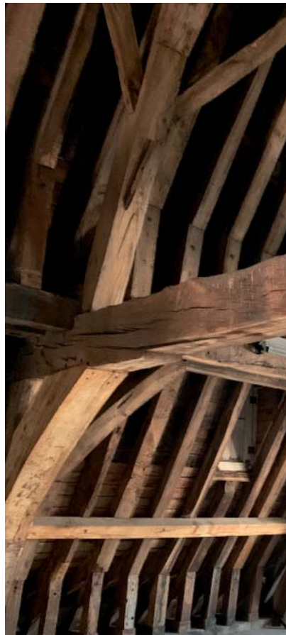
Fig. 35. Balkenrooster en met planchetten afgewerkt plafond 2 de verdieping, 2022 © ARTER
