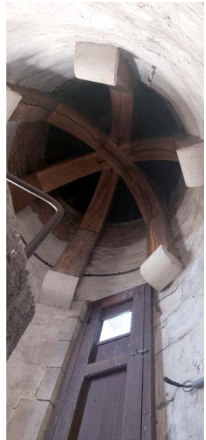
Fig. 39. Constructie toren arkeltoren oost, 2022 © ARTER
