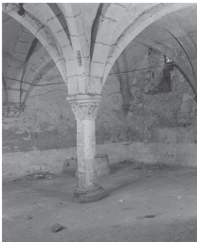
Fig. 80 - Zicht op de eerste ruimte van de hallenkelder omstreeks 1948 (detail), © KIKIRPA
