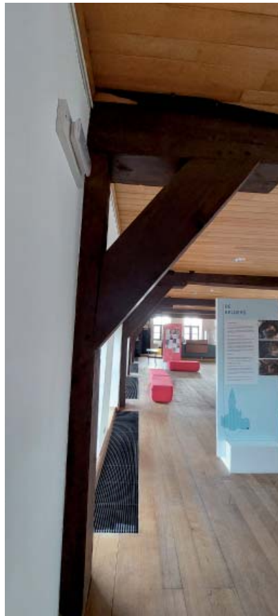
Fig. 28. Balkenrooster en met planchetten afgewerkt plafond 2 de verdieping, 2022 © ARTER
