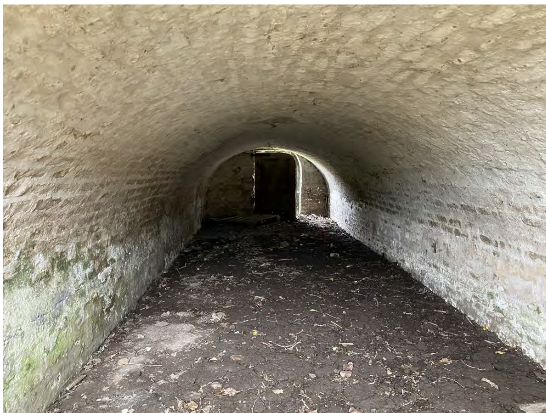
De halfondergrondse aardappelkelder afgedekt met een tongewelf.
