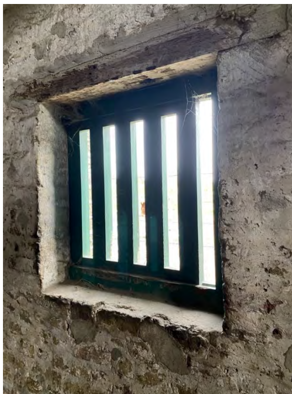
De binnenzijde van de herstelde toegangspoort. Rechts: de houten verluchtingsroosters van de ramen
