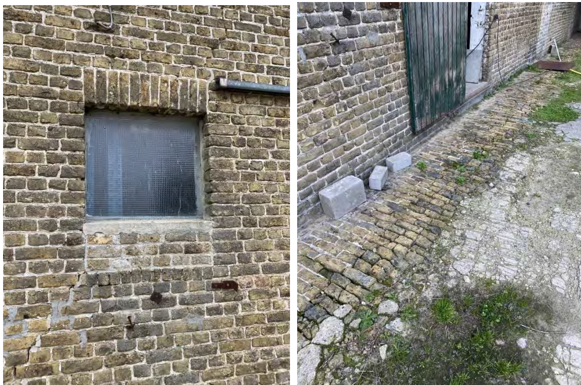
Links: een nog origineel stalvenster in de zuidelijke langgevel. Het venster werd onderaan gedeeltelijk gedicht. Rechts: het sinterpad tegenaan de zuidgevel.
