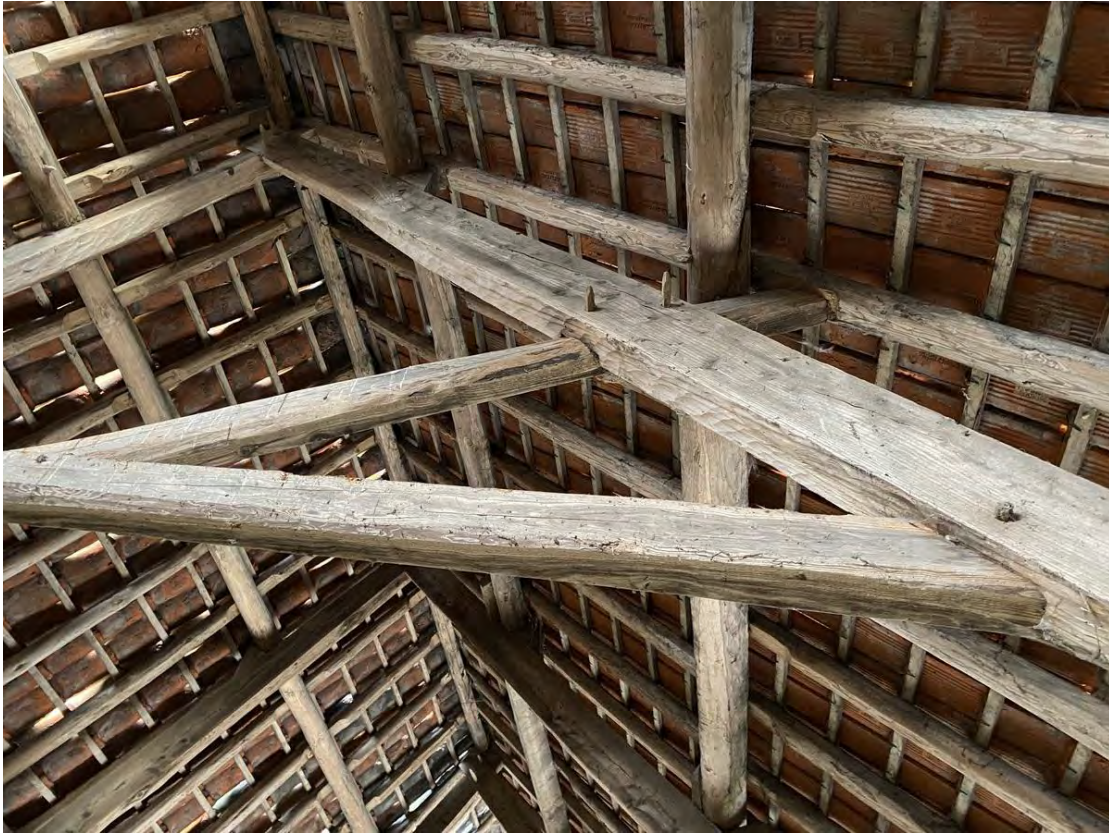
De bekapping van de schuur. Detail van de verbindingen.
