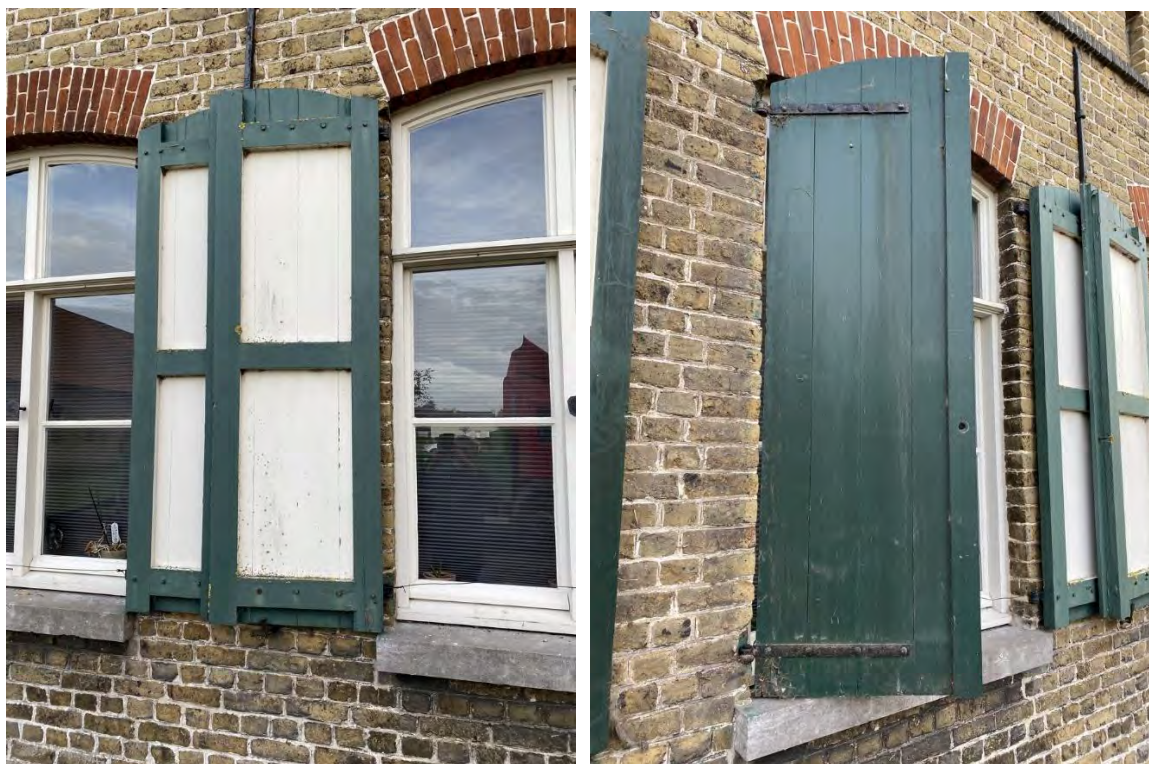
De raamluiken van de voorgevel. De buitenbekleding en het raamwerk zijn dondergroen geschilderd.
