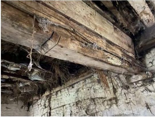
De moerbalk van het dilt boven de oude wagenbergplaats. De afwerking van de balkuiteinden laat hier een gerecupeerde balk vermoeden.
