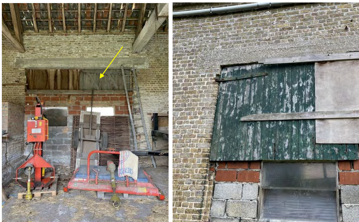
De gedichte schuurpoort in de noordelijke gevel. Een gedeelte van de schuurpoort bleef bewaard.
