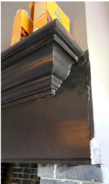
Links: detail van de profilering van het bordenrek.
