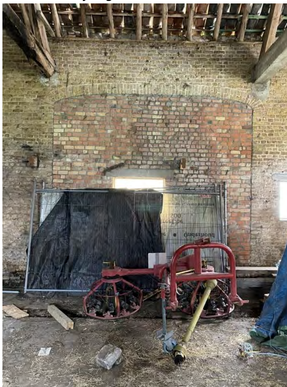
De gedichte originele schuurpoort in de noordelijke gevel; buiten- en binnenzicht.
