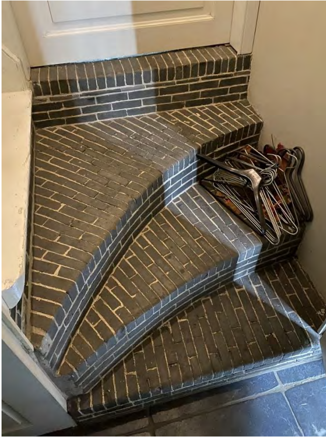
De bakstenen trap naar de voutekamer (boven) en naar de zoldertrap (links).
