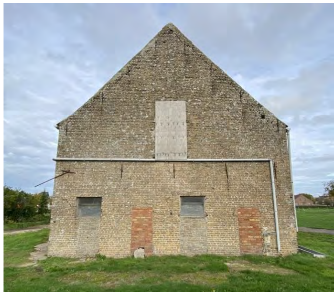
De korte gevels van de schuur. De oostelijke gevel (links) of straatgevel is rijk versierd. Onderaan de gedichte openingen voor de vetmeststallingen. De oostelijke gevel is sober gehouden. De (gedichte) openingen voor de vetmeststallen zijn later aangebracht.
