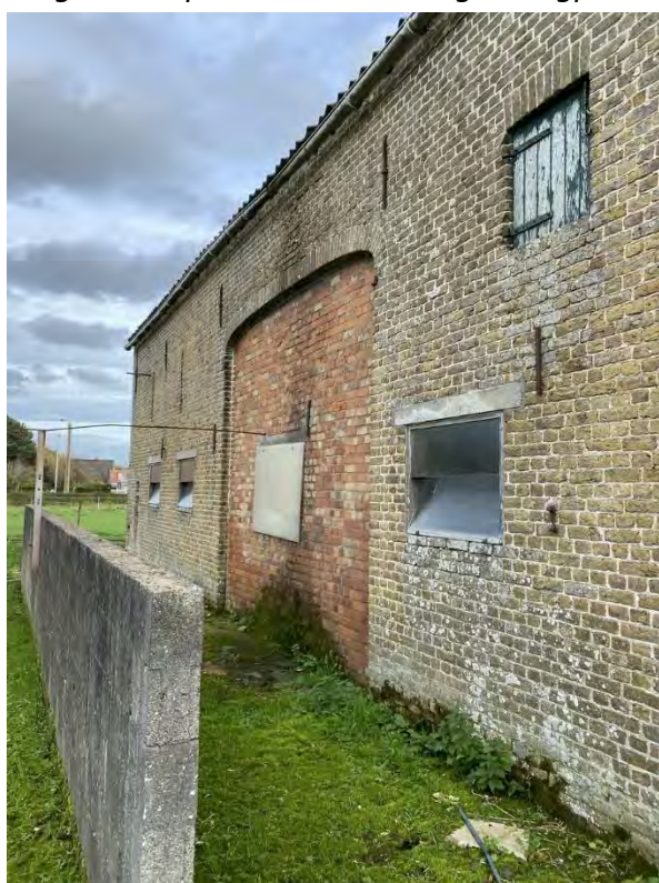
De gedichte originele schuurpoort in de noordelijke gevel; buiten- en binnenzicht.
