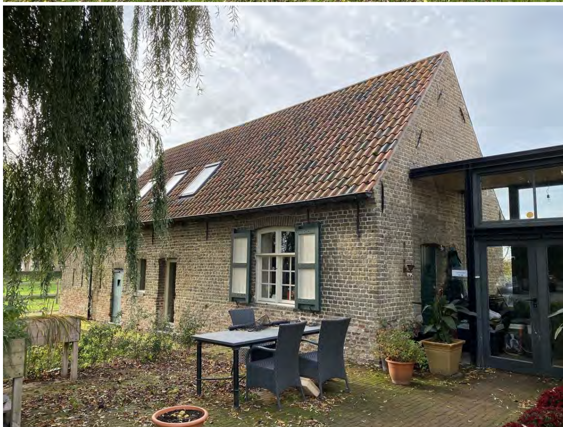
Het bakhuis respectievelijk gezien vanuit het zuidwesten (links) en het zuidoosten (rechts).
