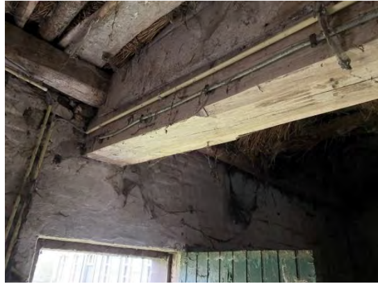
De moerbalk van het dilt boven de oude wagenbergplaats. De afwerking van de balkuiteinden laat hier een gerecupeerde balk vermoeden.
