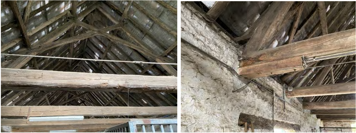
De bekapping van de wagenbergplaats.rechts de bijgewerkte moerbalk.
