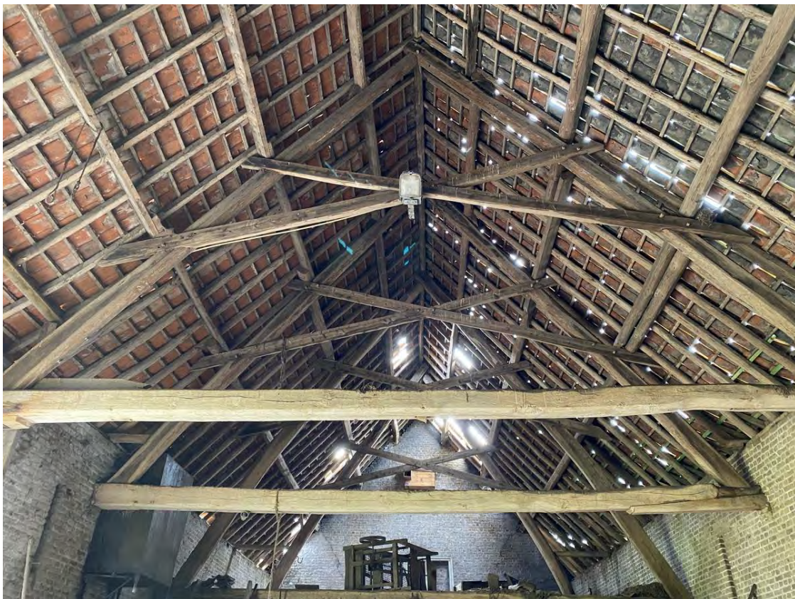
De bekapping van de schuur boven het dilt.
