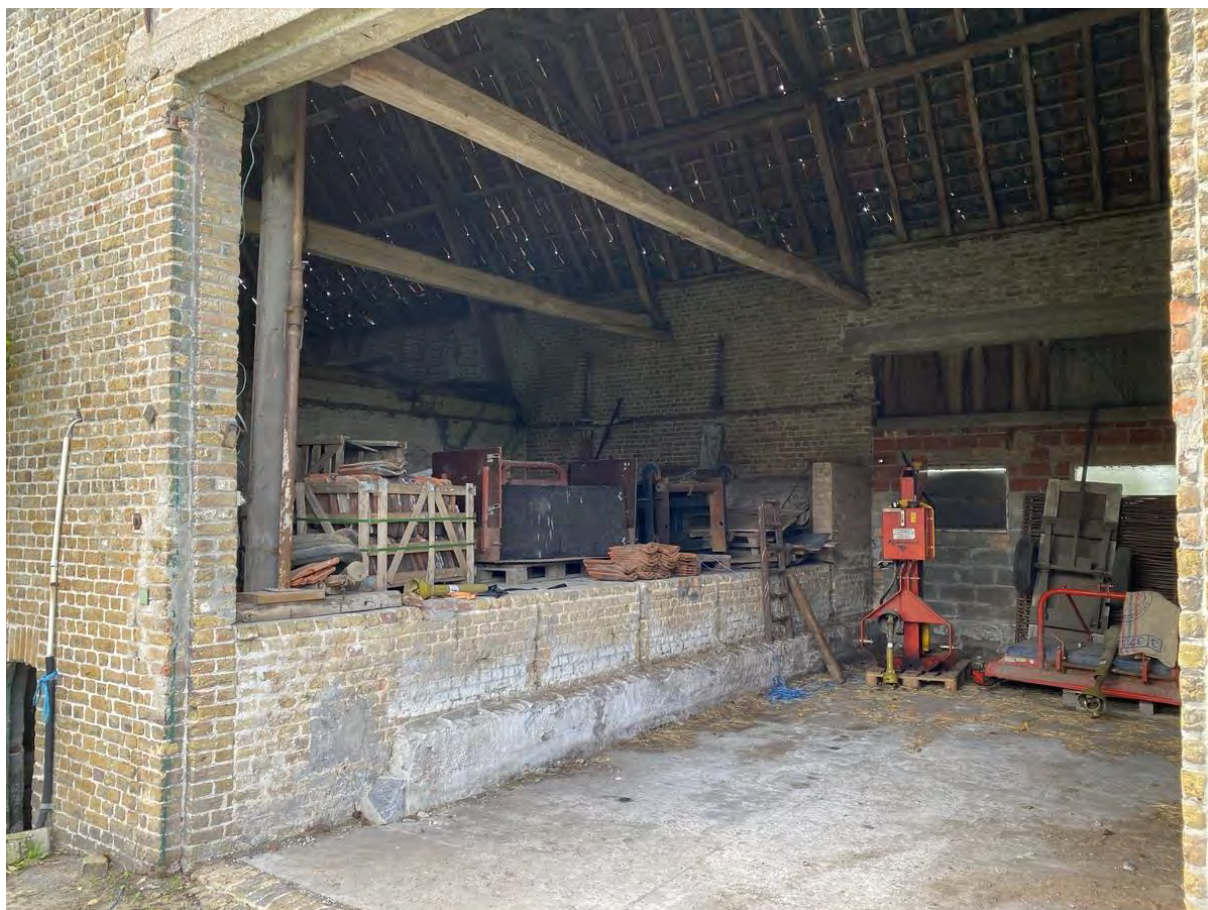
De schuurpoort met links de halfondergrondse aardappelkelder.
