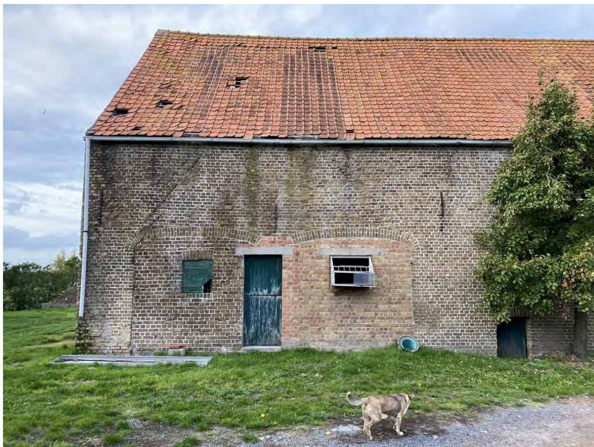
De gedichte poorten van de wagonbergplaats in het westelijke gedeelte van de schuur.
