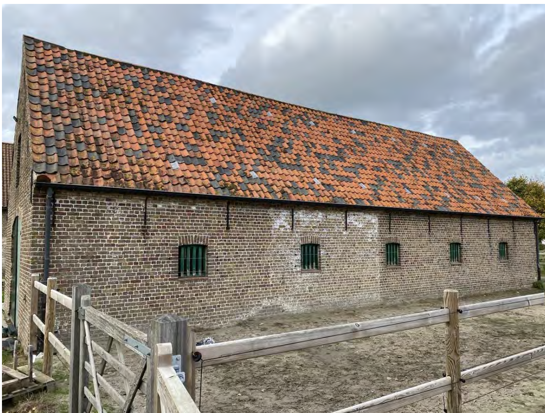
De wagonbergplaats de zuidelijke gevel
