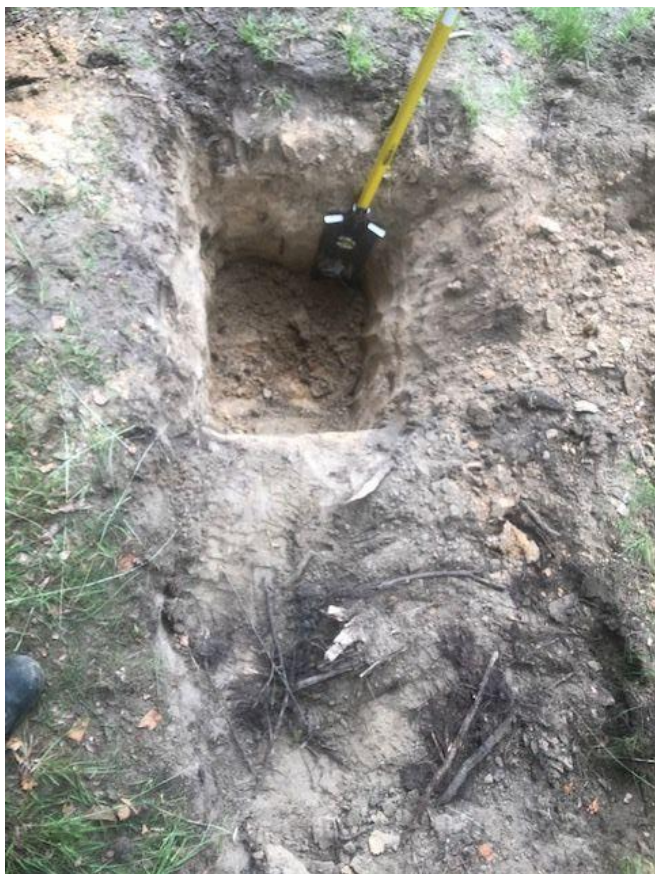
Figuur 26: Profielkuil 2. Uitgevoerd ter hoogte van huisnummer 33 Breedte 70cm, lengte 120cm, diepte 80cm
