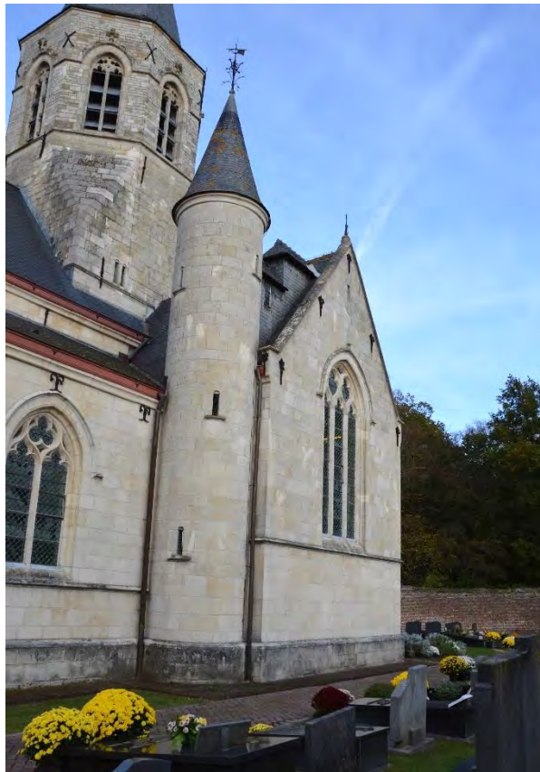
Fig. 24 - De in 1893-1899 zwaar gerestaureerde zuidelijke dwarsbeuk, met volledig vernieuwd gevelparement, nieuwe dakconstructie en traptoren.
