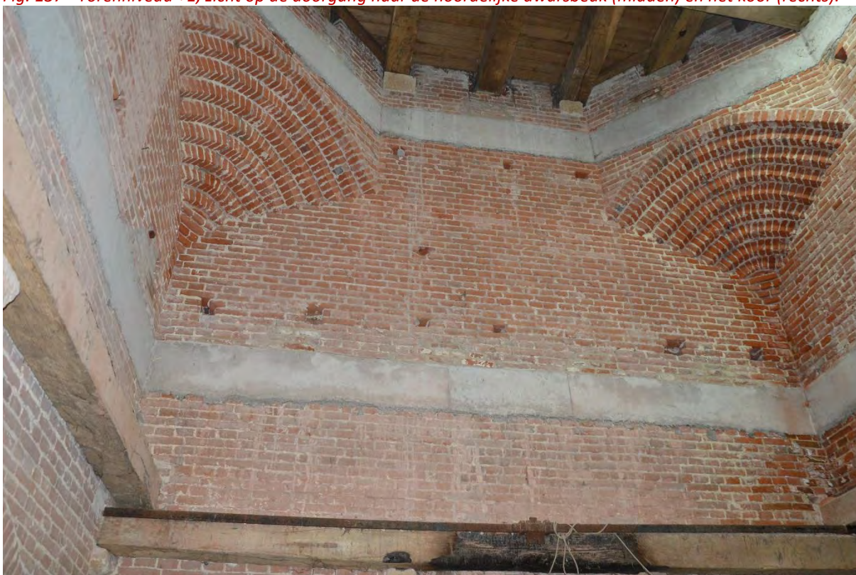
Fig. 138 - De binnenzijde van de torenschacht, met de houten balken, de betonnen ringbalken en de ontlastingsbogen in de hoeken.
