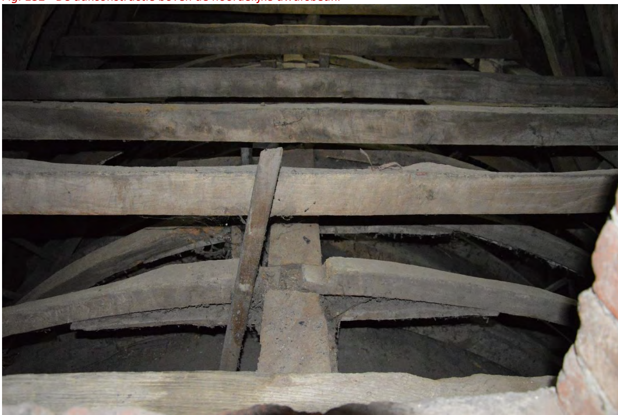
Fig. 133 - De ribben van een ouder houten tongewelf zijn bewaard in de zolder van de noordelijke dwarsbeuk.
