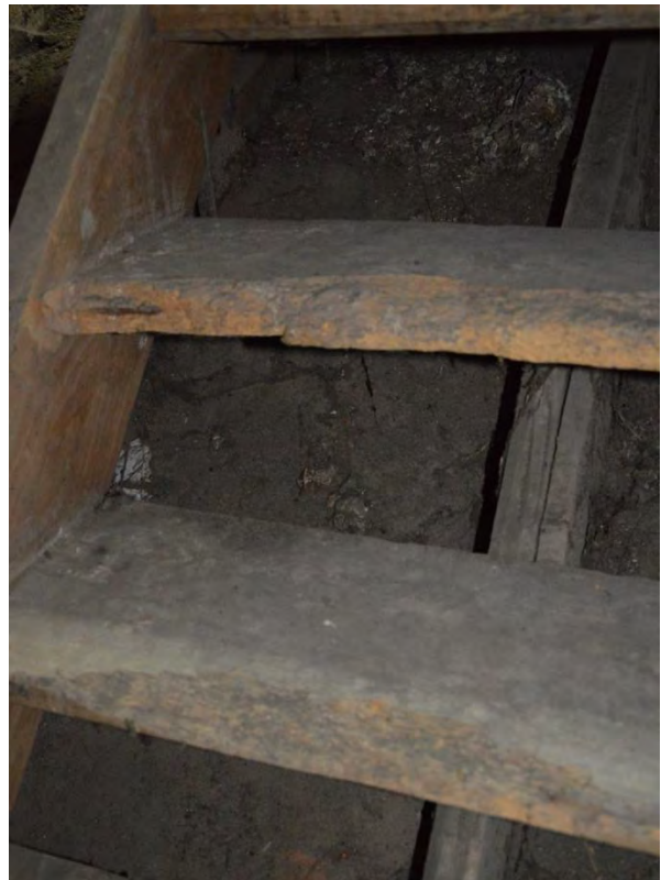
Fig. 174 – Aantasting op de trap in de zolder.
