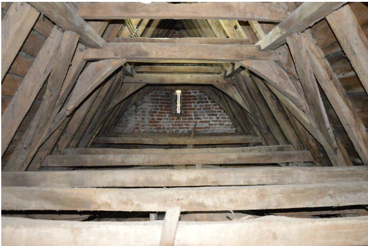
Fig. 132 - De dakconstructie boven de noordelijke dwarsbeuk.
