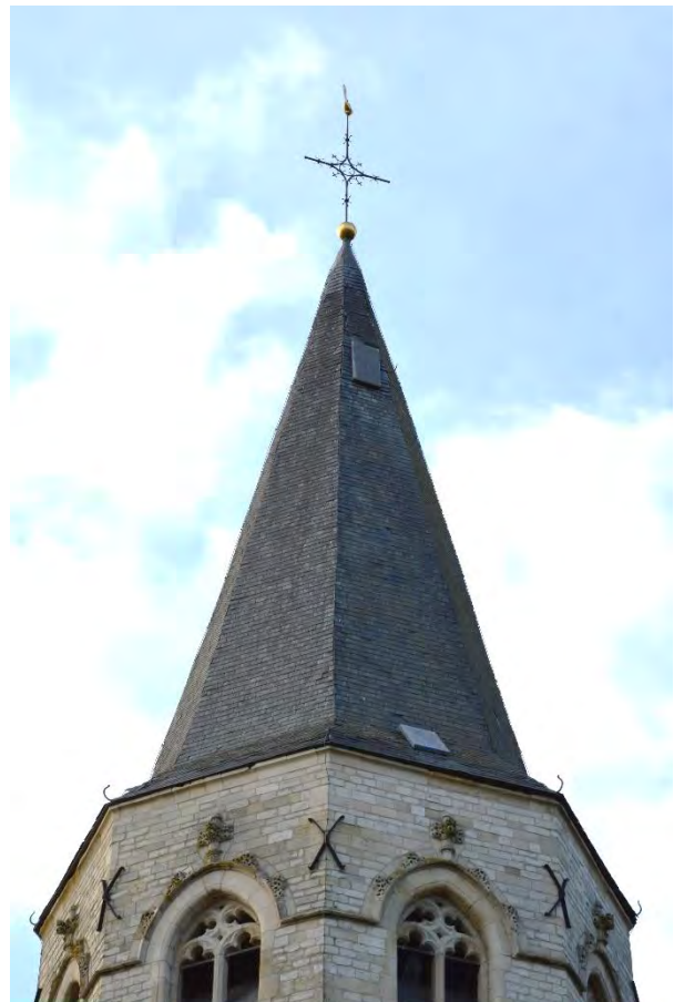
Fig. 50 - Het torendak van de vieringtoren, oostzijde met luiken.
