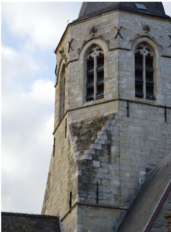
Fig. 157 – Vervuilde afzaten.
