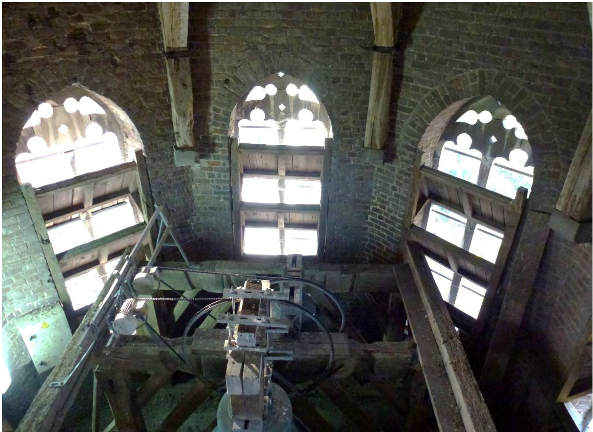
Fig. 141 - Het torenniveau +2, overzichtsfoto.
