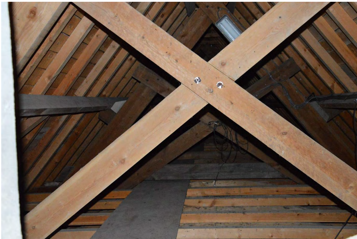
Fig. 131 - De grotendeels vernieuwde dakconstructie van de middenbeuk.
