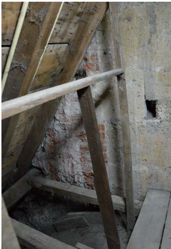
Fig. 129 - Het baksteenmetselwerk aan de zuidzijde van de vieringtoren verwijst mogelijk naar de vroegere locatie van de traptoren.
