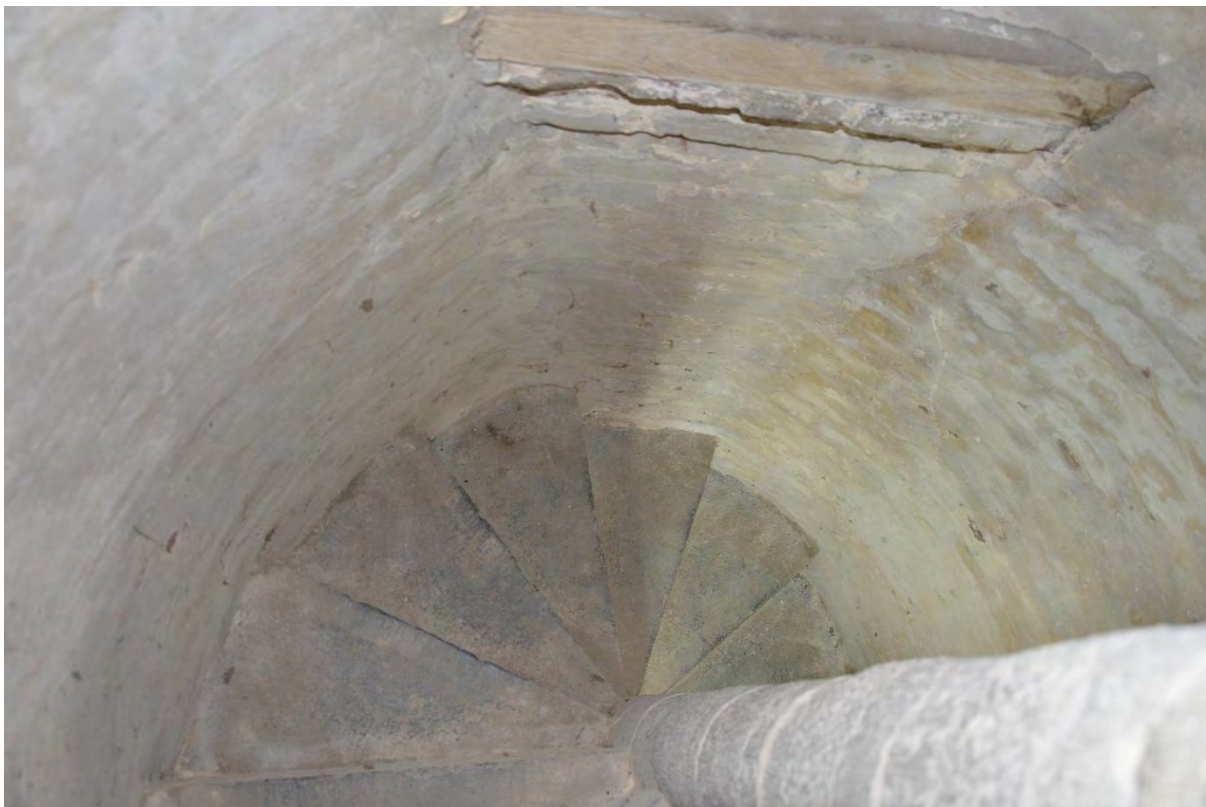
Fig. 124 - De spiltrap van blauwe hardsteen.
