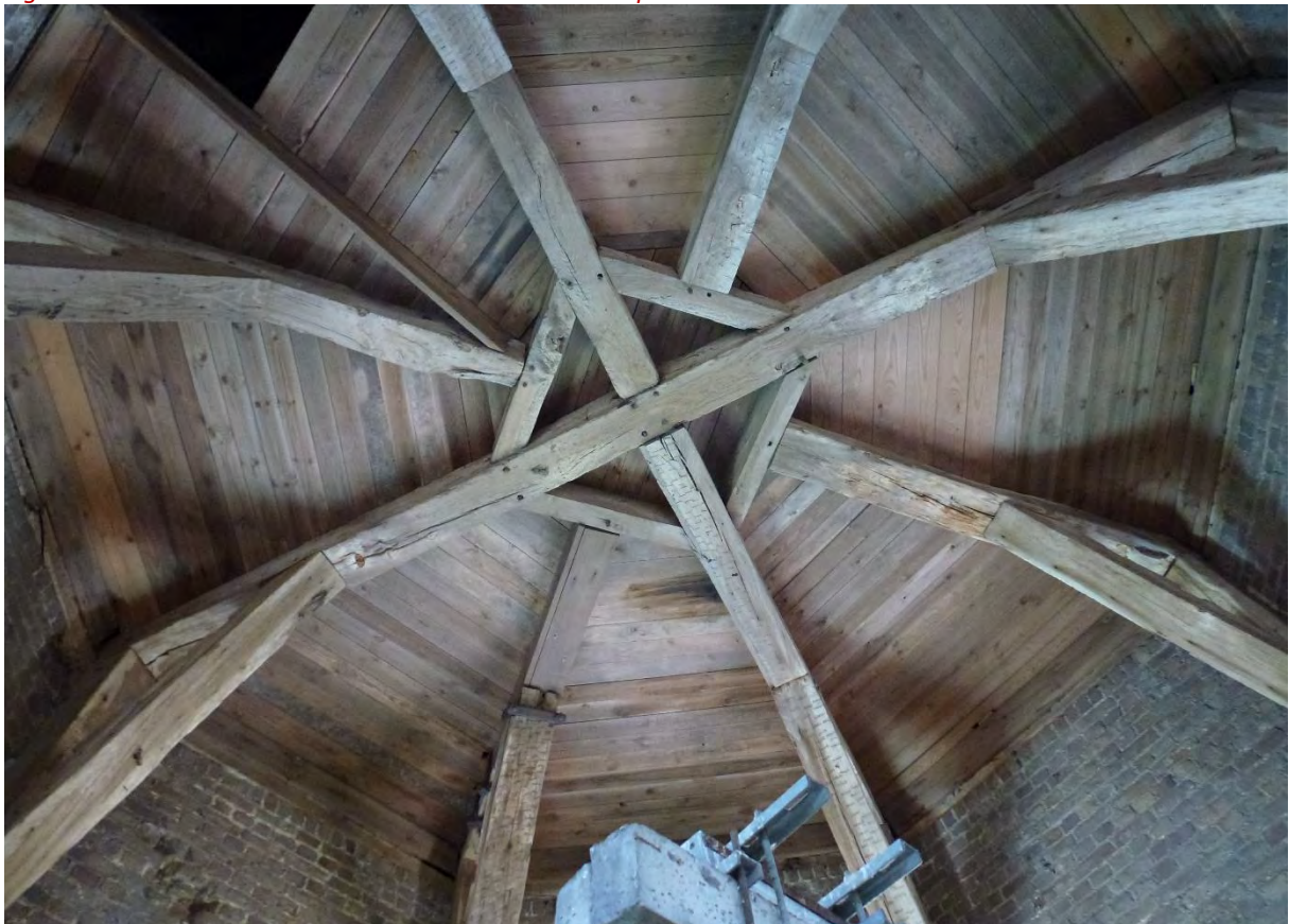
Fig. 144 - Het plafond van niveau +2.
