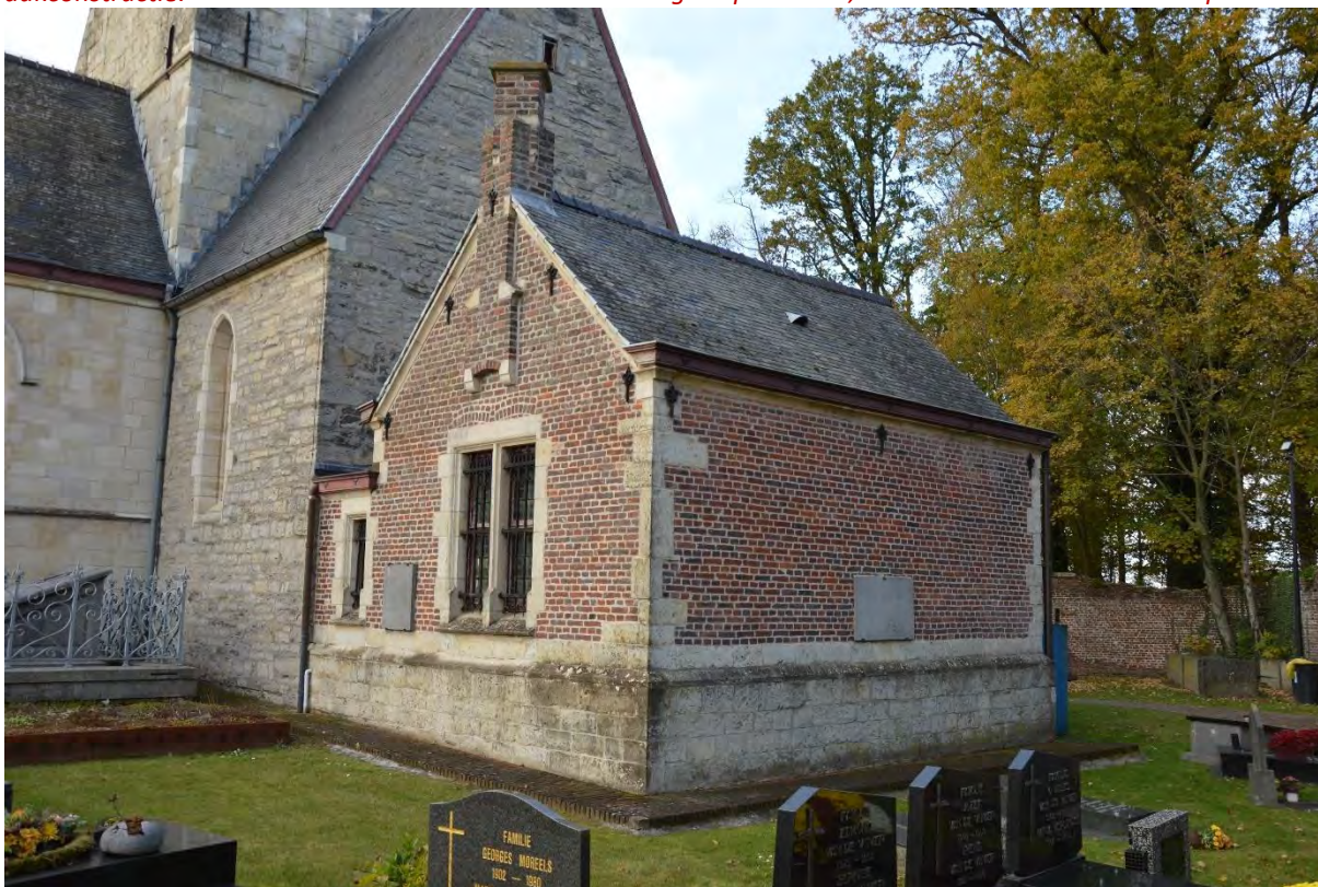
Fig. 25 - De in 1893-1899 aangepaste sacristie. De geveltoppen, de dakconstructie en de gevelopeningen aan de zuidzijde dateren uit deze restauratiecampagne.
