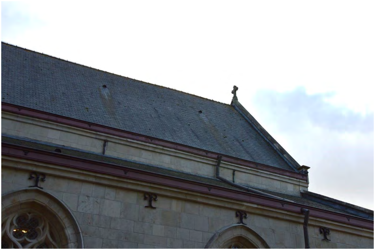
Fig. 45 - Het dak van de middenbeuk en de noordelijke zijbeuk.
