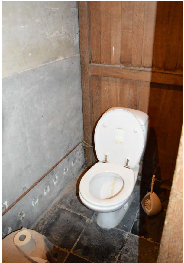
Fig. 64 - Bergruimte doksaa: toilet.
