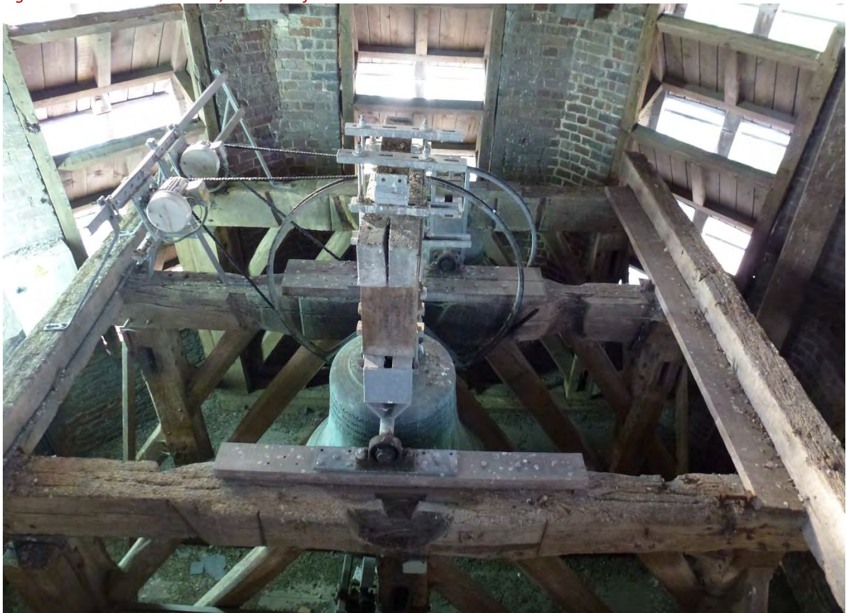
Fig. 142 - De twee luidklokken in hun eikenhouten klokkenstoel.
