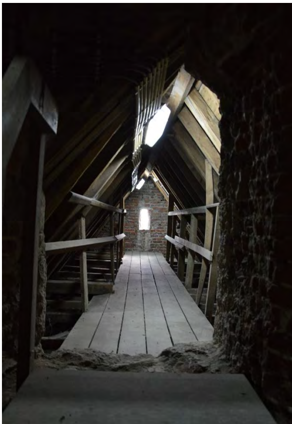
Fig. 128 - De zolder van de zuidelijke dwarsbeuk, gezien vanuit de vieringtoren.
