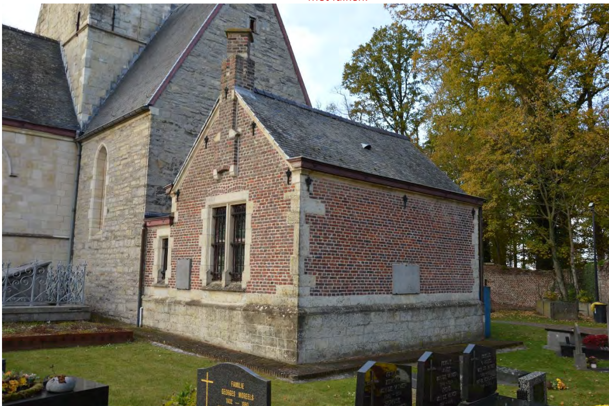
Fig. 51 - Het dak van de sacristie.
