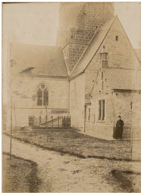
Fig. 17 - De kerk na restauratie in mei 1899, gezien vanaf het zuidoosten.
