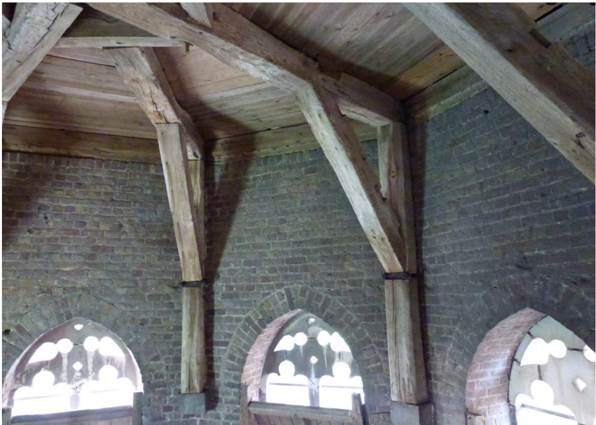
Fig. 20 - De binnenzijde van de achtzijdige torenspits, de bouwplannen en vergelijkend onderzoek van de historische foto's, tonen aan dat de torenspits volledig werd heropgebouwd bij de restauratie van 1893-1899.
