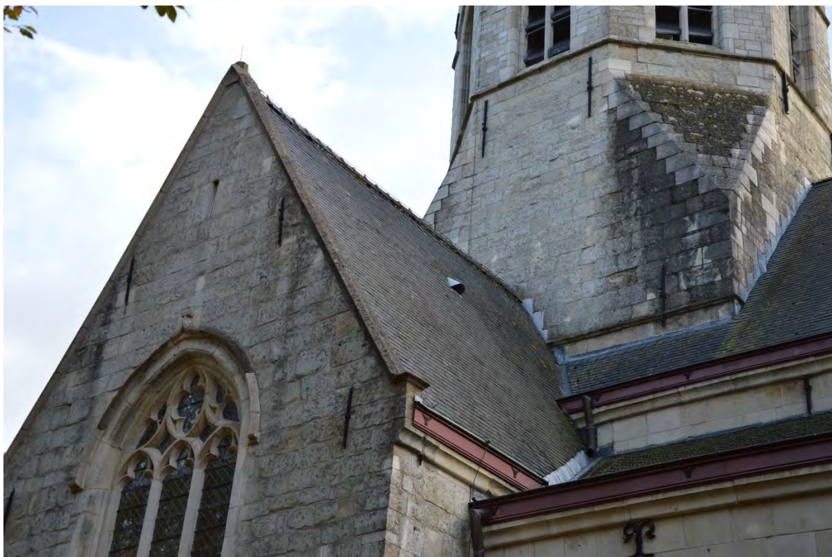
Fig. 47 - Het dak van de noordelijke dwarsbeuk en de aansluitingen met de daken van midden- en zijbeuk.
