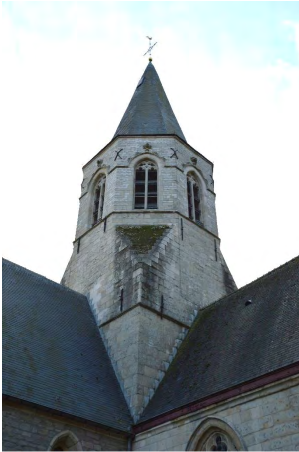
Fig. 43 - De vieringtoren, gezien vanaf het noordoosten.
