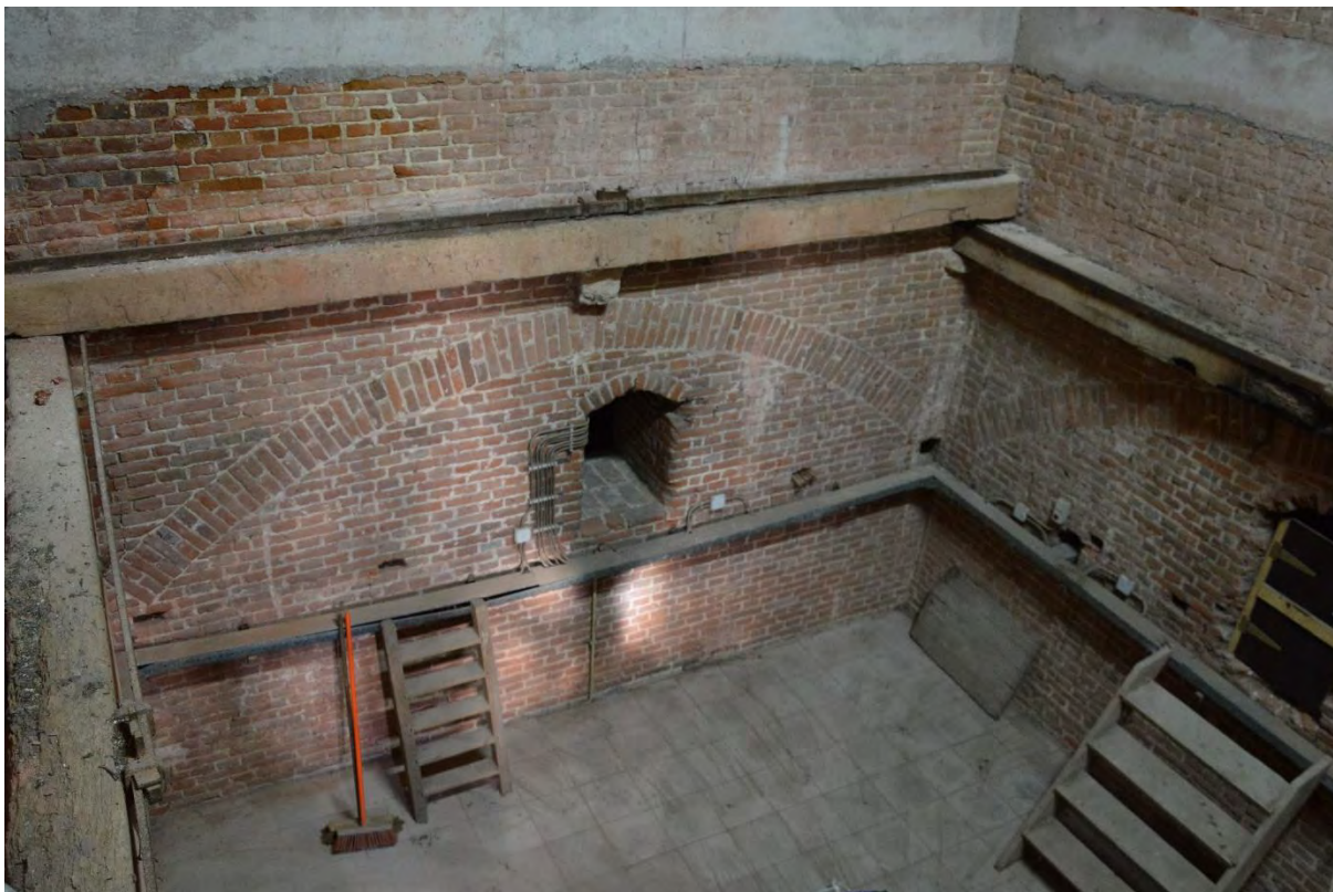
Fig. 137 - Torenniveau +1, zicht op de doorgang naar de noordelijke dwarsbeuk (midden) en het koor (rechts).
