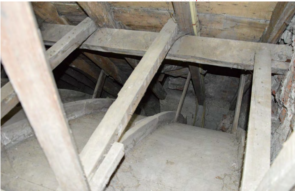
Fig. 130 - Zicht op de dakconstructie en de bovenzijde van het spitstongewelf.
