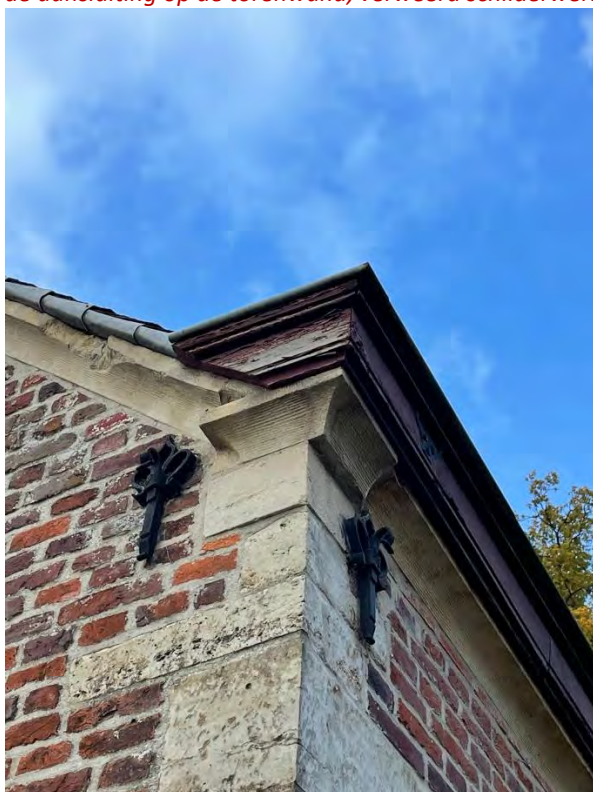
Fig. 153 – Afbladderende verf op de boeiplank.
