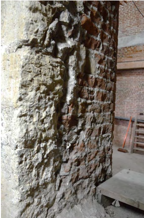
Fig. 19 - Doorgang vanuit de zolder van de zuidelijke dwarsbeuk naar het eerste niveau van de vieringtoren. De snede toont aan dat de bovenste geleding van de vierkante toren is opgetrokken uit baksteen-metselwerk, met een gevelparement in gekantrechte Balegemse steen.
