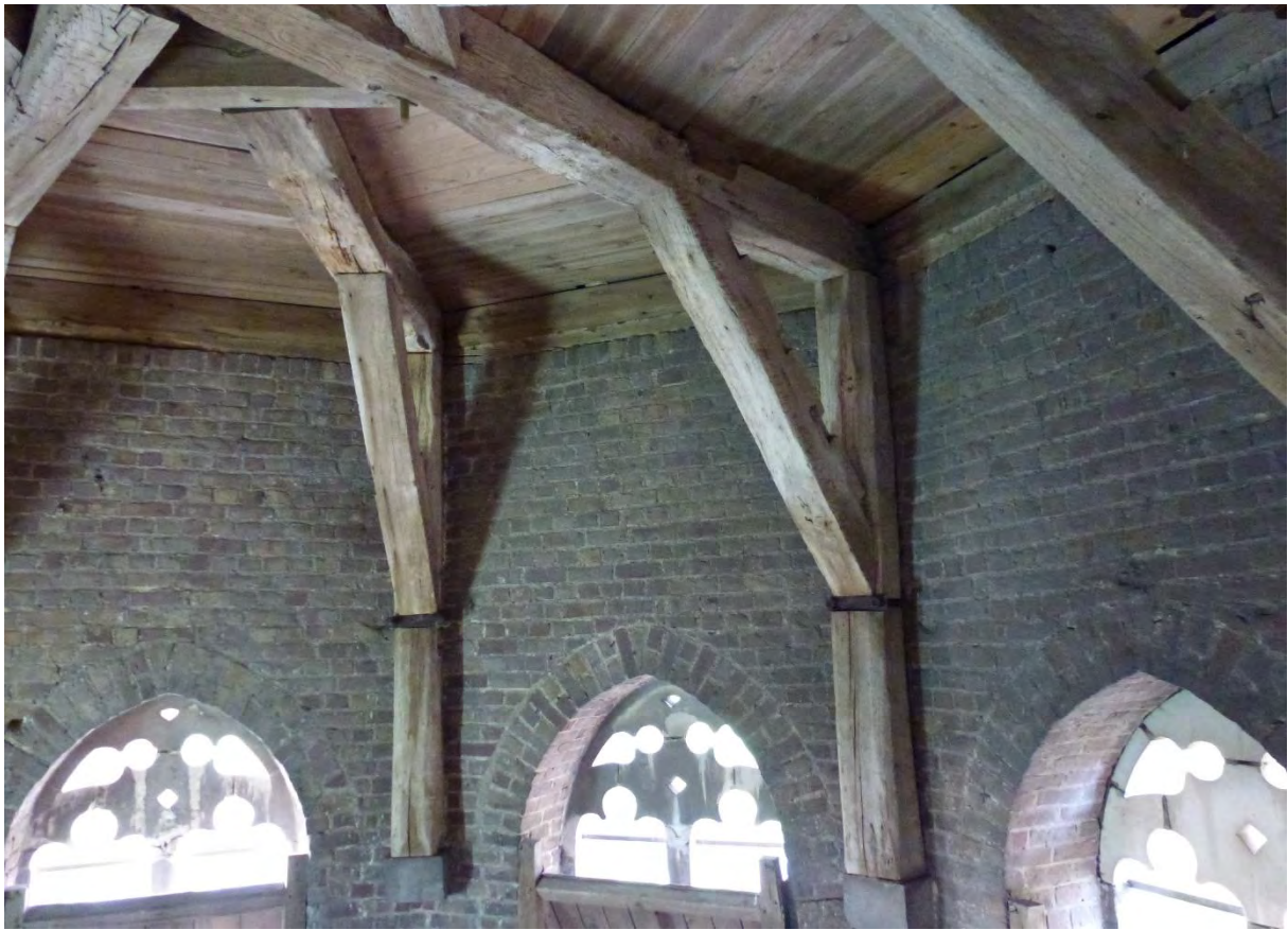
Fig. 143 - De basis van de dakconstructie van de torenspits.
