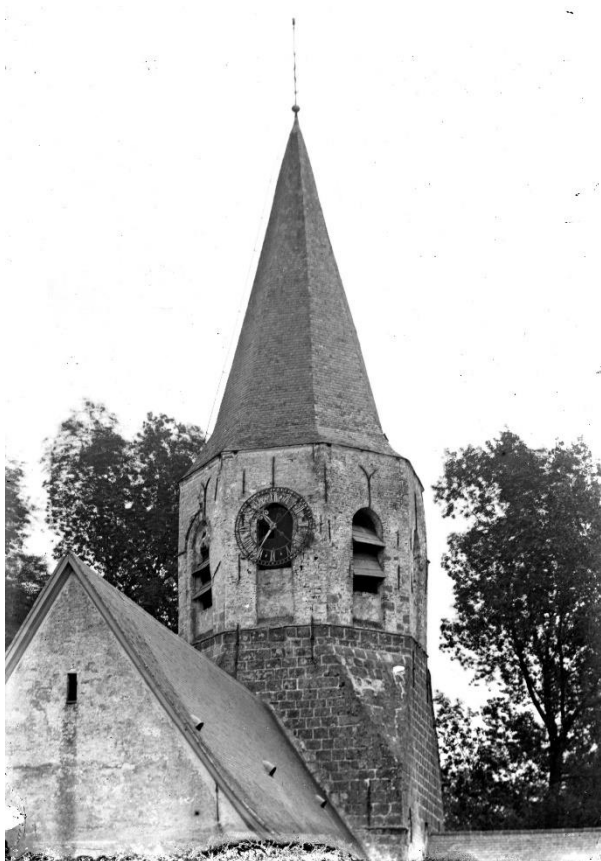
Fig. 14 - Foto van de toren (+ delen van de middenbeuk en de zuidelijke dwarsbeuk) in 1892, voor restauratie.
