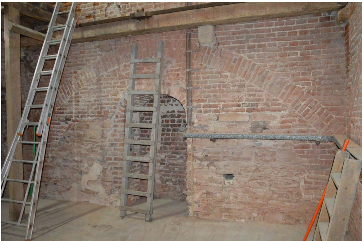
Fig. 18 - Interieur van de toren (niveau + 1), zicht naar het westen. De toren bewaart een basis in onregelmatige blokken Doornikse steen, identiek aan het metselwerk van het koor.
