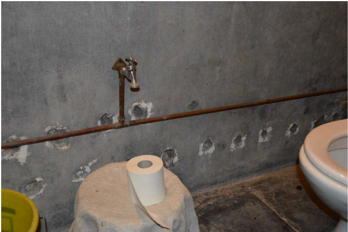
Fig. 172 – Injecties in de muren tegen opstijgend vocht.
