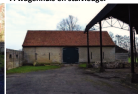
10. hangar en schuur
