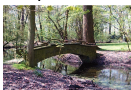
28. stenen brug bij vijver
