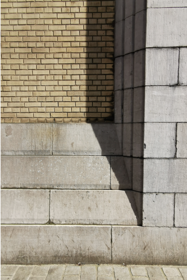
detail voorgevel Nationalestraat
