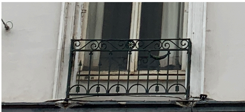
Afbeelding 11. Detailfoto balustrade voor raam tweede bouwlaag.
