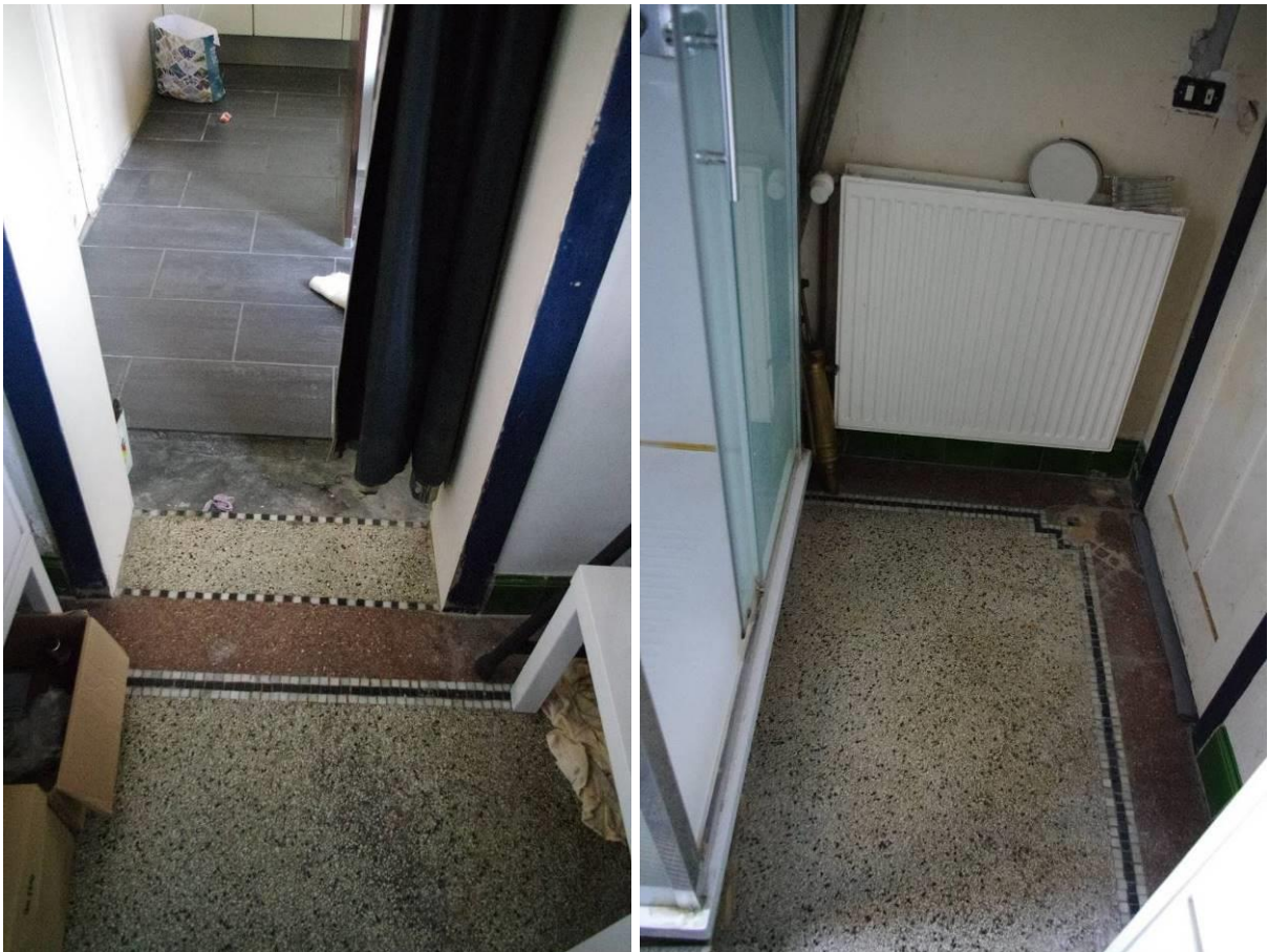
Figuur 206 - 207: oorspronkelijke terrazzovloer in de berging
