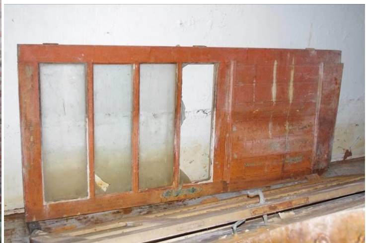
Figuur 118 (links): type buitendeur - westgevel van de ijzerwinkel. De glasruiten werden mee geschilderd.
