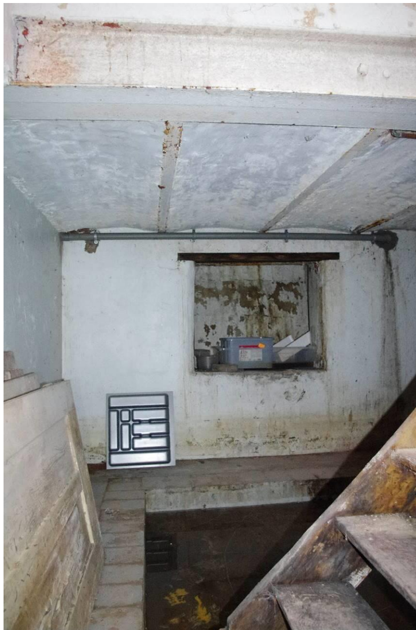
Figuur 232: zicht in de kelder
