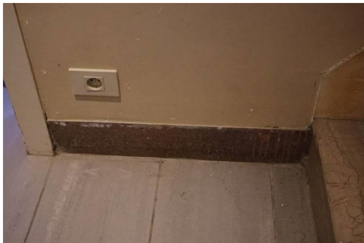
Figuur 192: zicht op de doorlopende terrazzo plint
