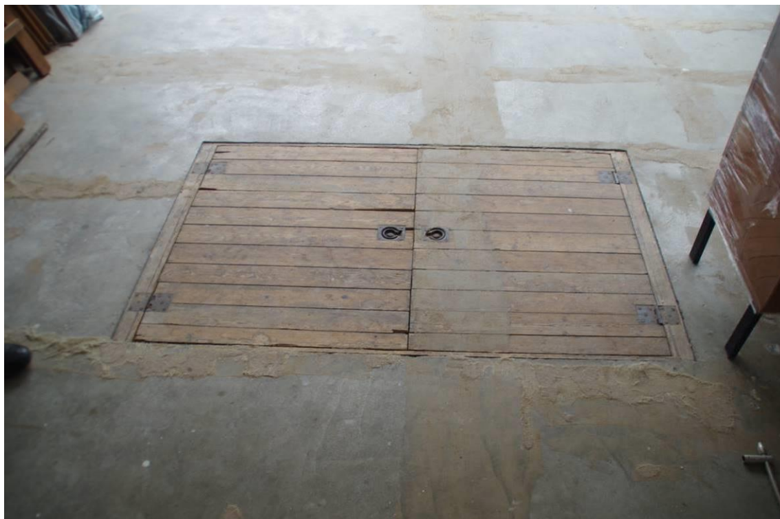
Figuur 182: zicht op het vloerluik boven de garage
