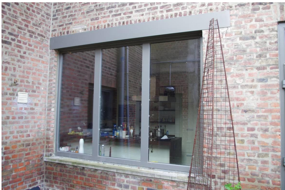
Figuur 132: huidige invulling van het keukenraam in de oostgevel van het huis - vast schrijnwerk PVC
