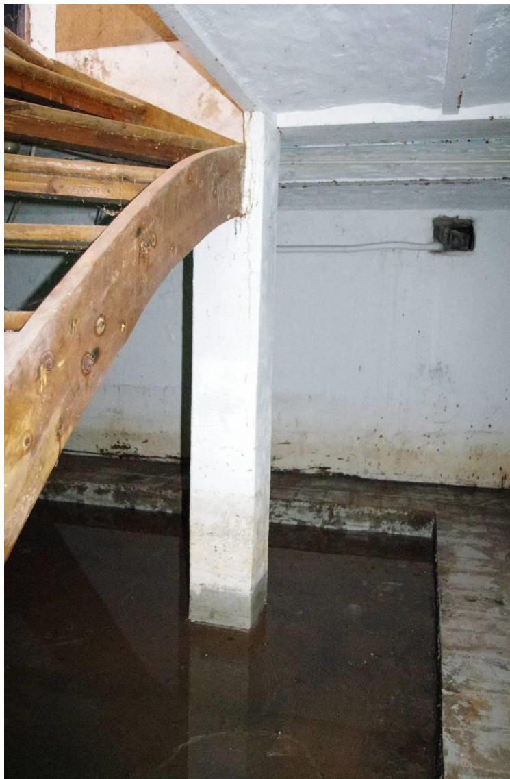
Figuur 231: zicht in de kelder
