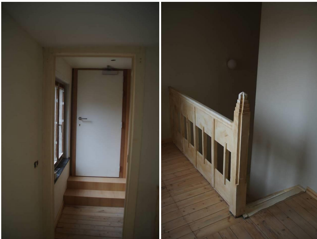
Figuur 234 (links): zicht op de hal en de verhoogde toegang naar de winkelruimte (met branddeur)
