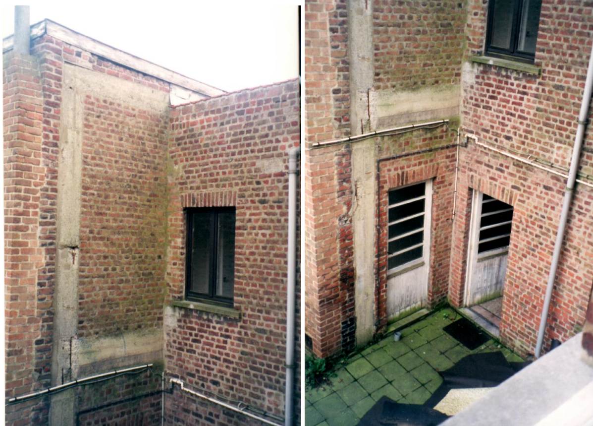
Figuur 93 - 94: vrije westelijke eindgevel van de ijzerwinkel - foto's 2001 - de schrijnwerken van de woning (rechter gevel op de beide foto's) werden ca. 2002 vervangen; de deur naar de ijzerwinkel bleef tot op heden behouden (archief architect J. Boens)
