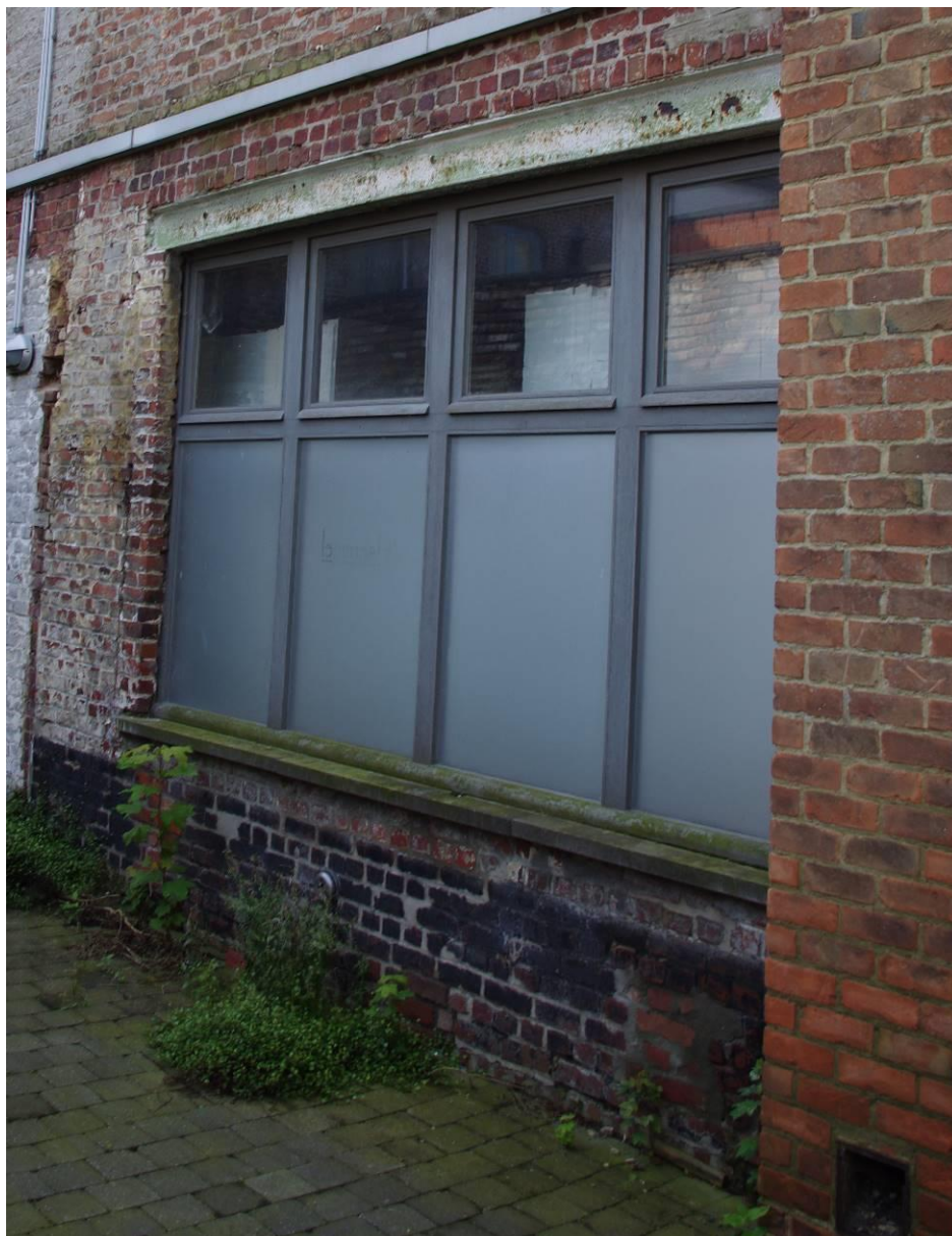
Figuur 134: houten schrijnwerk van het vml. kantoor, heden sanitair (noordgevel ijzerwinkel)
