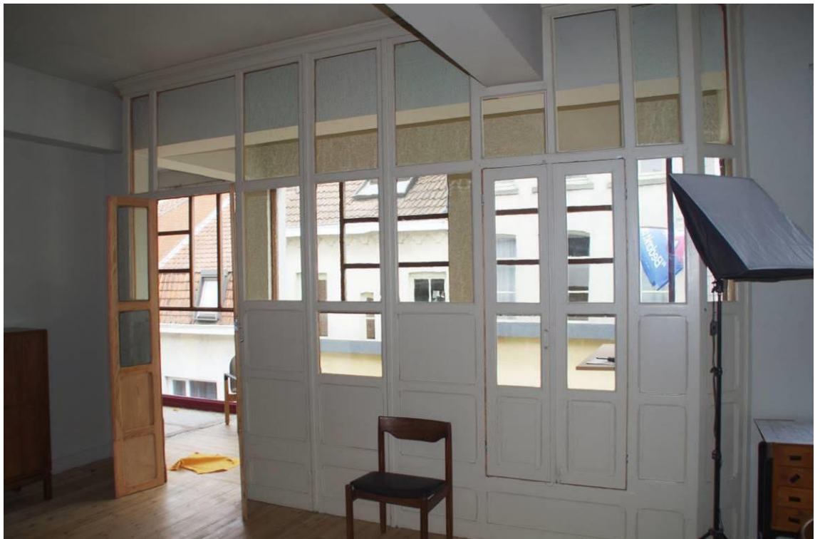
Figuur 170: binnenschrijnwerkgeheel gebouwd ter hoogte van de noordelijke traveeën - waarschijnlijk recuperatie
