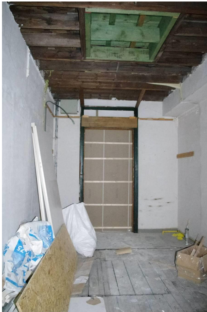
Figuur 184: zicht op de ruimte boven de zuidelijke doorgang, deel west (kijkrichting oost)
