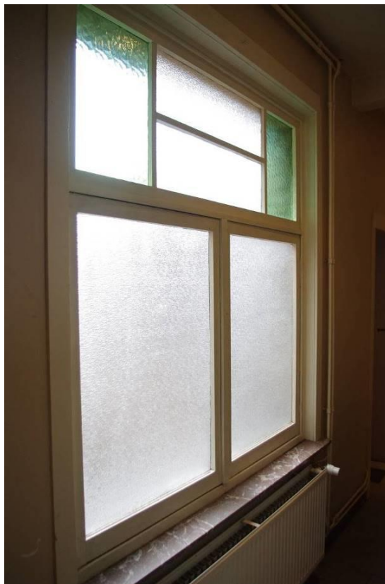
Figuur 195: binnenzicht op de vensteropening
