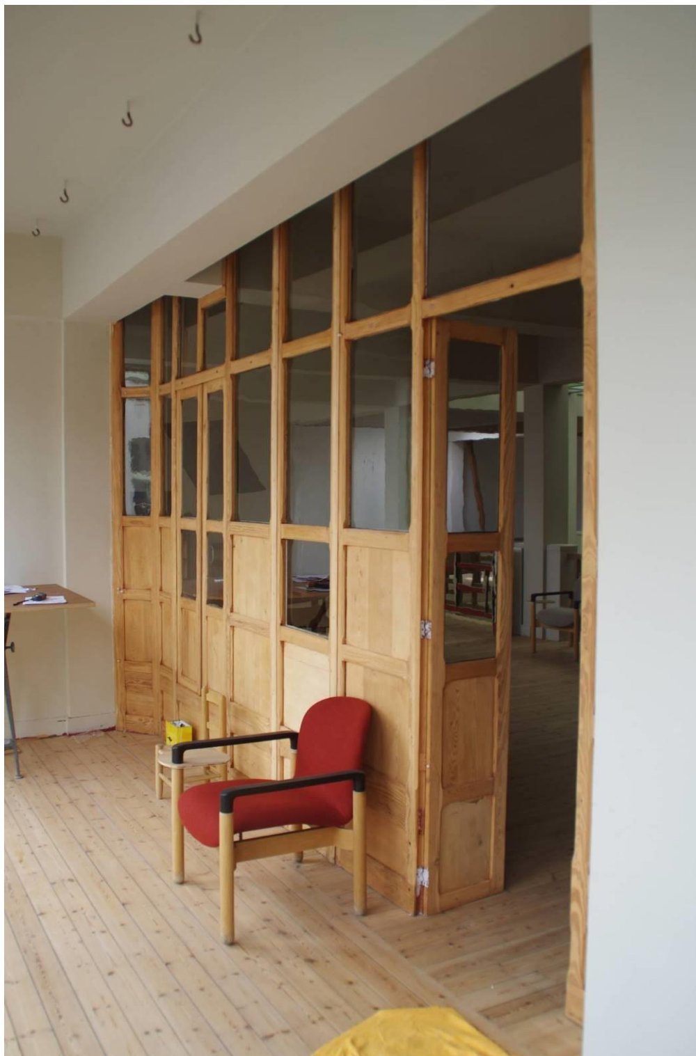
Figuur 171: binnenzicht in de noordelijke galerij op verdieping +1 aan de voorgevel
