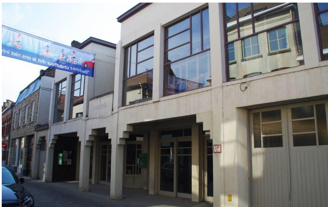
Figuur 72: zicht op de voorgevel van de ijzerwinkel in de Nieuwstraat
