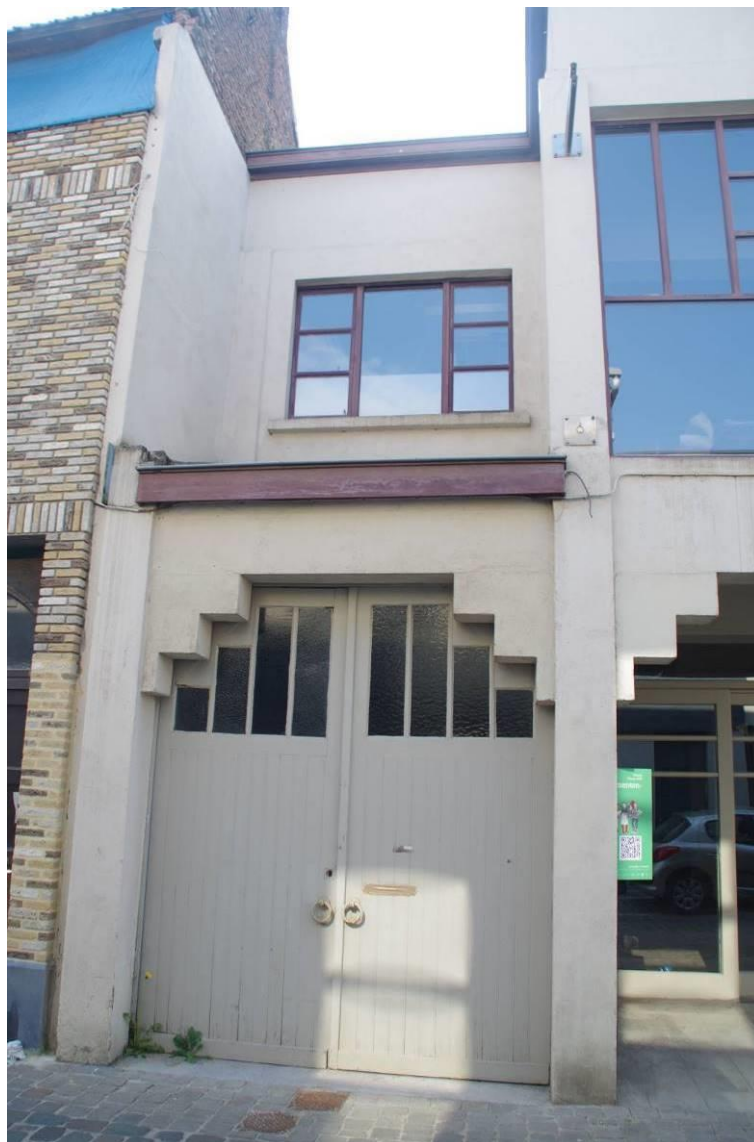
Figuur 74: zicht op de poort van de zuidelijke doorgang naar de achterliggende smidse
