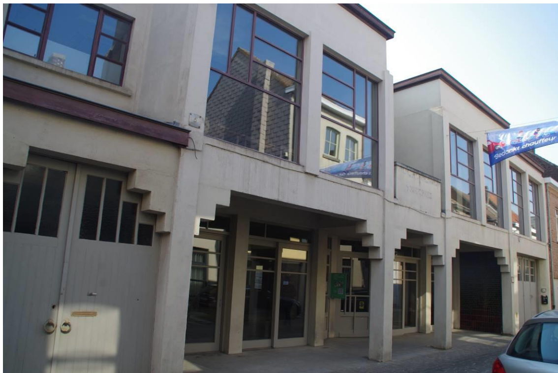
Figuur 73: zicht op de voorgevel van de ijzerwinkel in de Nieuwstraat
