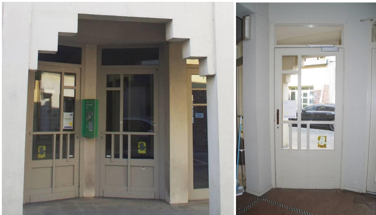
Figuur 83 (links): buitenzicht op het oorspronkelijke gevelschrijnwerk aan de hoofdinkom
