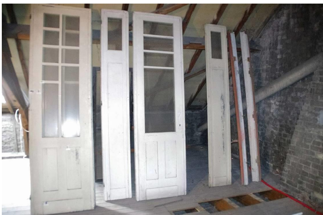
Figuur 219: het deurgeheel bestaande uit vijf beglaasde panelen, afkomstig uit de opening tussen eet- en zitkamer
