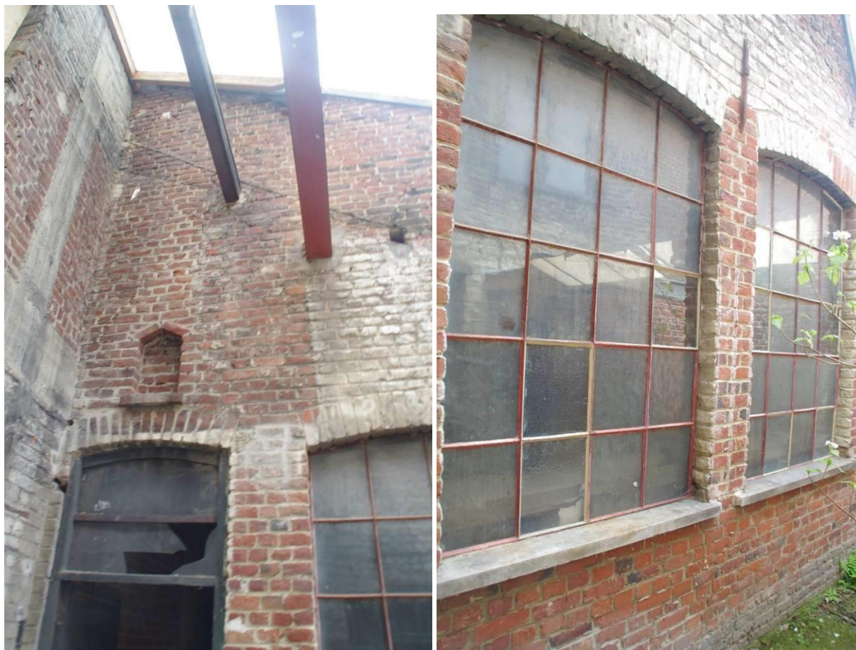
Figuur 99 - 100: noordgevel van de smidse vanuit de zuidelijke binnenkoer
