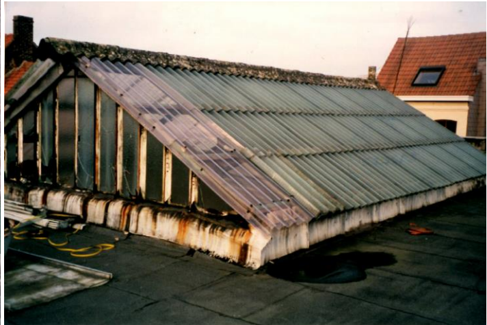
Figuur 112 (links): deels bewaarde gewapende glazen golfplaten van de dakkoepel op de berging boven de smidse 44 .
