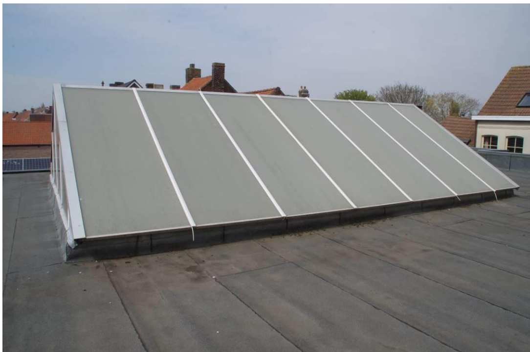
Figuur 110: zicht op de hedendaagse bekleding met polycarbonaat kanaalplaten en PVC schrijnwerk
