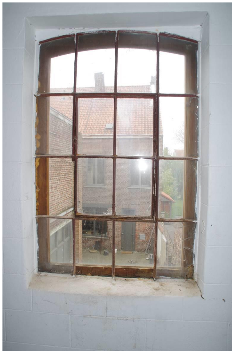
Figuur 183: binnenzicht op het metalen gevelschrijnwerk in de westgevel
