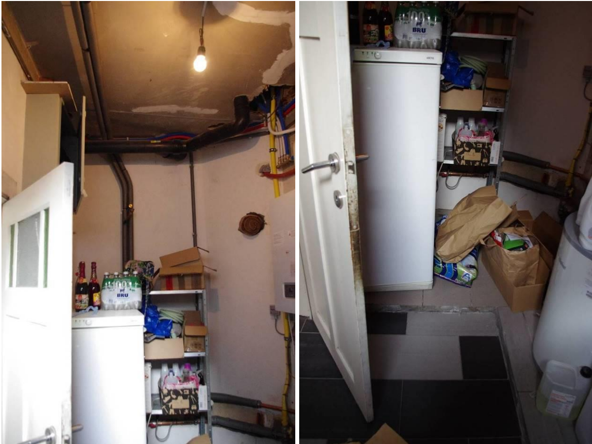
Figuur 213 - 214: stookruimte en detail van de vloerbetegeling
