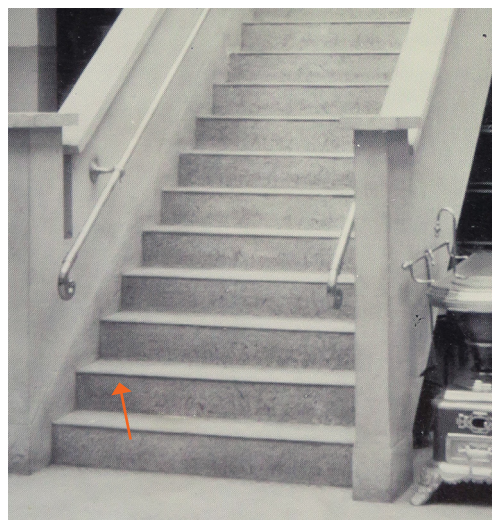
Figuur 45 (links): Detail van de trap na reconstructie (met trapneuzen) (© Verdonck Ann, 2004)
