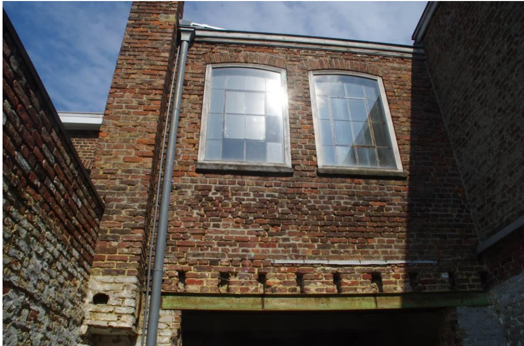
Figuur 98 : detail westgevel van de garage-annex
