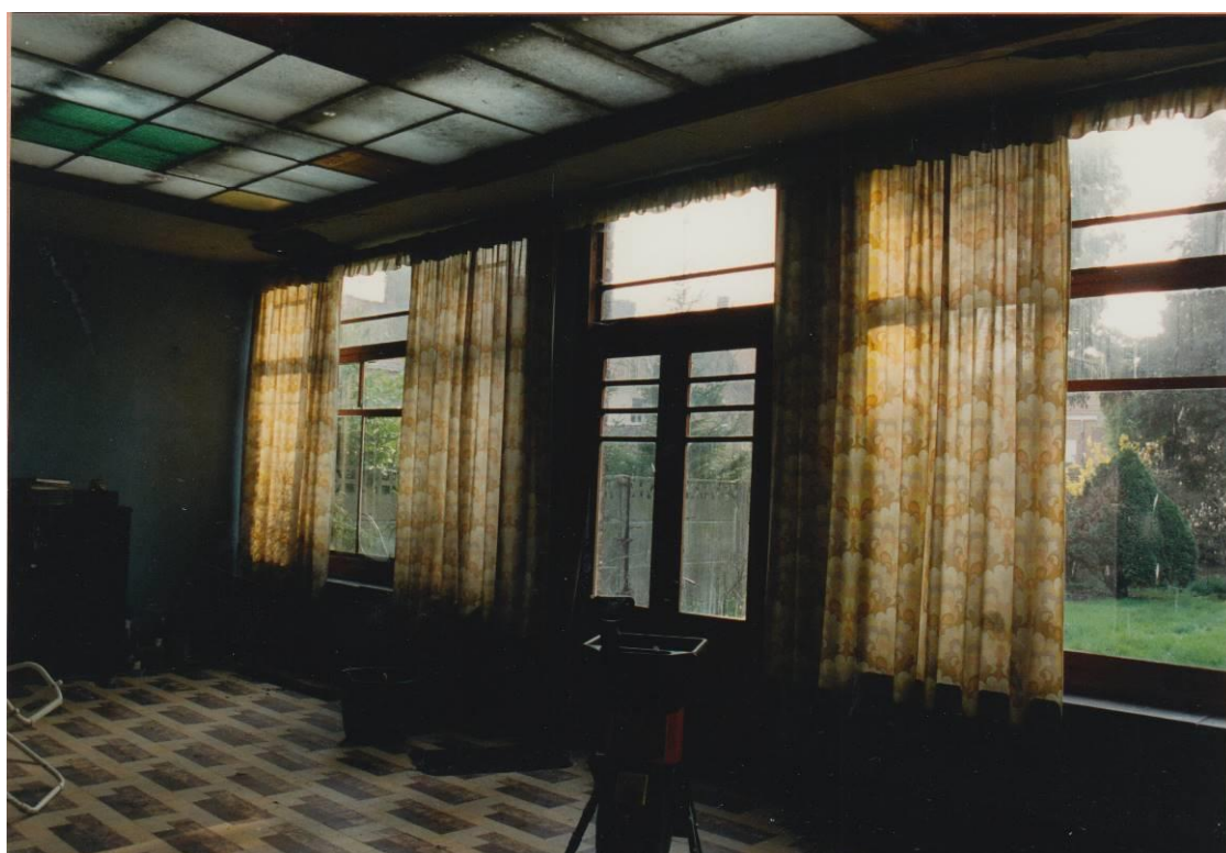
Figuur 230: zicht op de historische veranda in 2000. Alle elementen op deze foto werden afgebroken en bleven niet bewaard. Verdwenen erfgoedelementen . (archief Onroerend Erfgoed)
