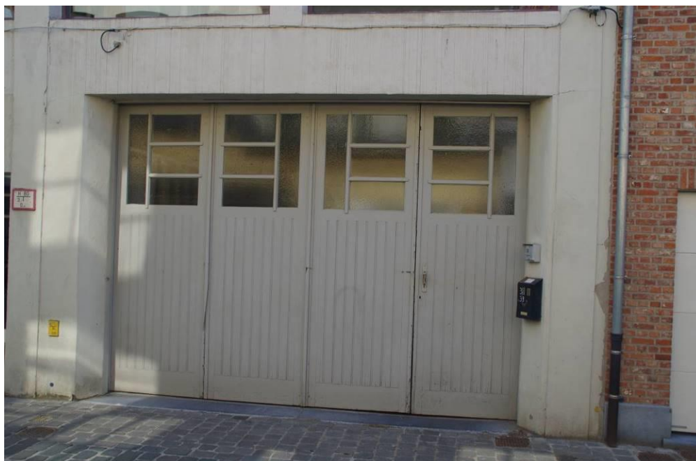
Figuur 92: zicht op de poortdoorgang onder de noordelijke annex
