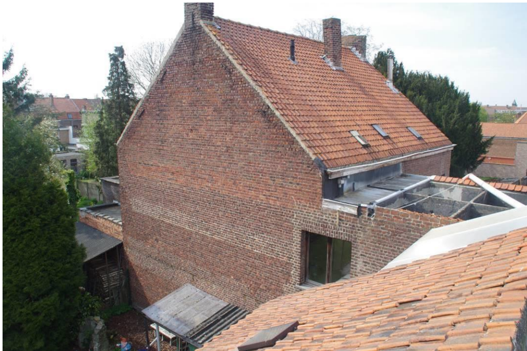
Figuur 102: blinde zuidelijke zijgevel woning en gevel van het doorgangsvolume
