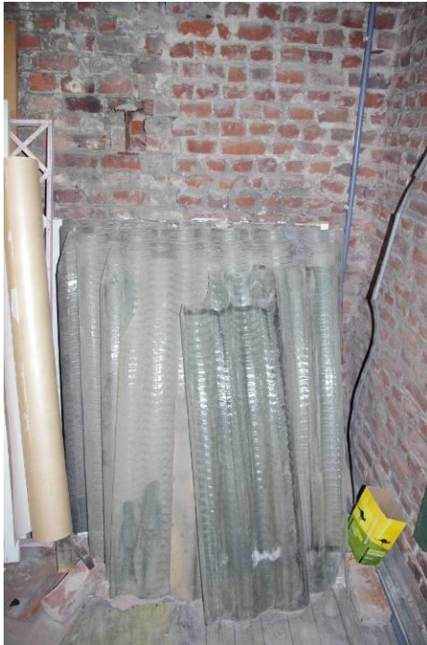
Figuur 112 (links): deels bewaarde gewapende glazen golfplaten van de dakkoepel op de berging boven de smidse 44 .
