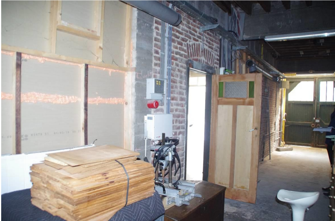
Figuur 154: binnenzicht in de zuidelijke doorgang (openstaande deur naar de ijzerwinkel)
