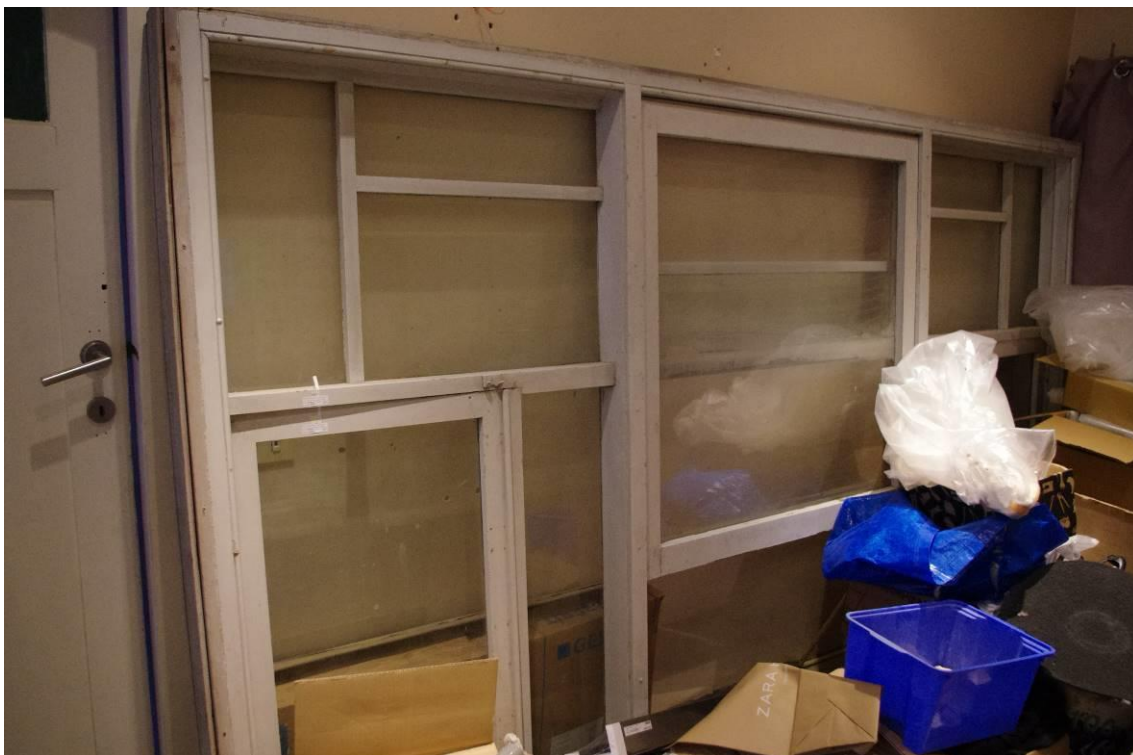
Figuur 129: zicht op het origineel schrijnwerkelement in de inkom van de woning
