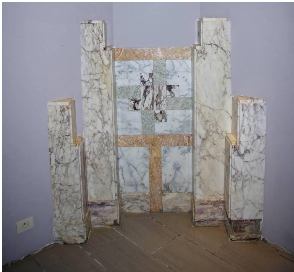
Figuur 225: detail van marmeren schouw - de tussenmuur naar de eetplaats (links) werd ca. 2002 dikker afgewerkt, waardoor de linker elementen deels in de muur verdwenen (vergelijk met volgende figuur).
