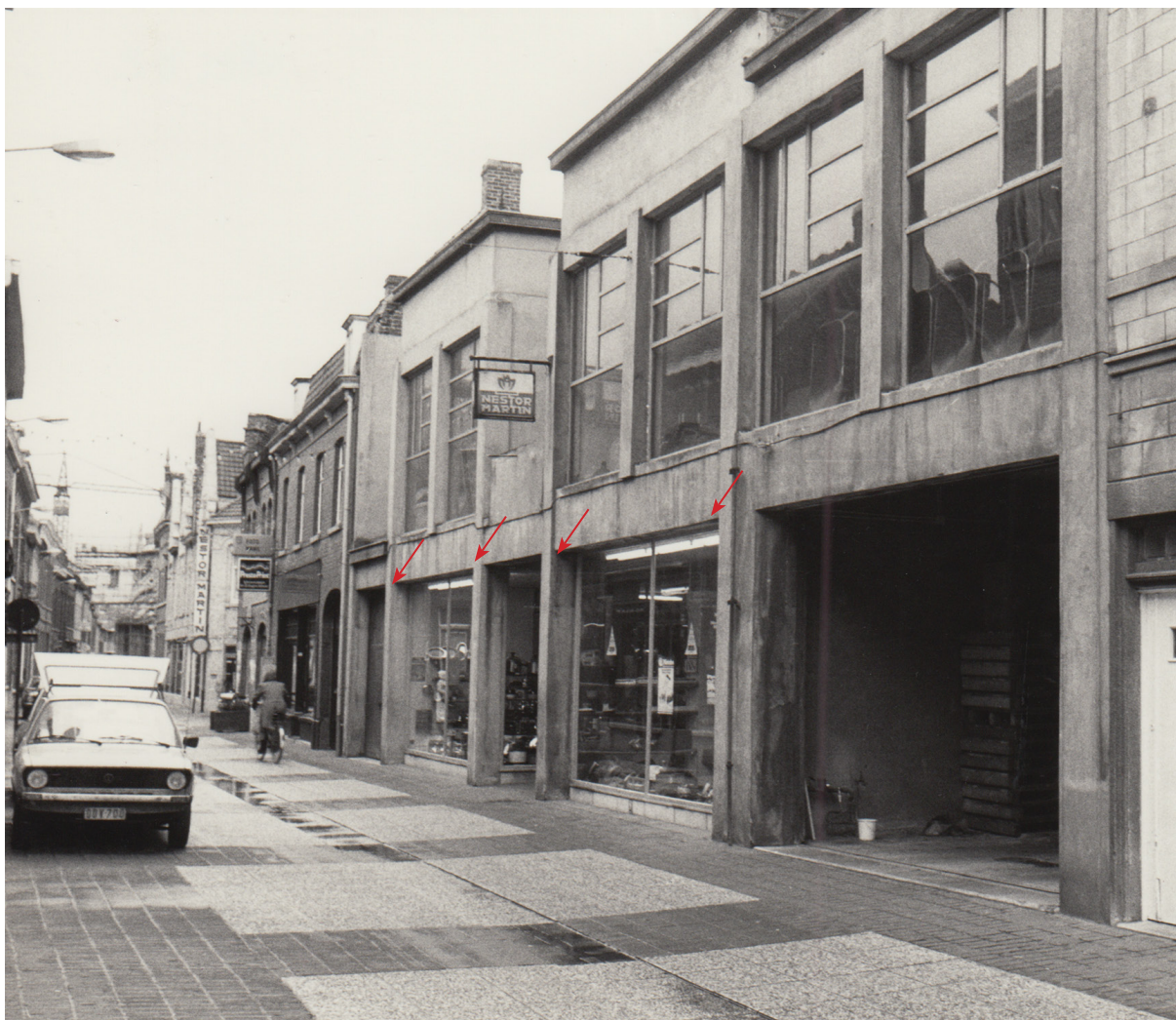
Figuur 36: Voorgevel van de ijzerwinkel met de vitrine uit 1956 en de verwijderde consoles. De vervuilde simili was op dat moment niet overschilderd (© Vlaamse Overheid, december 1982)
