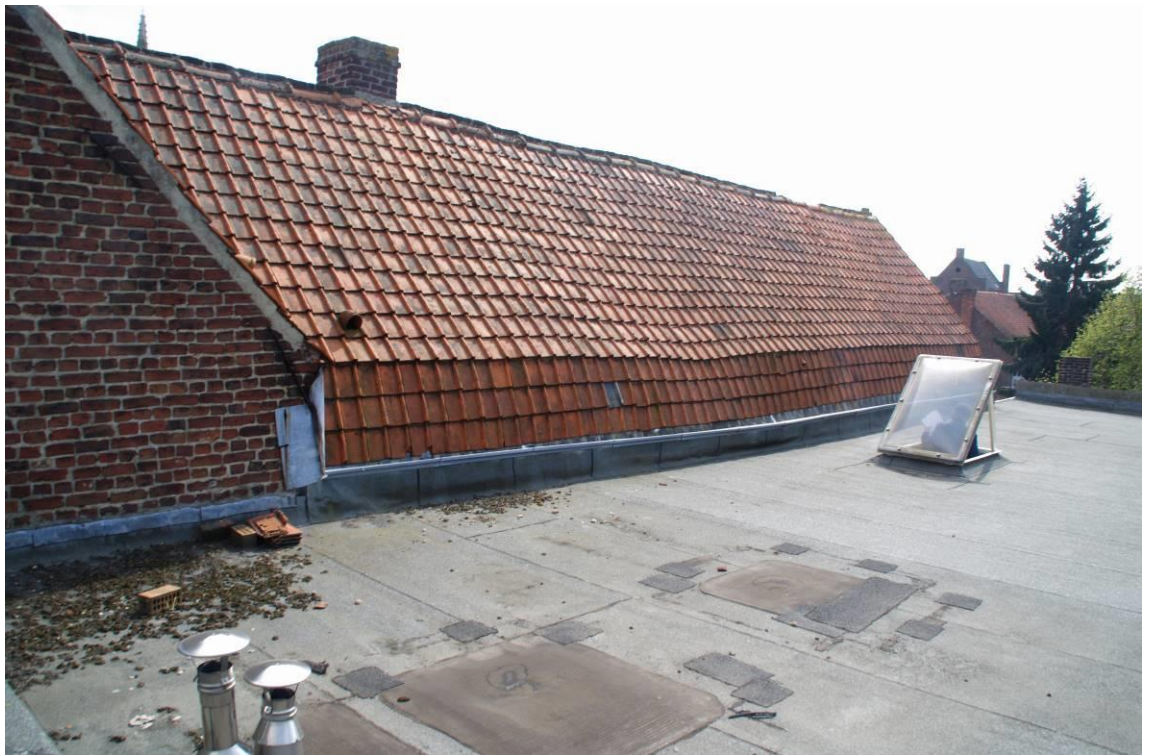
Figuur 109: zicht op het platte dak en de daklichtopening. Het dak in orangerode stormpannen is de buur Nieuwstraat 37.
