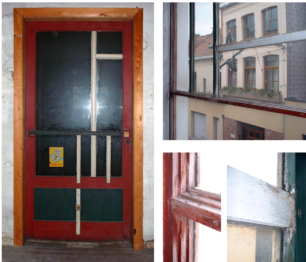
Figuur 57 (links): Eén van de inkomdeuren gerecupereerd in het interieur (© Verdonck Ann, 2002)
