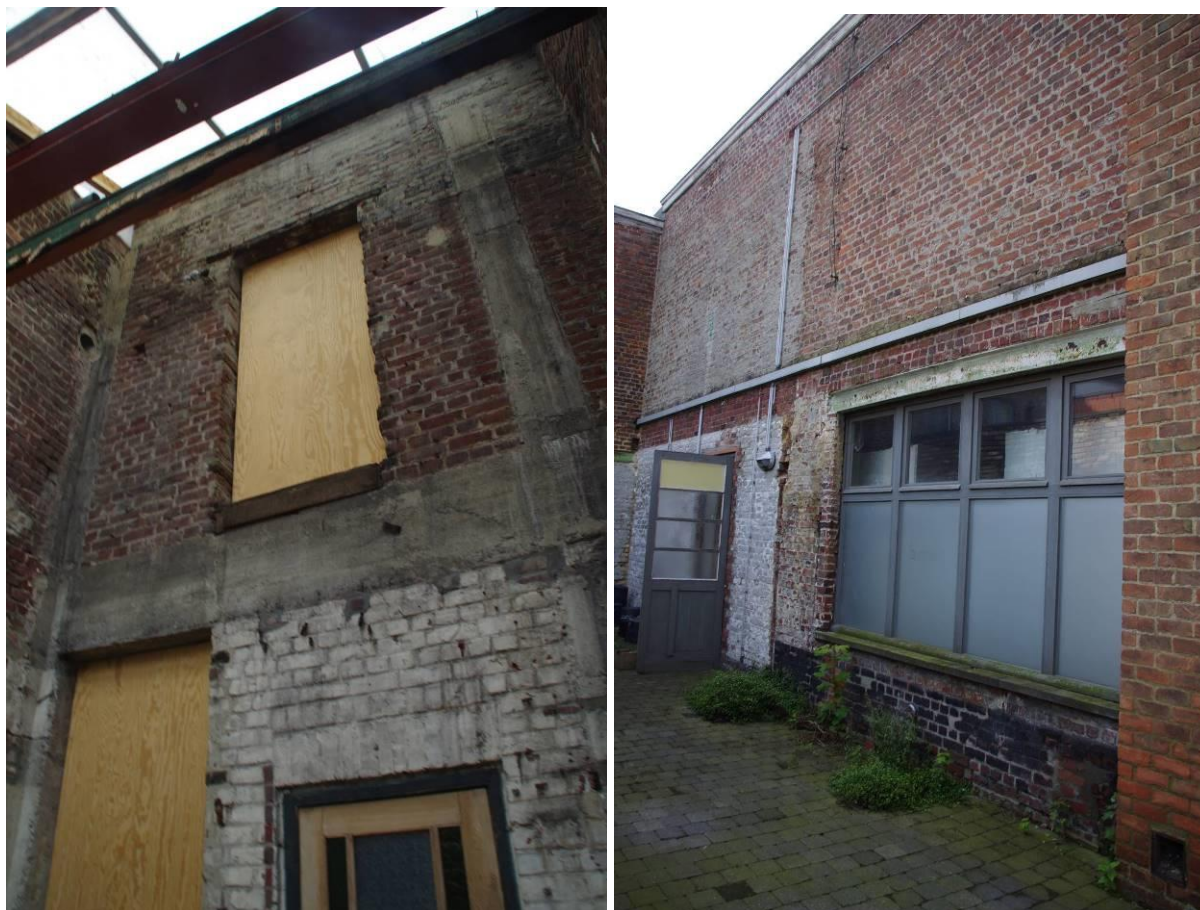
Figuur 95 (links): zicht op de westgevel van de ijzerwinkel vanuit de zuidelijke koer - de twee beplankte openingen werden in de tweede helft van de 20 ste eeuw gemaakt voor de plaatsing van een trap (na het afbreken van de betontrap). Allicht werd deze binnenkoer dan ook overdekt.
