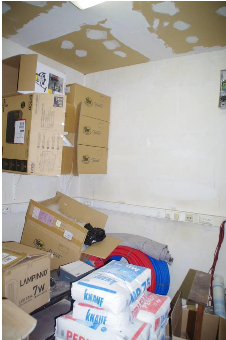
Figuur 158: binnenzicht op de bergplaats
