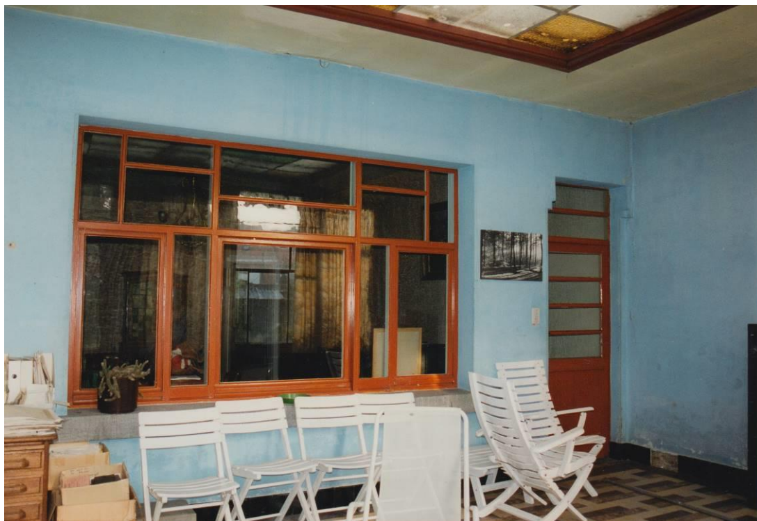
Figuur 107: foto uit 2000 van de oorspronkelijke achtergevel vanuit de latere veranda - buitendeur ter hoogte van de gang - vergelijk met Figuur 127 (archief Onroerend Erfgoed)
