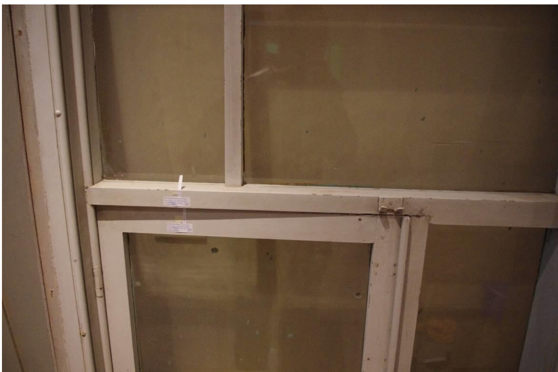
Figuur 130: detail ter hoogte van de afgenomen spanjoletten
