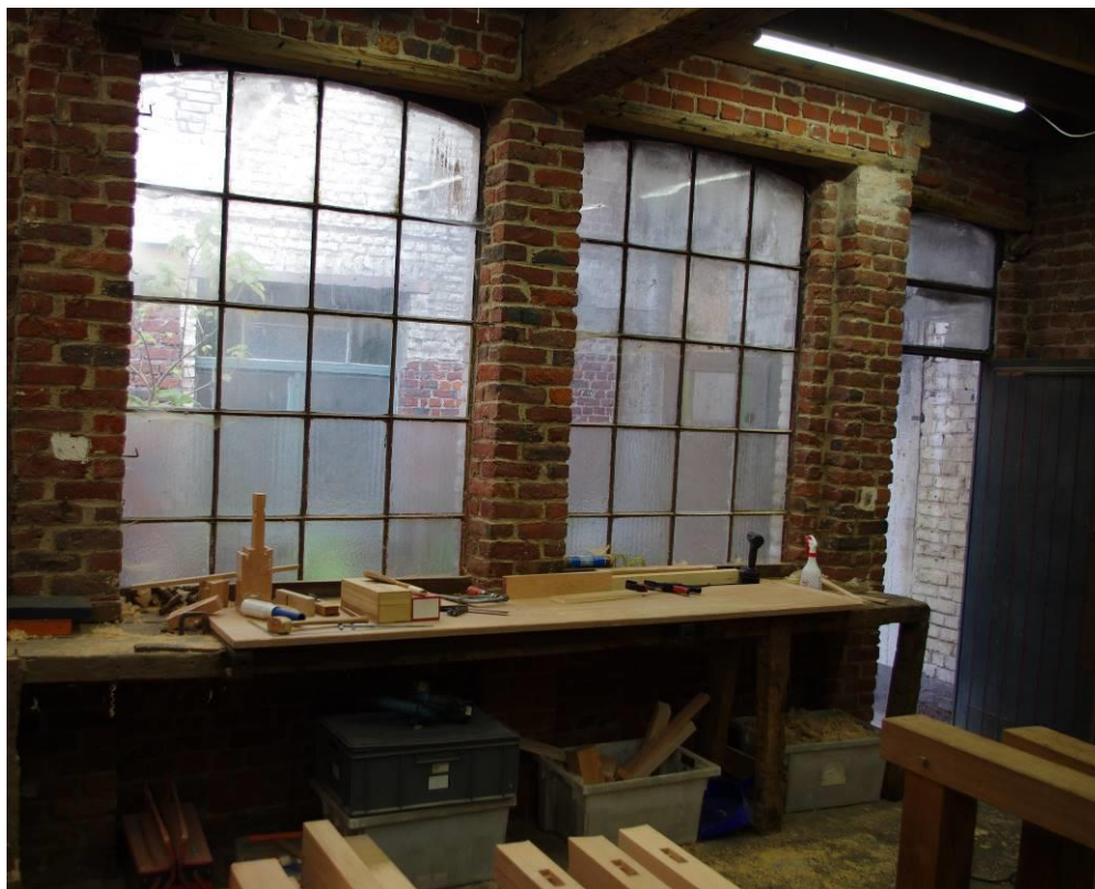
Figuur 135 : gietijzeren ramen in de smidse. Houten opgeklampte buitendeur.
