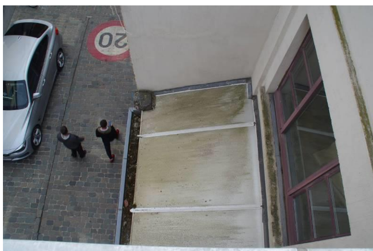
Figuur 75: zicht op de lichtstraat boven de poort naar de zuidelijke doorgang
