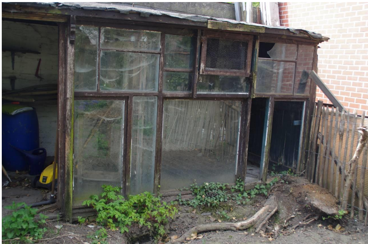
Figuur 131 : raam van de westgevel van het woonhuis, uitgenomen ca. 1924 bij de bouw van de veranda en hergebruikt als kippenhok
