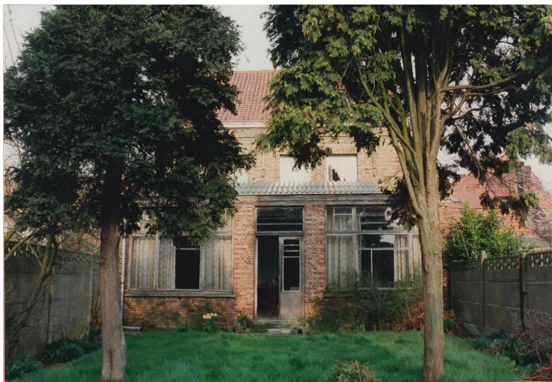
Figuur 108: foto van de westelijke achtergevel voor de restauratiewerken in 2002 - met nog aanwezige veranda - verdwenen erfgoedelement (archief Onroerend Erfgoed)
