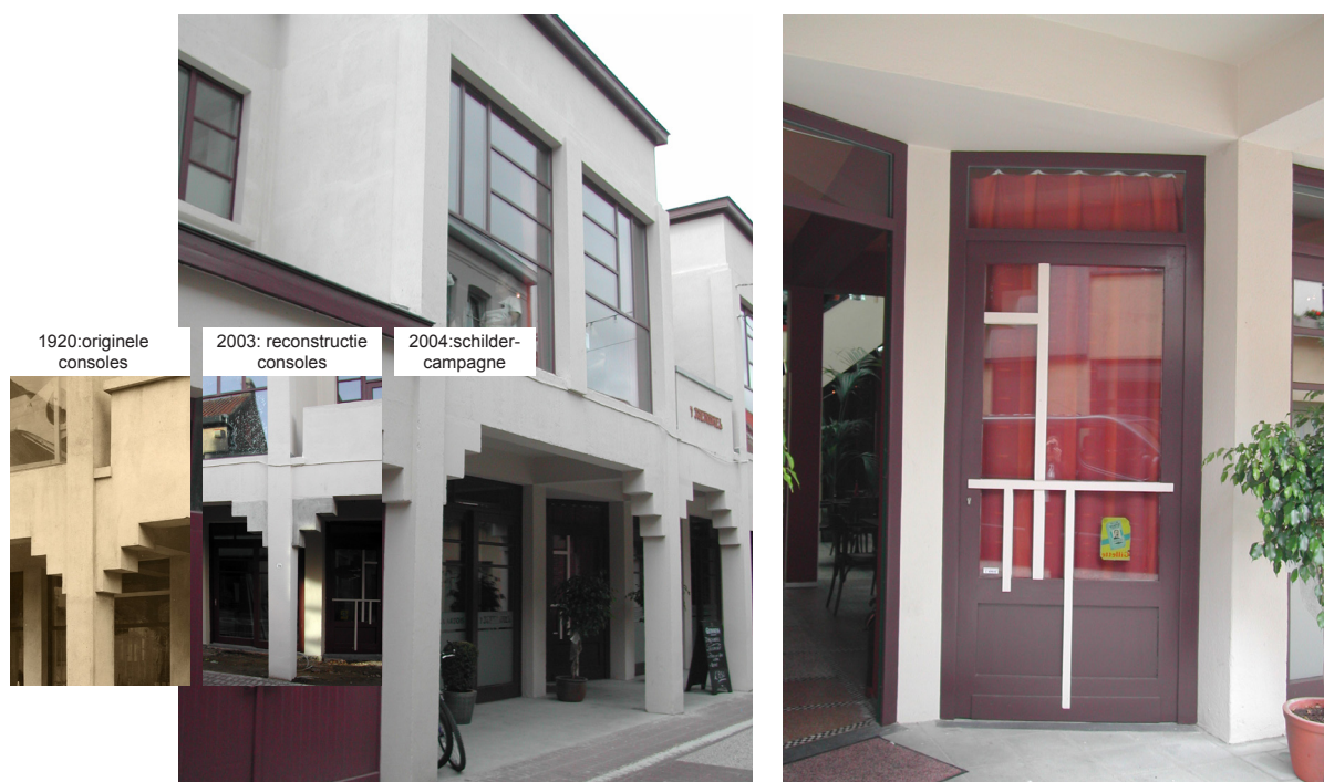
Figuur 42 (links): Wit geschilderde voorgevel, bordeaux-bruin schrijnwerk en reconstructie van de (te brede) kubistische accenten (© Verdonck Ann, 2003 en 2004)
