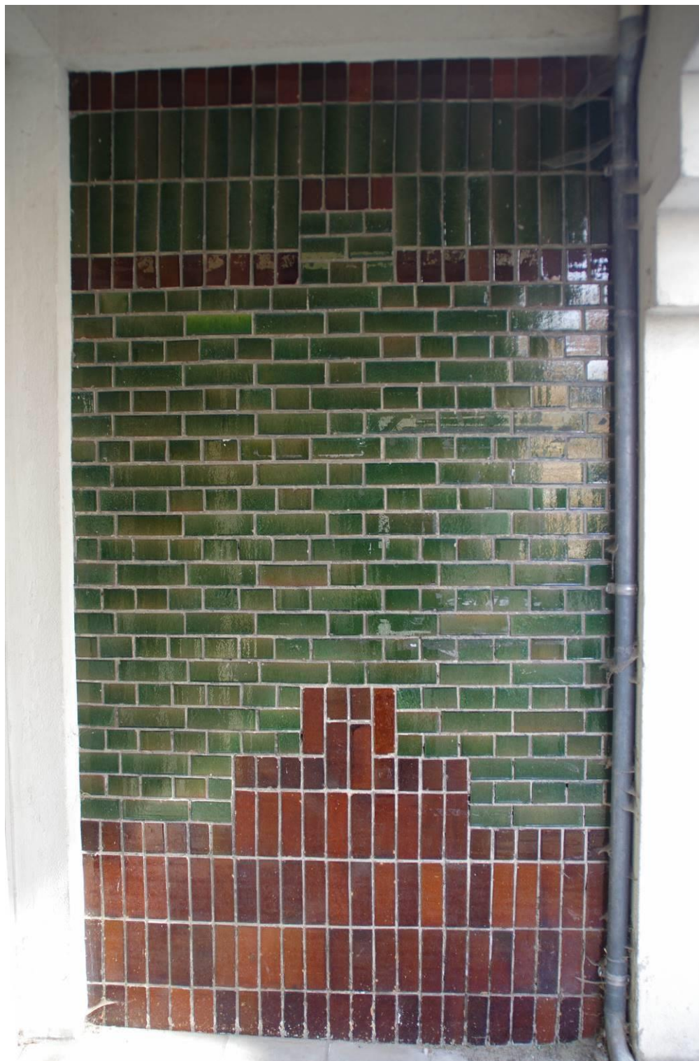
Figuur 82: detail van de geglazuurde bakstenen in de galerij
