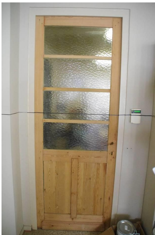
Figuur 122: voormalige buitendeur (deur stookplaats woning?) in 2002 herplaatst in de wand van de nieuw gemaakte berging (reconstructie oorspronkelijk magazijn)
