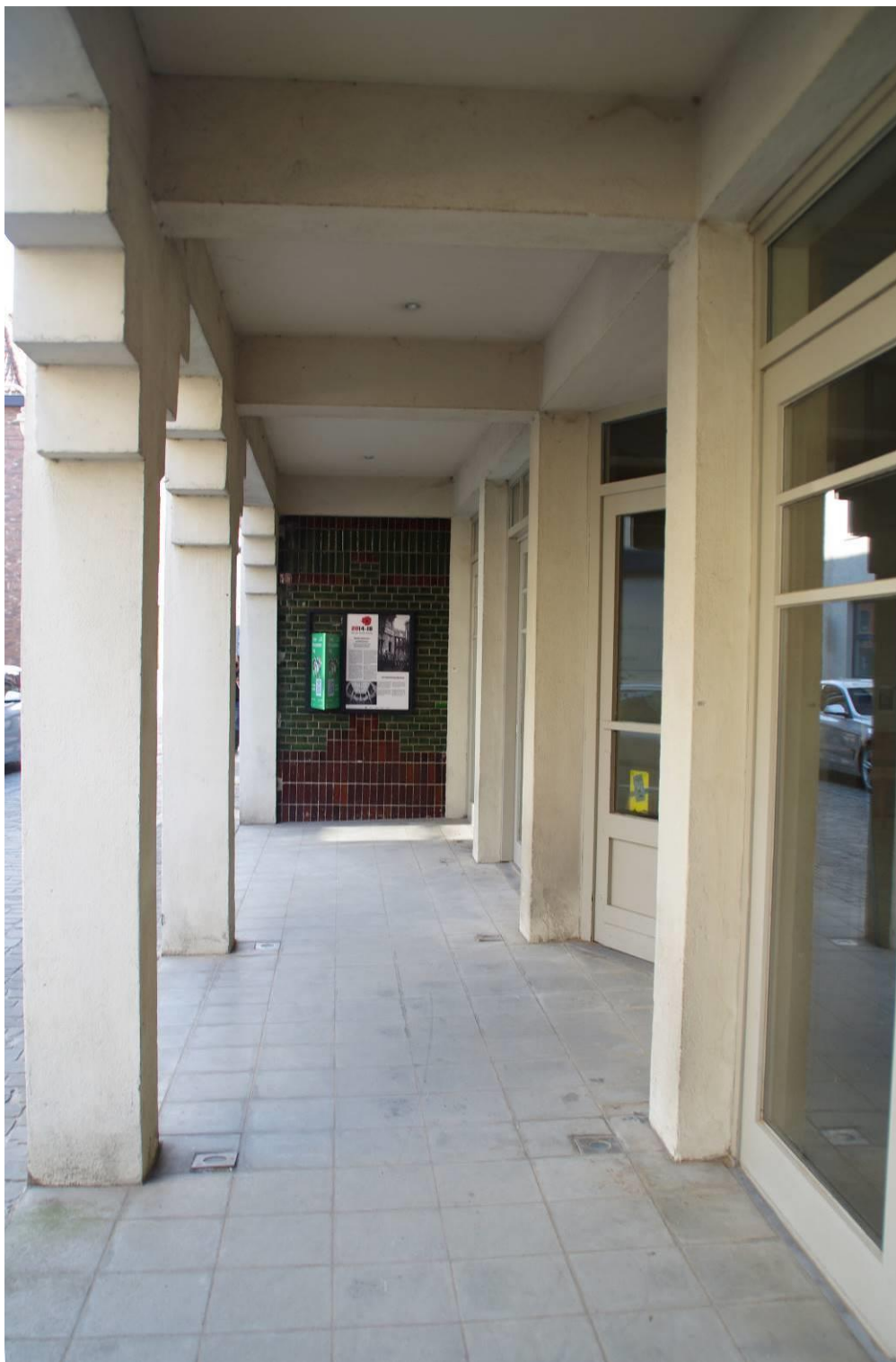
Figuur 81: zicht op de gelijkvloerse galerij aan de voorgevel
