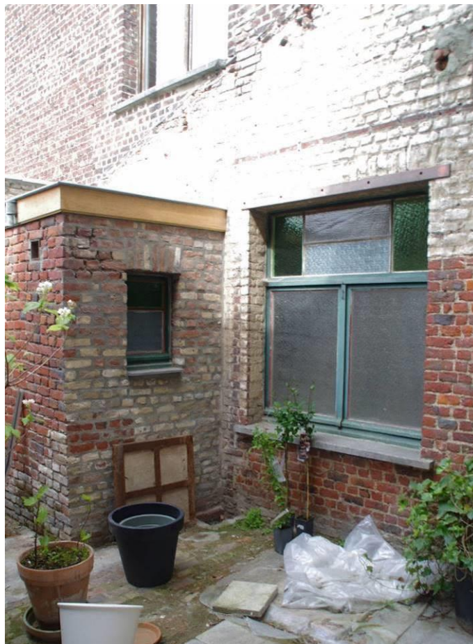
Figuur 101: zicht op zuidelijke zijgevel van de woning en het doorgangsvolume
