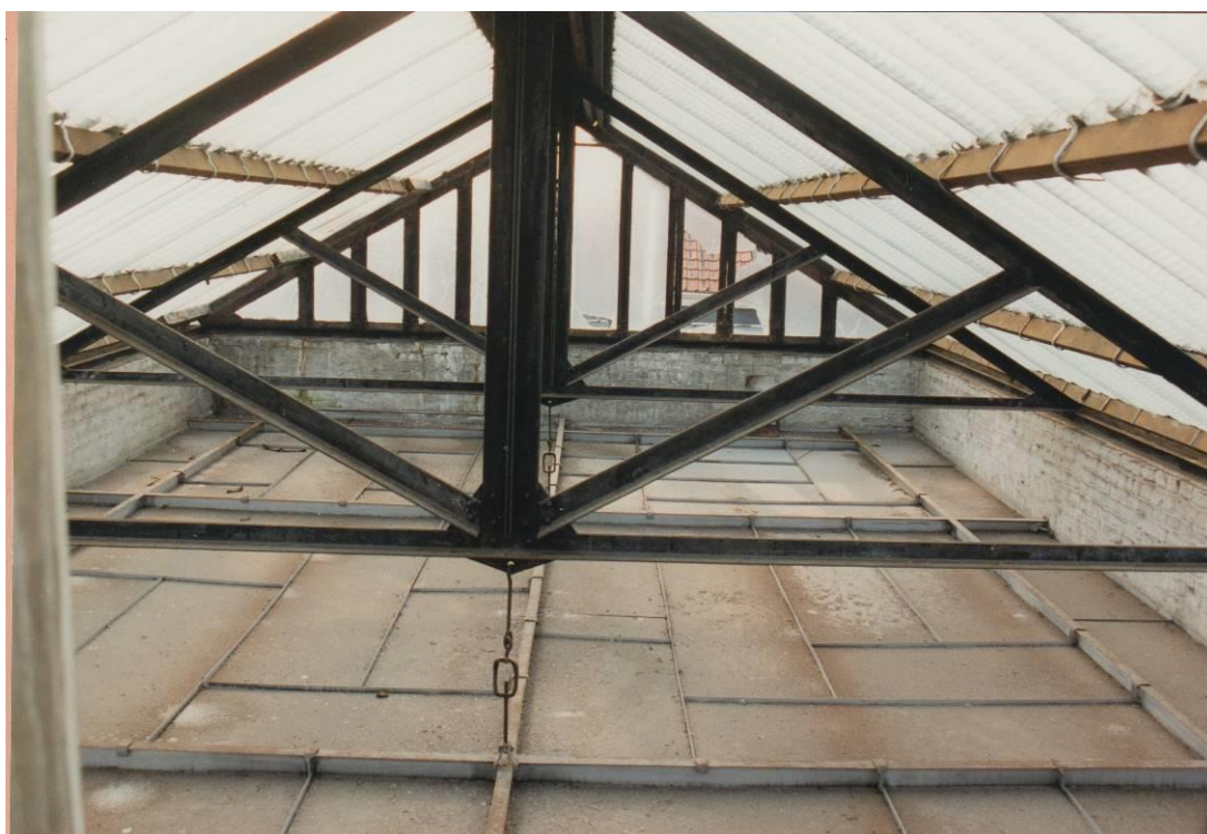
Figuur 111 : structuur van de daklichtkoepel in samengebouwte staalliggers, zoals zichtbaar in 2000 met de voormalige gegolfde glasplaten
