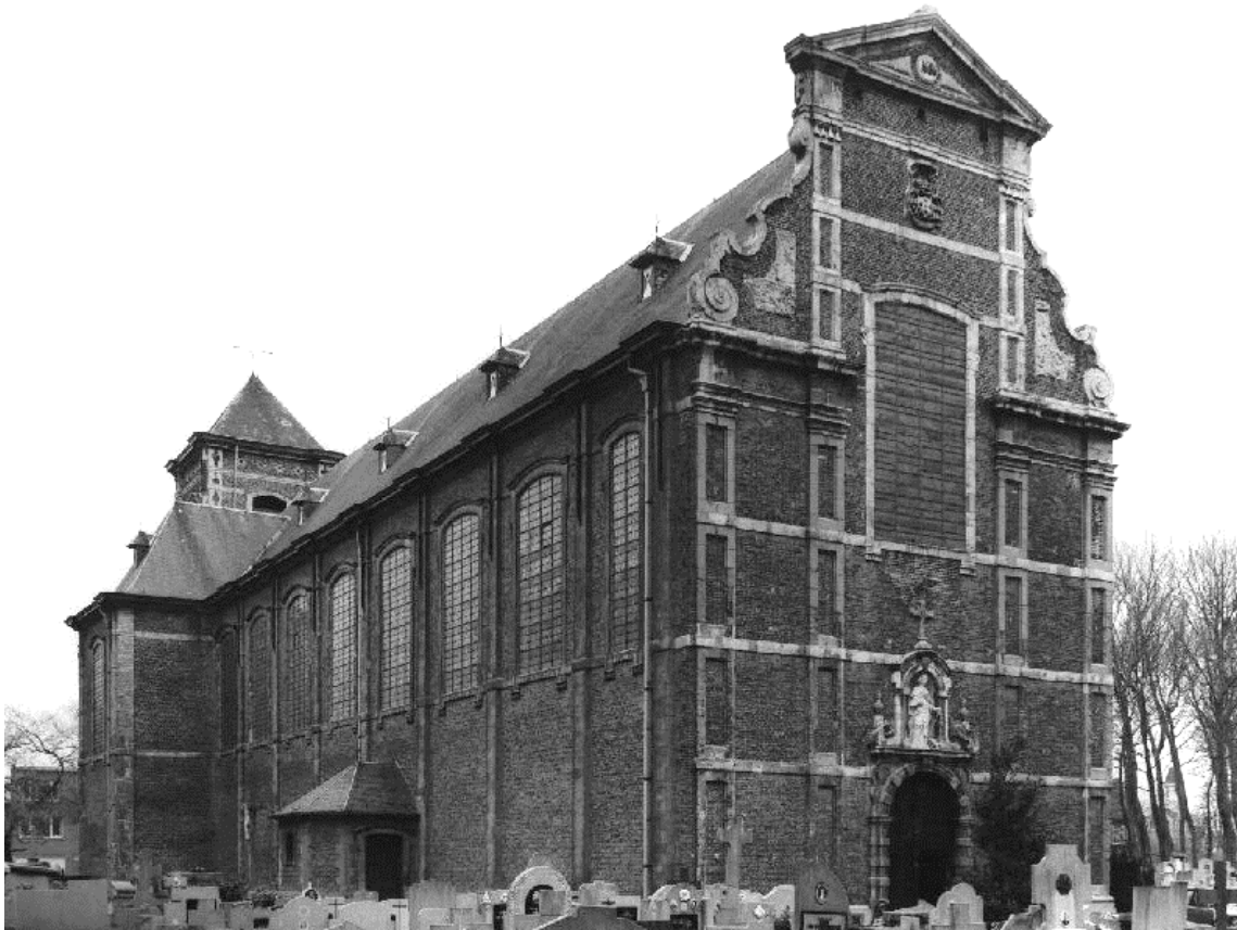
Figuur 59: Zicht op noordwestelijke gevel van de Sint-Catharinakerk (KIK M264676)
