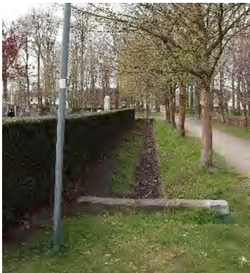
Locatie: zuid-, west-, noordelijke kerkhofrand Oorsprong: met zekerheid opklimmend tot 1778 (zichtbaar op de Ferrariskaart) Typologie: wadi (vroeger beperkte waterpartij met waterplanten begroeide vijver) Waterpermanentie: waterpartij staat permanent droog Diepte waterparij: ondiep Oeverversteving: talud is onderaan verstevigd met kasseien (+/- 30 cm hoog) watervervuiling: -
