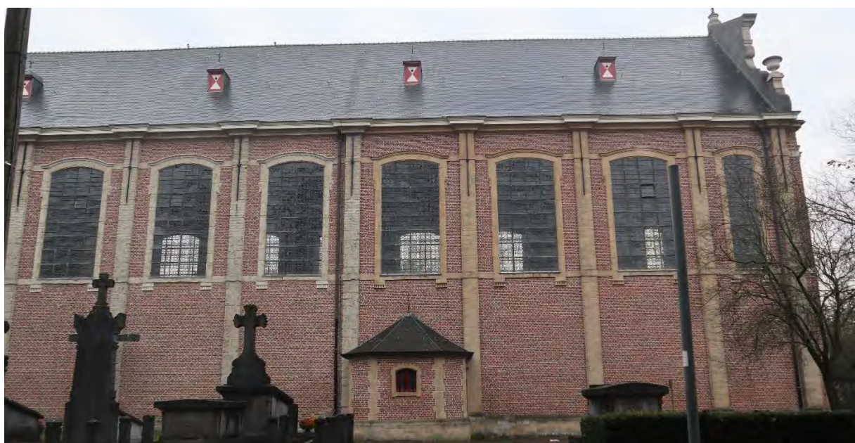
Figuur 95: Enkele foto's met zicht op de gevels van de Sint-Catharinakerk (Mar Jaen 2021)
