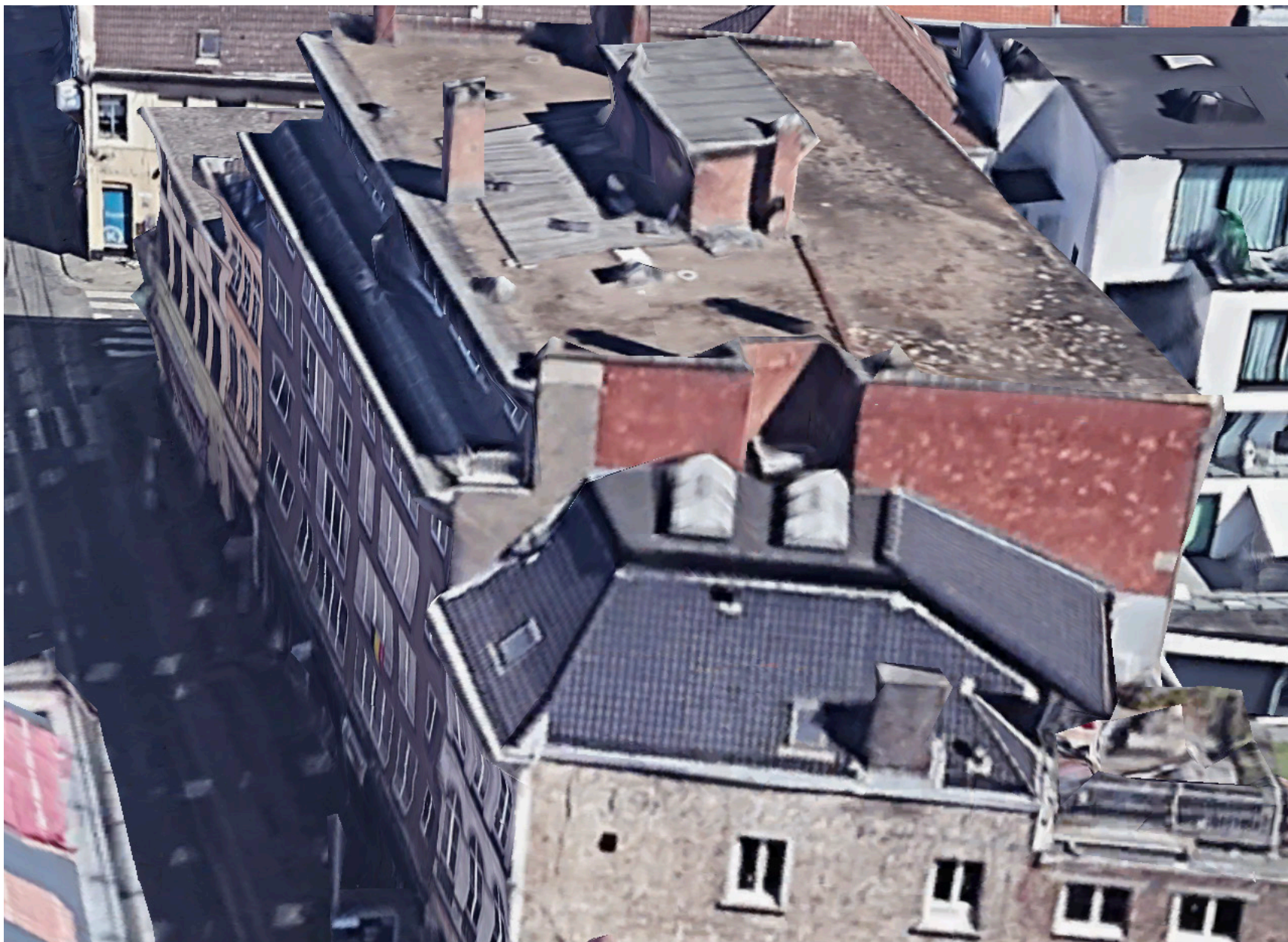
Afb. 23. 3D weergave van Nederkouter 13-35 met zicht op het plat dak. (Bron: Google Earth).
