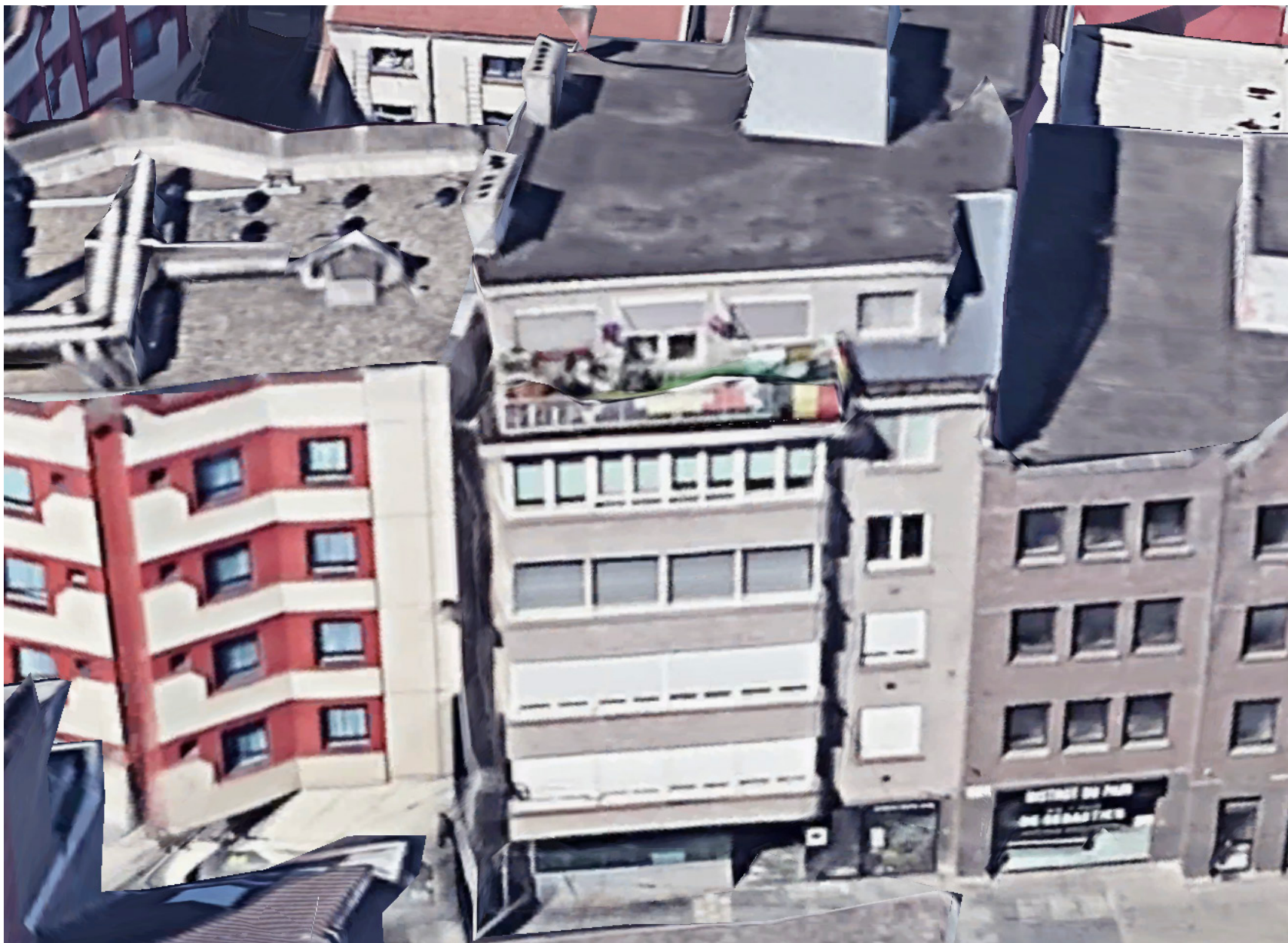
Afb. 24. 3D weergave van Nederkouter 8-22, met zicht op het dakterras en plat dak. (Bron: google earth)
