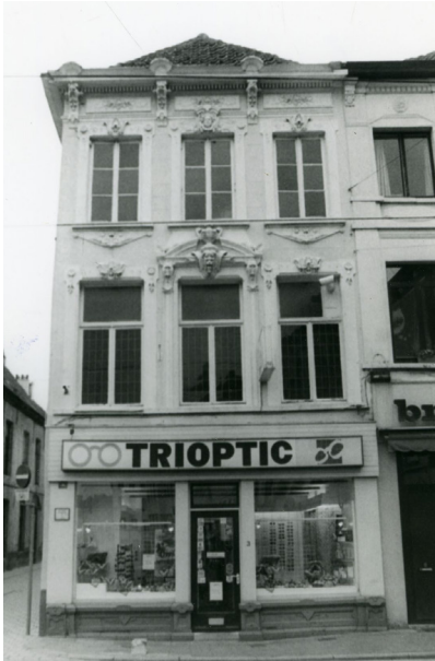
Afb. 12. Gebouw na verbouwing in 1995. (Bron: Archief Gent, MA, BA, 2007_00523)
