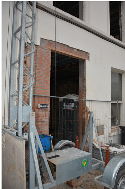
Afb. 25. Lichtarmatuur en installaties tegen de gevel.
