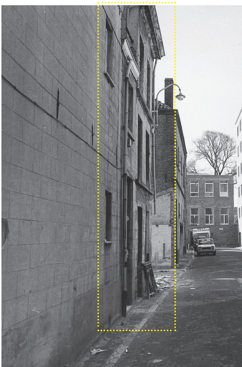
Afb. 8. Zicht op het voormalig gebouw, 1981. (Bron: Archief Gent, SCMS_ dd.1981)
