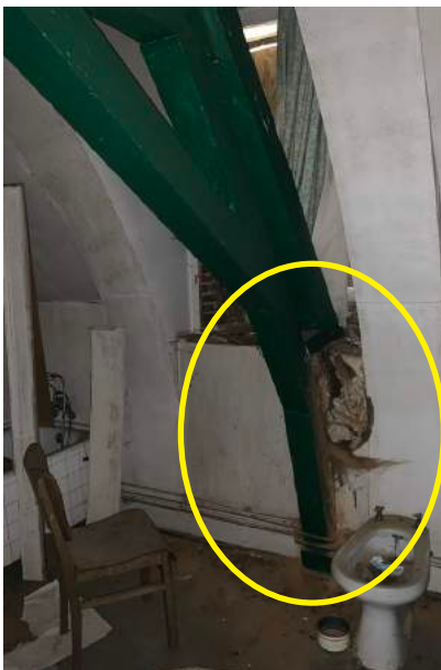
Afbeelding 280. Aangetaste spantvoet.
