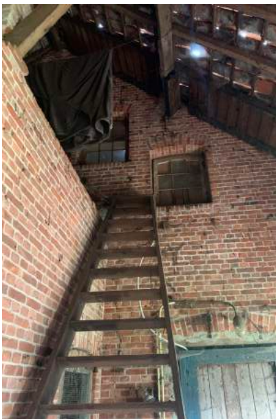
Afbeelding 418. Slijtage van de houten trappen.
