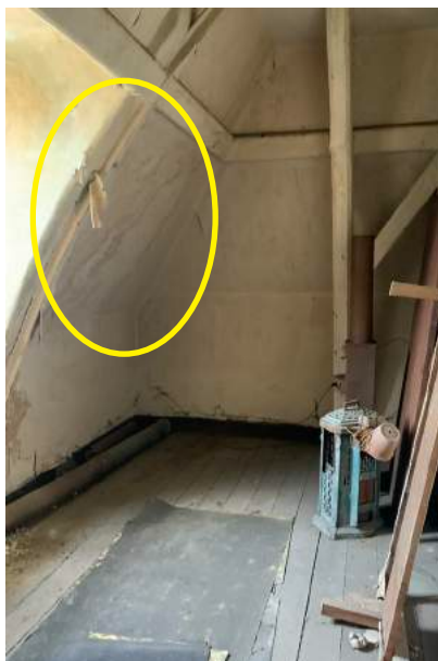
Afbeelding 303. Aangetaste bebording en kepers.
