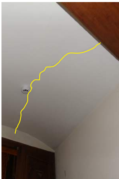
Afbeelding 162. Scheuren in de zuidvleugel.
