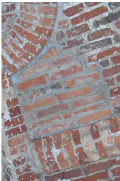
Afbeelding 341. Schade aan het baksteenmetselwerk (mechanisch).
