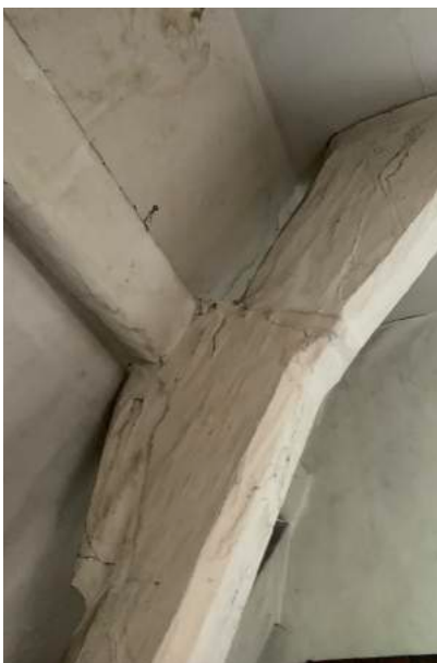
Afbeelding 284. De moerbalken in de koetshuizen zijn vermoedelijk aangetast.
