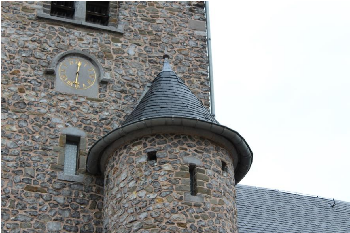
Fig. 41- Het dak van het zuidelijke traptorentje.
