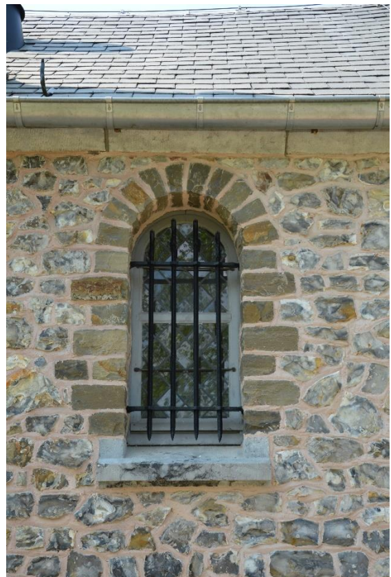
Fig. 29 – Een vensteropening van de sacristie, zuidzijde.
