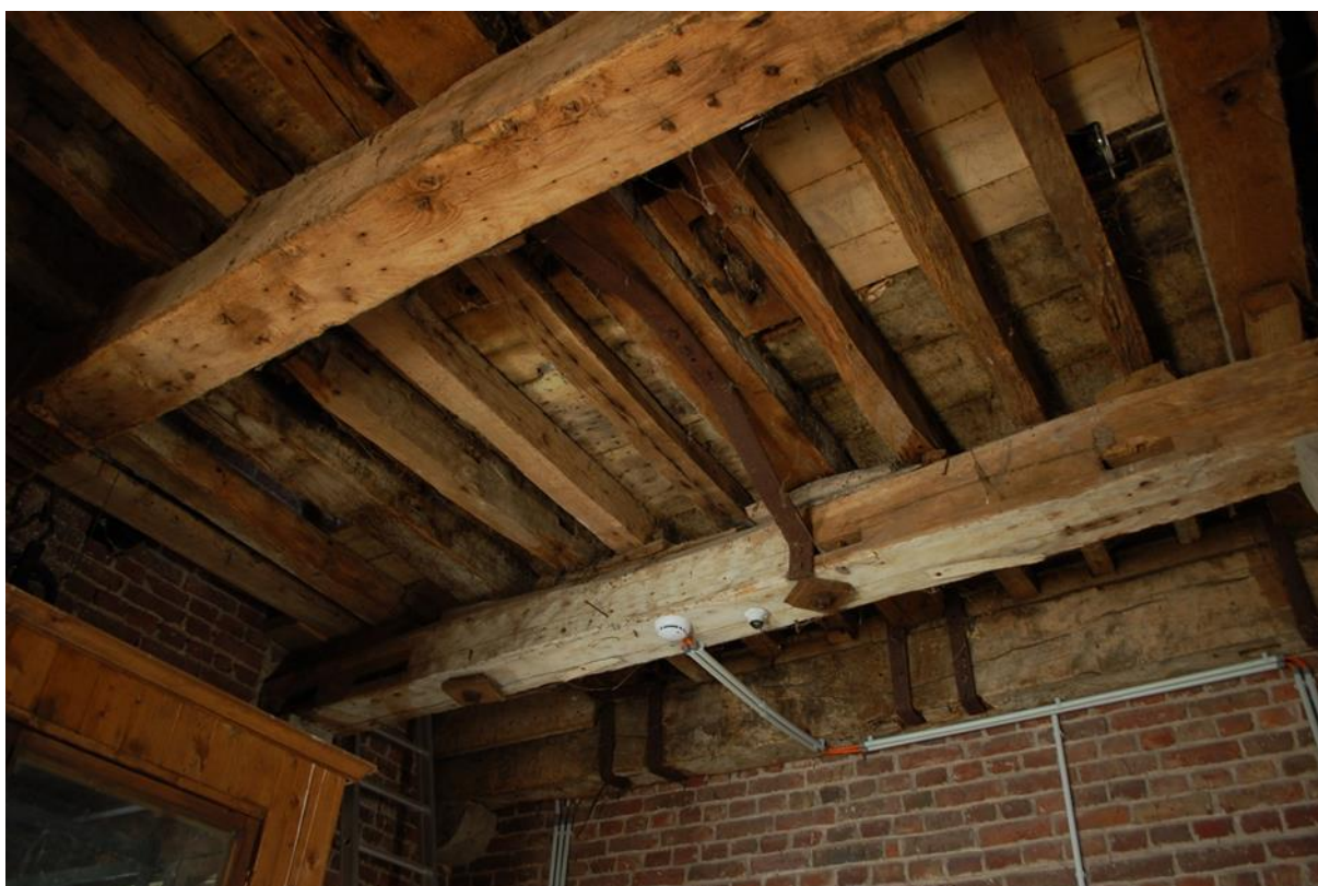
Fig. 118 – Toren. Verdieping +2. Houten plafond met metalen verstevigingen.
