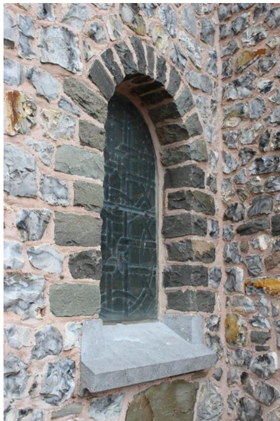
Fig. 32 - Rondboogvenster in de eerste geleding van de zuidgevel van de toren.
