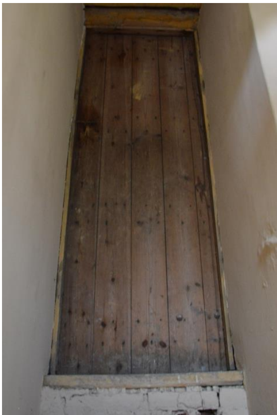
Fig. 116 - Toren. Toegang tot verdieping +2.
