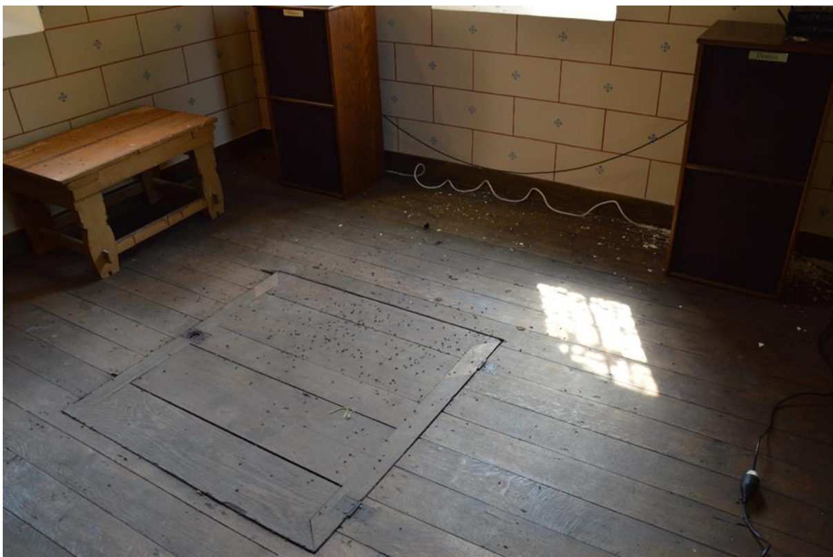
Fig. 112 – Toren. Verdieping +1, vloer.
