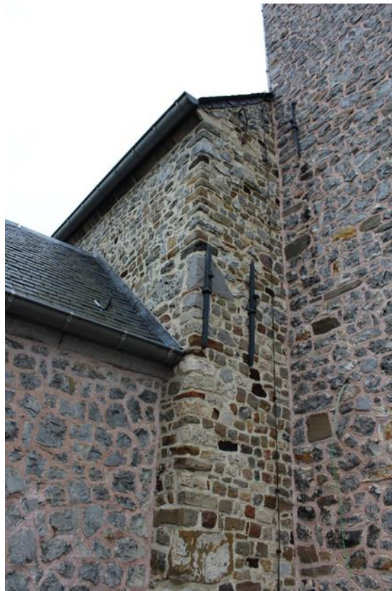
Fig. 19 - De muurankers van de beuk (noord) tussen toren en doopkapel.
