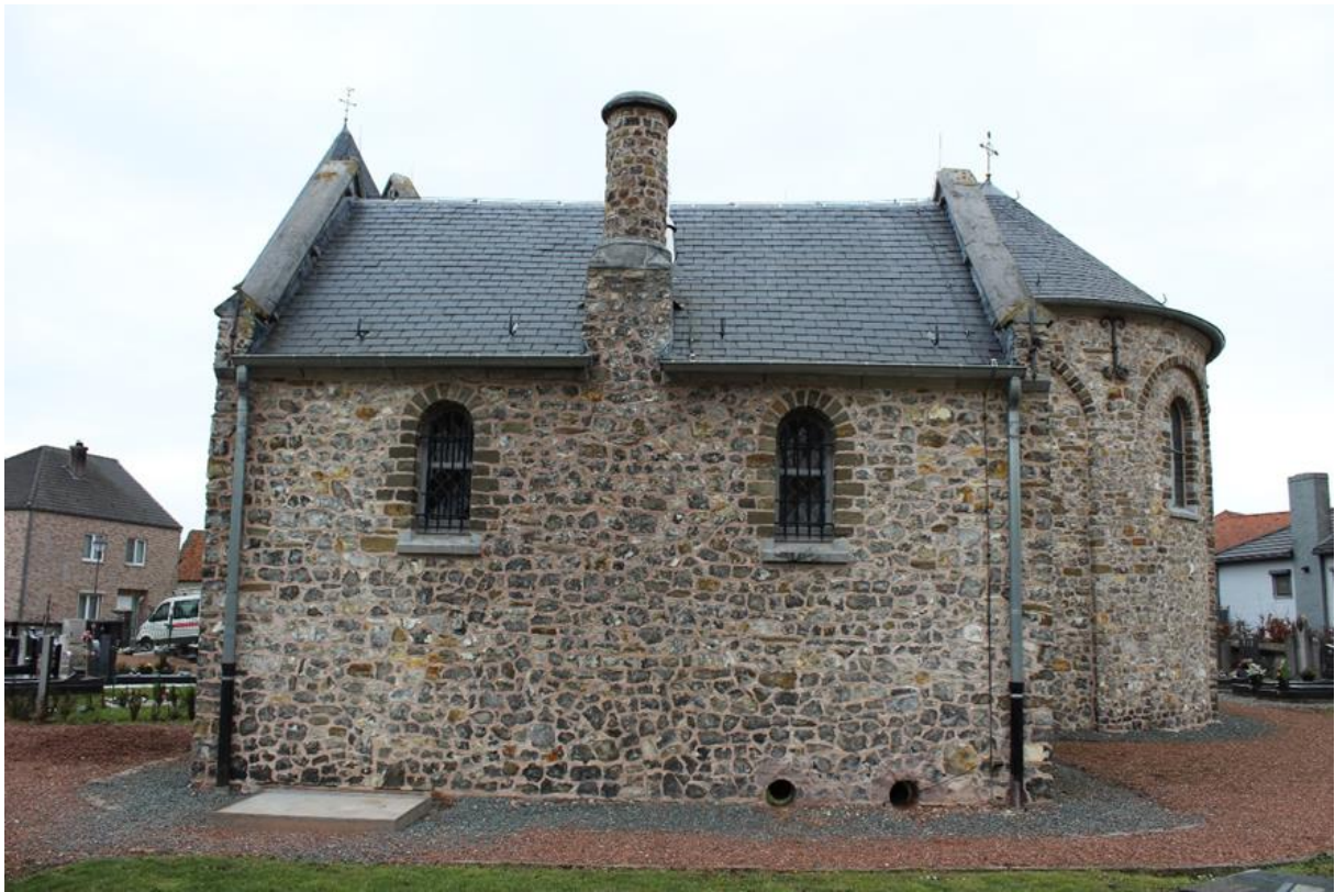
Fig. 38 - Het zadeldak van de sacristie.
