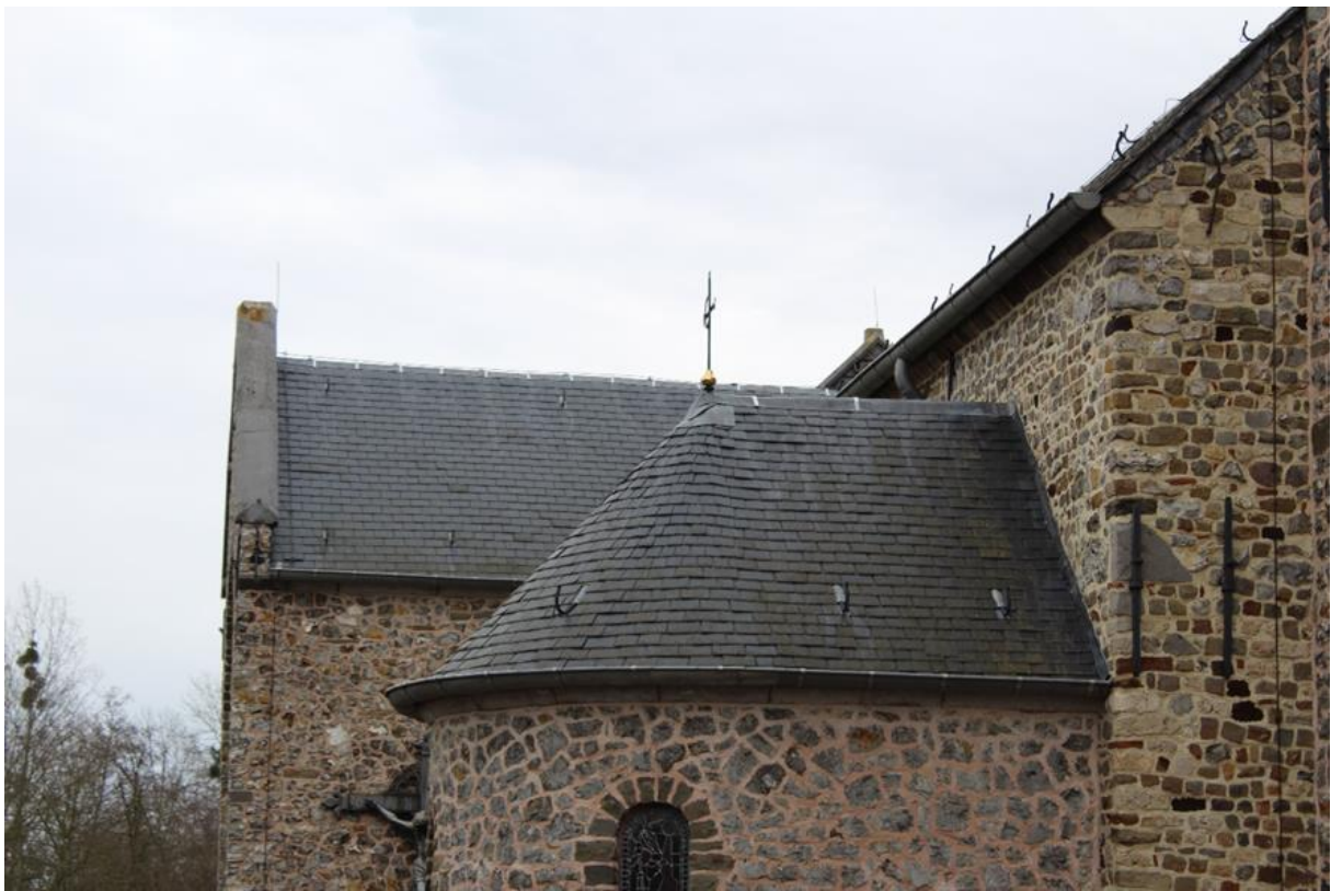
Fig. 36 - De daken van de doopkapel en transept noord.
