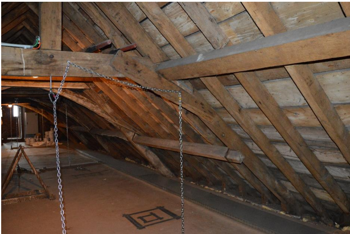
Fig. 127 – Zicht naar het westen op de constructie van het zadeldak boven het schip.
