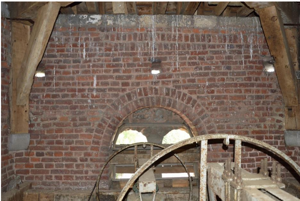
Fig. 119 – Toren. Verdieping + 3 met de klokkenstoel.
