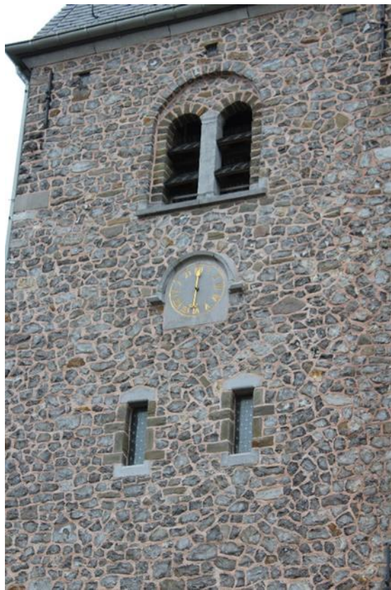
Fig. 17 - Derde en vierde geleding van de noordzijde van de toren.
