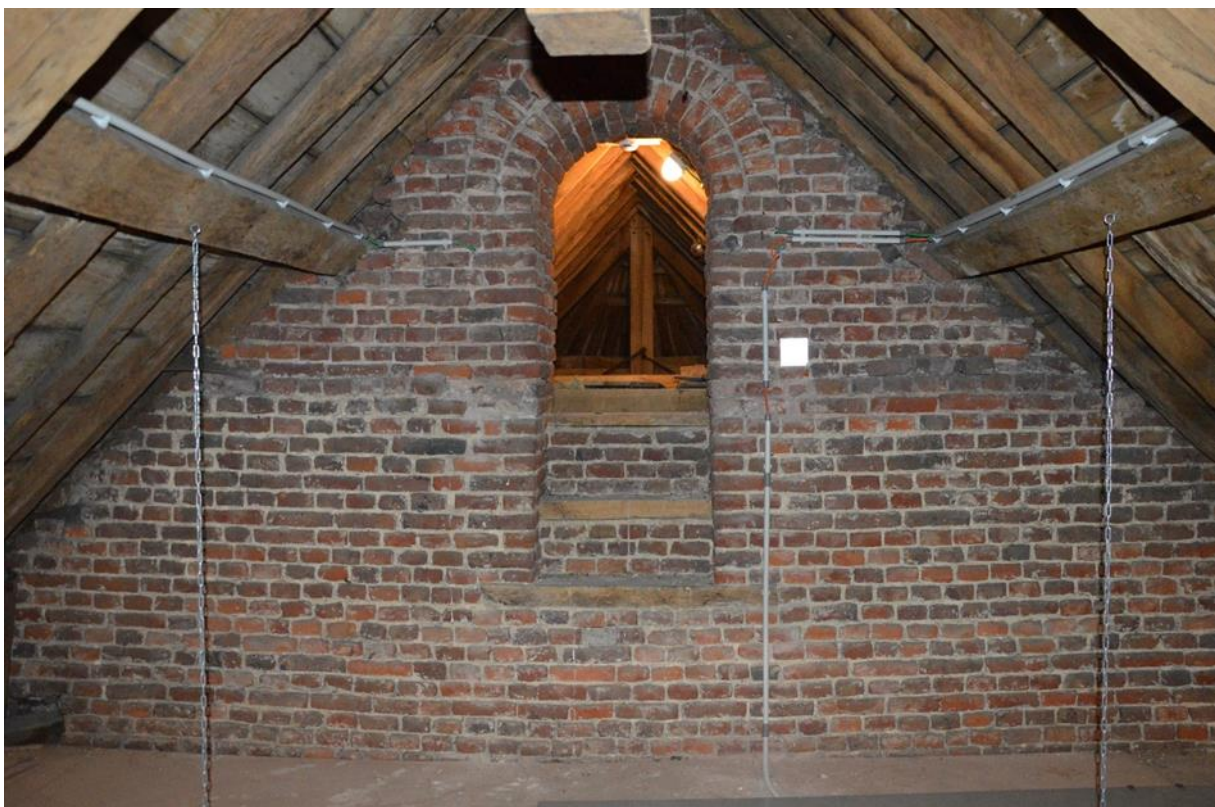
Fig. 126 – Toegang tot de zolder van het koor.
