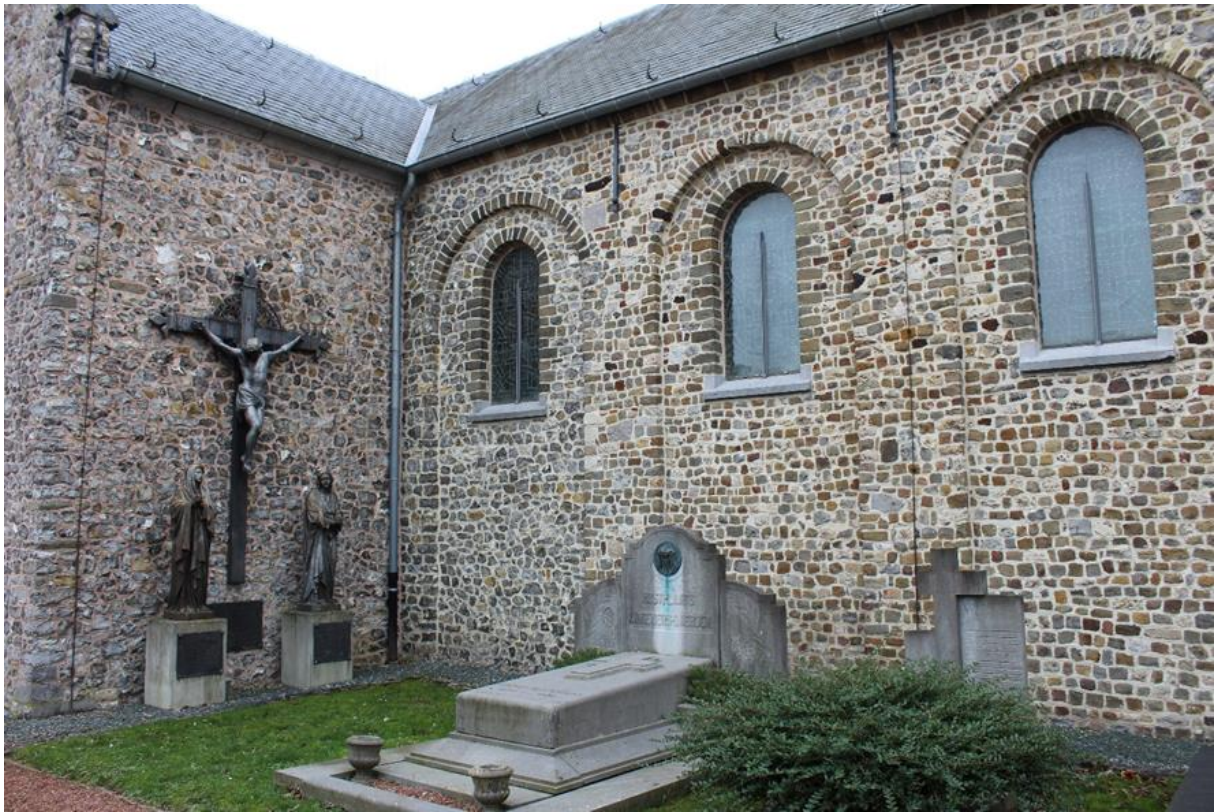
Fig. 15 - Tijdens de recente exterieurrestauratie zijn de verschillende bouwfasen leesbaar gemaakt door het aanbrengen van verschillende kleuren voegmortel.
