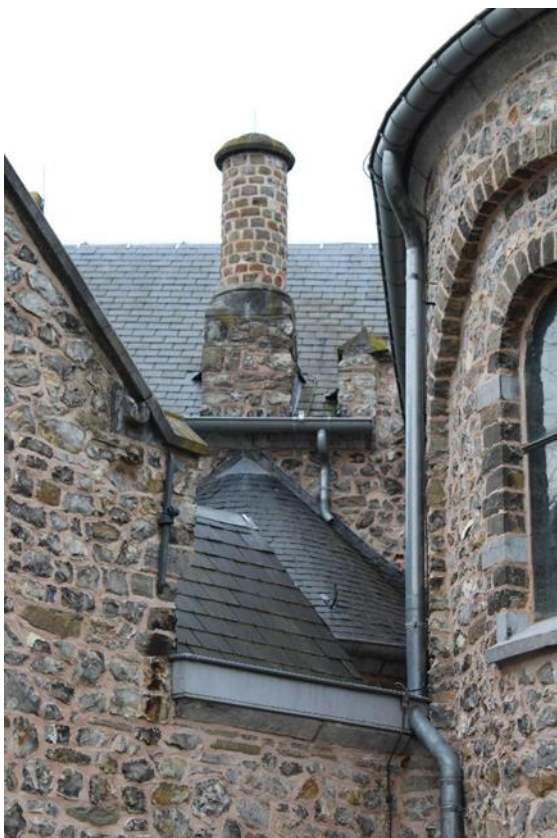
Fig. 33 - De schoorsteen in het zuidoak van de beuk.
