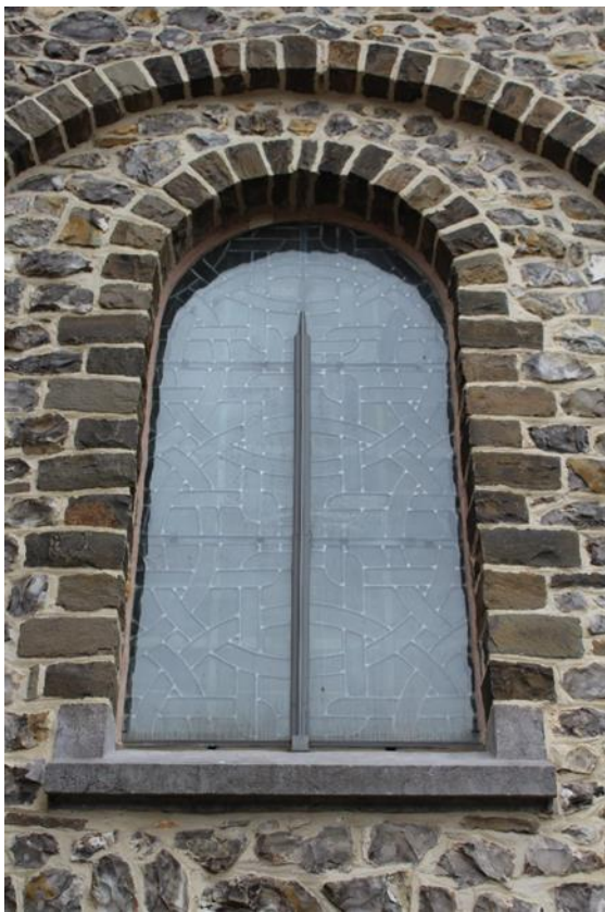
Fig. 20 - Rondboogvenster in de noordgevel van de beuk.
