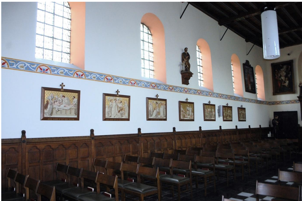
Fig. 65 - De zuidelijke muur van het schip.
