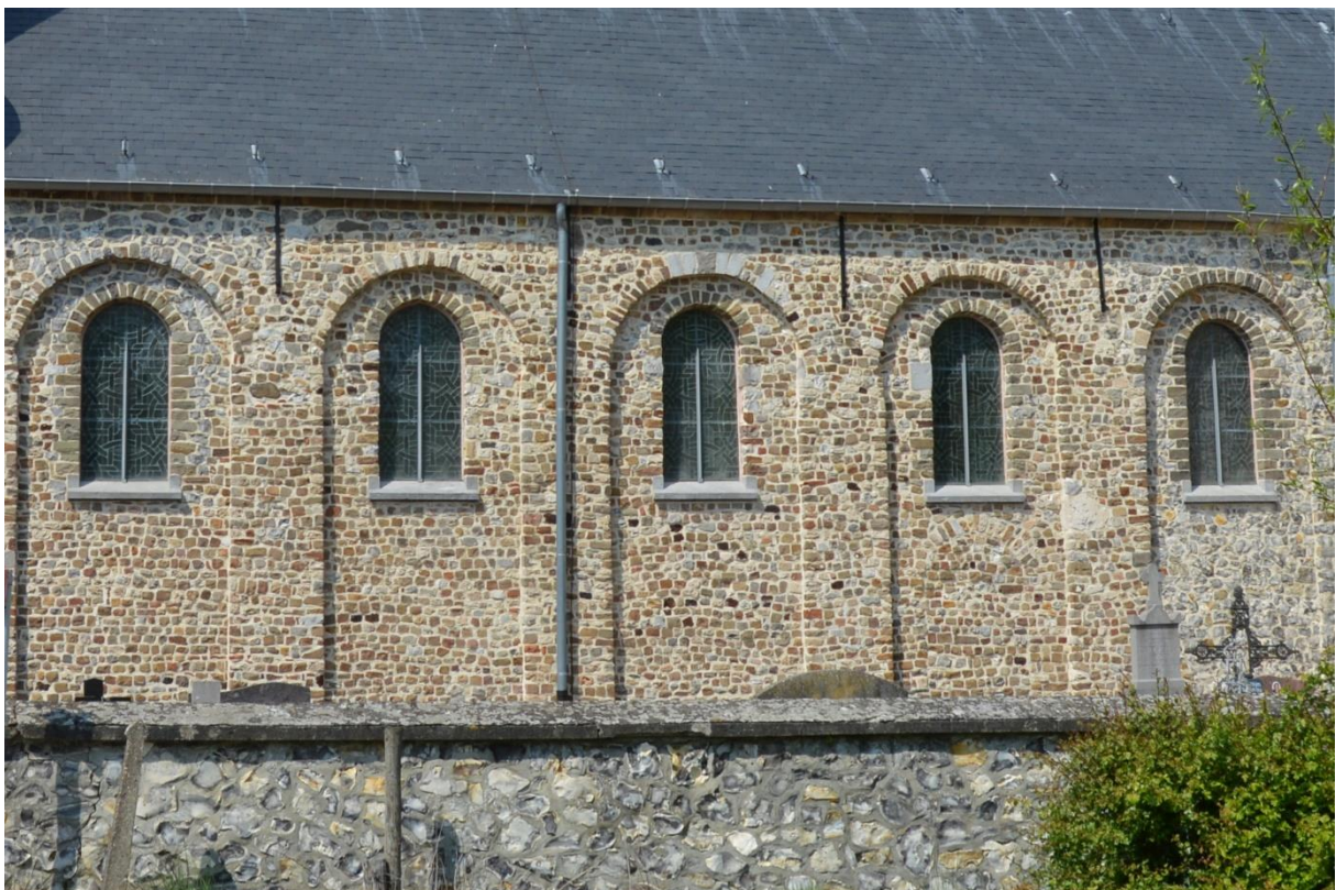
Fig. 30 - In de tweede t.e.m. vierde travee van de zuidgevel van de beuk zijn drie romaanse rondboogvensters grotendeels bewaard gebleven.
