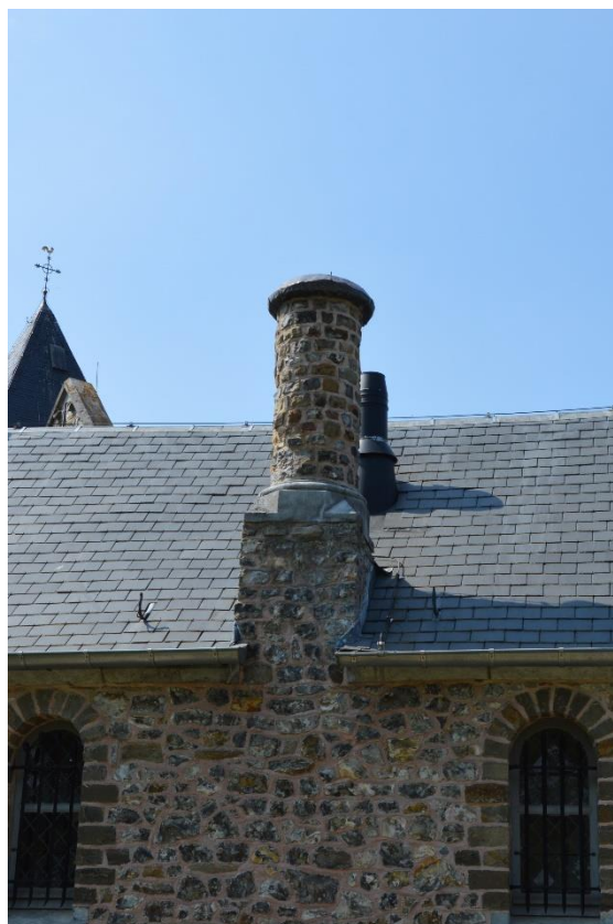
Fig. 34 - De schoorsteen in het dak van de sacristie.
