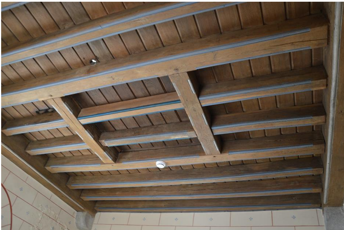
Fig. 111 – Toren. Verdieping +1, plafond.
