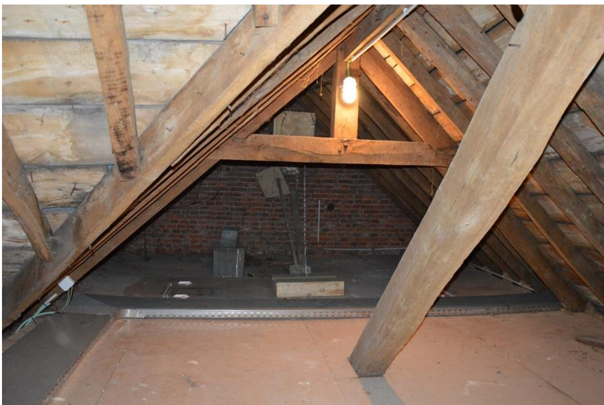
Fig. 128 – Zicht op de zolder met de dakstructuur van de noordelijke kruisbeuk.
