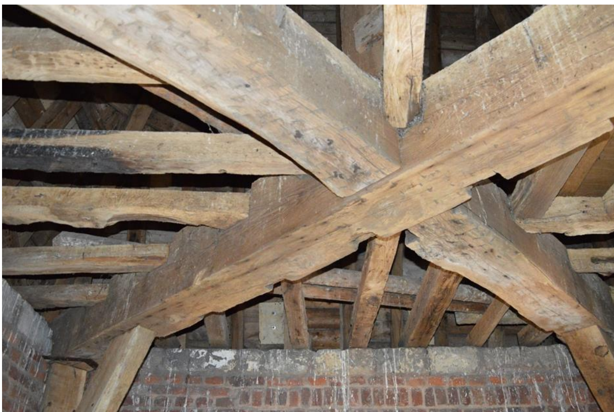
Fig. 120 – Toren. Verdieping +3, zicht op de gekruiste balken van de zolder (+4).
