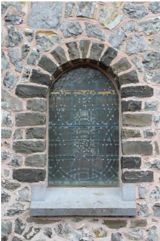
Fig. 18 - Een rondboogvenster van de toren.
