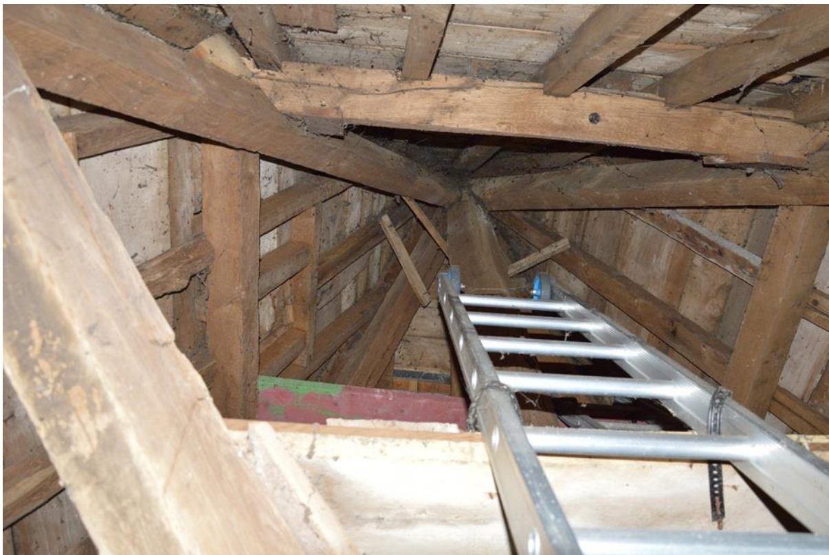
Fig. 123 – Toren. Verdieping +4, zicht op de constructie van het puntdak.
