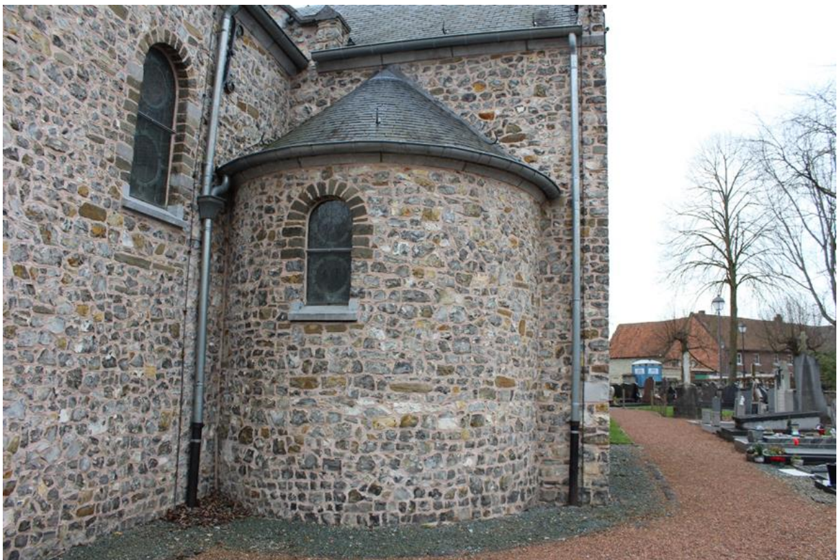
Fig. 37 - Het apsidiool tegen transept noord.
