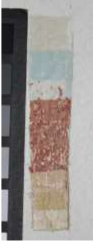
51 Stratigrafisch onderzoek in de dagkanten van het glasraam in de inkomhal.
