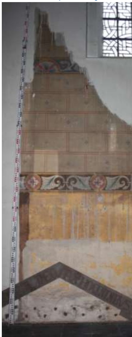
42 Overzicht van de muurschildering in het zuidelijk transept na het verwijderen van het orgel.
