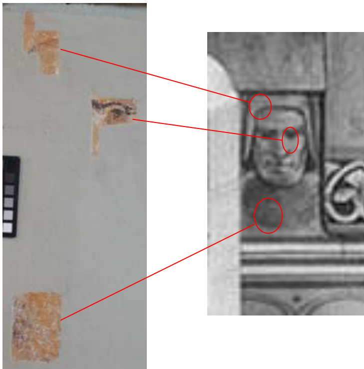
37 Vrijleggen van het mannenhoofd onder het kapiteel ( zuidelijk absidiool).
