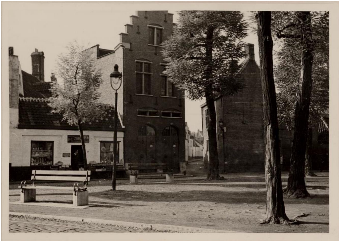
Figuur 27 - Foto van het overharde Sint-Elisabethplein, na 1938 (datum bouw elektriciteitscabine) (Bron: Archief Gent, Beeldbank, preview_SCMS_FO_0303).
