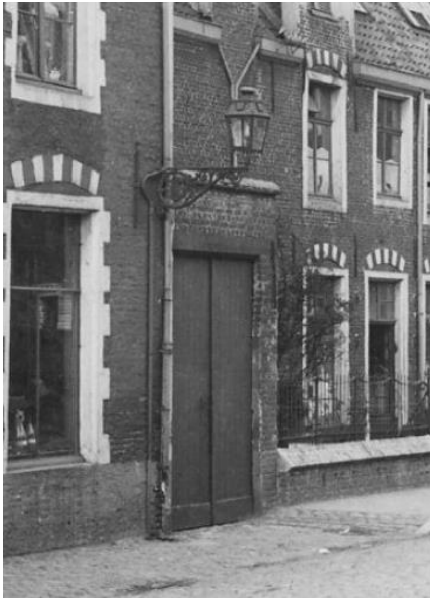
Afb. 3 - Typische wandlantaarn voor gasverlichting, zoals deze voorkwam in het begijnhof vanaf het laatste kwart van de 19de eeuw.
