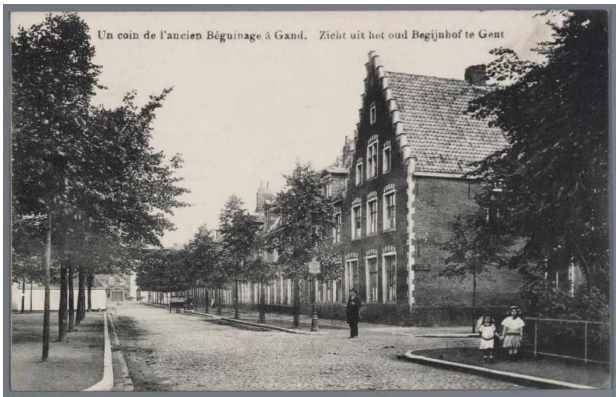
Afb. 13. In de vroege 20ste eeuw wordt de bestrating steeds verder afgewerkt, o.m. door de aanleg van borduren en voetpaden waar deze nog ontbraken (Bron: Archief Gent, Beeldbank, SCMS_PBK_0111).
