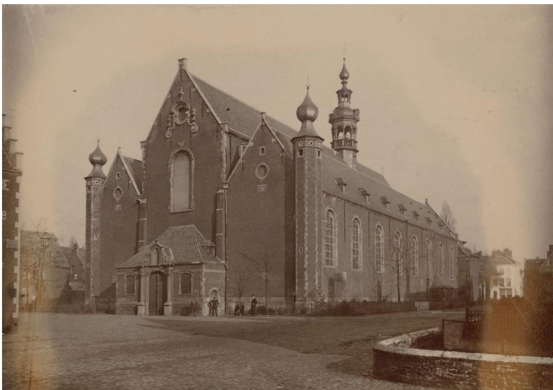
Afb. 15. De bestrating aan de zuidzijde van de kerk, na de heraanleg van 1880 en voor de vernieuwing van de lage omheiningsmuurtjes circa 1901 (Bron: Archief Gent, Beeldbank, SCMS_FO_0273). 37
