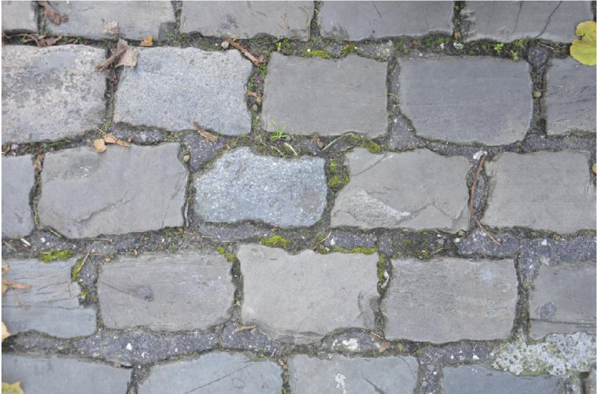
Afb. 36. - Plein voor de kerk (Sophie Van Akenstraat), met de hand gekapte recuperatiestenen (granodioriet). Kinderkopjes. Een groot deel zijn foutief plaatst op hun kant, waardoor ze breken volgens hun natuurlijke gelaagdheid.
