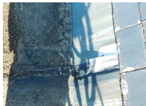
Beschadigde uitzetband schip.
