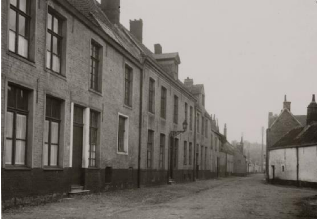
Afb. 23. Bestrating in de Provenierstersstraat. De in 1888 gesloopte tuinmuur voor de huizen in de Provenierstersstraat (huidige nrs. 9-25) tekent zich nog af in de kasseiverharding. Het wegdek waterde hier dus ook af tot tegen de tuilmuren/gevels, en niet naar het midden van de straat, zoals vandaag het geval is (Bron: Archief Gent, Beeldbank, SCMS_FO_0289).
