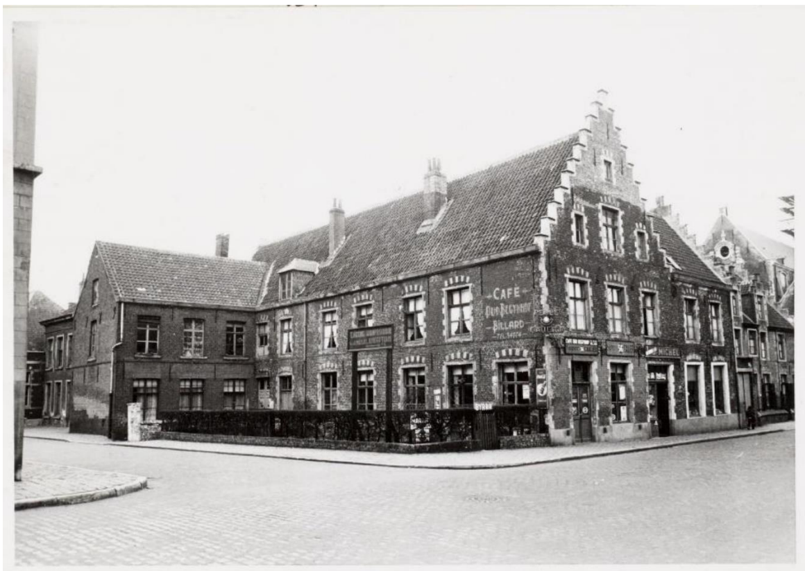
Afb. 28. - Foto van de H. Lammensstraat en de E. Boonenstraat in 1958, de kasseien zijn overgoten met asfalt (Bron: Archief Gent, Beeldbank, preview_SCMS_FO_4929).
