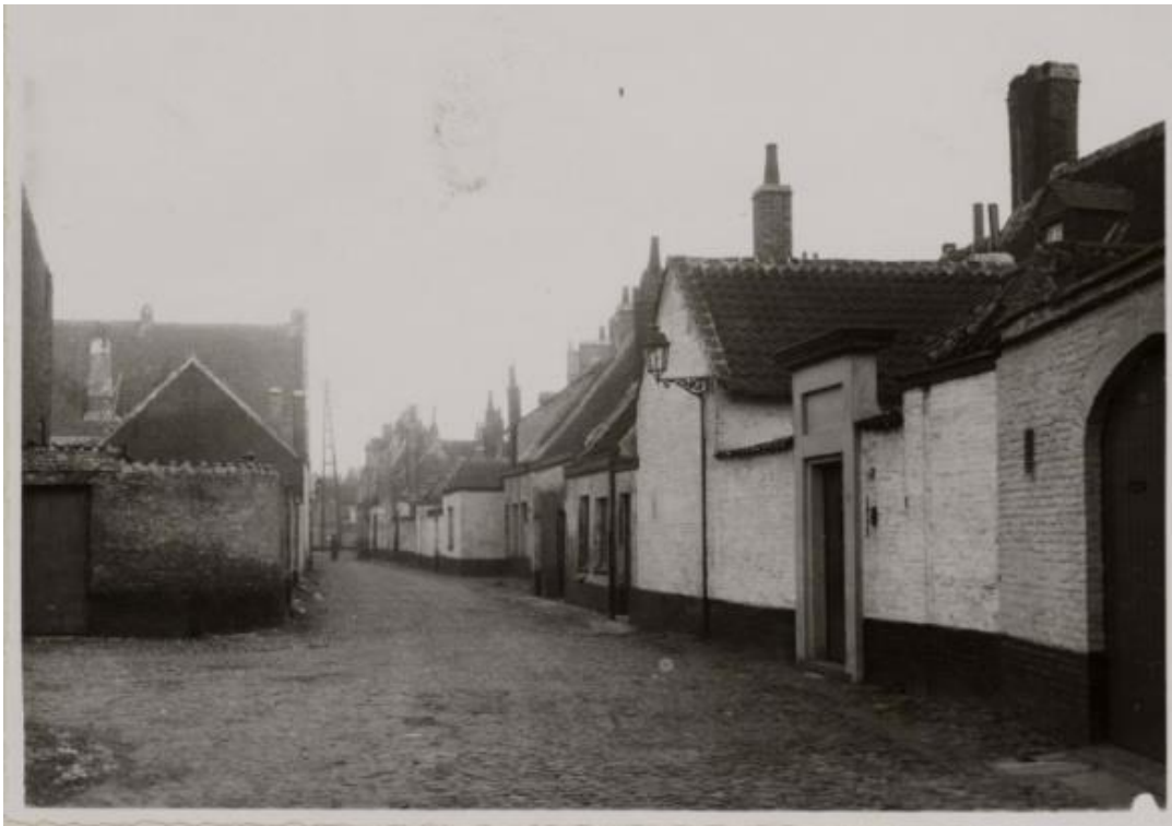
Figuur 24. Foto van de Provenierstersstraat op het kruispunt met de Zwartekatstraat, zeker te dateren na 1903 (en mogelijk na 1936) (Bron: Archief Gent, Beeldbank, SCMS_FO_0294). 43
