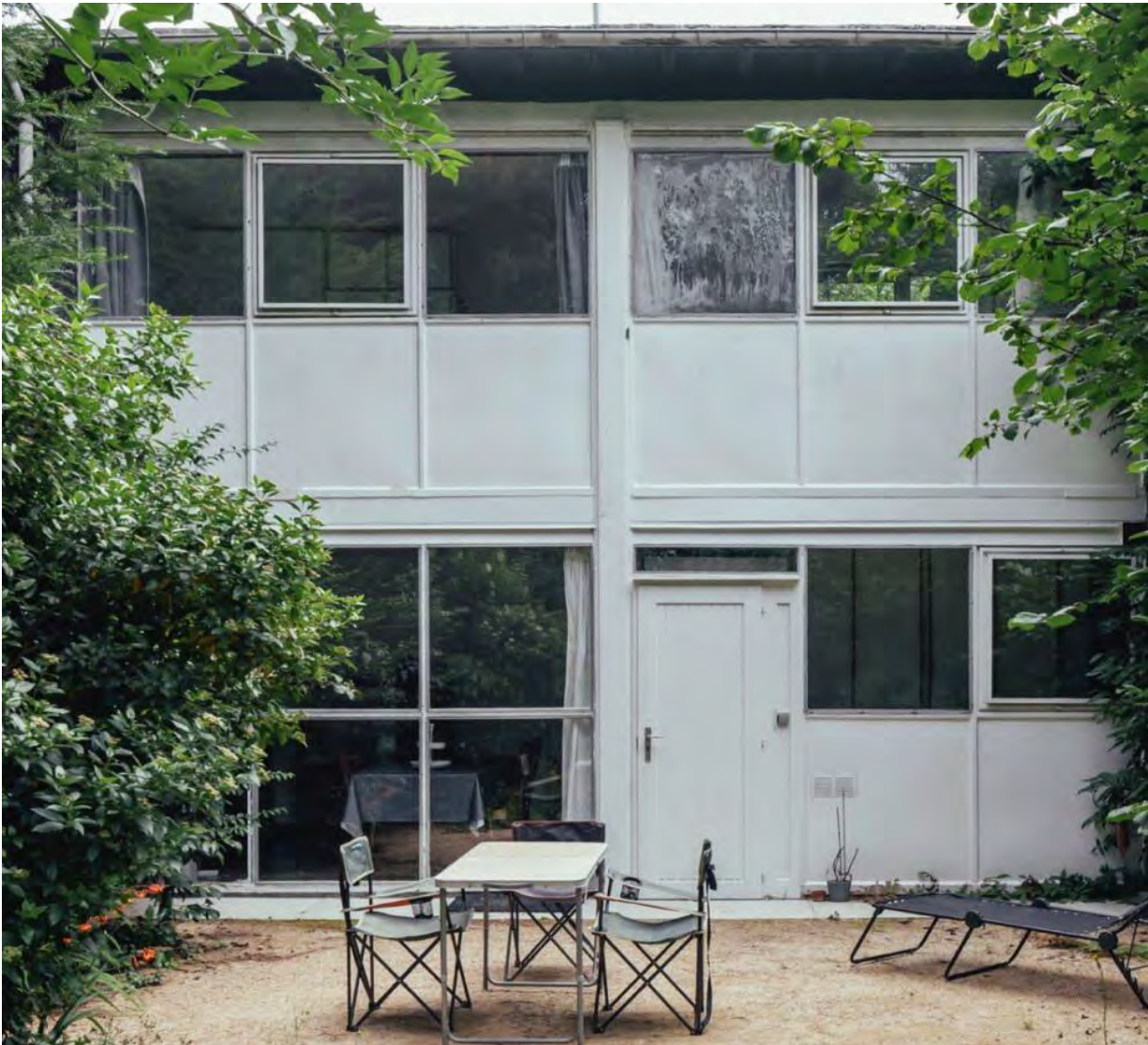
Achtergevel met houten, smallere achterdeur en verplaatst draairaam (foto architectenwoning 2016)
