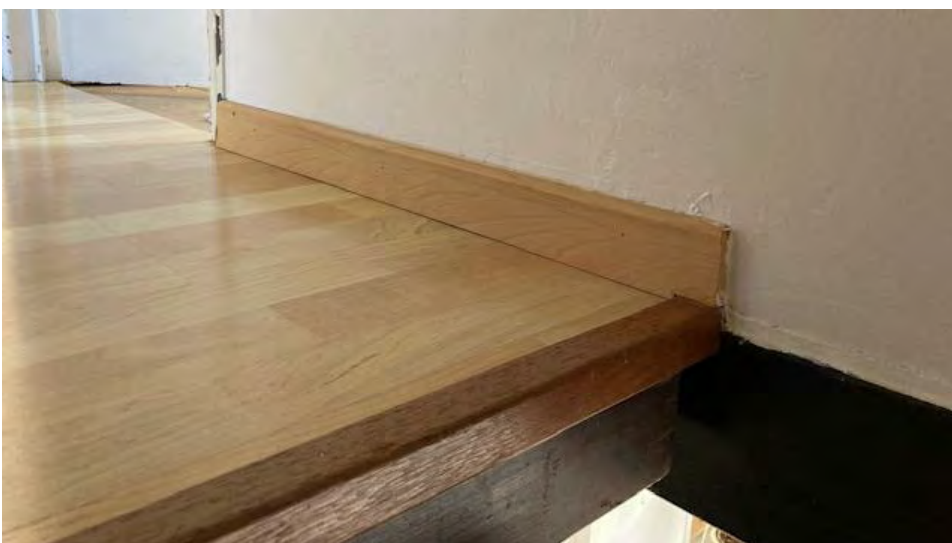
Laminaat op trapplatform boven
