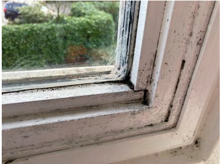
Metalen panelen aan ramen: schimmelvlekken op het metaal (middelgrote slaapkamer)
