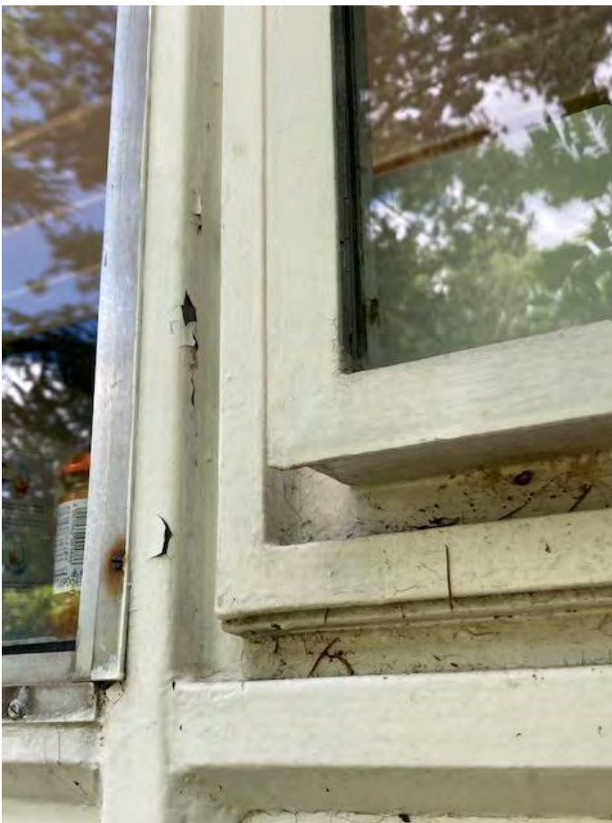
Breder, dubbel gelaagd kader voor draairamen
