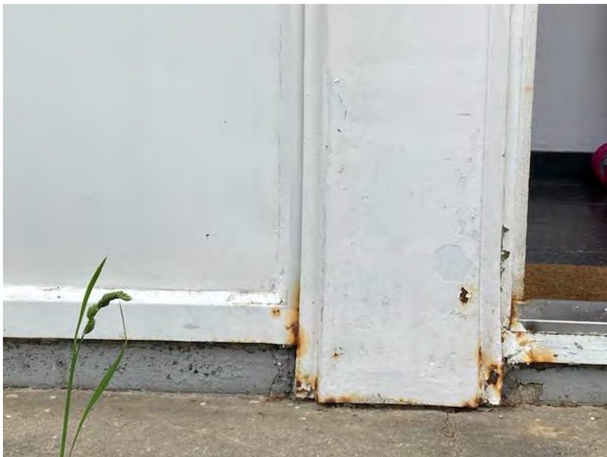
Voorgevel, stalen portiek centraal
