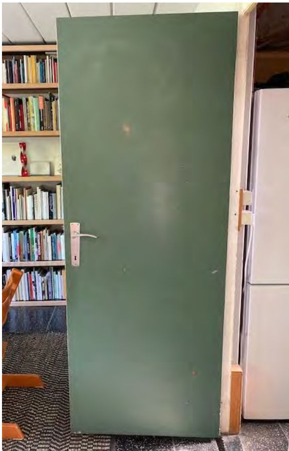
Deur remise binnenkant
