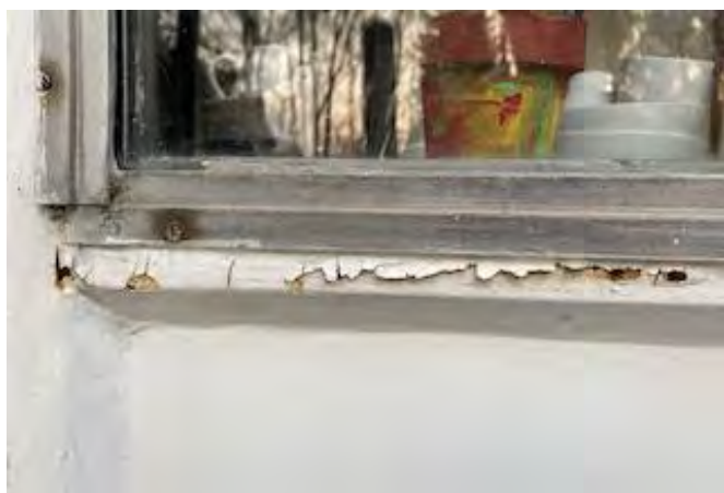
Metalen latten voor aanbrengen extra glas, vastgeschroefd op de metalen structuur, verroest
