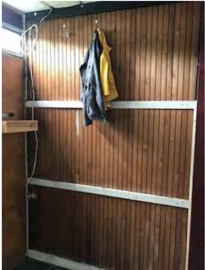
Houten wand tussen remise en inkomhal, mogelijks origineel
