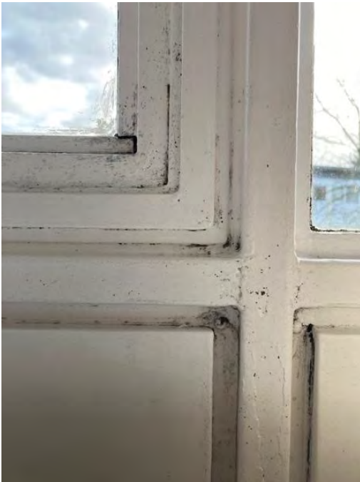
Metalen panelen aan ramen: schimmelvlekken op het metaal (middelgrote slaapkamer)
