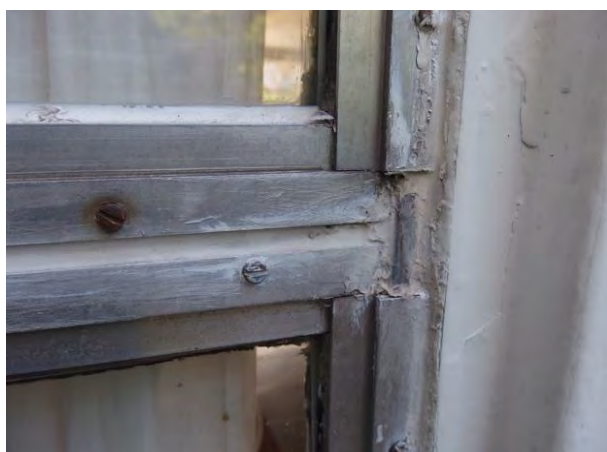
Metalen latten voor aanbrengen extra glas, vastgeschroefd op de metalen structuur, verroest
