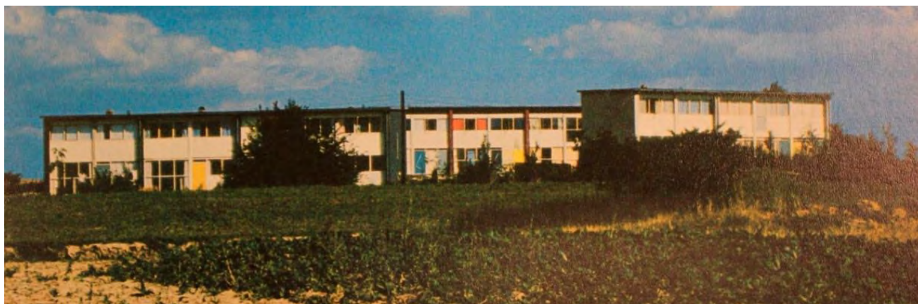
Achtergevel woning 7, tweede huis van links (archiefbeeld online)
