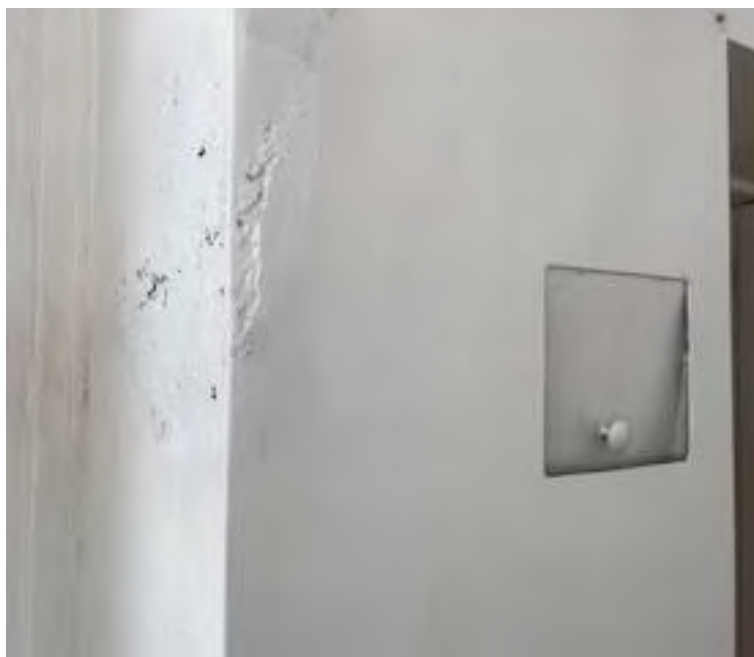
Schade aan originele metalen koker
