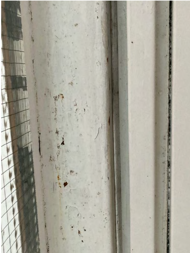
Afschilfering verf metalen structuur en portiek
