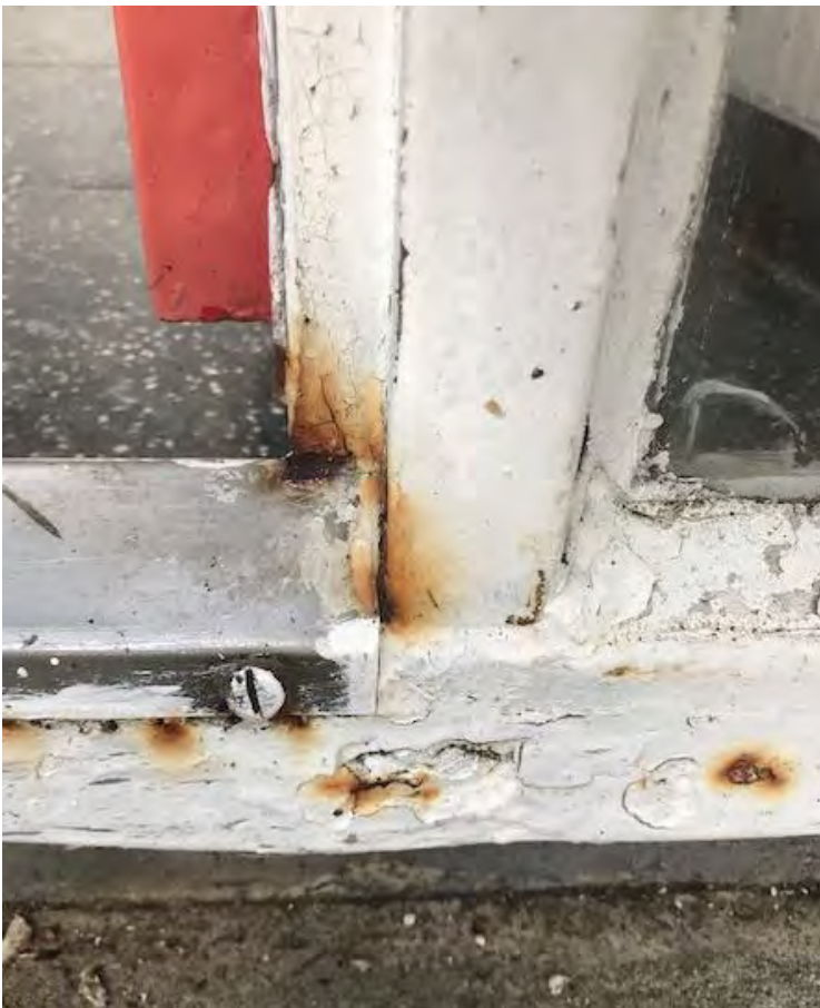
Voorgevel: Roestsporen en gaten metalen structuur Metalen latten op boord voordeur
