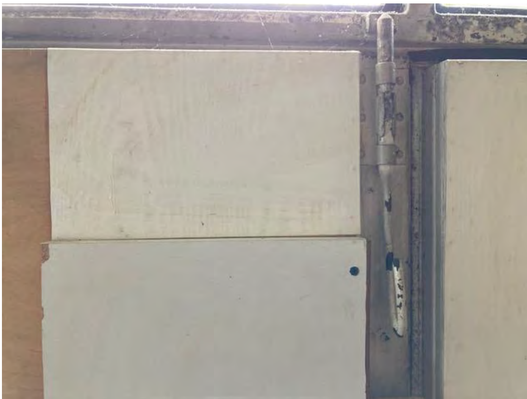
Deur remise met verschillende houten panelen bekleed
