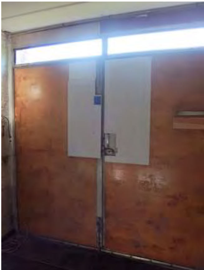
Met hout beklede metalen dubbele deur naar buiten
