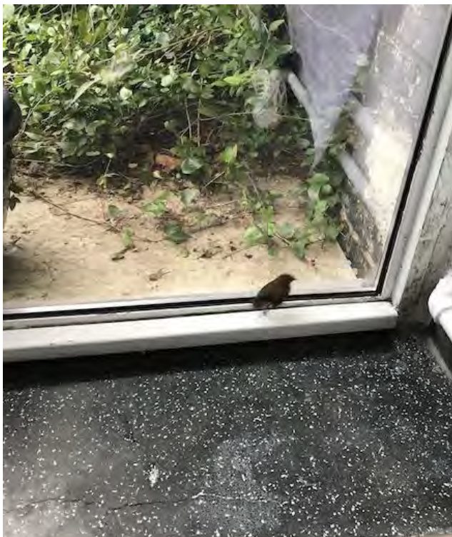
Houten lat op metalen frame onderaan
