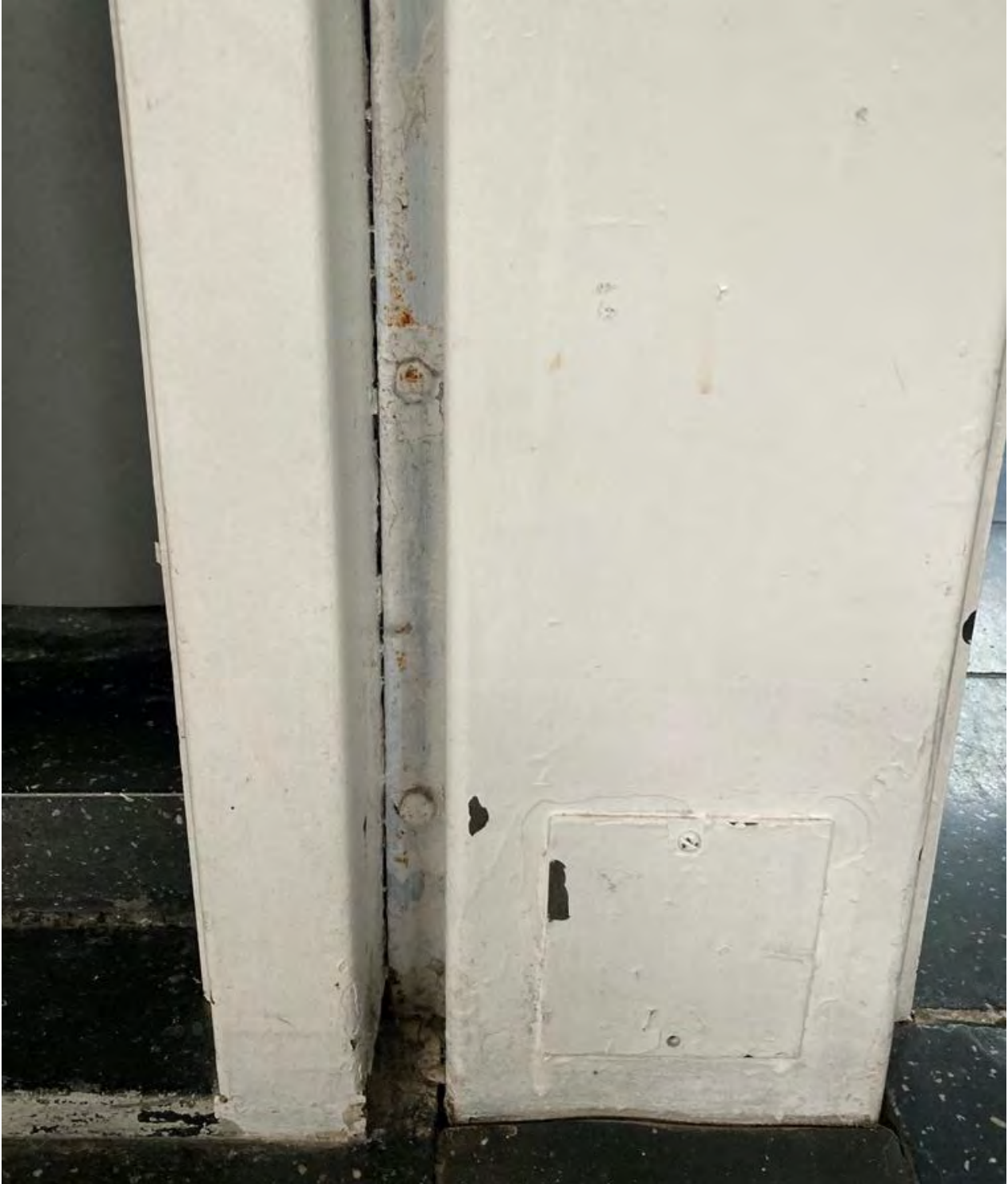
Stalen portiek centraal in de woning
