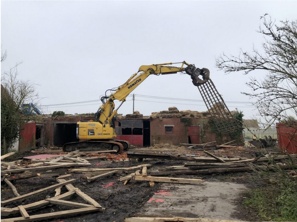
De schuur tijdens de afbraakwerken in 2019. Op de voorgrond de resten van de spanten.
