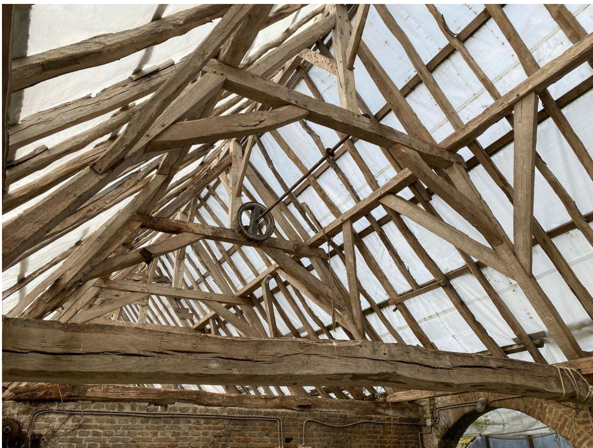
De bekapping gezien vanuit het wagenhuis
