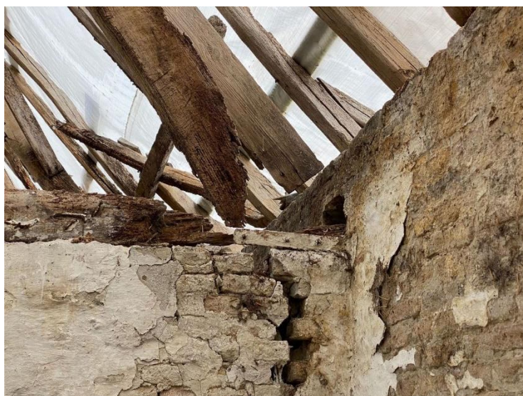
De bekapping. De uiteinden van de moerbalken. Enkele van de koppen zijn volledig weggerot.
