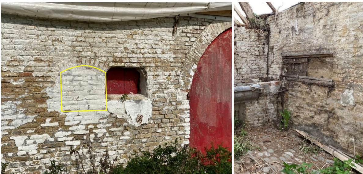
Het gedichte originele stalraam naast het nieuwe raam (links); rechts de schuifluikconstructie van hetzelfde raam
