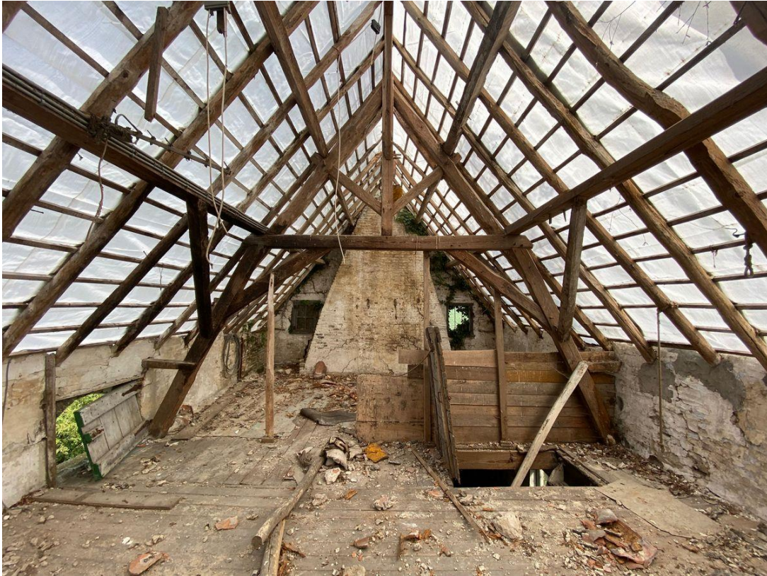
De bekapping boven het laaghuis gezien vanuit het westen. Vooraan rechts het luik van de zoldertrap. Vooraan links het luik van het laadvenster.
