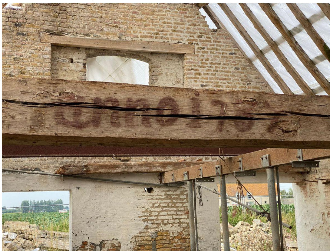
De datum 1787 geschilderd in een bruine verf op de eerste moerbalk vanaf het noorden.
