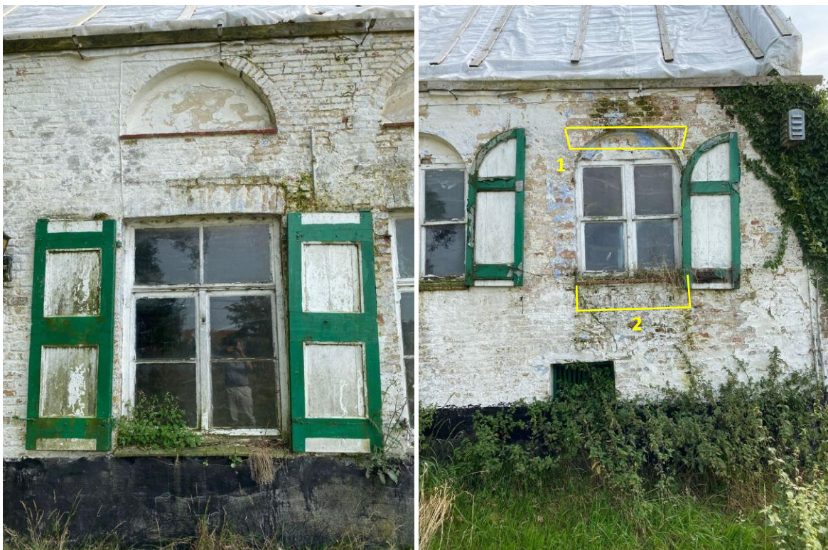
Detail erfgevel ter hoogte van de opkamer (links). De rondboognissen van de voutekamer doorbreken de originele streklaag (1). De vensterdorpel is verhoogd (2).
