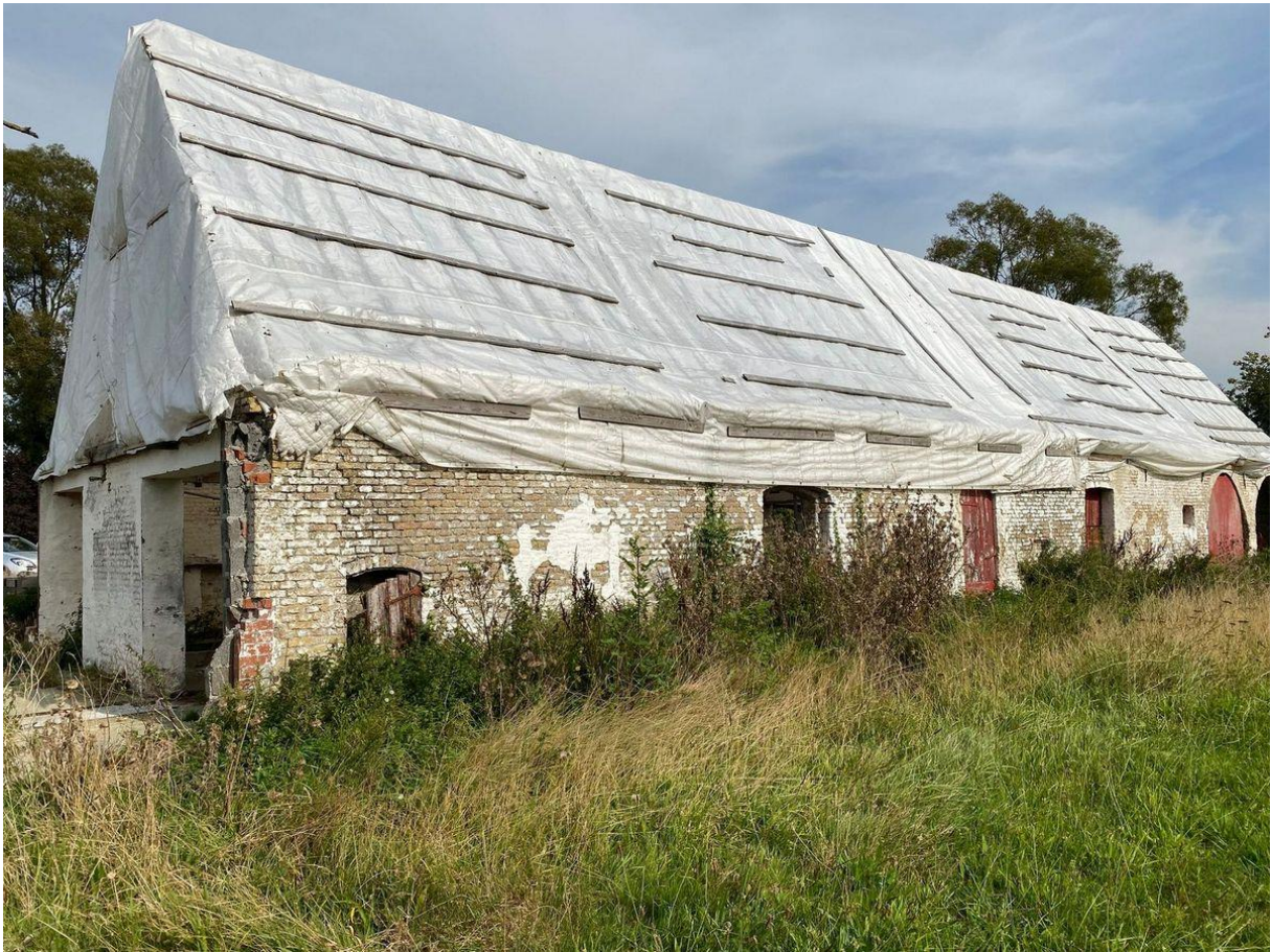
De stalling gezien vanuit het noordoosten (toestand zomer 2021)
