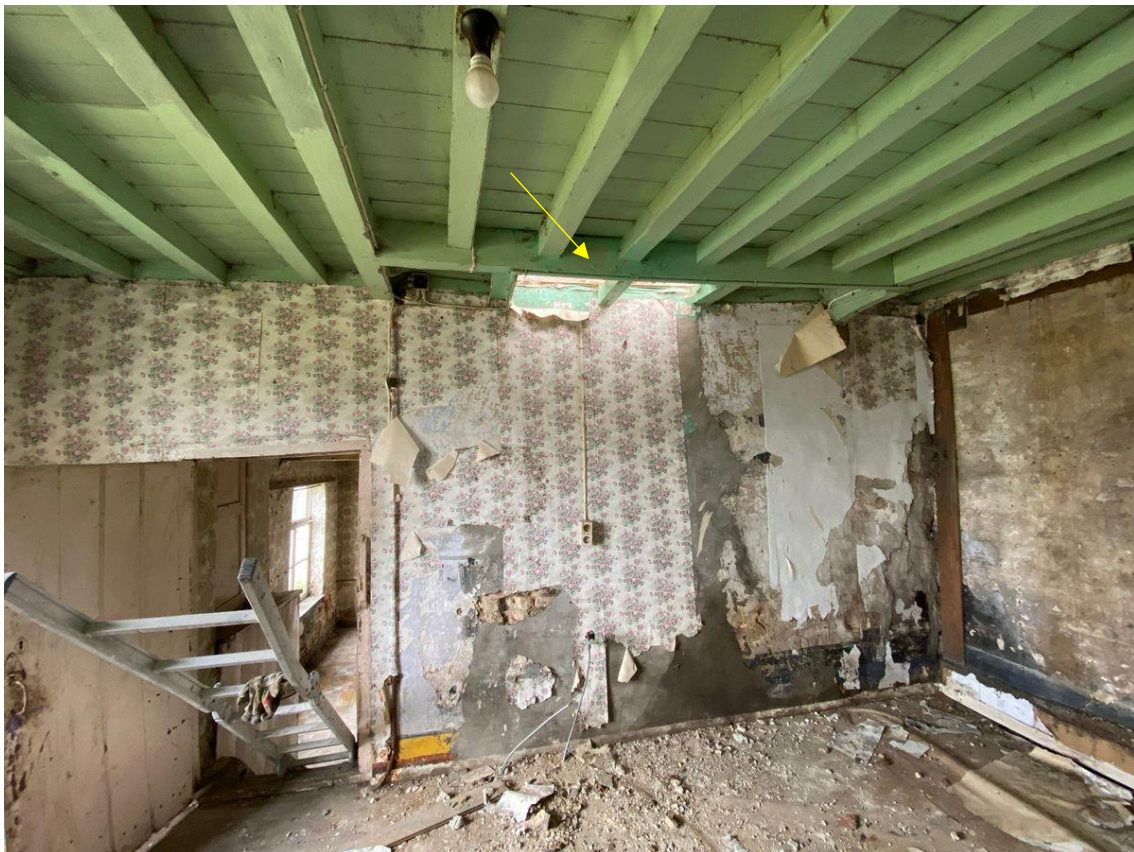
De oostmuur van de voutekamer. De ravelijnbalk (pijl) toont de plaats aan van de verdwenen openhaard.
