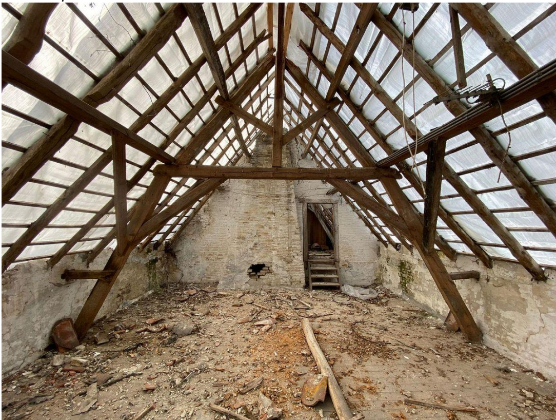
De bekapping boven het laaghuis gezien vanuit het oosten. Op de achtergrond de muur van de voute met de deur naar de zolder boven de voute.
