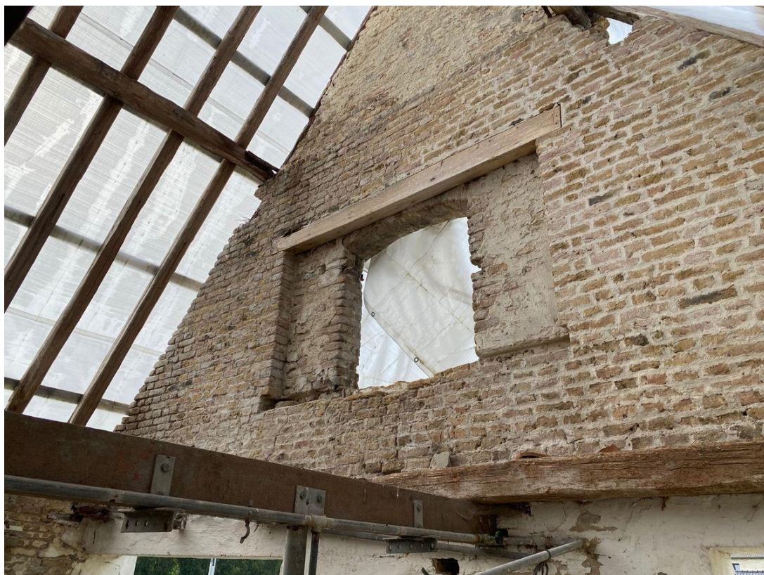
De binnenzijde van de noordelijke topgevel. De vensteropening steekt in een rechthoekige nis, die aan de binnenzijde met een kalklaag was bedekt.
