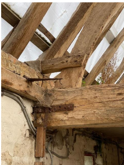
De bekapping. De uiteinden van de moerbalken. Enkele van de koppen zijn volledig weggerot.
