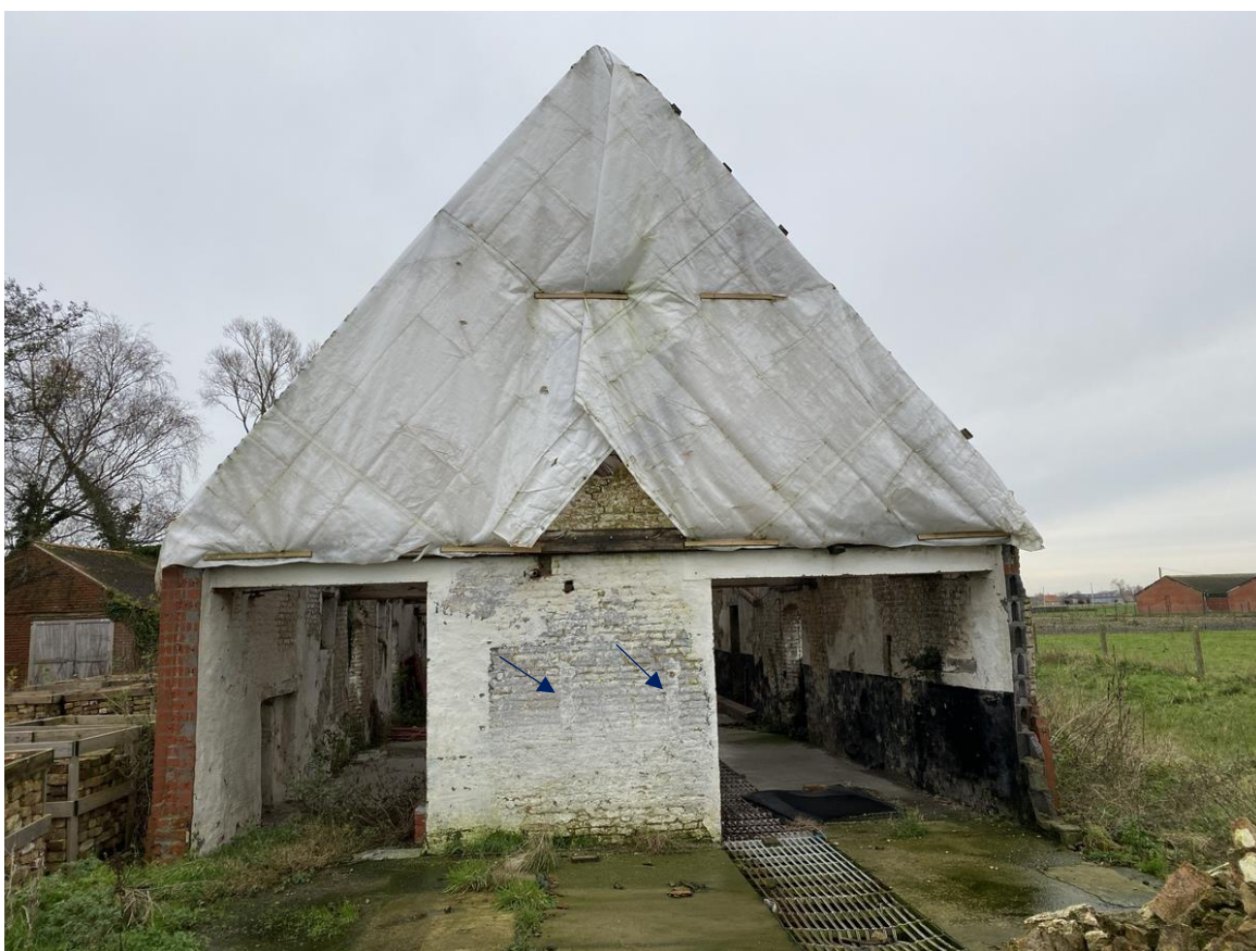
De noordelijke puntgevel. In de gevel zijn nog twee luchtspleten te onderscheiden.
