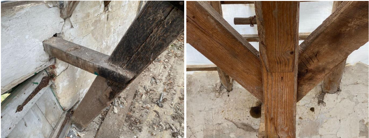
Het blokkeel (links) en de aanzet van de schoren voor de gordingen (rechts)
