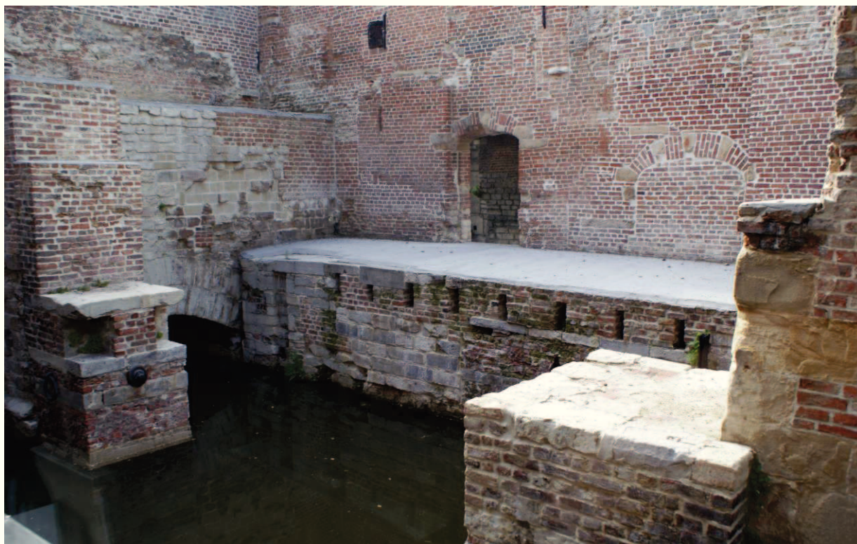
Na het weghalen van de wortelpakketten en de aarde, het stabiliseren van het metselwerk, het reinigen en hervoegen van de gevels, ... kan het water tussen het molenhuis en het spuihuis opnieuw ongehinderd doorstromen. De huidige toestand refereert aan de vroeger functie van het molencomplex. © stedelijke dienst Monumentenzorg Mechelen
