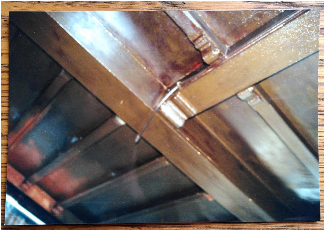
Gelijkvloers – restauratie plafond
