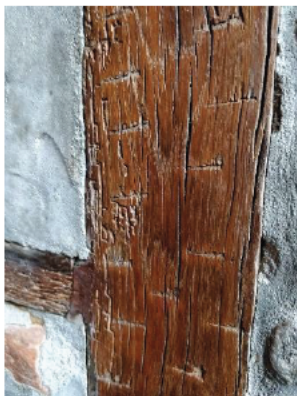
Kappen in houten vakwerk en cementering over het metselwerk.
