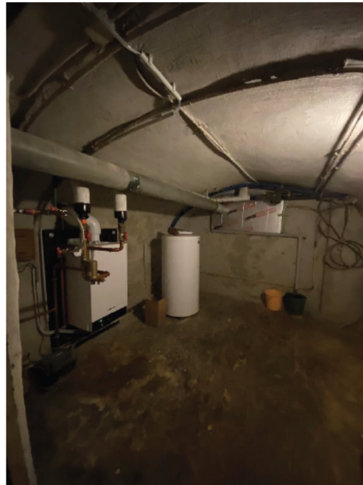
F2: Kelder 1 (Gewelfd is Erfgoedelement)
