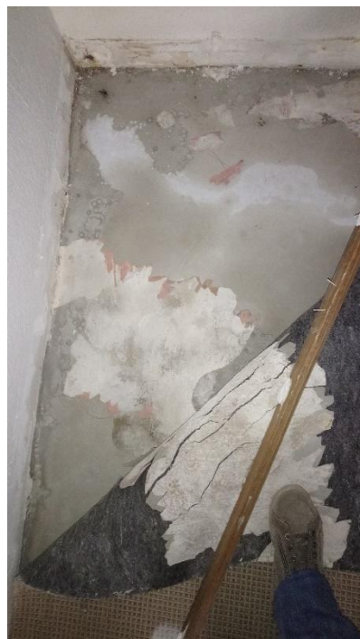
F2: Woonkamer 2 – betonplaat
