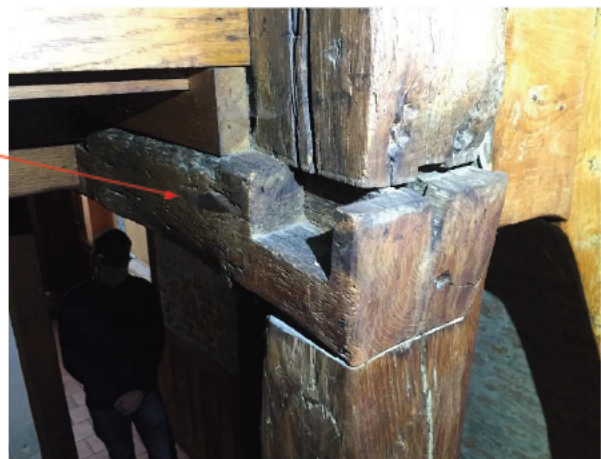
Afgesneden balk voor creatie trapgat + zichtbare opleg balk
