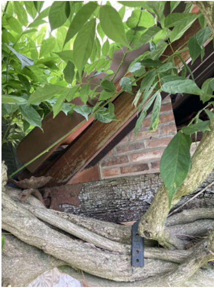
Aangetast houten balk
