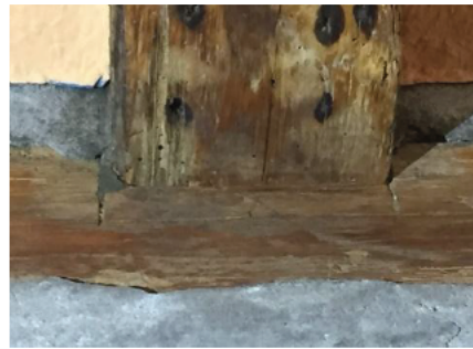
Kinderbalken herlegd en verstevigd voor beton/chape t.h.v. de badkamer op de verdieping (Balken zijn erfgoedelement)
