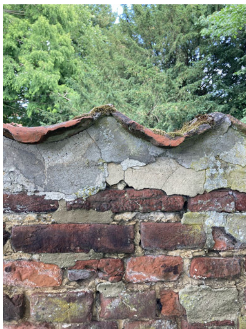
Verschillende lagen mortel
