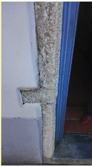
voordeur (Stenen Omkadering deur is Erfgoedelement)
