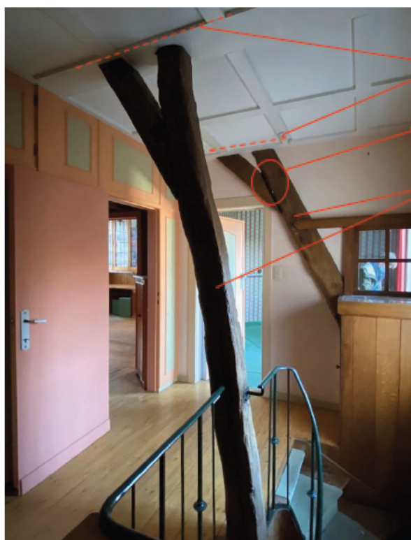
Gebinte afgezaagd onder plafond (spanten zijn Erfgoedelementen)
