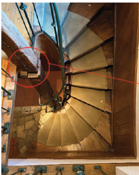
Gebinte gebruikt als verticale voor trap
