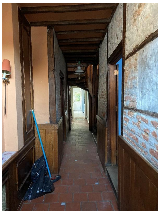
F5: Inkomhal (vakwerk is erfgoedelement)
