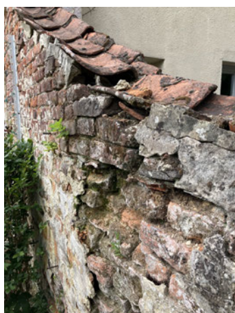
Aangetaste voegwerk
