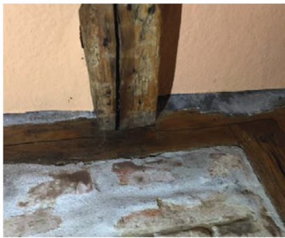
Kinderbalken herlegd en verstevigd voor beton/chape t.h.v. de badkamer op de verdieping (Balken zijn erfgoedelement)
