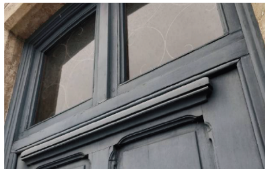
Sluitstuk op toch en waterinfiltratie te voorkomen
