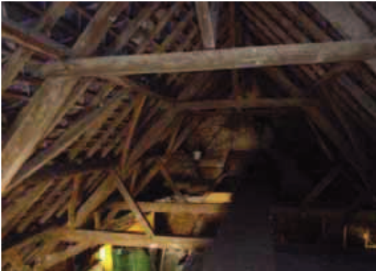
De monumentale kapconstructie van de woning is algemeen nog in goede staat.
