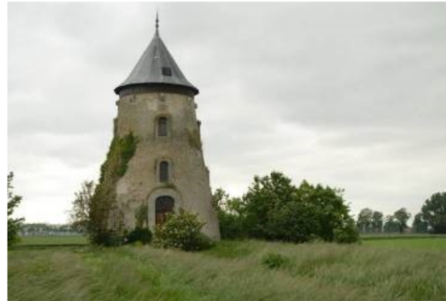
Zicht op de Sint-Gustaafmolen gelegen langs de Ringsloot Veurne (foto nr 90)
