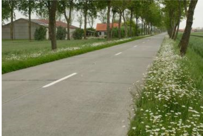
De Moeren, W. Cobergherstraat vanaf kasteellaan in noordelijke richting (foto nr 76)
