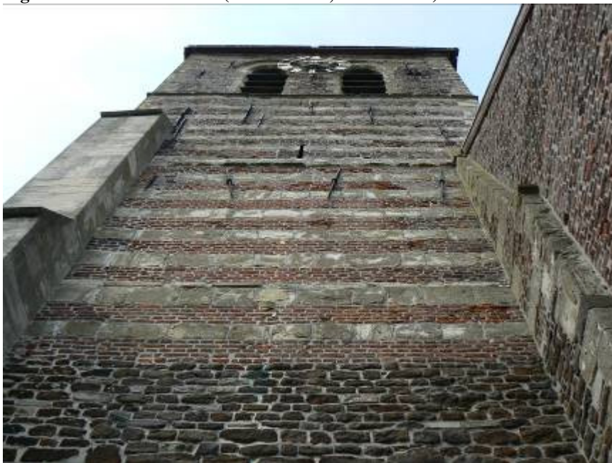
Figuur 16: bouwkundige gelaagdheid in de kerk van Elst (gebruik van veldstenen) in combinatie met speklagen
