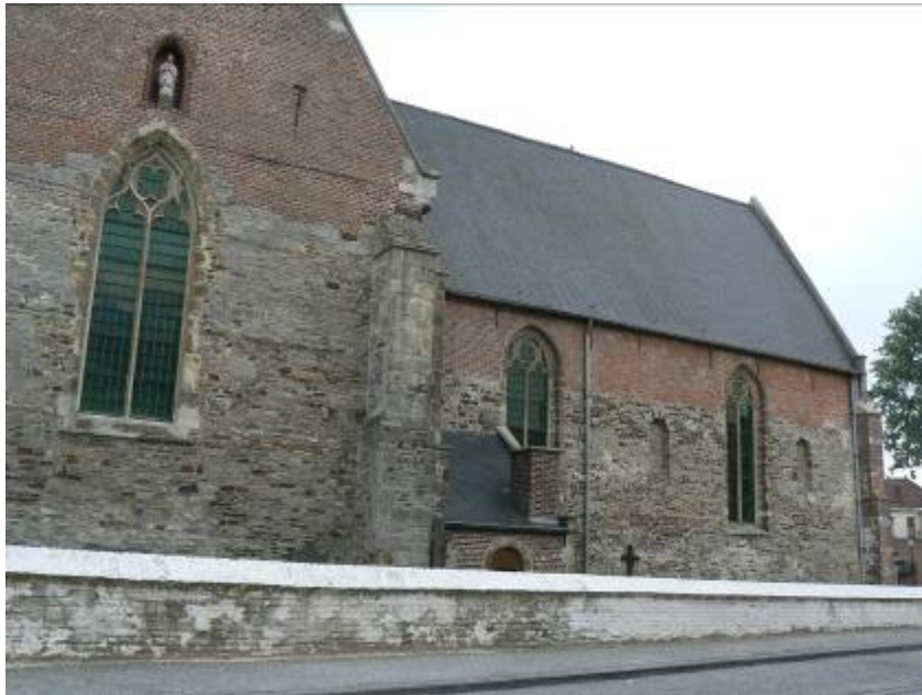
Figuur 13: bouwkundige gelaagdheid in de kerk van Rozebeke
