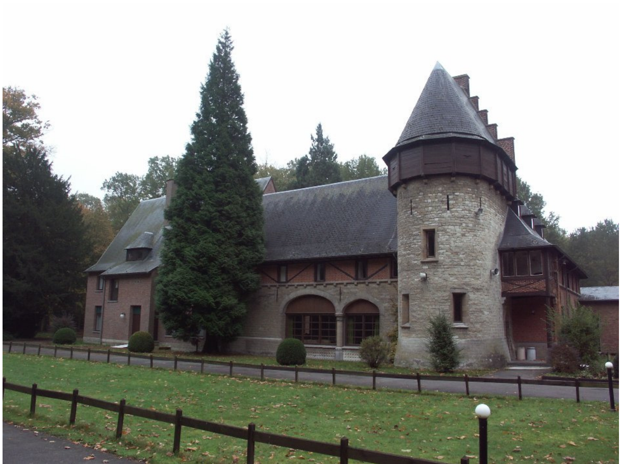
Foto 2: Bijgebouwen bij het kasteel van Zellaar, oorspronkelijk gebouwd als koetshuis en paardenstal
