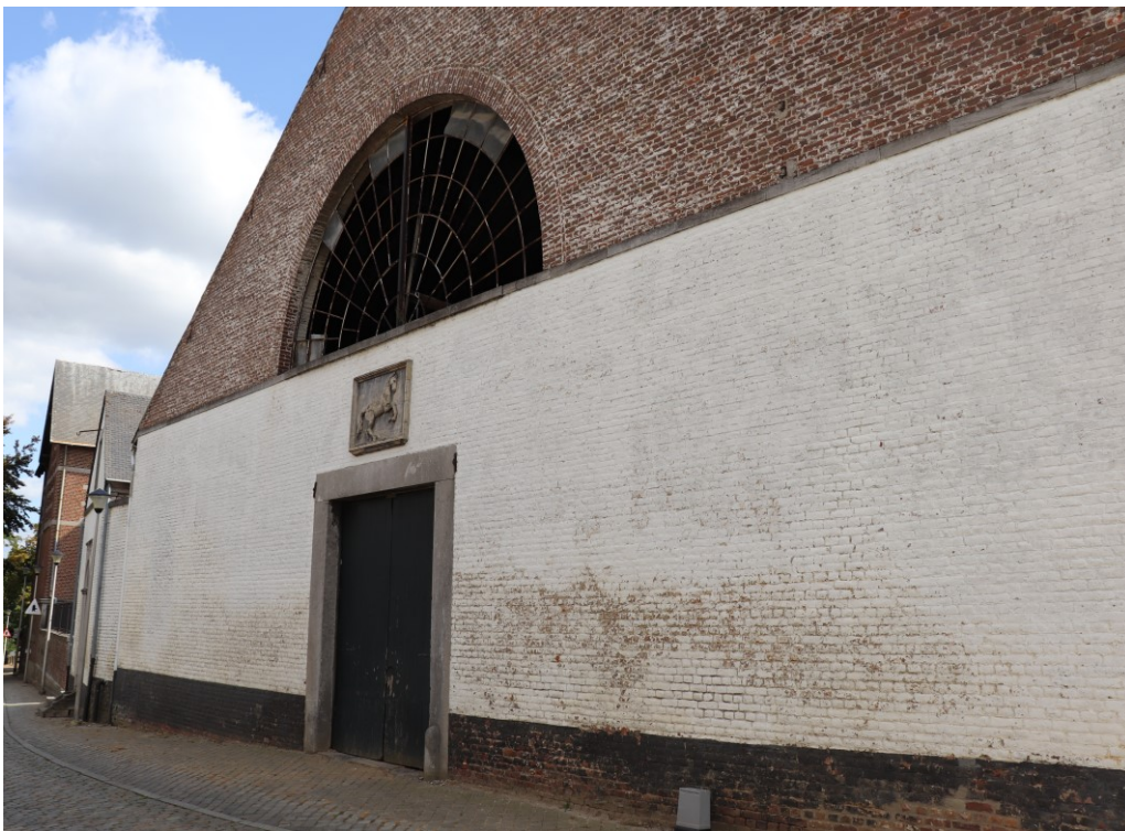
Voorgevel - toestand september 2021
