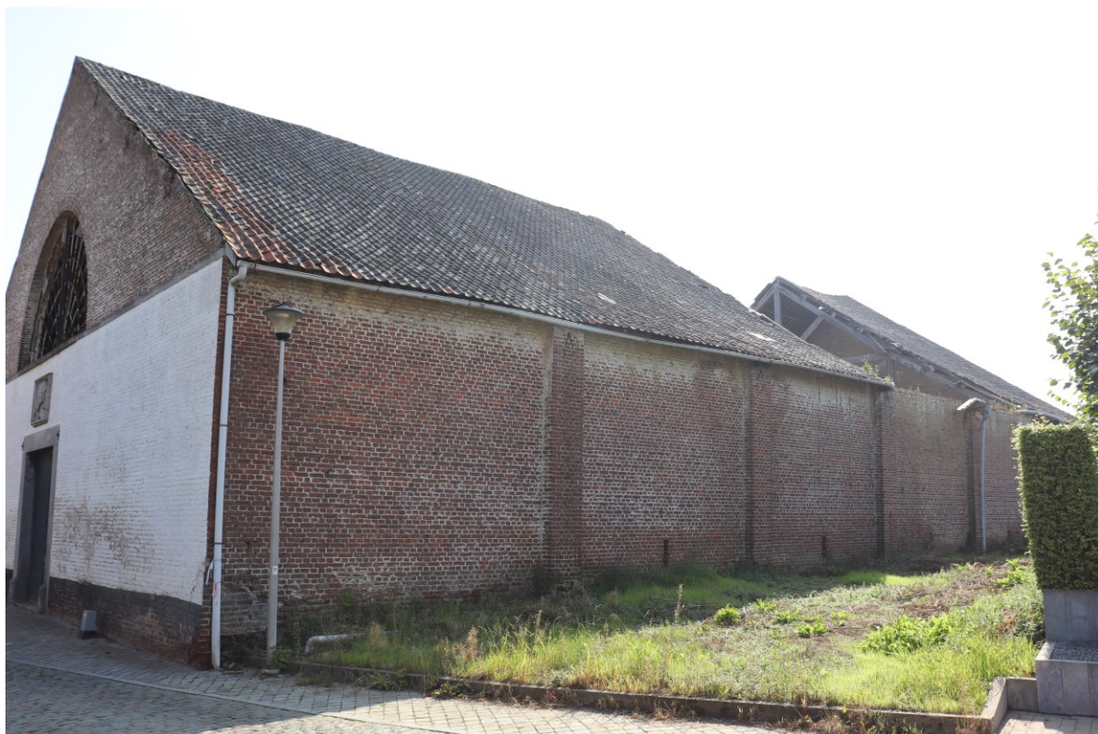
Westelijke zijgevel - toestand september 2021
