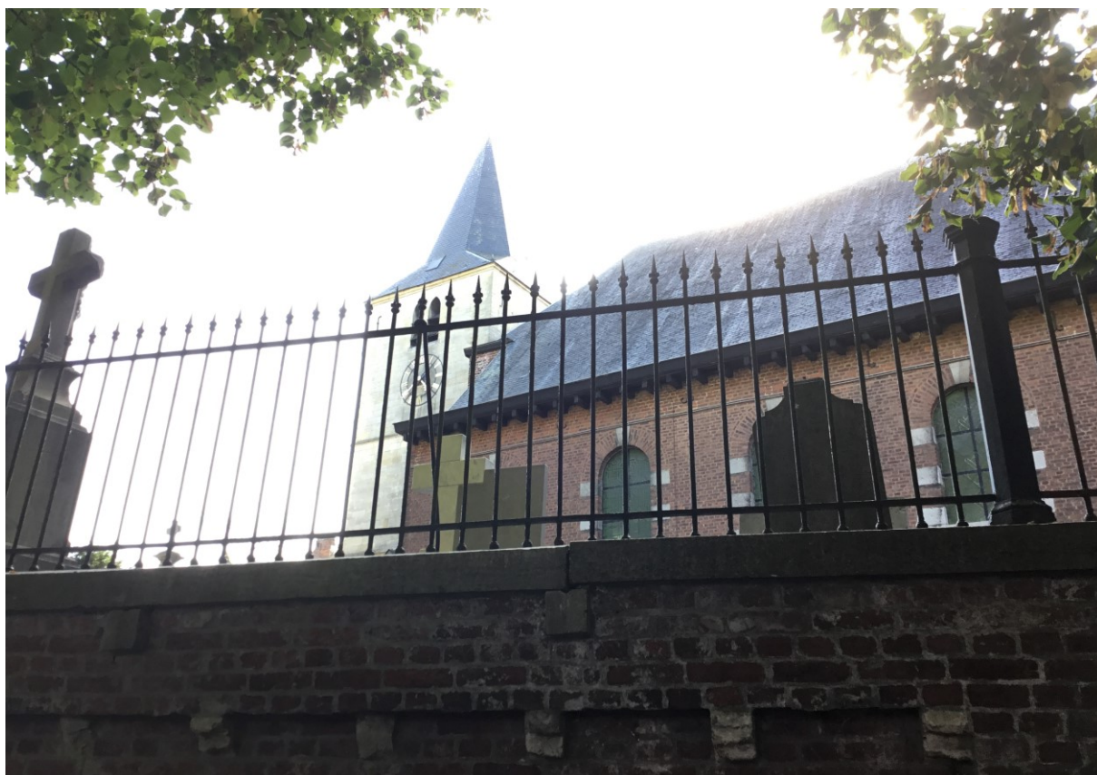
Kerkhof, bakstenen muur met gietijzeren hekwerk
