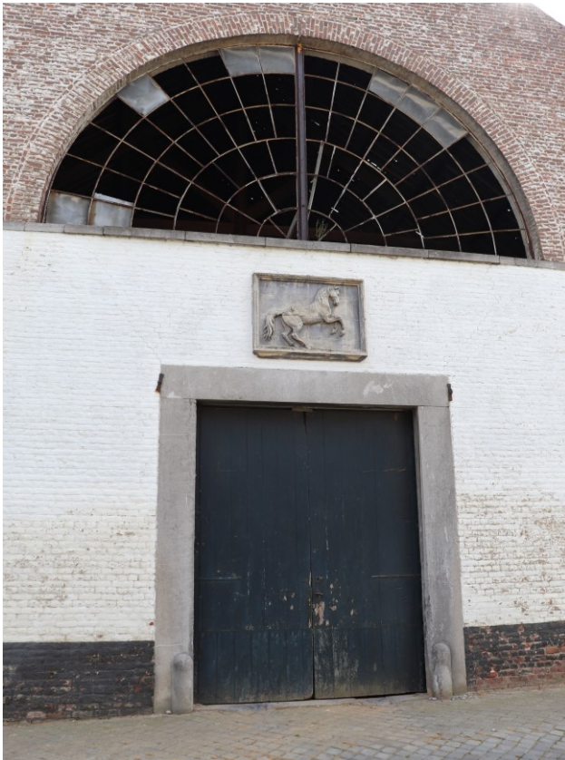
Voorgevel - toestand september 2021
