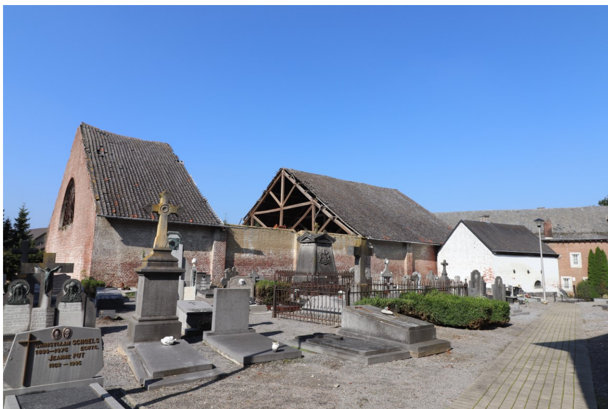
Oostelijke zijgevel - toestand september 2021
