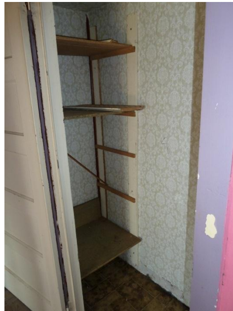
Foto 19: woning 15: berging (verdieping)
