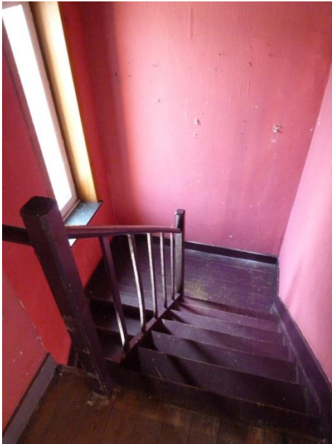
Foto 16: woning 15: trap (verdieping)
