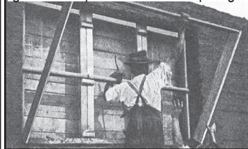
fig. 33: Houten panelen voor creatie openingen
