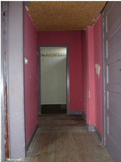
Foto 18: woning 15: hal (verdieping)
