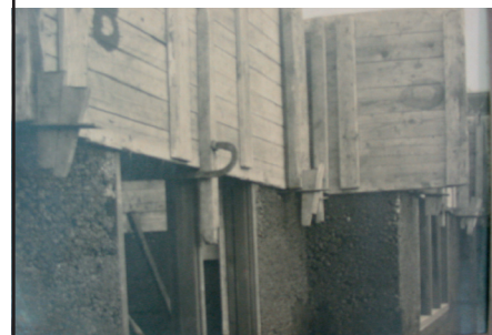
fig. 15: Werffoto's : gebruik van asbeton volgens het Duitse NONPLUS-systeem
