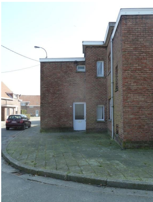
Foto 4: Woning 3: straatgevel kort, voorgevel
