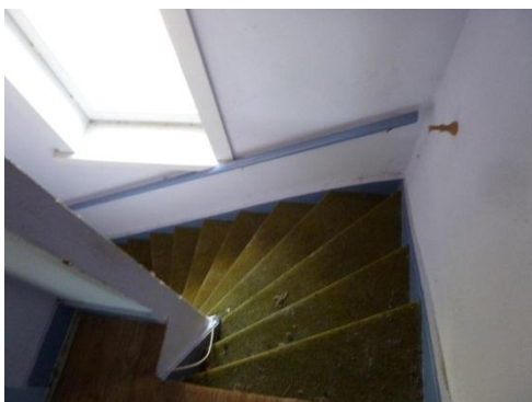
Foto 69: woning 3: trap verdieping
