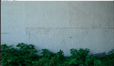
fig. 24: Beschadigde plint, Kard. Mercierplaats 4
