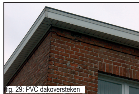
fig. 29: PVC dakoversteken
