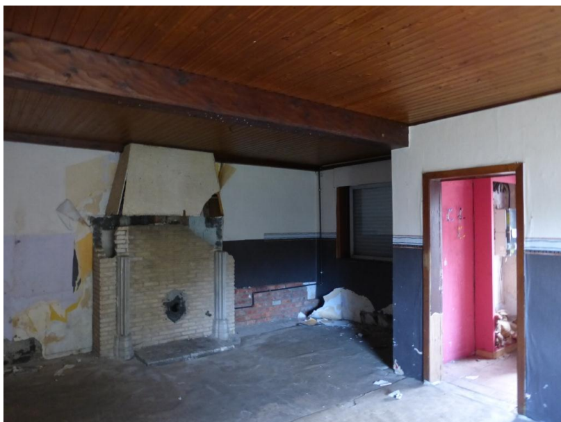
Foto 18: Kardinaal Mercierplein nr15: gelijkvloers, verwijderde binnenmuur (© Onroerend Erfgoed)
