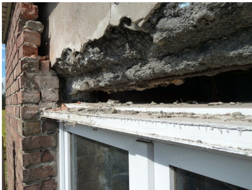
Foto 16: Kardinaal Mercierplein nr15 : beschadigde asbeton boven raam (© Onroerend Erfgoed)
