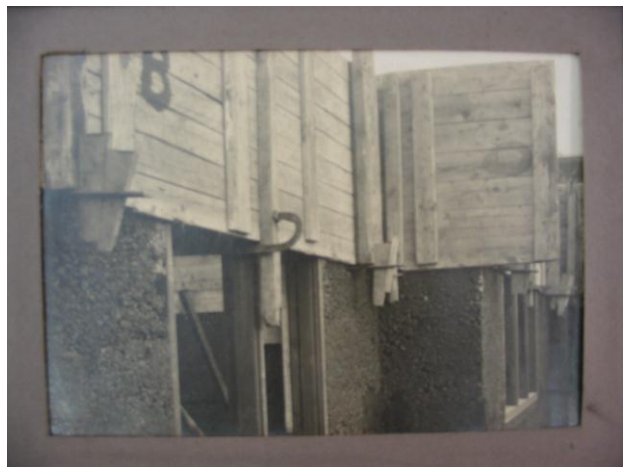
Foto 09 en 10: werffoto's van het gebruik van asbeton (© Sint-Lucasarchief Brussel, collectie Huib Hoste)
