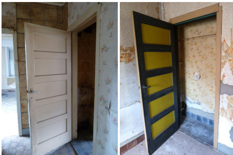
Foto 21 / 22 : kastenwand woning nummer 4 (© Onroerend Erfgoed)
