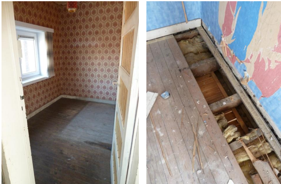
Foto26 / 27 : houten verdiepingsvloeren (© Onroerend Erfgoed)
