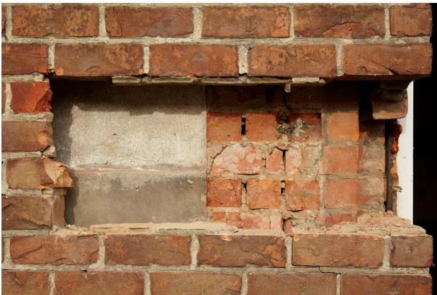
Foto 15 : Kardinaal Mercierplein 15 :bakstenen voorzetwand, afgeslepen deurpenant in baksteenmetselwerk (© Onroerend Erfgoed)
