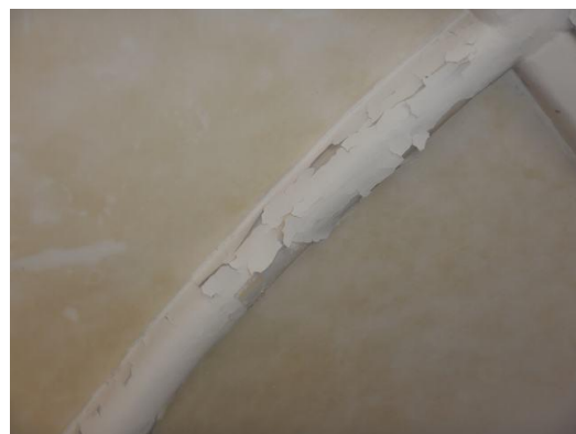
Afbladderende verf op de ribben
