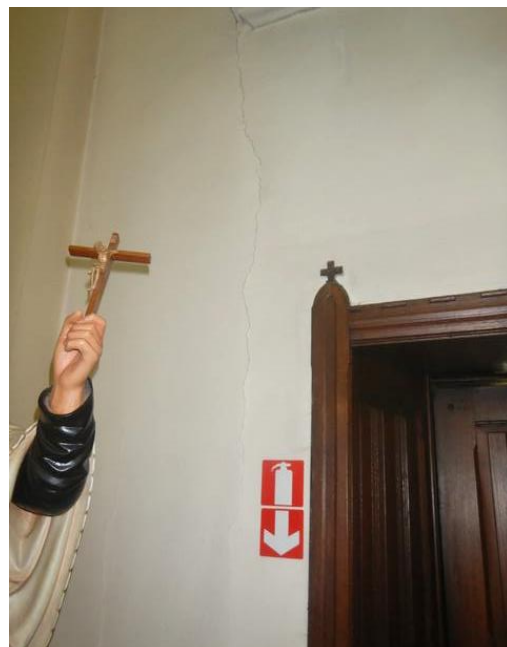
Zettingsscheur
