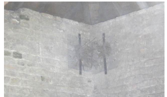
Goede afscherming van de gaten aan de binnenzijde van de toren
