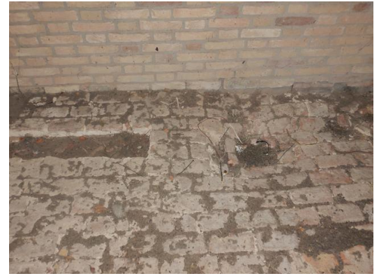
Bakstenen vloer tussenverdieping toren
