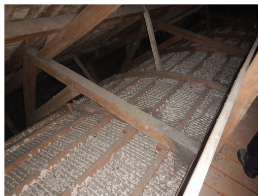
Kapconstructie en koepelconstructie kerk
