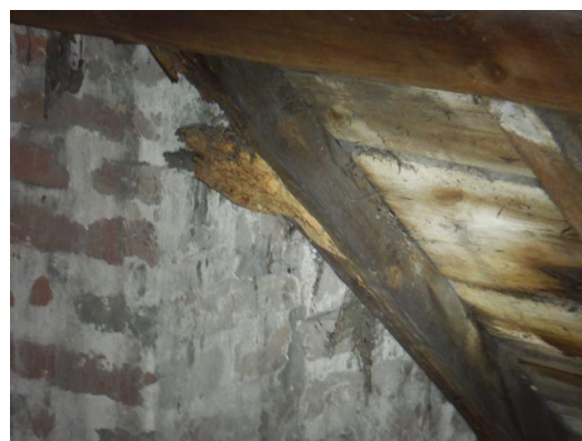
Aantasting huisboktor door inrotting
