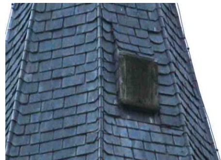
Foto tijdens de vorige inspectie = 2012
