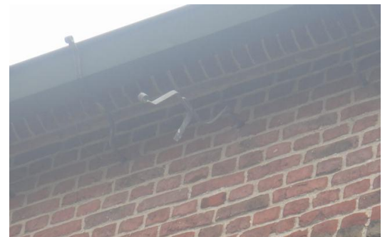
Scheef hangende gootbeugel dakvlak [17]
