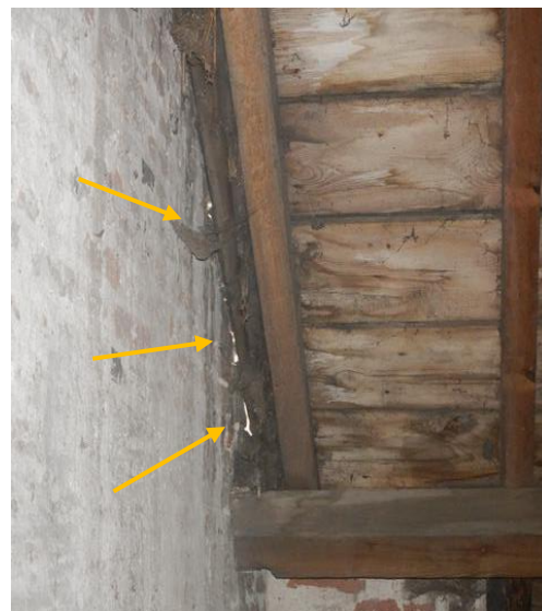
Dakvlak [18] - Lichtinval op de kapzolder ter hoogte van de aansluiting tussen het dak en de toren.
