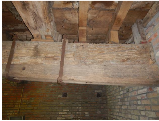
Moerbalk toren – onder klokkenzolder
