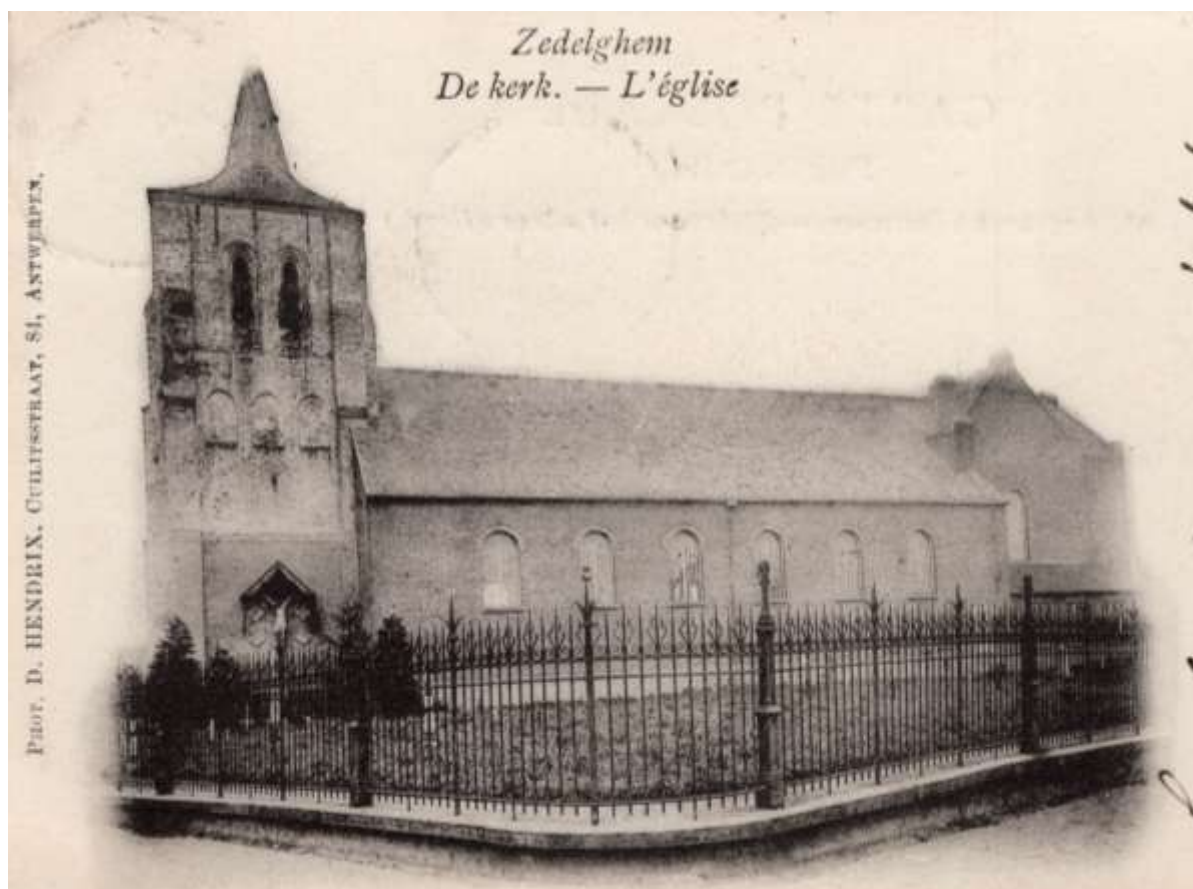
Twee foto's van de kerk met het nieuwe schip rond 1900. Slechts enkele stenen grafmonumenten en een familiekapelletje zijn te zien op het kerkhof. Deze bevinden zich in de uitbreidingszone van 1887. Het kerkhof is omringd door een smeedijzeren hek. De linden zijn nog niet aangeplant. (prentbriefkaarten Gemeentearchief Zedelgem)
