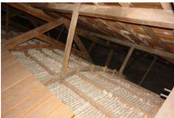
Beploistering rinkellatten tongewelf middenbeuk
