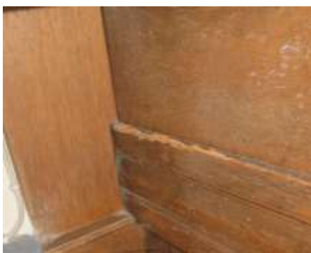
Aantasting door houtworm op linker en rechter zijkant
