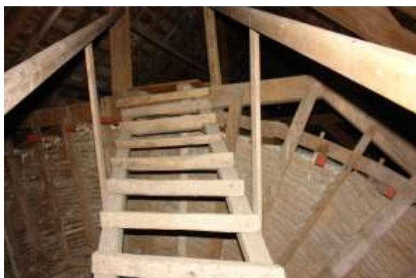
Ladder vanaf toren naar loopbrug middenbeuk.
