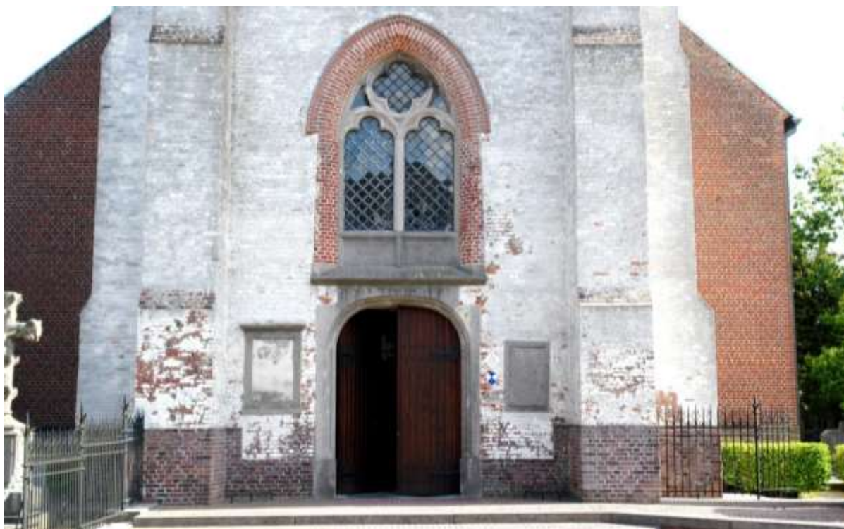
Westgevel, hoofdingang en spitsboograam vervangen in 1847.
