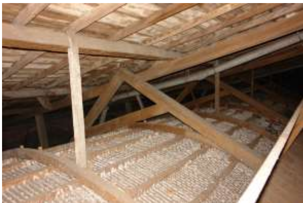
Bepleistering rinkellatten tongewelf middenbeuk
