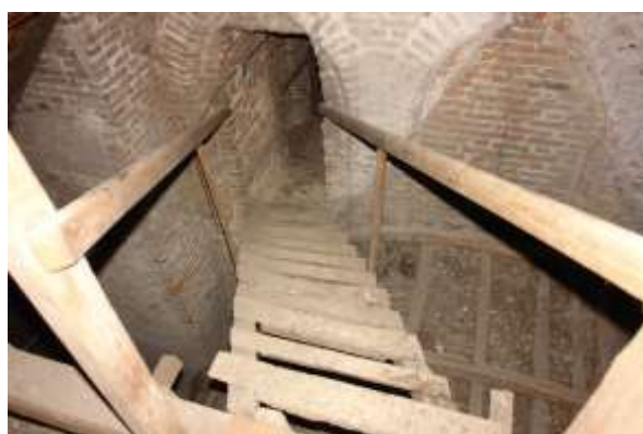
Ladder vanaf toren naar loopbrug middenbeuk.
