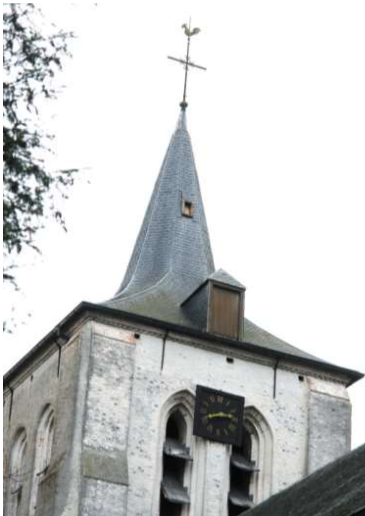
Torenspits met dakkapel, dakluik en torenuurwerk..
