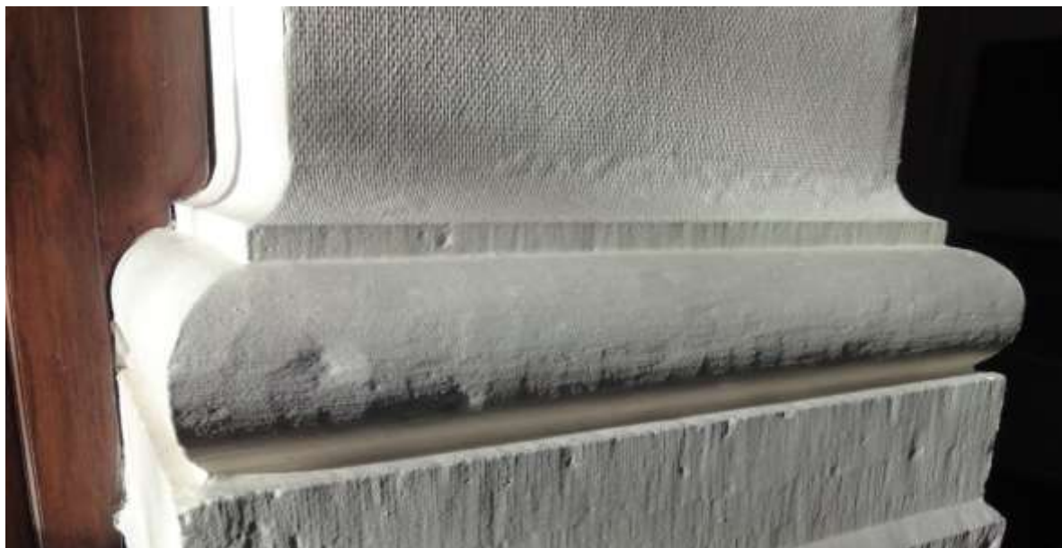
Storende glasvezelstructuur op kolommen
