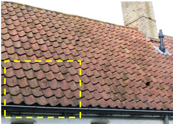
Figuur 122 (links en rechts) Detail dakvlak voorgevel: ventilatiepan, opgewaaide pannen en afgeschilferde pan (13.10.2021)
