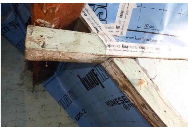
Figuur 157 Nummer 15: sporen van aantasting door houtborende insecten in structuur dakkapel (13.10.2021)
