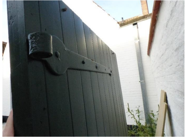
Figuur 127 Tuinpoort: gerecupereerde spoorhengsels (13.10.2021)
