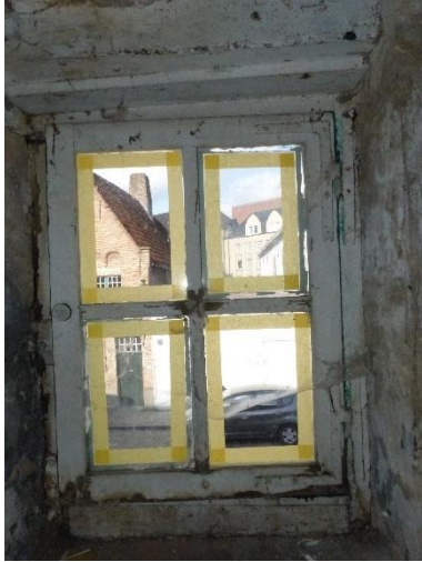
Figuur 141 Nummer 11: zolderraam met hengsels en ronde knop (13.10.2021)
