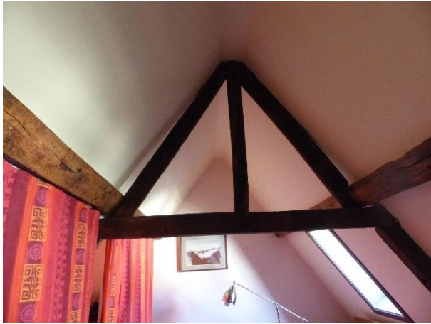
Figuur 170 Nummer 6: getelmerkt A-spant, korbelen ontbreken (13.10.2021)
