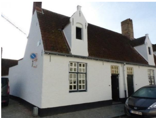
Figuur 117 Dak hoofdvolume in Boomse pannen (13.10.2021)
