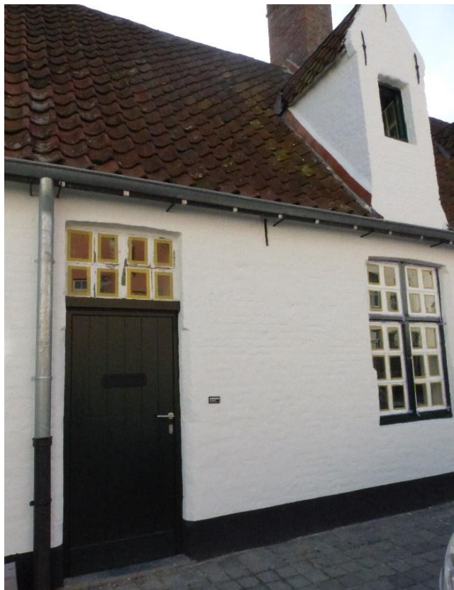
Figuur 118 Zinken mastgoot verankerd aan metselwerk voorgevel en vernieuwde zinken regenwaterafvoer aangesloten op dolfijnstuk (13.10.2021)
