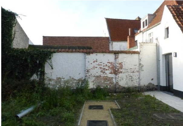
Figuur 86 Tuinmuur voor renovatiewerken (13.10.2021)
