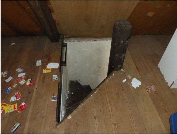
Figuur 219 Nummer 2: trapgat gezien vanaf zolder (13.10.2021)
