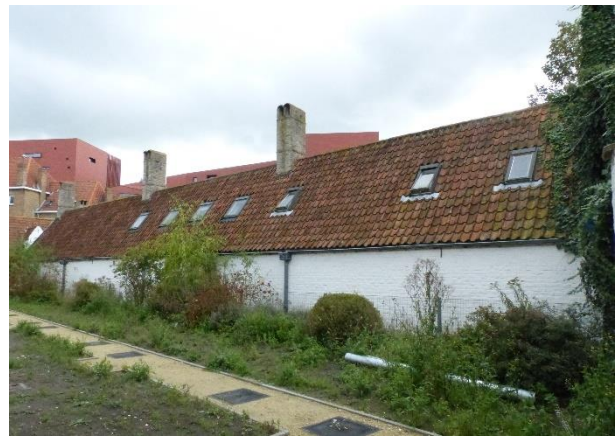
Figuur 121 Dakvlak achtergevel met dakvlakvensters en regenpijpen met vergaarbak (13.10.2021)
