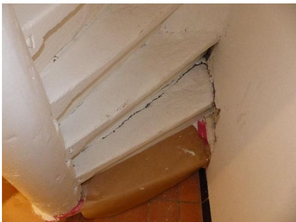
Figuur 210 Nummer 17: historische spiltrap: vernieuwde eerste trede (13.10.2021)
