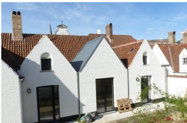
Figuur 116 Dak 17de-eeuws hoofdvolume en aanbouwen uit de jaren 1960 in Boomse pannen (13.10.2021)
