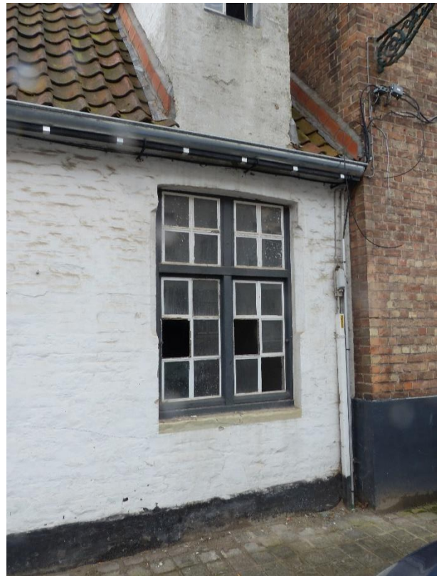
Figuur 132 Nummer 19: guillotineraam met vlak kalf voor de restauratiewerken (18.03.2021)
