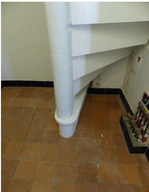
Figuur 200 Nummer 11: historische spiltrap: onderzijde tredes verstevigd, vernieuwde eerste trede (13.10.2021)
