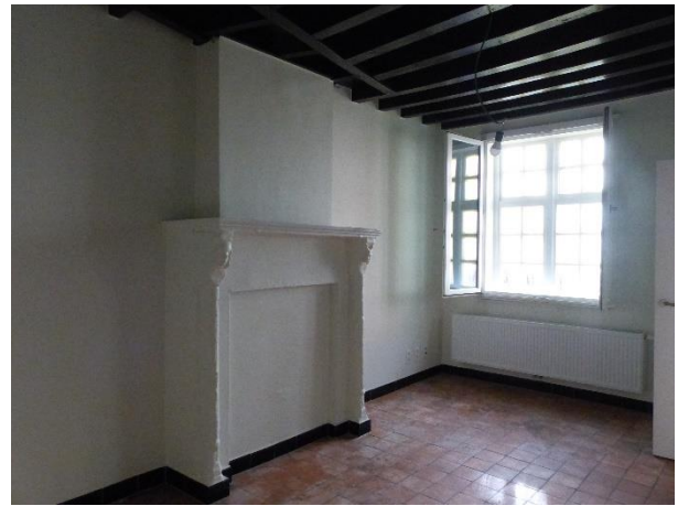
Figuur 239 Nummer 19: geprofileerde schouwmantel. Haardnis is dichtgemetseld (13.10.2021)
