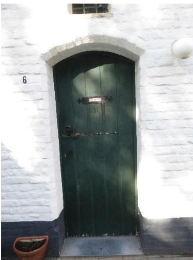
Figuur 92 Getoogde deuropening met afgeschuinde dagkanten godshuis Gloribus (13.10.2021)
