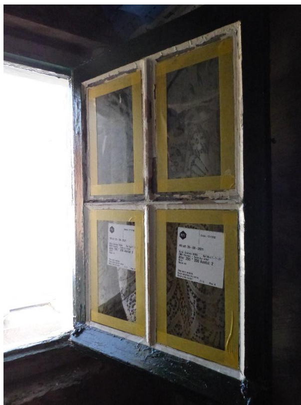
Figuur 138 Nummer 9: zolderraam met nieuw getrokken glas tijdens schilderwerken (13.10.2021)
