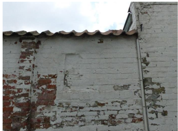
Figuur 89 Dichtgemetselde opening in tuinmuur (13.10.2021)
