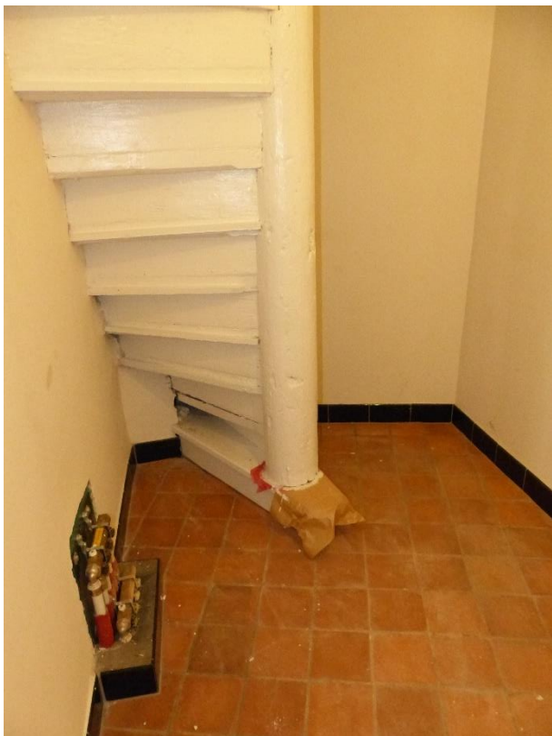
Figuur 210 Nummer 17: historische spiltrap: vernieuwde eerste trede (13.10.2021)
