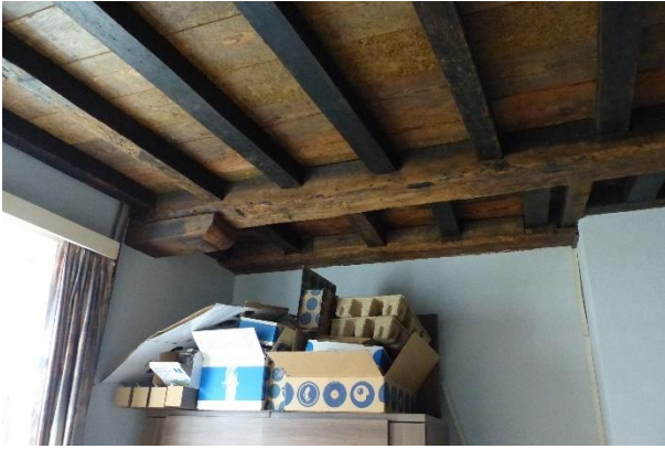
Figuur 180 Nummer 2: roostering zoldervloer in slaapkamer met raveelconstructie voor schouwkanaal (13.10.2021)
