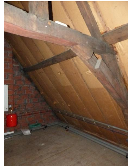
Figuur 174 Nummer 2: detail spant Figuur 154: korbeel vervangen met recuperatiehout (13.10.2021)
