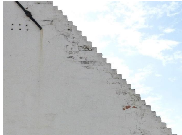
Figuur 99 Detail goed bewaarde getrapte zijpuntgevel zonder bijkomende afdekking. De foto toont vochtshade ter hoogte van de randen (13.10.2021)
