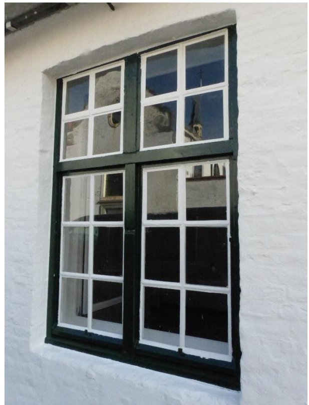
Figuur 134 Nummer 13: guillotineraam met vlak kalf na de restauratiewerken (13.10.2021)
