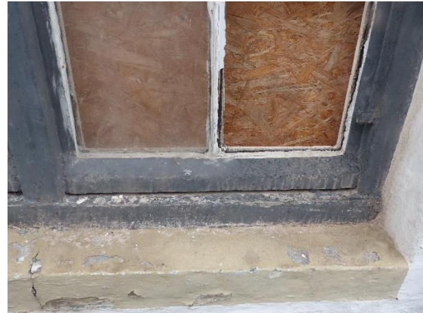
Figuur 71 Witstenen raamdorpels met sporen van verschillende lagen schilderwerk - inmiddels hersteld en overschilderd (18.03.2021)
