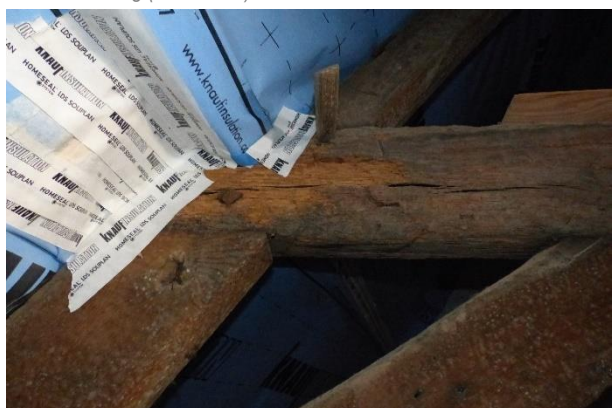
Figuur 158 Nummer 13: sporen van aantasting door houtborende insecten ter hoogte van trek balk spant (13.10.2021)
