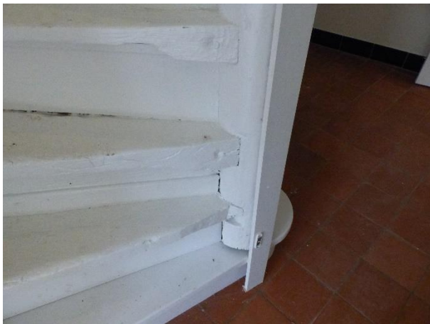
Figuur 205 Nummer 15: historische spiltrap: vernieuwde eerste trede (13.10.2021)
