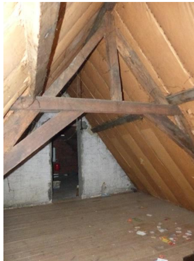
Figuur 173 Nummer 2: getelmerkt A-spant (13.10.2021)
