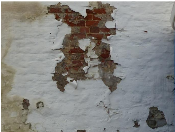
Figuur 78 Onderzijde muur in oranje tot bruine baksteen met onregelmatige vorm, bovenliggend gedeelte in oranje baksteen met veel regelmatigere vorm, beide gevoegd met kalkmortel (18.03.2021)
