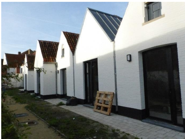
Figuur 79 Zicht op achterzijde van nummers 9 t.e.m. 15. De uitspringende volumes zijn volumes uit de jaren 1960, die verlengd werden in 2021 (13.10.2021)
