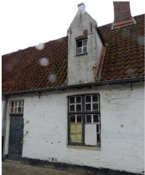
Figuur 123 Situatie buitenschrijnwerk voorgevel tijdens de werken (18.03.2021)
