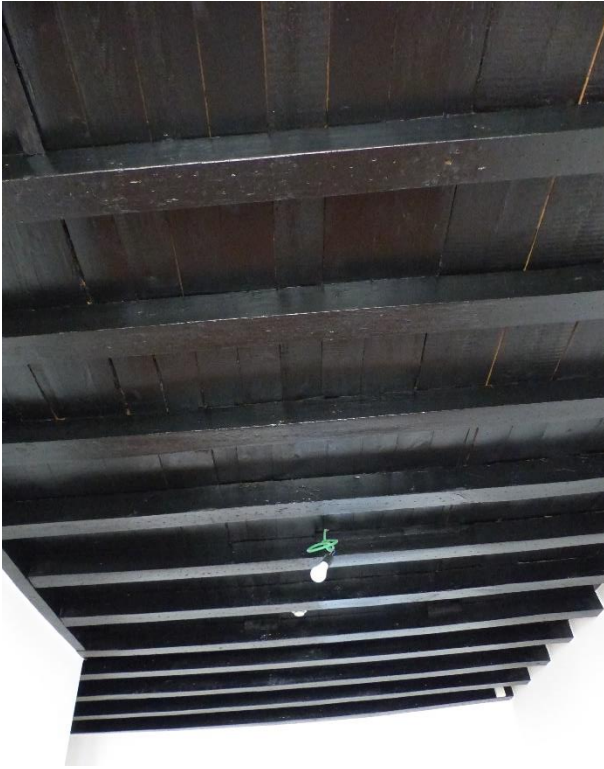
Figuur 176 Nummer 9: onderzijde zoldervloer bestaande uit een combinatie van brede en smalle planken (13.10.2021)
