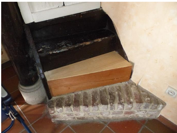
Figuur 217 Nummer 2: eerste twee tredes vervangen (13.10.2021)
