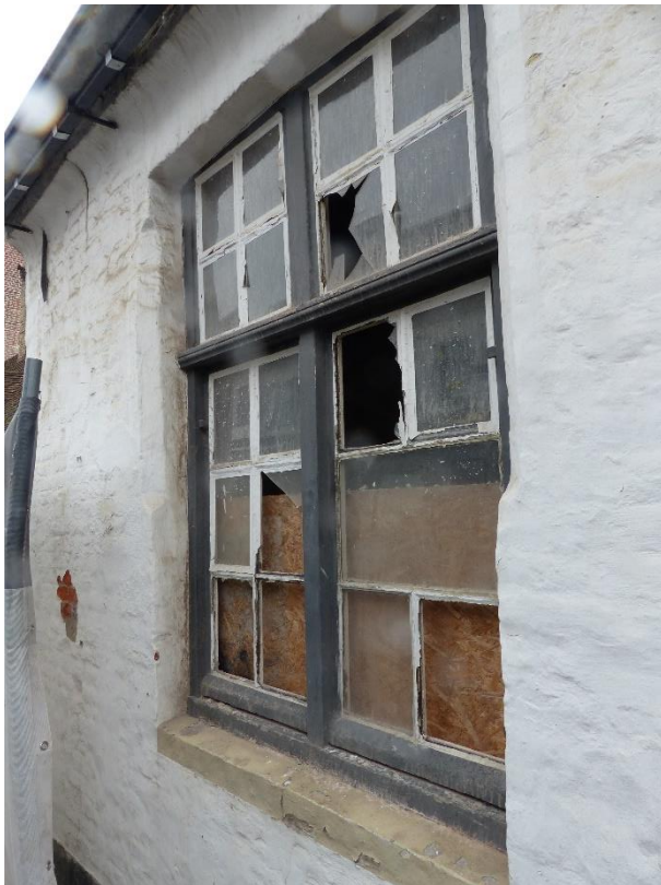
Figuur 131 Nummer 9: guillotineraam met geprofileerd kalf voor de restauratiewerken (18.03.2021)
