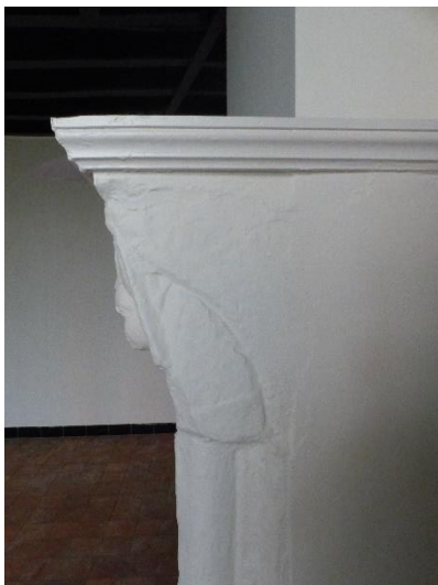
Figuur 243 Nummer 19: detail profiel schouwvang (13.10.2021)
