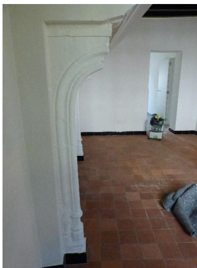
Figuur 224 Nummer 9: schouwmantel in profiel (13.10.2021)
