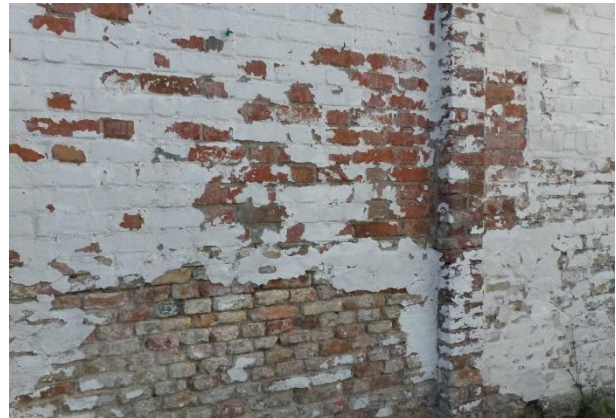
Figuur 87 Bovenste gedeelte in een ander type baksteen dan onderste deel (13.10.2021)
