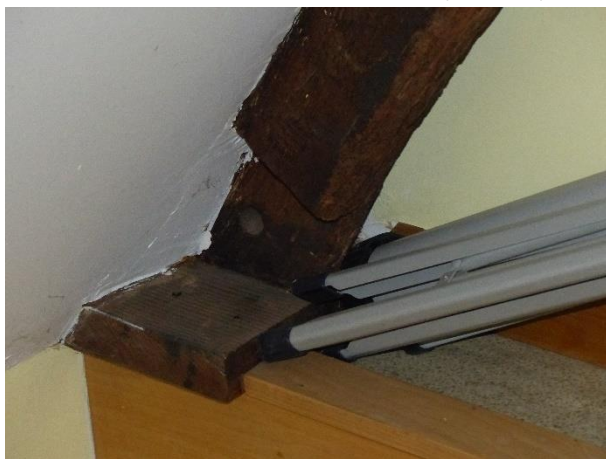
Figuur 167 Nummer 6: detail aangepaste spantvoet (13.10.2021)
