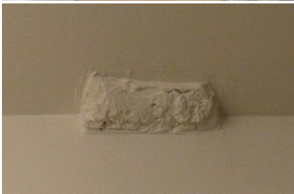
Figuur 149 (linksboven) Nummer 11: zoutuitbloeiing onder historische trap (13.10.2021)
