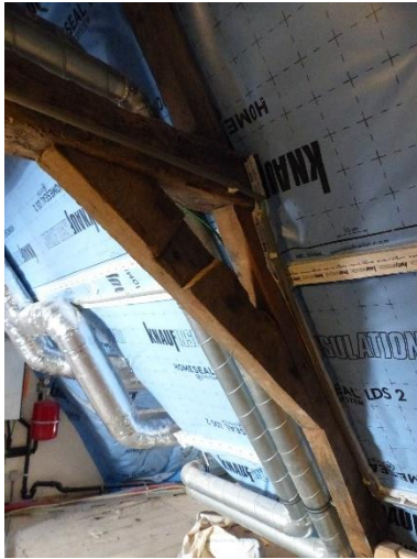
Figuur 159 Nummer 9: korbeel vervangen met recuperatiehout (13.10.2021)
