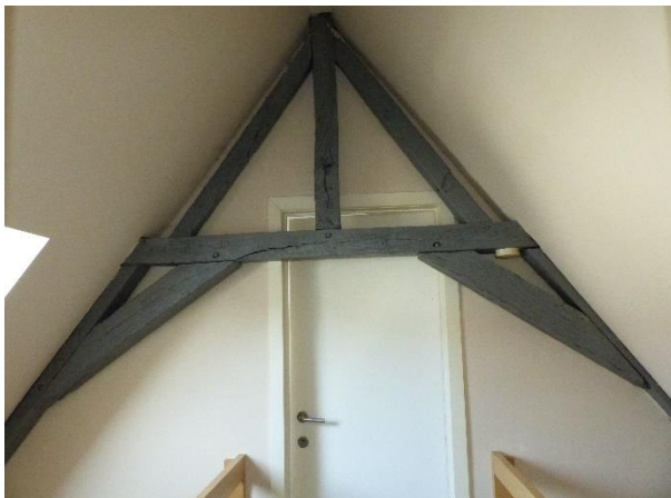
Figuur 162 Nummer 4: getelmerkt A-spant (13.10.2021)
