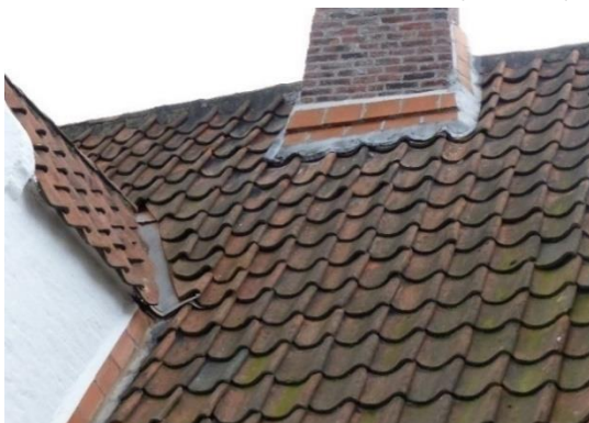
Figuur 119 Detail vernieuwde aansluitingen in voorgevel (13.10.2021)
