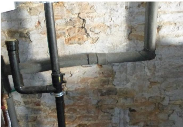
Figuur 183 Nummer 11: afgebrokkelde gekaleide afwerking (13.10.2021)
