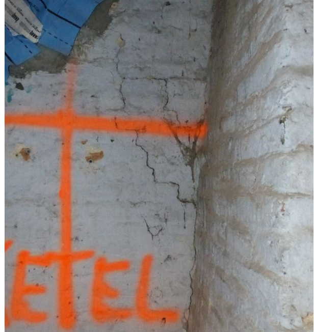
Figuur 149 (linksboven) Nummer 11: zoutuitbloeiing onder historische trap (13.10.2021)
