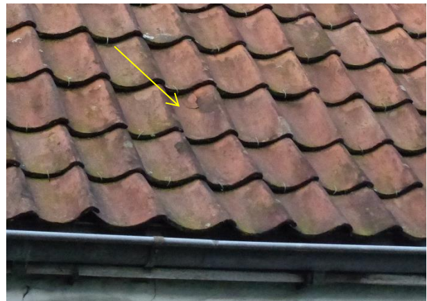
Figuur 122 (links en rechts) Detail dakvlak voorgevel: ventilatiepan, opgewaaide pannen en afgeschilferde pan (13.10.2021)
