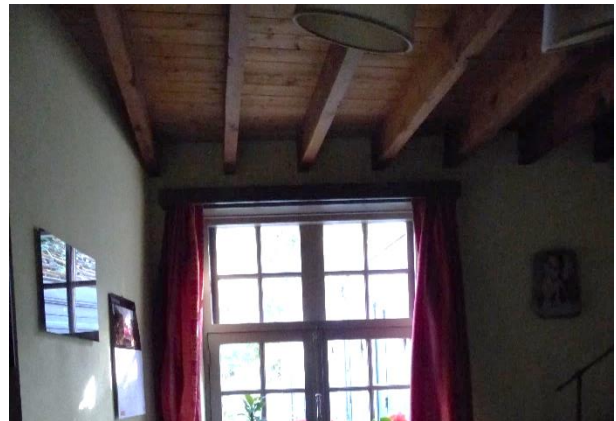
Figuur 181 Nummer 2: roostering zoldervloer in slaapkamer met plank afgewerkt met jasperstechniek (13.10.2021)
