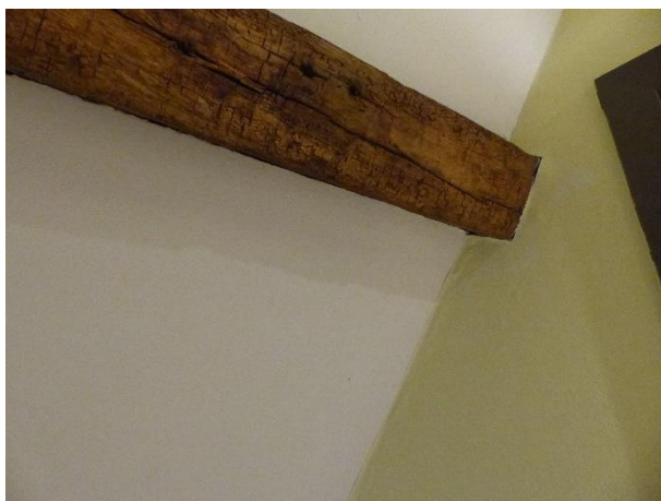
Figuur 169 Nummer 6: gording met windscheur en kubisch rot (13.10.2021)
