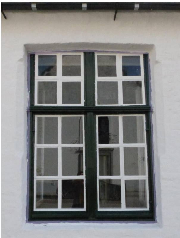
Figuur 133 Nummer 9: guillotineraam met geprofileerd kalf na de restauratiewerken (13.10.2021)
