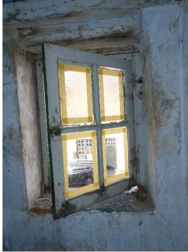
Figuur 142 Nummer 13: zolderraam met schuifslot met draaiknop en briquetschamieren (13.10.2021)
