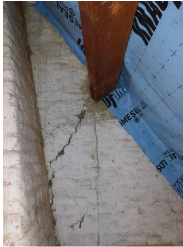
Figuur 160 Nummer 11: vernieuwde gording veroorzaakt barst in metselwerk (13.10.2021)
