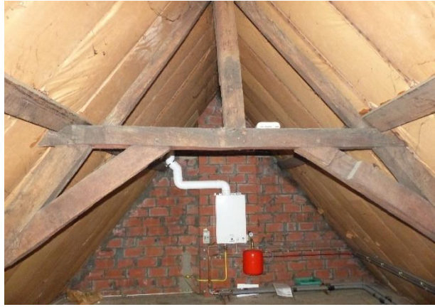
Figuur 154 Nieuwe scheidingsmuur tussen nummer 2 en nummer 4 (13.10.2021)
