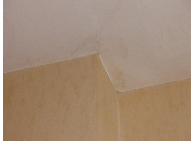
Figuur 190 Gloribus nummer 4: sporen van vochtinfiltratie langs schouwkanaal (13.10.2021)
