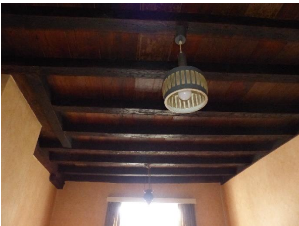
Figuur 178 Nummer 2: roostering zoldervloer in leefruimte met ravelconstructie voor schouwkanaal (13.10.2021)
