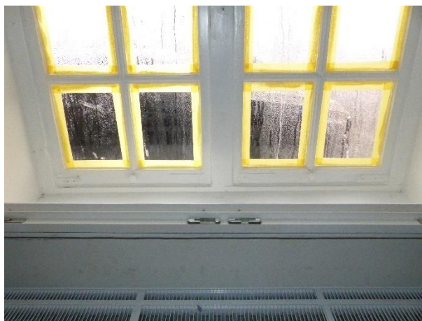
Figuur 136 Nummer 19: detail sluitwerk guillotineraam (13.10.2021)
