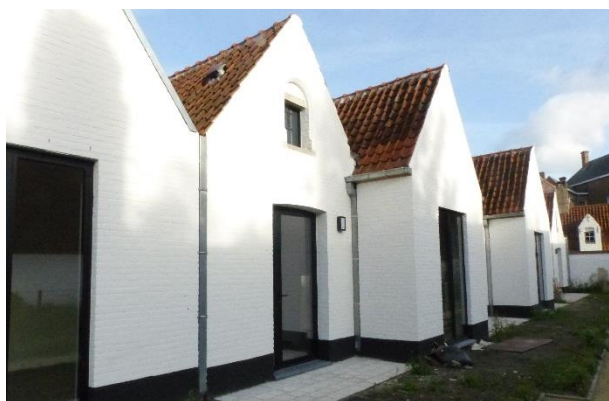
Figuur 115 Zakgoten tussen hellende daken. Verlengd deel van aanbouw jaren 1960 tevens bedekt met Boomse pannen en voorzien van zinken hanggoot. Afvoeren geïntegreerd in metselwerk (13.10.21)
