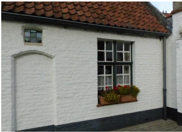
Figuur 120 Regenwaterafvoer voorgevel en aansluiting op puntgevel (13.10.2021)
