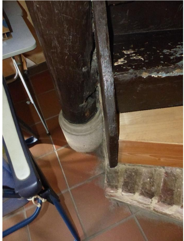
Figuur 216 Nummer 2: detail geprofileerde console in arduin. Tweede en derde trede aanvankelijk ingeklemd in spil (13.10.2021)
