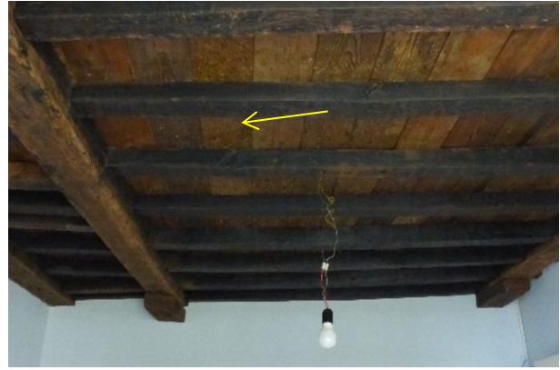
Figuur 181 Nummer 2: roostering zoldervloer in slaapkamer met plank afgewerkt met jasperstechniek (13.10.2021)
