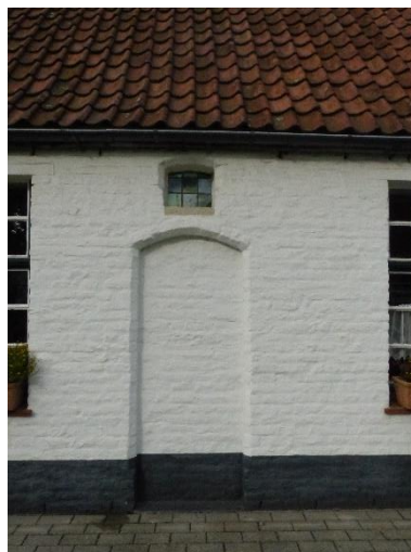
Figuur 93 Dichtgemetselde deuropening (13.10.2021)
