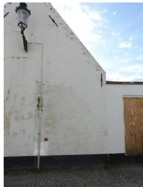
Figuur 95 Detail vochtshade zijgevel met rechts recent geschilderde tuingevel godshuis Van Peenen (13.10.2021)
