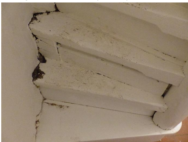
Figuur 200 Nummer 11: historische spiltrap: onderzijde tredes verstevigd, vernieuwde eerste trede (13.10.2021)
