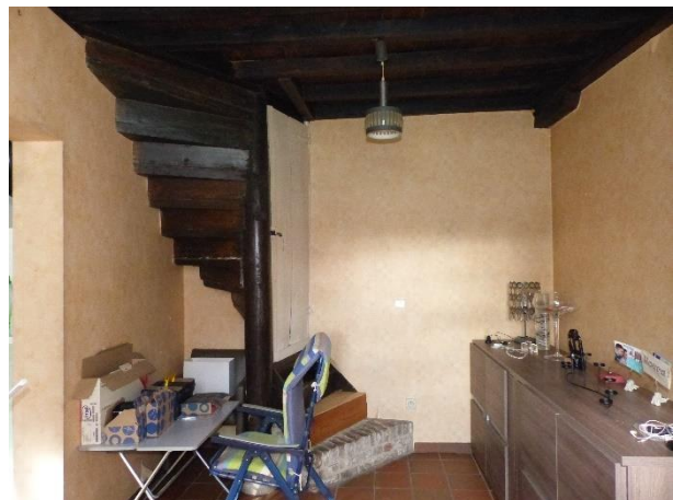
Figuur 179 Nummer 2: roostering zoldervloer in leefruimte met ravelconstructie voor trap (13.10.2021)
