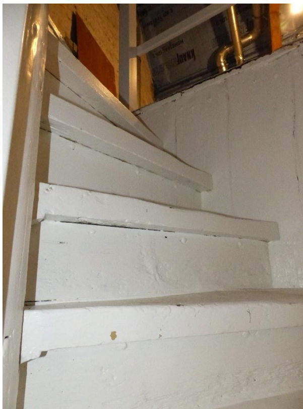
Figuur 212 (linksboven) Nummer 17: tweede trede verzakt (13.10.2021)
