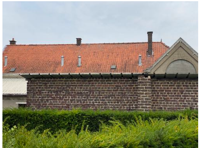
Afb. 48. — Aanzicht achtergevel schoolmuur
