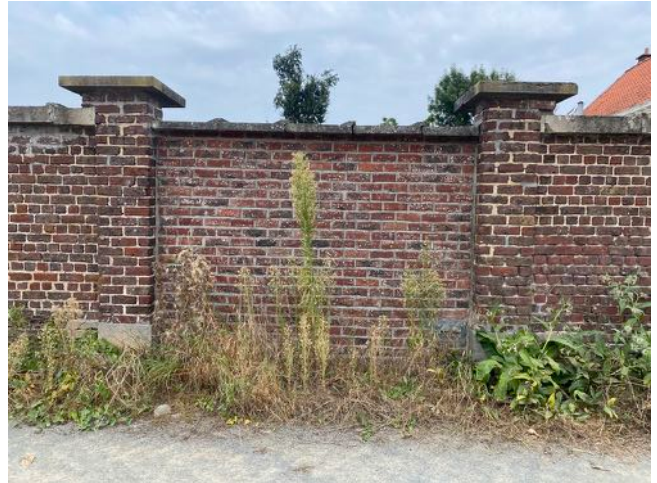
Afb. 34. — Aanzicht linkerzijde schoolmuur
