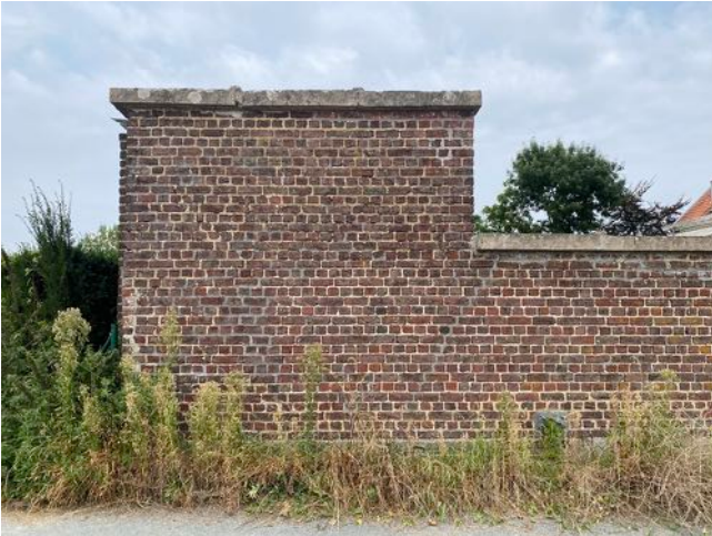
Afb. 33. — Aanzicht linkerzijde schoolmuur
