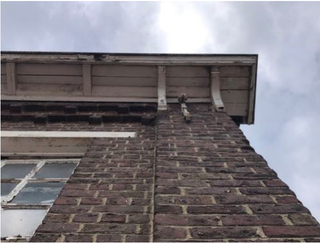
Afb. 15. – Detail dakoversteek voorgevel rechterzijde
