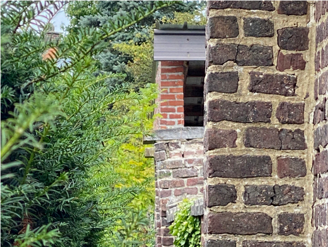
Afb. 45. — Aanzicht achtergevel schoolmuur
