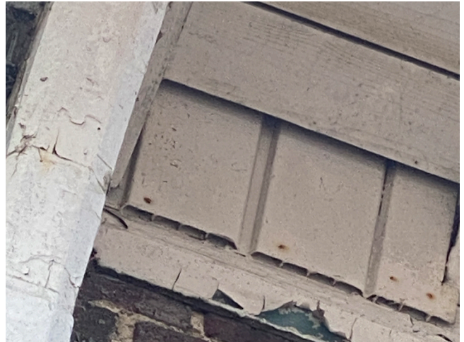
Afb. 10. – Detail witte, plastic elementen ter vervanging van verloren gegaan hout voorgevel
