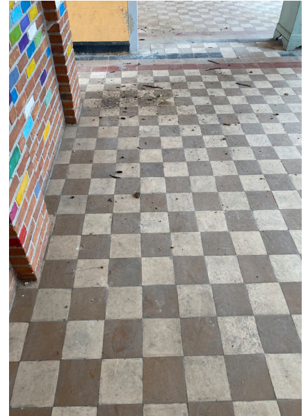
Afb. 141. – Zicht tegelvloer werkklas
