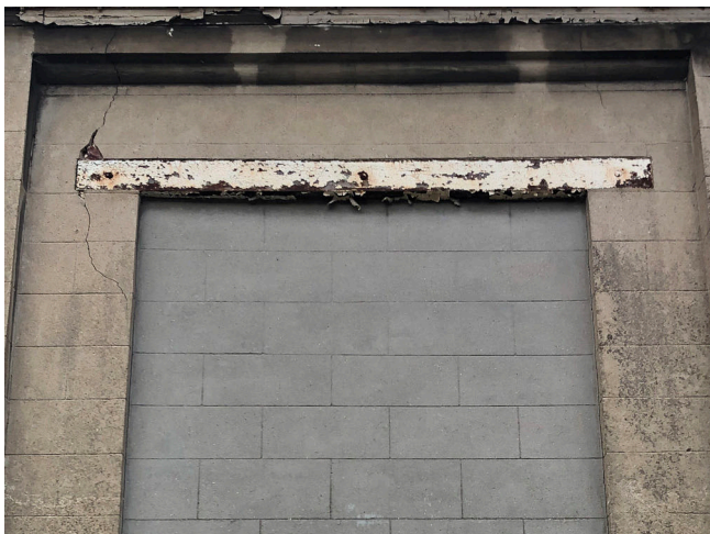
Afb. 25. — Detail ijzeren latei
