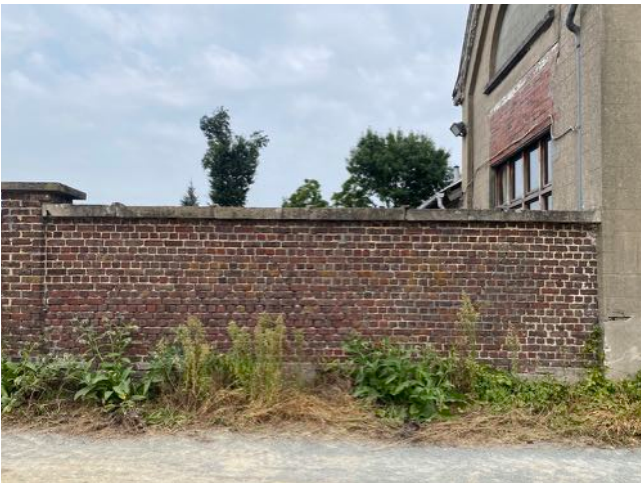
Afb. 35. — Aanzicht linkerzijde schoolmuur
