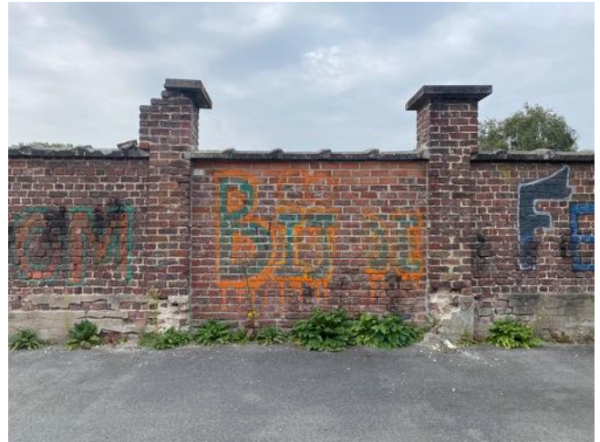
Afb. 117. – Graffiti op binnenzijde schoolmuur
