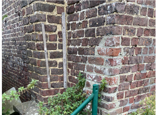
Afb. 40. — Detail van imperfecte steenvoegen die reeds vervangen werden door donkerder voegwerk / recenter voegwerk
