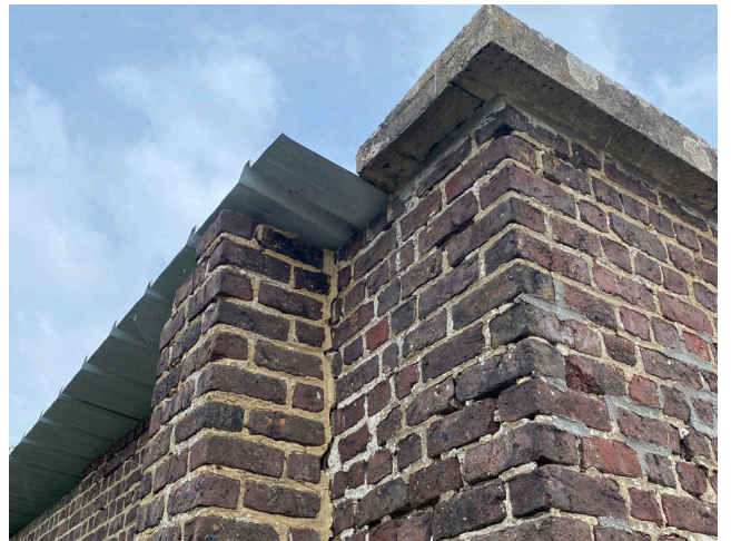
Afb. 42. — Detail hoek linkerzijde schoolmuur
