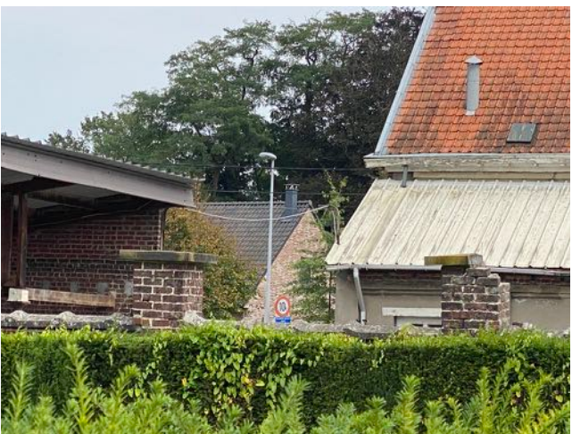
Afb. 49. — Aanzicht achtergevel schoolmuur
