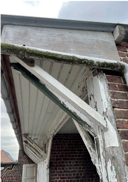
Afb. 84. – Plafondafwerking witte pvc planchetten
