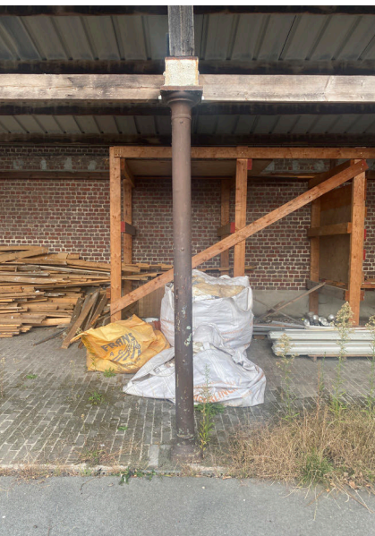
Afb. 106. – Gietijzeren kolom
