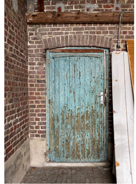
Afb. 102. – Opgeklamte deur in Noordwestelijke hoek
