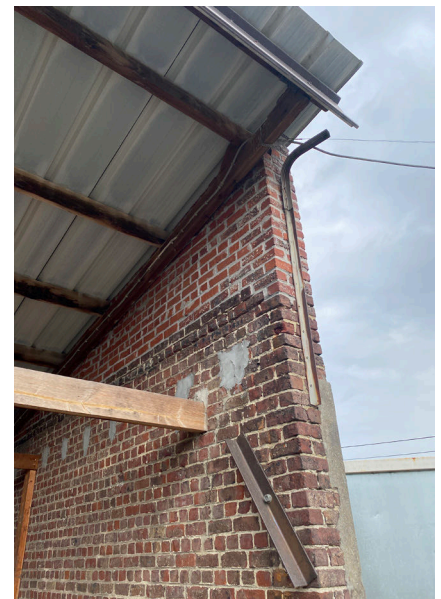
Afb. 108. – Ophoging gemetselde wand
