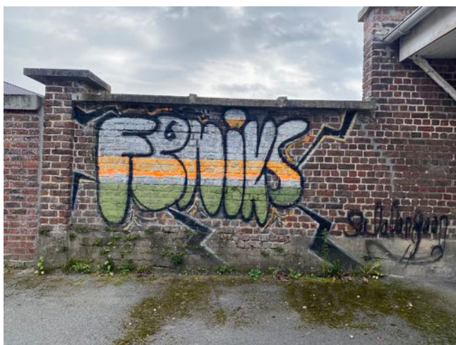
Afb. 114. – Graffiti op binnenzijde schoolmuur
