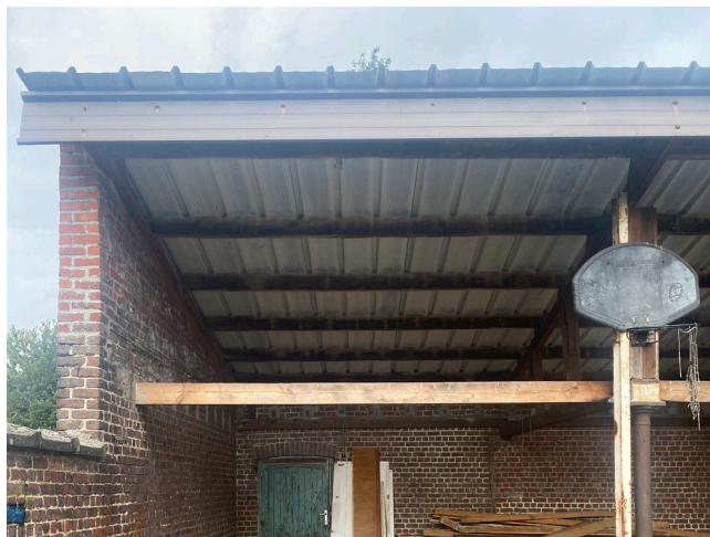
Afb. 95. — Linkerzijde vernieuwd dakschild in golfplaten
