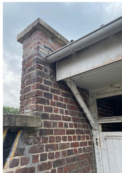
Afb. 113. – Aansluiting wand en sanitaire blok
