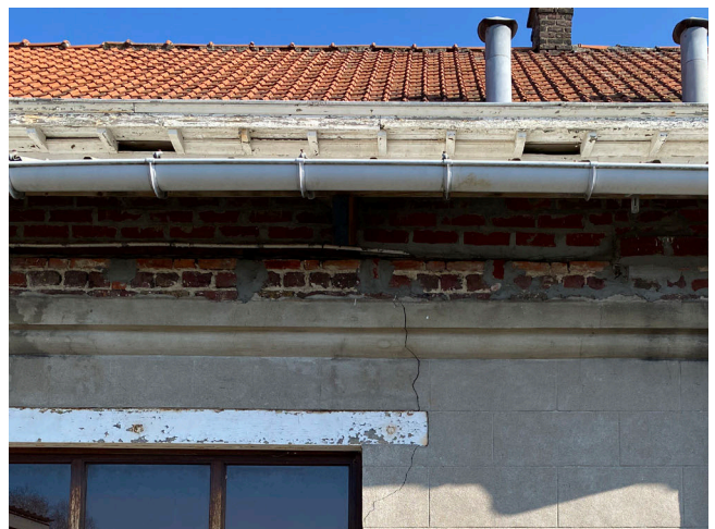
Afb. 64. — Aanzicht ontbrekende houten delen van de dakgoot
