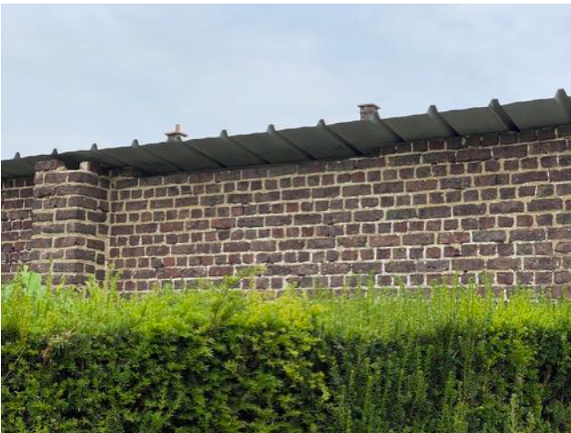
Afb. 47. — Aanzicht achtergevel schoolmuur
