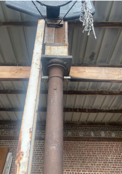
Afb. 103. – Detail bovenzijde gietijzeren kolom
