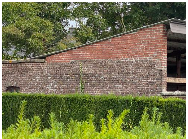
Afb. 50. — Aanzicht achtergevel overdekte speelplaats
