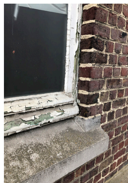
Afb. 6. – Voorgevel detail hardstenen dorpel
