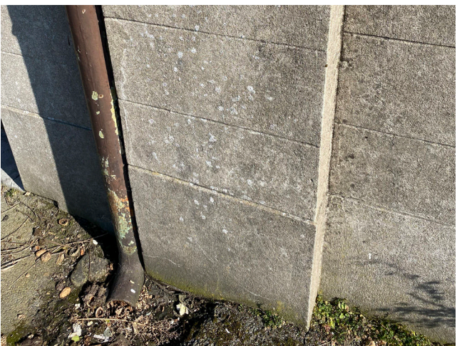
Afb. 63. — Detail onderkant regenwaterafvoer in gietijzer
