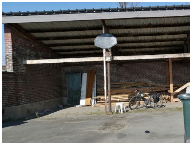
Afb. 68. – Asfaltlaag met onkruidgroei
