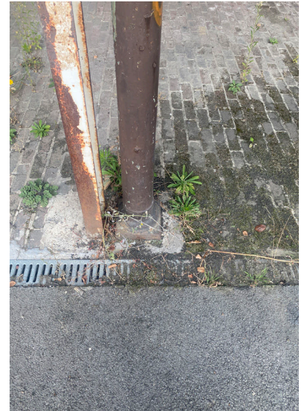
Afb. 105. – Detail onderzijde gietijzeren kolom
