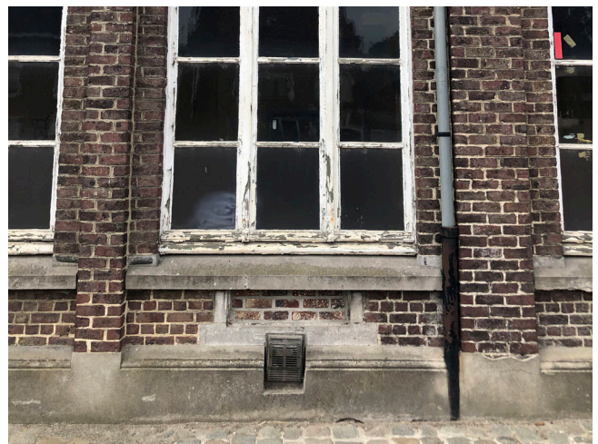
Afb. 18. – De afvoeren in zink en onderaan in gietijzer
