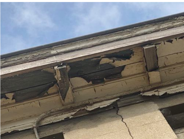
Afb. 11. – Detail dakoversteek, onder losse verschilders, is de kleur groen te zien
