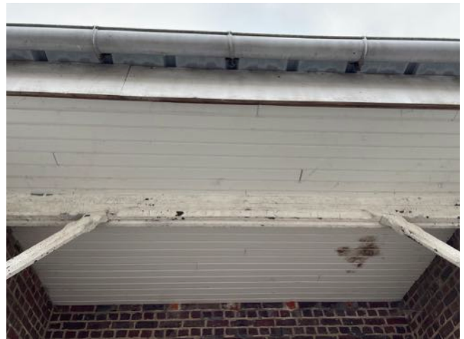
Afb. 91. – Plafondafwerking in witte pvc planchetten
