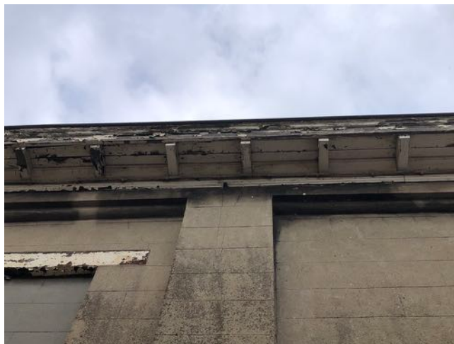
Afb. 26. — Zicht gecementeerde tandlijst onder dakgoot
