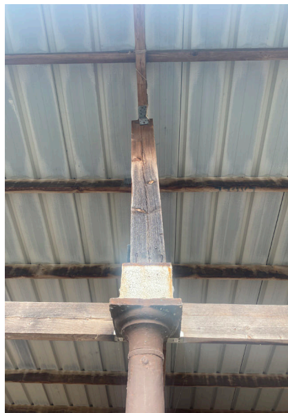
Afb. 107. – Gietijzeren kolom
