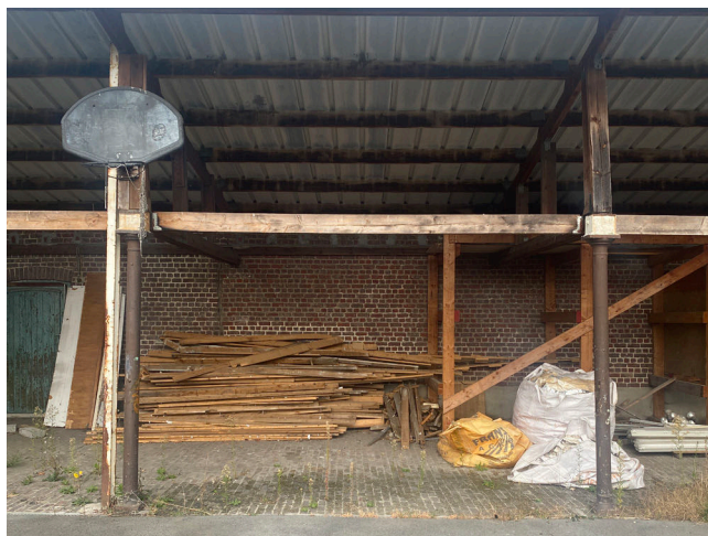
Afb. 99. — Zicht twee gietijzeren kolommen
