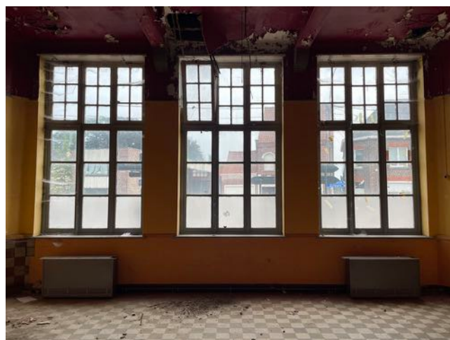
Afb. 164. – Zicht naar voorgevel
