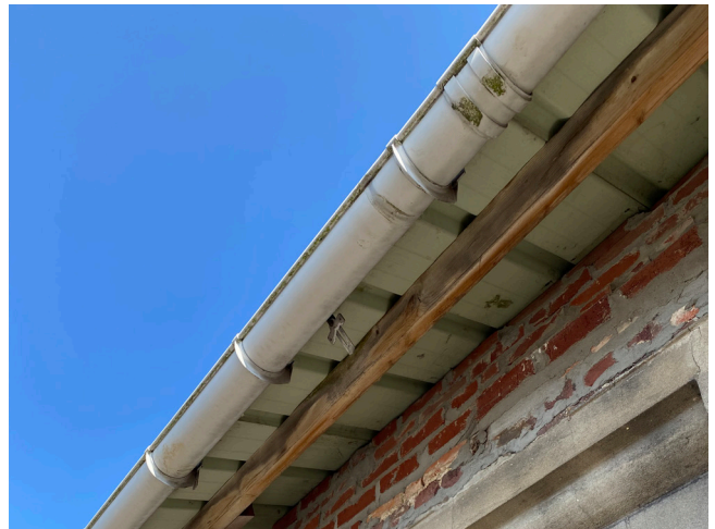
Afb. 62. — Detail opgemetselde bakstenen wand
