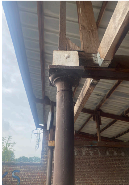
Afb. 104. – Detail bovenzijde gietijzeren kolom
