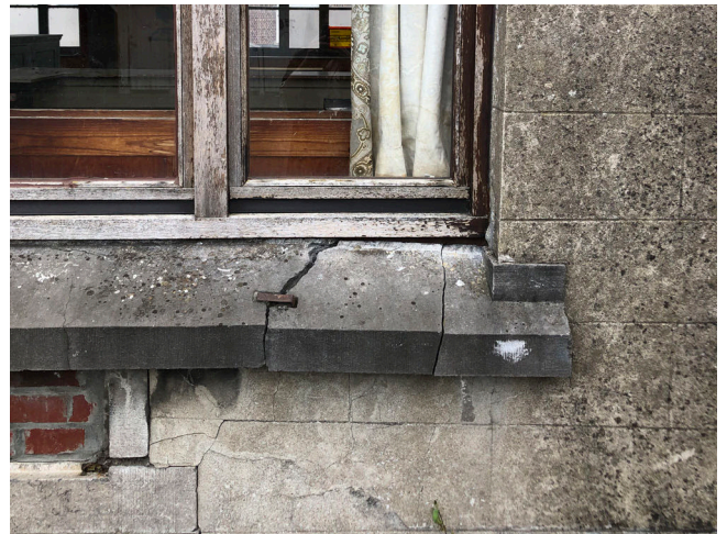
Afb. 52. – Detail gebroken, hardstenen dorpel R0.10
