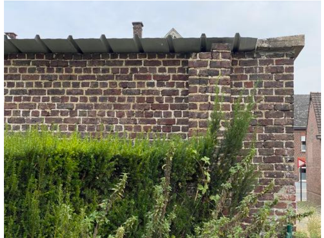
Afb. 46. — Aanzicht achtergevel schoolmuur
