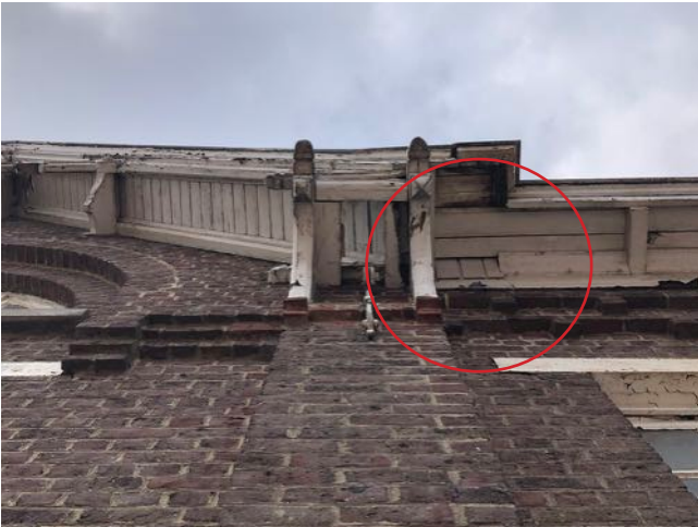
Afb. 9. – Detail dakoversteek puntgevel rechterzijde
