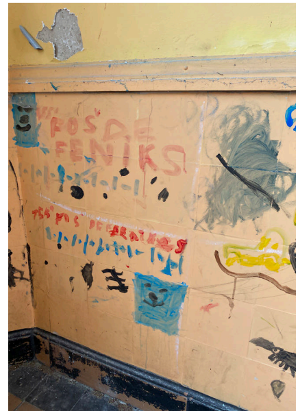
Afb. 126. – Bekladde muur met verf
