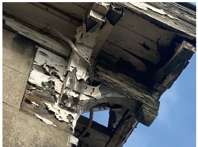
Afb. 12. – Detail dakoversteek voorgevel linkerzijde
