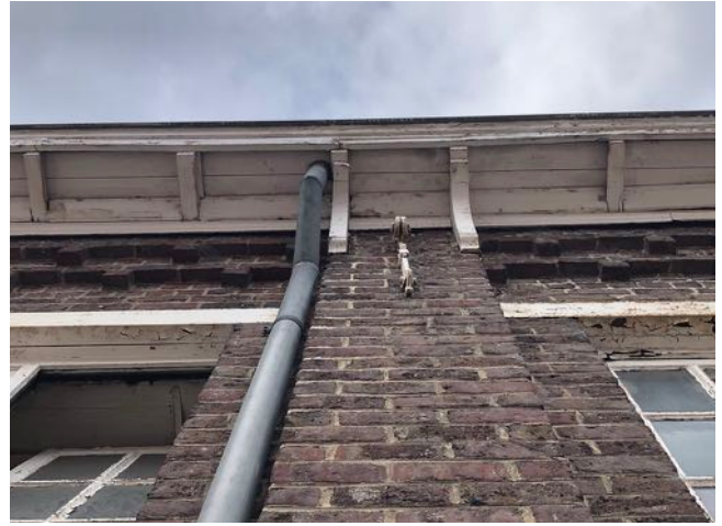
Afb. 14. – Detail dakoversteek, het gesmeed sieranker en de zinken waterafvoer
