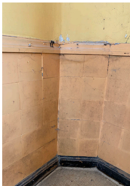
Afb. 137. – Zicht afgeschuinde linkerhoek
