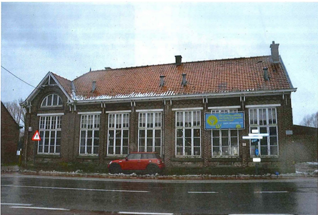
Voorgevel gemeenteschool Nederzwalm, zicht vanuit het oosten (13.12.2017)
