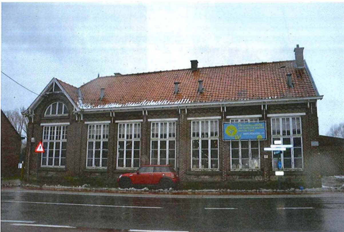
Voorgevel gemeenteschool Nederzwalm, zicht vanuit het oosten (13.12.2017)
