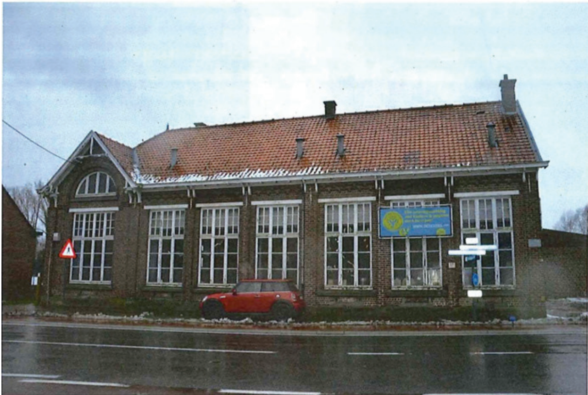
Voorgevel gemeenteschool Nederzwalm, zicht vanuit het oosten (13.12.2017)
