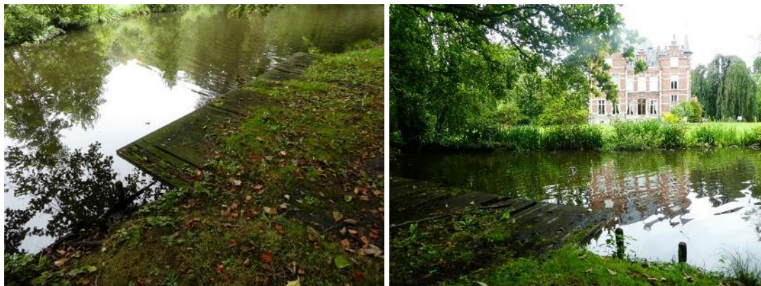
Figuur 2.6-1: Oude steiger aan de zuidzijde van de parkvijver (Antea Group 2020).
