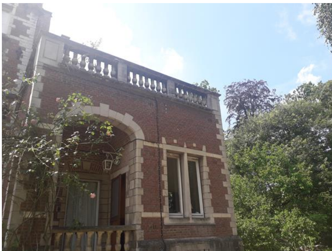
Figuur 3.3-3: Aanbouw met dakterras.
