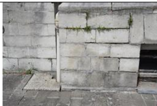
Voegwerk aan de ingang van het kasteel
