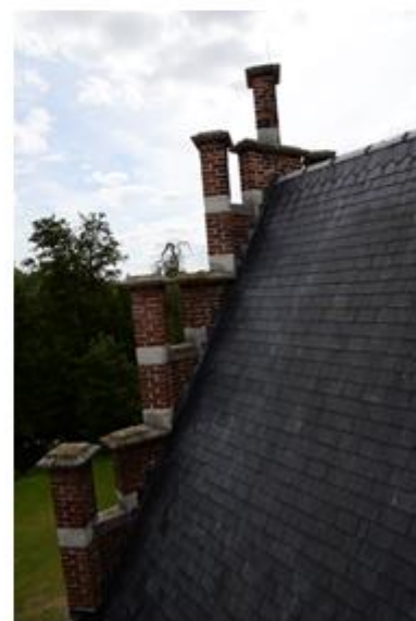
Loden traploketten dak [8]
