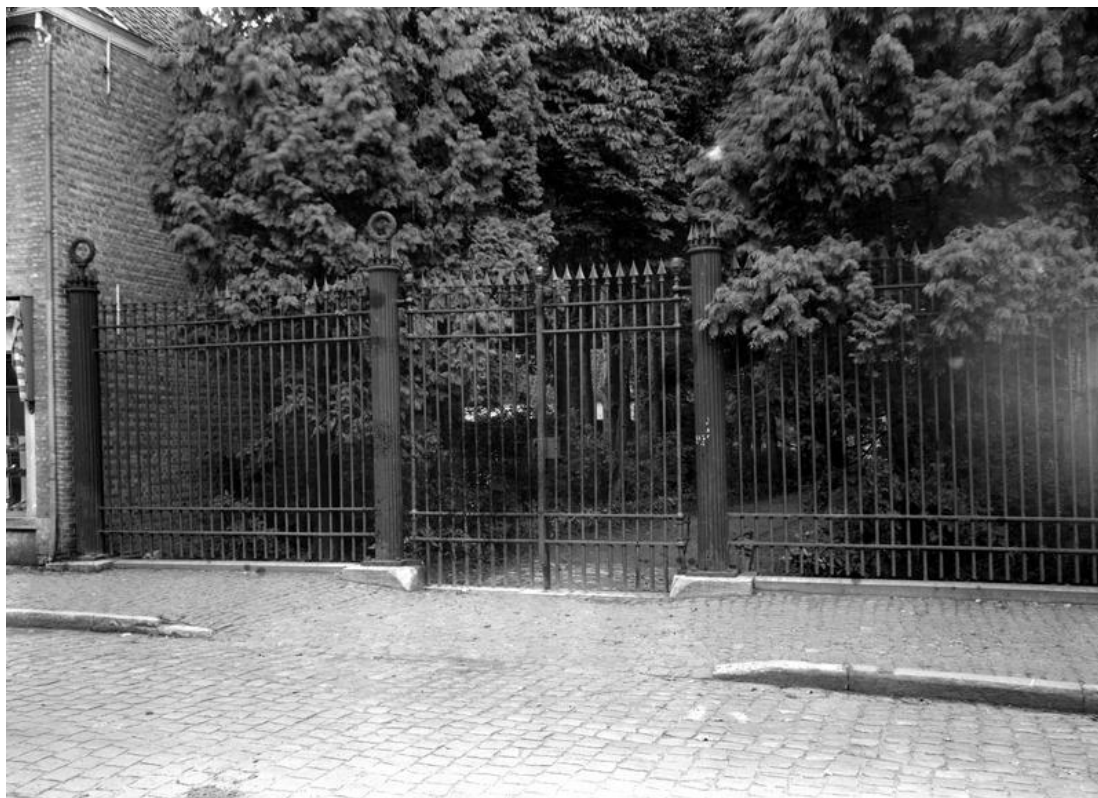
Figuur 3.2-58: Foto van de toegangspoort in 1945 (bron: KIK-IRPA; Commissariaat generaal voor de Passieve Luchtbescherming).
