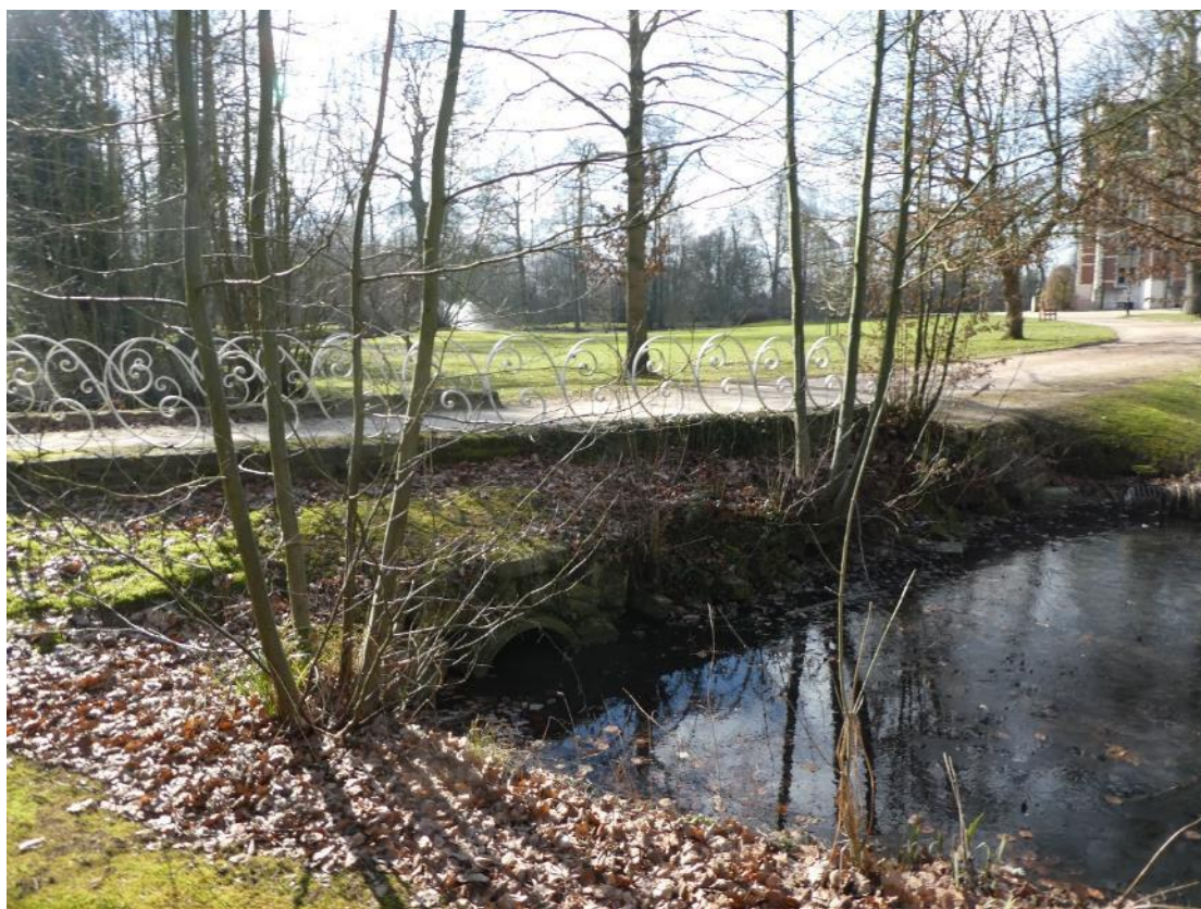
Figuur 3.2-89: Een duiker onder het pad verbindt beide delen van de parkvijver. Een witgeschilderde balustrade langs het pad geeft het een landschappelijk uitzicht als brug (Antea Group 2018).
