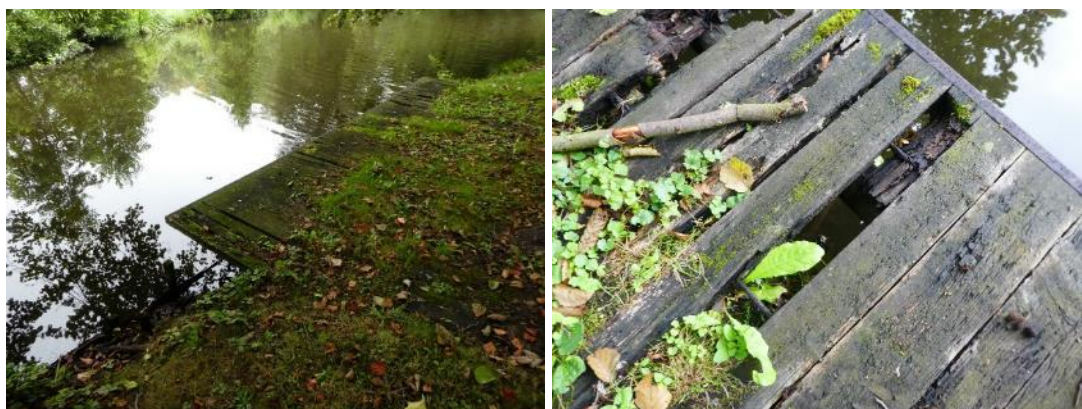
Figuur 3.2-81: Oude steiger aan de zuidzijde van de parkvijver (Antea Group 2018, 2020).
