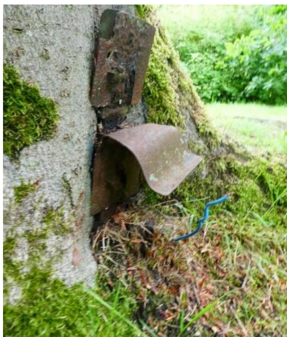
Figuur 3.2-96: IJzeren constructie aan bomen (Antea Group 2020).
