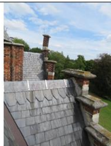
Nokken met vernieuwd bladlood bevestigd met rvs-beugels dak [14] en dak [9]
