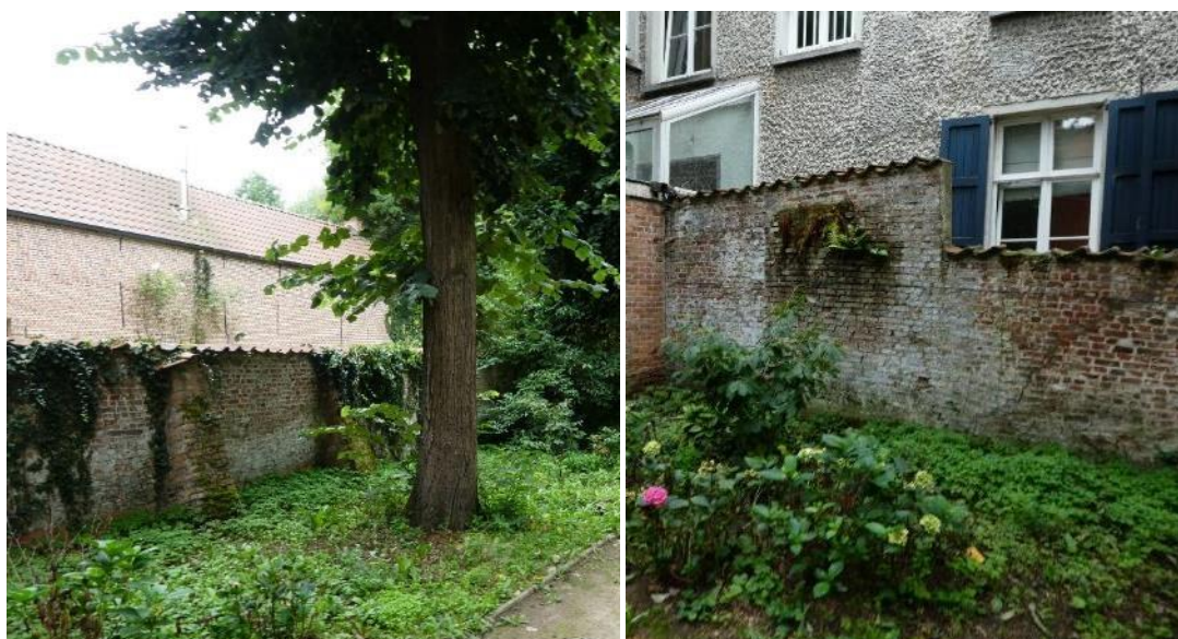
Figuur 3.2-79: Tuinmuur langs de toegangsreef (Antea Group 2018).
