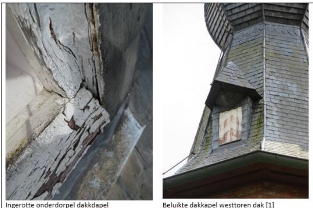
Ingerotte onderdorpel dakkapel
