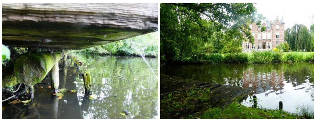
Figuur 3.2-82: Oude steiger aan de zuidzijde van de parkvijver (Antea Group 2020).
