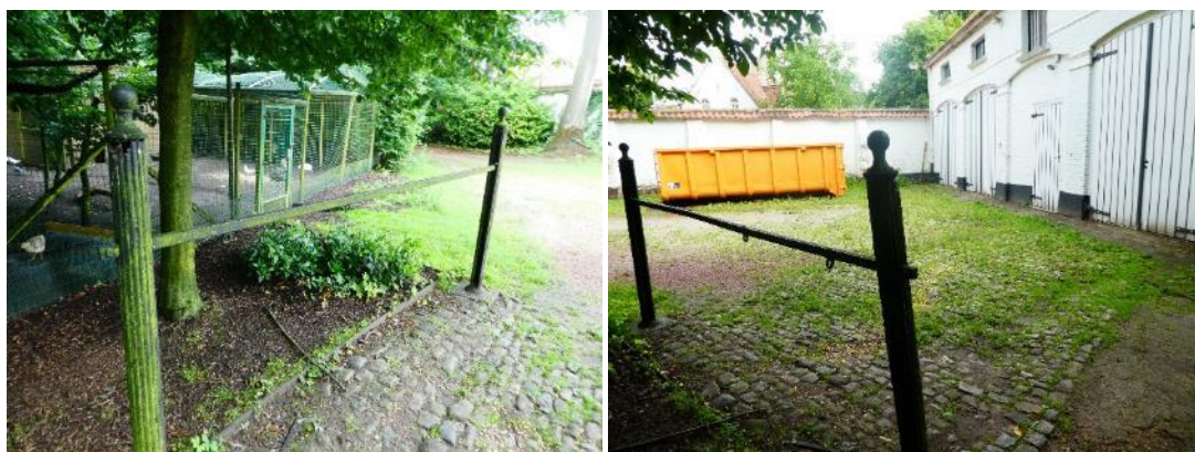
Figuur 3.2-92: Metalen constructie op het einde van een korte kasseiweg nabij het koetshuis (Antea Group 2020).
