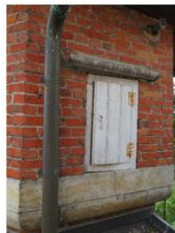
Toegangsluik tot de westtoren
