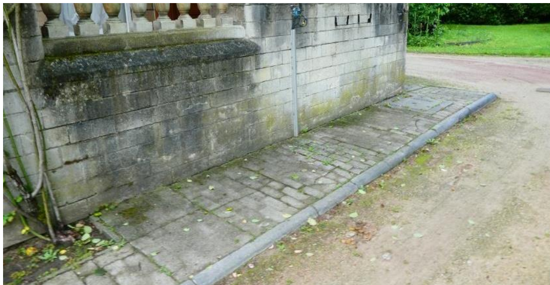
Figuur 3.2-54: Strook van betonklinkers en natuurstenen boordstenen rondom het kasteel (Antea Group 2020).
