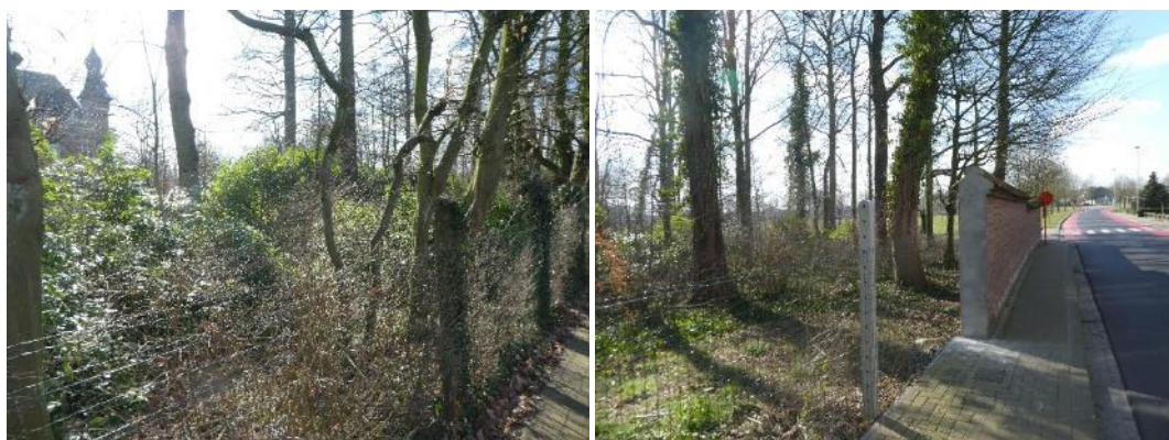
Figuur 3.2-77: Groen geplastificeerde rechthoekige tuingaas bevestigd aan betonpalen tussen beide tuinmuren (Antea Group 2018).
