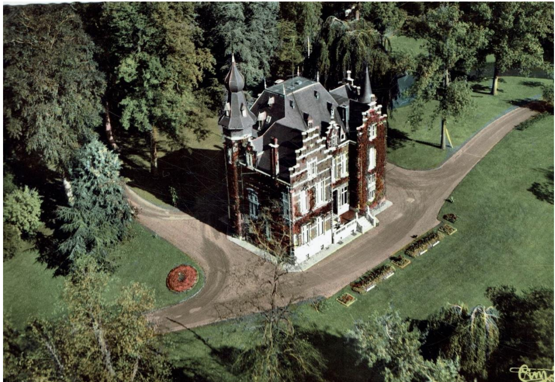
Figuur 2.2-6: Luchtfoto van de rood verkleurde gevelbegroeiing tegen het kasteel Blauwendael (bron: Delcampe).
