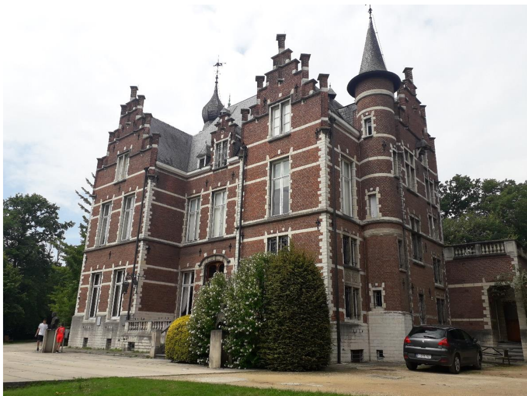
Figuur 3.3-11: Zuid- en oostgevel.
