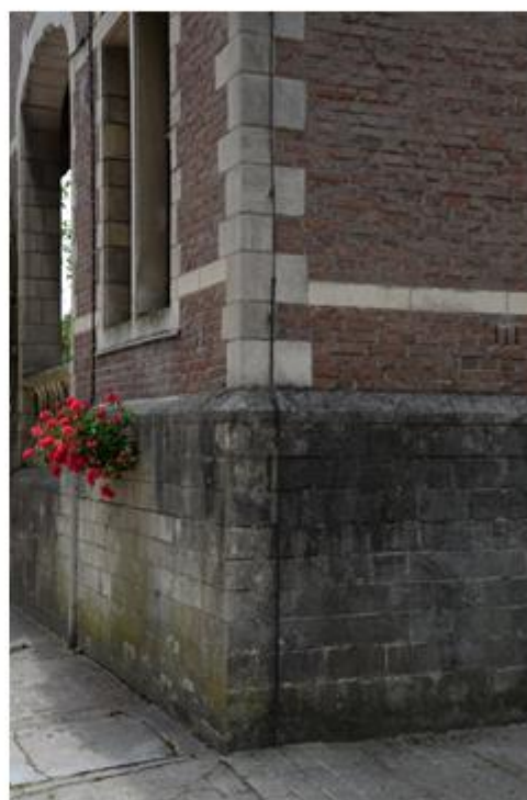
Conciërgewoning met cementrijke en harde voegmortel
