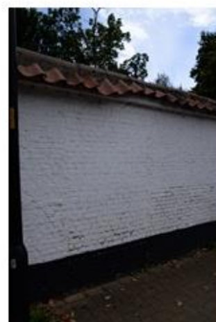
Muur bij het koetshuis vanuit de straatkant
