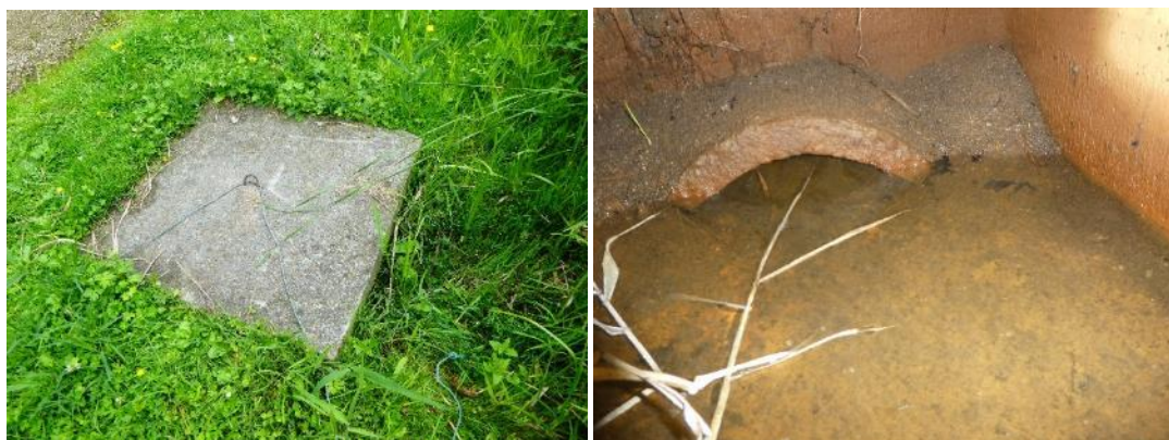
Figuur 3.2-85: Duiker P23 als één van de overlopen van de parkvijver (Antea Group 2020).
