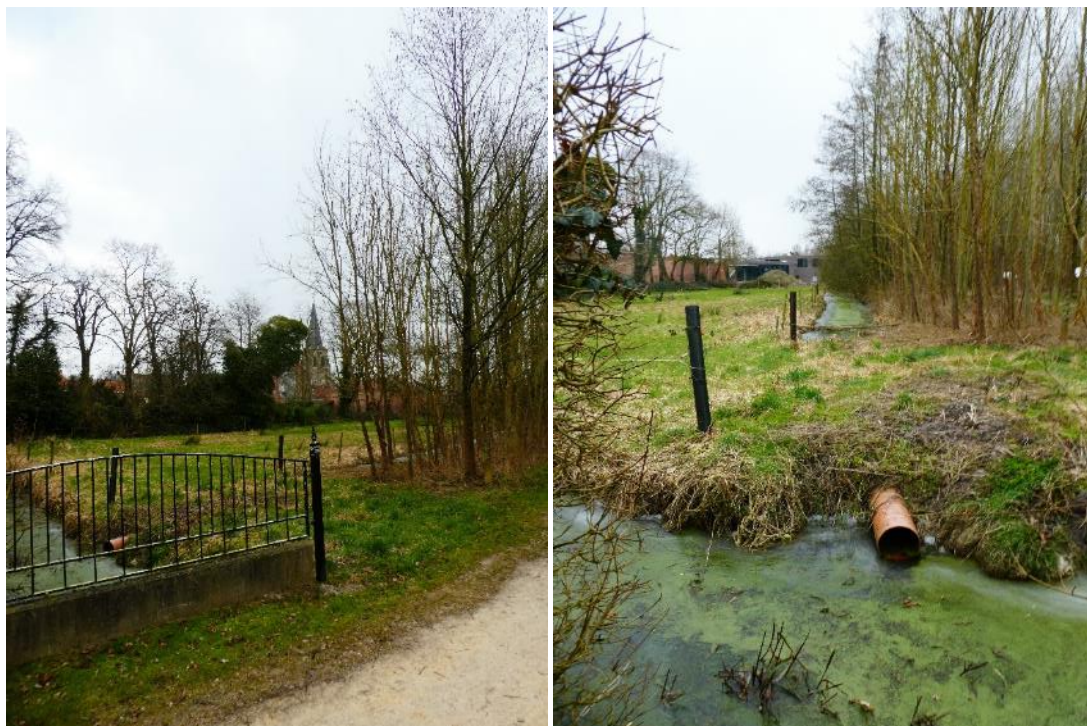
Figuur 3.2-84: Toegangsweg naar de paardenweide met PVC-duiker (Antea Group 2018).
