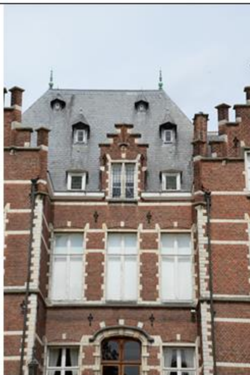
Koperen pironnen op het centraal platform en de dakkapellen
