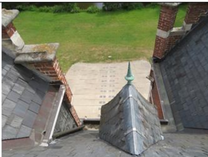
Koperen gootbekleding dak [14] en dak [7]
