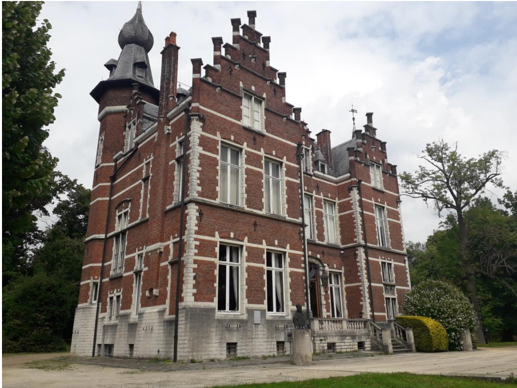
Figuur 3.3-9: Zuid- en westgevel (Patrick Van den Nieuwenhof 2020). Er zijn geen plannen van de zuid- en westgevel in het dossier van 1979.
