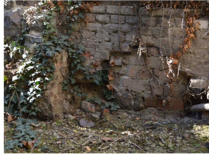
Natuurstenen en metselwerk achtergevel, 26 februari 2019
