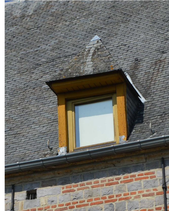
Zuidwestelijke dakkapel, 21 augustus 2019
