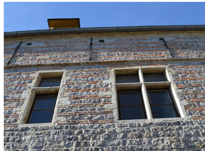
Rechte muurankers en steigergaten, 21 augustus 2019
