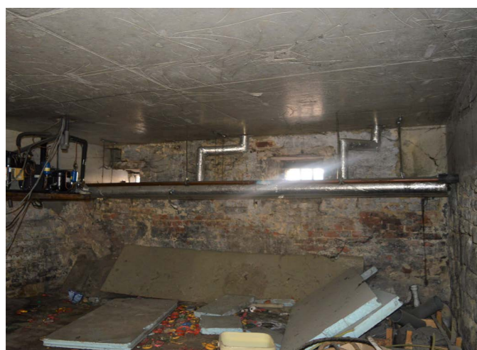
3. Zuidwestelijke deel van centrale kelder, 21 augustus 2019
