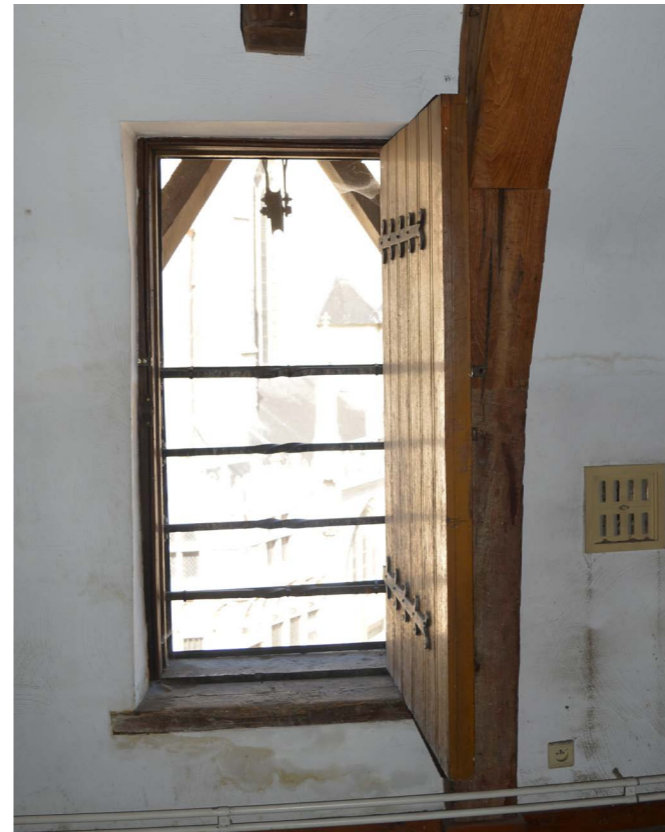
39. Groot dakvenster, voorzijde en met kunststof afgesloten steigerlat, 21 augustus 2019
