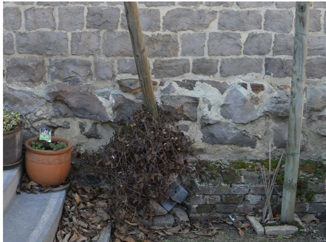
Natuurstenen en metselwerk achtergevel, 26 februari 2019
