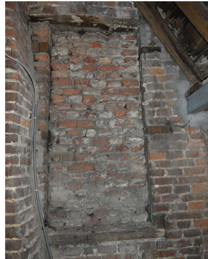
Dichtgemaakt venster op zolder, 21 augustus 2019
