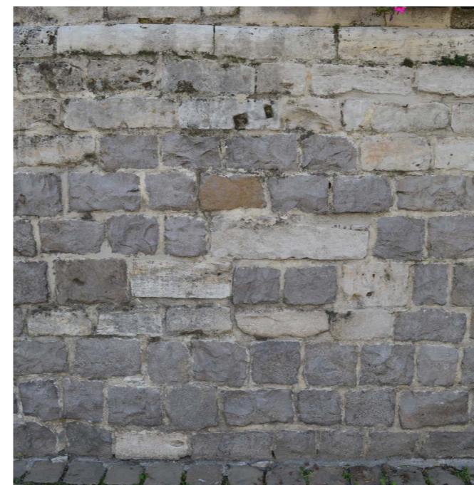
Detail van de voorgevel, 21 augustus 2019
