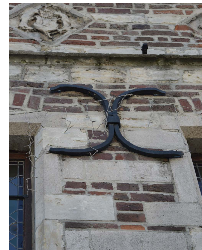
Rond X-vormig muuranker, 21 augustus 2019
