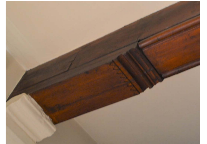
30. Moerbalk met balksleutel op stenen console
