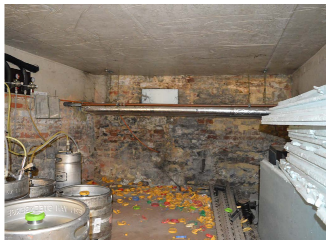
2. Middelste deel van centrale kelder, 21 augustus 2019
