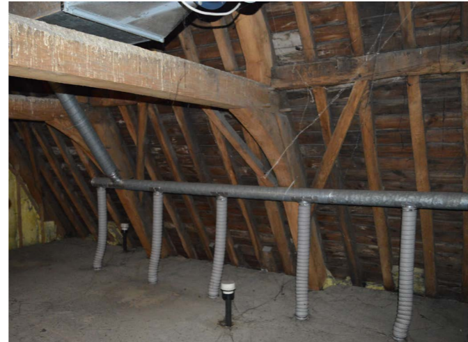
44. Dakgebinte aan voorzijde, 21 augustus 2019
