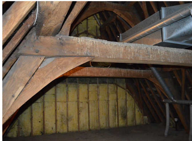
43. Dakgebinte aan zijde grote zolder, 21 augustus 2019
