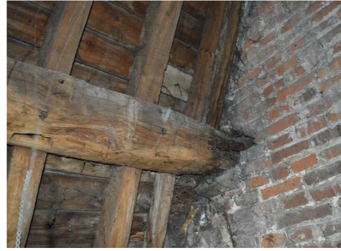
42. Dakgebinte aan muur met stadhuis, 21 augustus 2019
