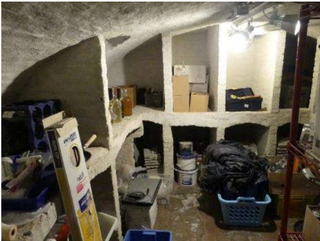
Foto 7 : Wijnkelder met tongewelf, bakstenen onderverdeling en bruinrood gebakken tegelvloer
