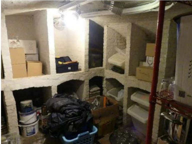
Foto 8 : : Wijnkelder met bakstenen onderverdeling en bruinrood gebakken tegelvoer
