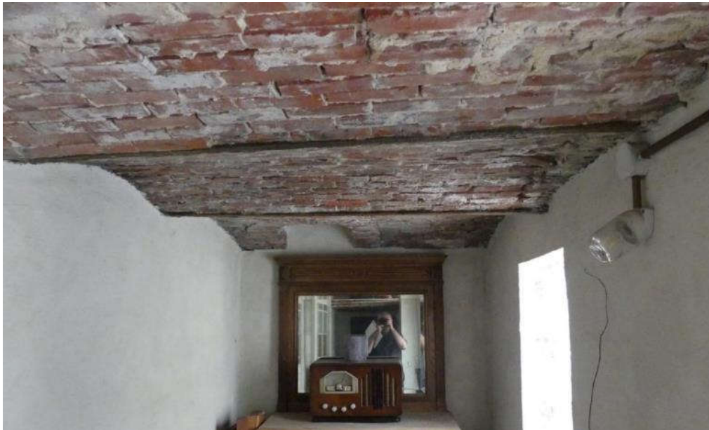
Foto 6. Kelders met tonneau-gewelven, gang links vanaf de buitentrap.
