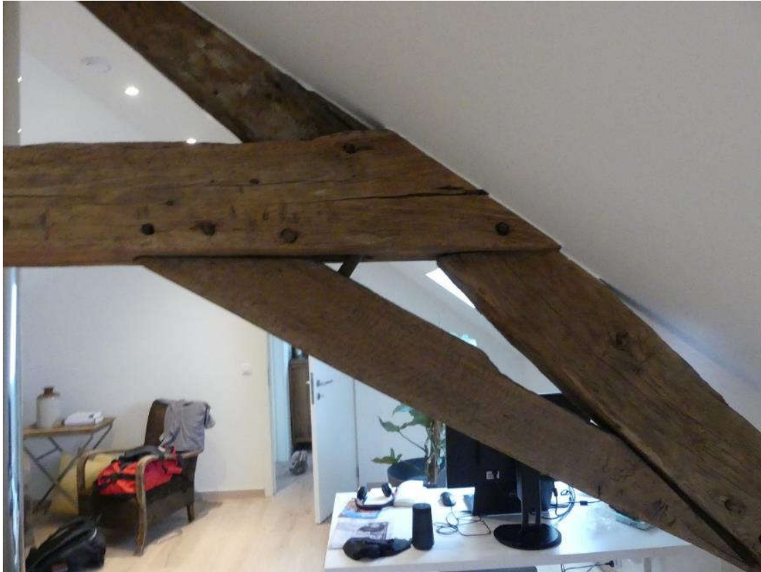
Foto 14 detail korbeel in eiken spant op zolder
