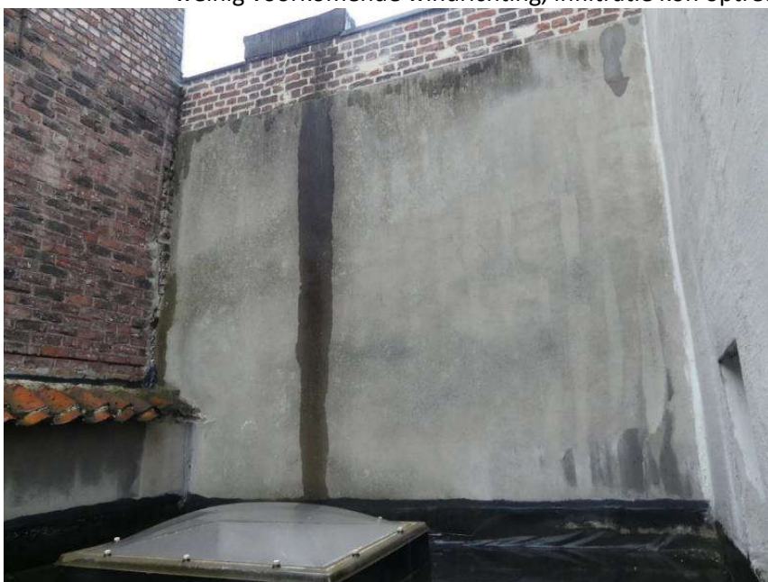
Foto 33. Blinde muur naar de koer, zonder functie.
