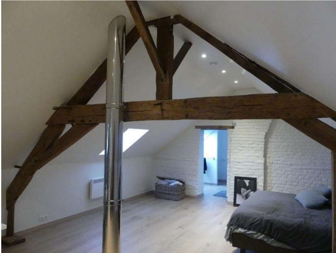
Foto 12. Origineel eiken spant op zolder met pen- en gatverbindingen.
