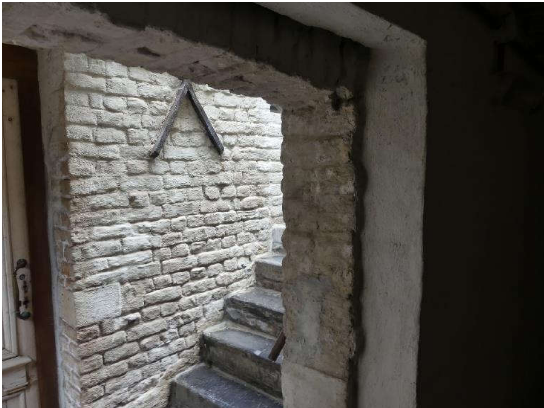
Foto 2. Buitentrap naar kelder uit arduin. (onderste 6 treden zijn origineel)
