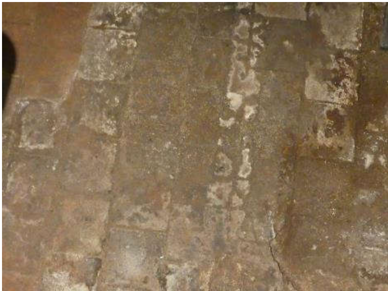
Foto 9 : bruinrood gebakken tegelvoer in wijnkelder
