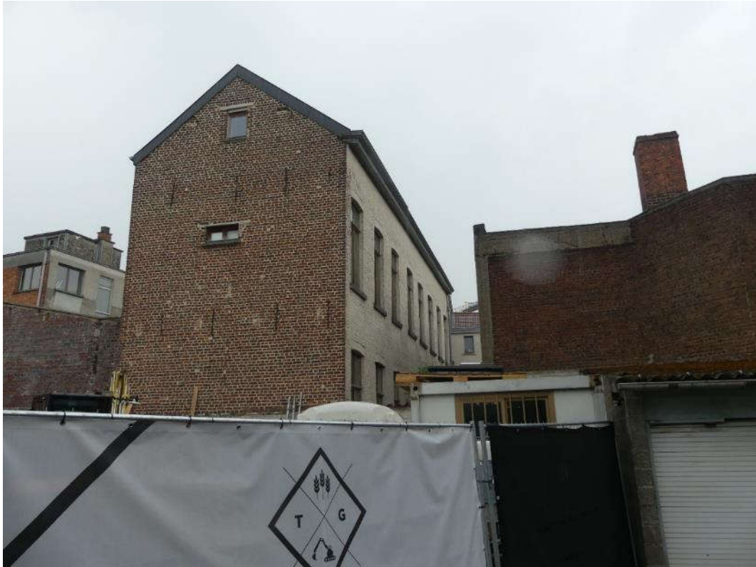
Foto 3. Noordelijke kopgevel op de perceelgrens en verkort perspectief op de gehele gekaleide werstgevel met 8 travees)
