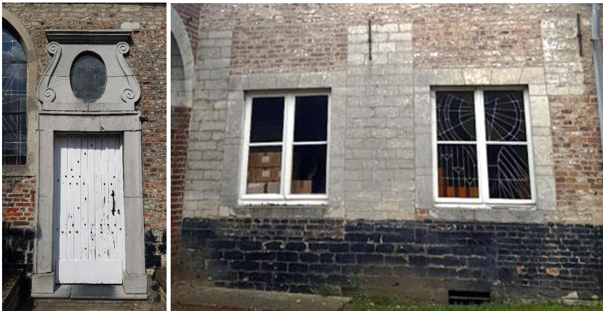
Fig. 43: Barokke deuromlijsting (links) en detail van de deels met natuursteen opgebouwde gevel en houten schrijnwerk langs het binnenplein (rechts).
