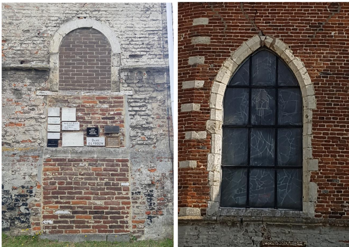
Fig. 40: Sporen van dichtgemaakte deuropening met rondboogvormig bovenlicht (links) en spitsboogvenster met glas-in-loodraam (rechts).
