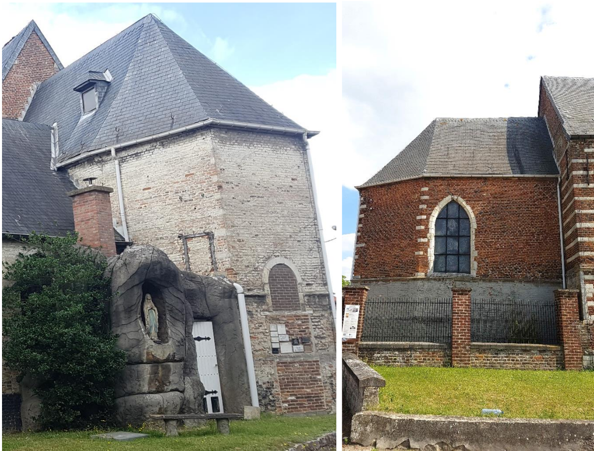
Fig. 39: Zicht op de oostgevels van het koor (links) en de noordgevels (rechts).
