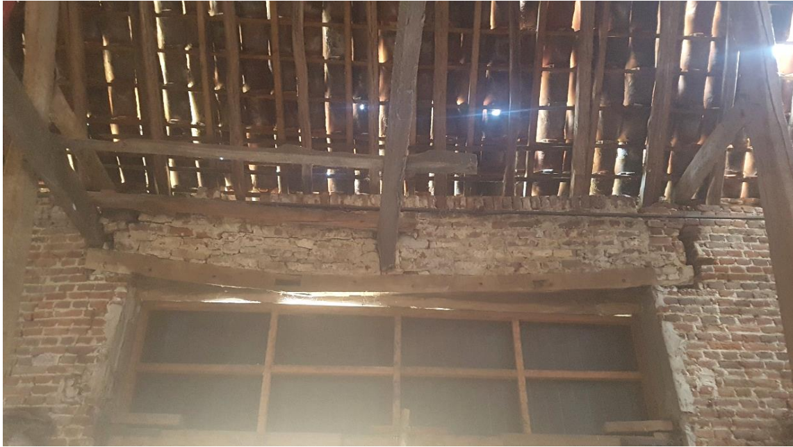
Fig. 74: Zwaar doorhangende poortlatei.
