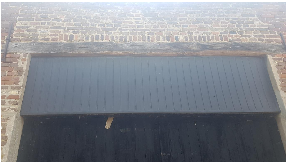
Fig. 68: Detail van de langse gevel met muurankers, gecementeerde dagkanten, recente houten poort en houten latei.
