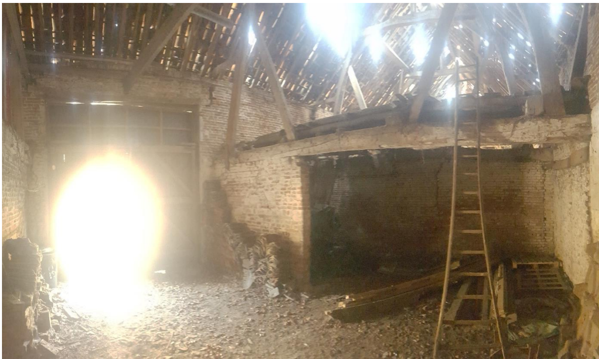
Fig. 70: Overzicht van de binnenruimte.
