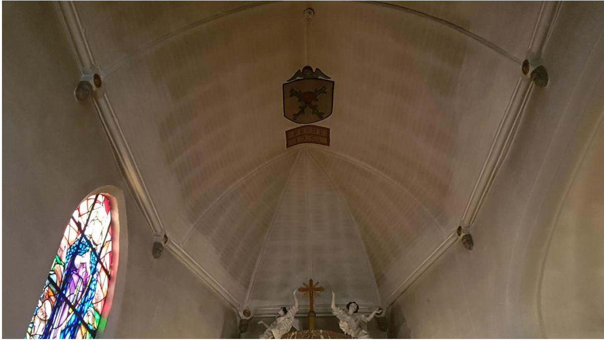
Fig. 55: Zicht op het plafond van het koor.
