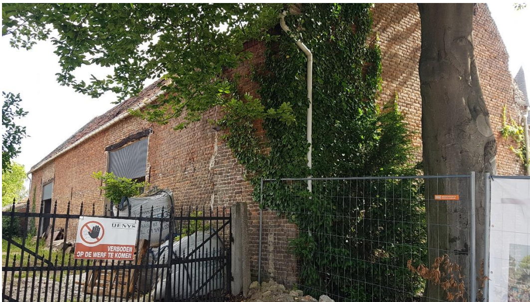
Fig. 67: Overzicht van de schuur langs de oostzijde.
