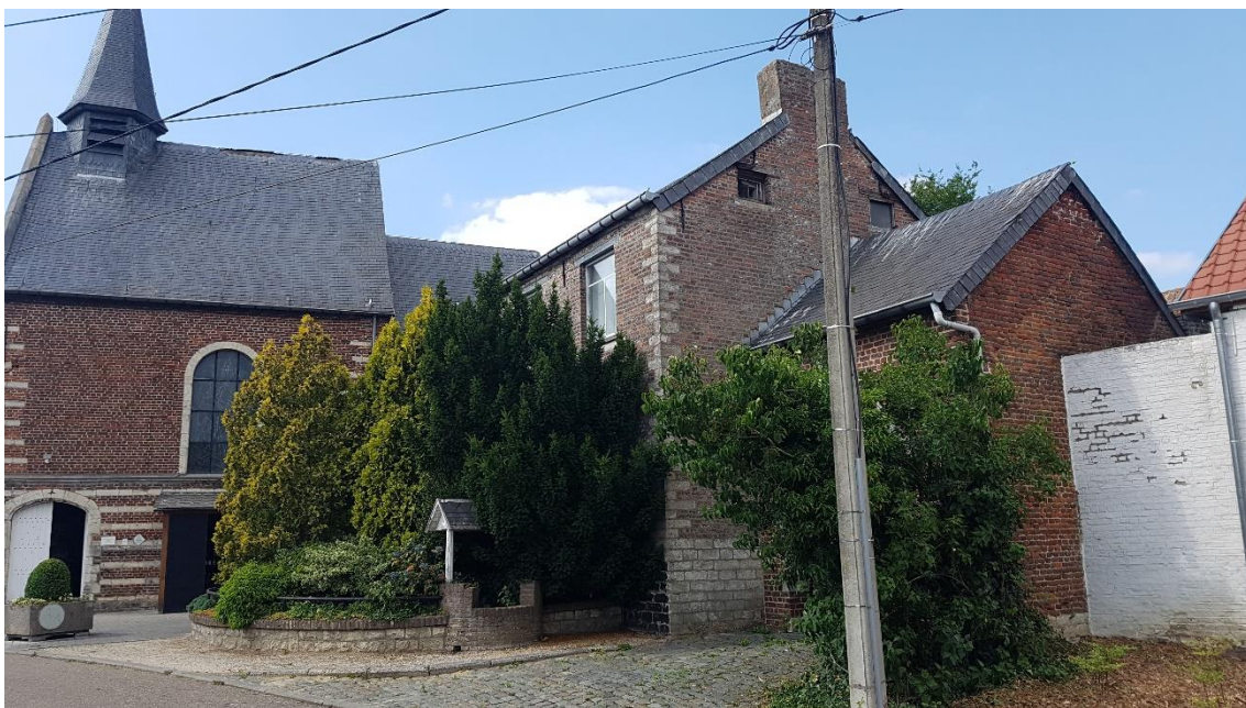
Fig. 36: Overzicht van de zuidgevels.
