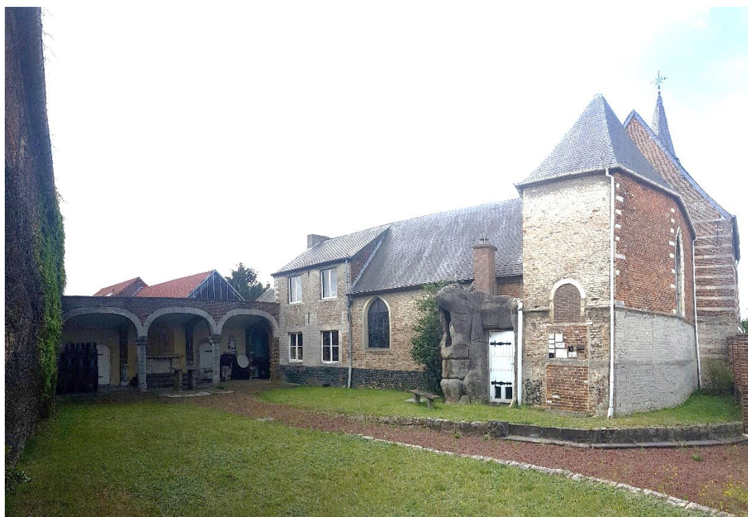
Fig. 76: Overzicht van het binnenplein, gezien vanaf de straat.
