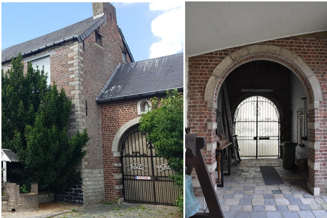
Fig. 44: Kopse gevel met hoekkettingen, natuursteenplint, zoldervenstertjes en aangebouwd poortvolume (links) en poortdoorgang gezien vanaf de gaanderij (rechts).
